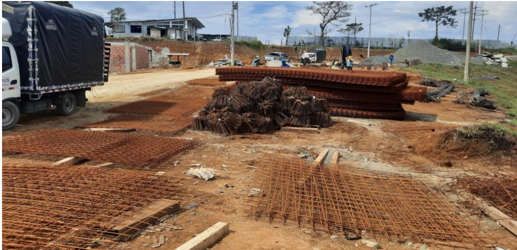
Figura 36. Almacenamiento del acero.
