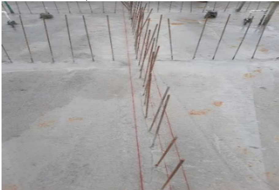
Figura 8. Dovelas de arranque.
