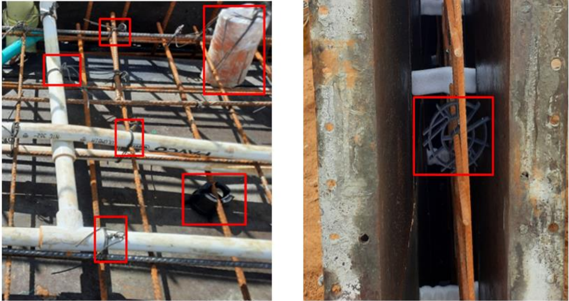
Figura 12. Espaciadores en muros y losas de entrepiso.
