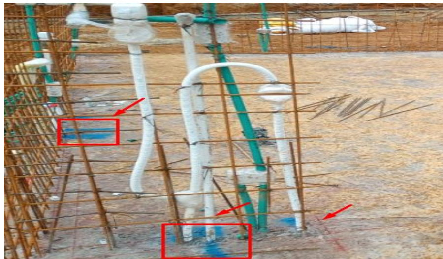
Figura 37. Marcación de la ubicación de las tuberías.
