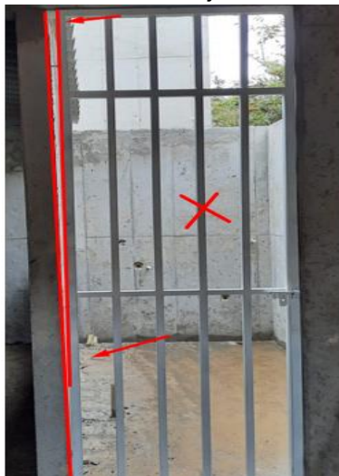
Figura 53. Instalación de rejillas.
