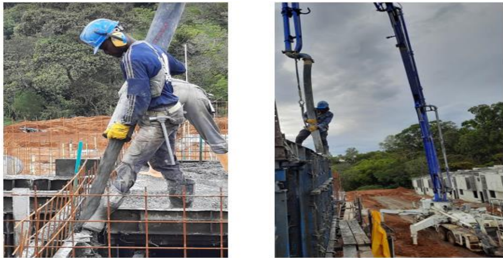
Figura 35. Proceso de vaciado de concreto premezclado.
