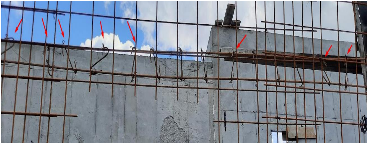
Figura 15. Viga de refuerzo en dintel.
