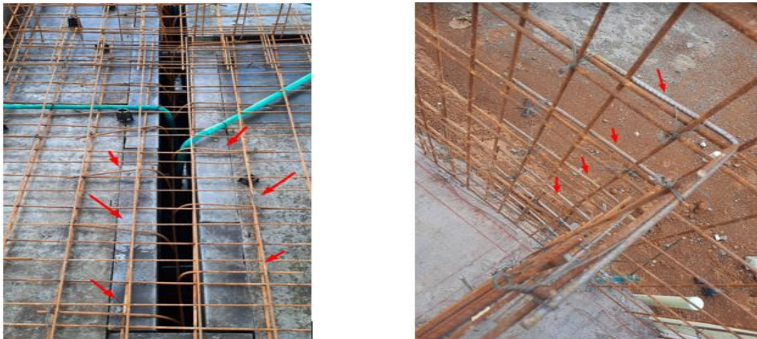
Figura 14. Refuerzos estructurales, esquineros.
