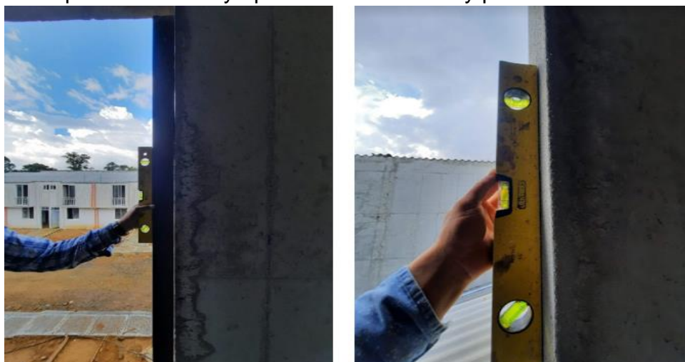
Figura 51. Chequeo de niveles y aplomes de ventanas y puertas.
