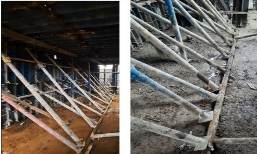
Figura 20. Apuntalamiento de encofrado de muros.
