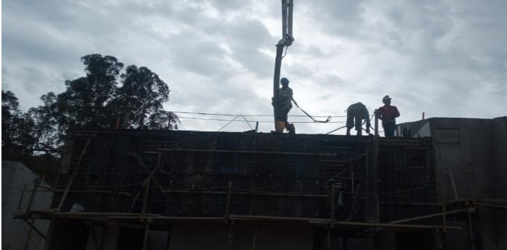
Figura 46. Implementación de línea de vida durante la fundición del segundo piso.
