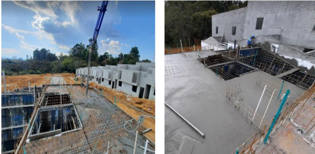
Figura 29. Antes y después del vaciado y vibrado del concreto.
