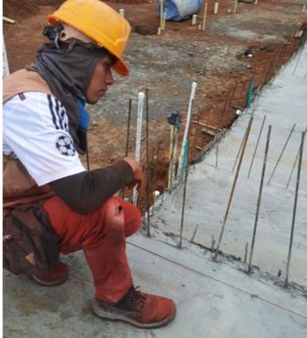
Figura 16. Proceso de cimbrado y pinado.
