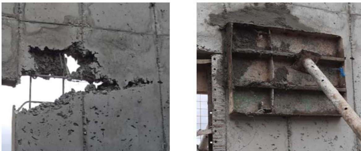
Figura 32. Reparación de agujero en muro estructural.
