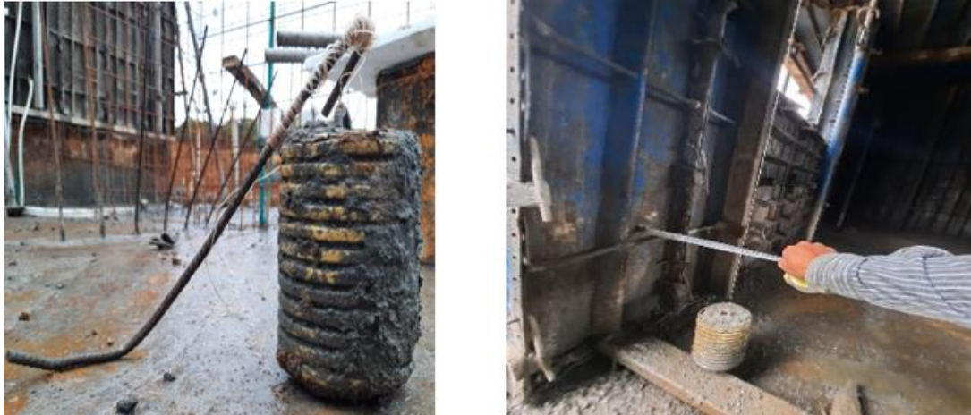
Figura 21. Aplomo de muros.
