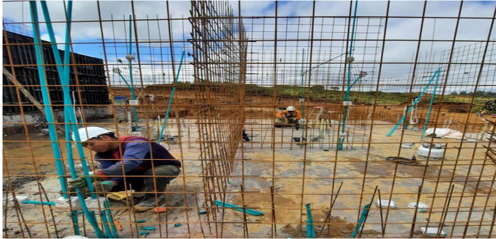
Figura 38. Instalación del sistema eléctrico.
