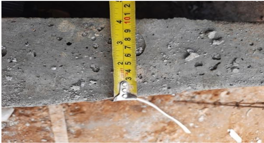
Figura 22. Espesor de muro.
