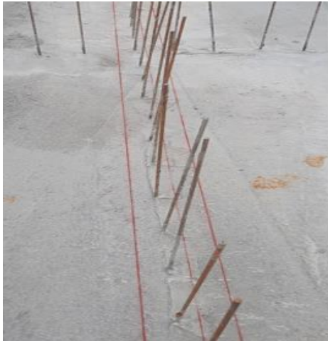
Figura 17. Cimbrado y pinado de muros.
