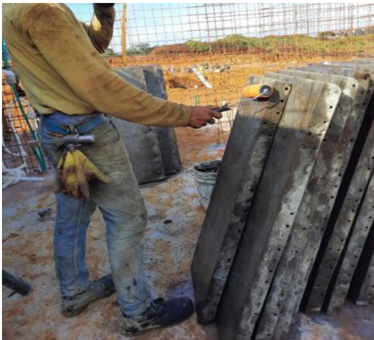
Figura 18. Aplicación de desmoldante a la formaleta.
