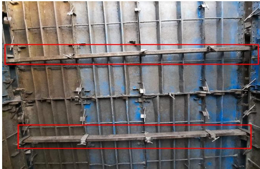
Figura 26. Chequeo en la instalación de alineadores.
