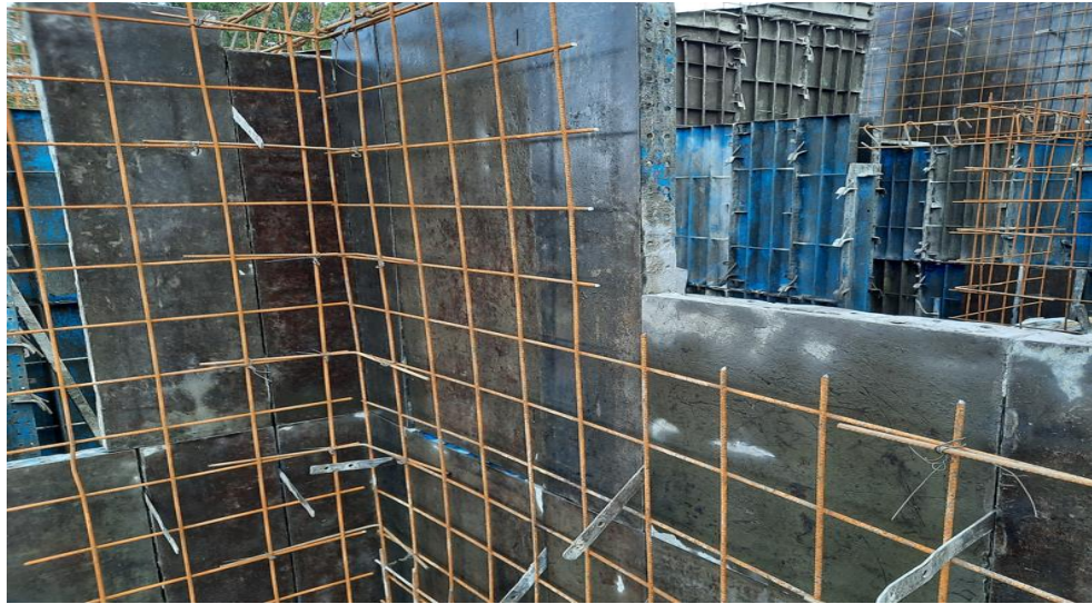
Figura 19. Proceso de armado de formaleta metálica en muro estructural.
