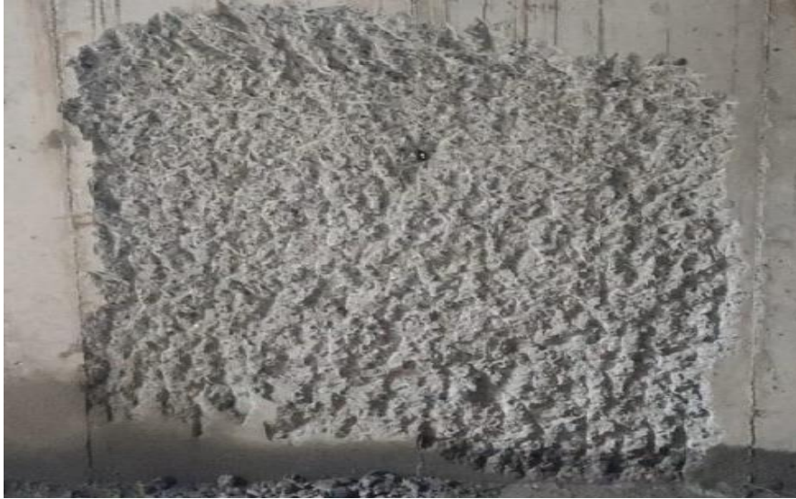
Figura 25. Proceso de picado de muro con protuberancias.
