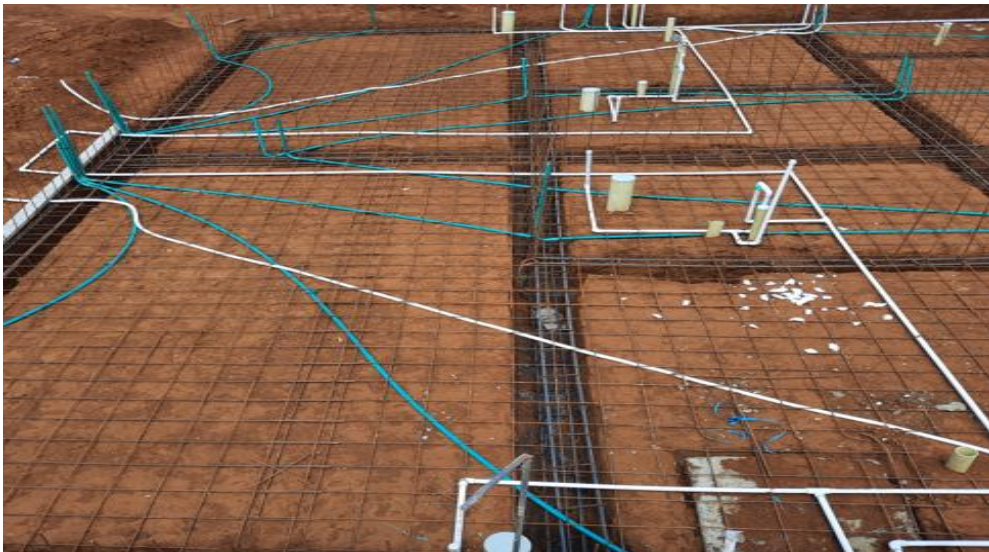
Figura 7. Estructura de la cimentación.
