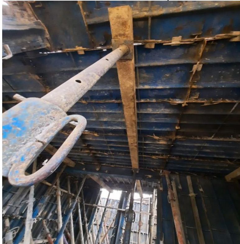
Figura 27. Soportes del encofrado de la losa de entre piso.
