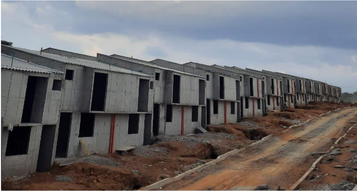
Figura 4. Sistema estructural con muros de carga.
