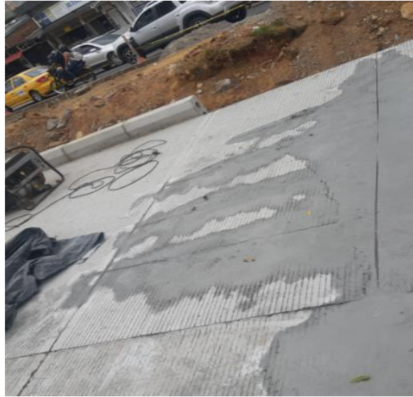
Ilustración 69. Corte juntas en eje 8 Fuente: Consorcio OXIKAB
