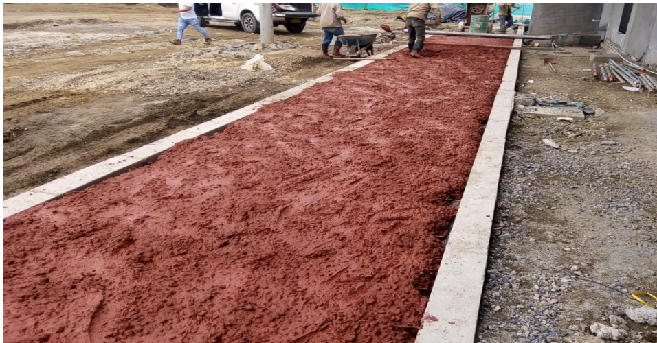
Ilustración 24. Instalacion de concreto MR38 color terracota Fuente: Autor
