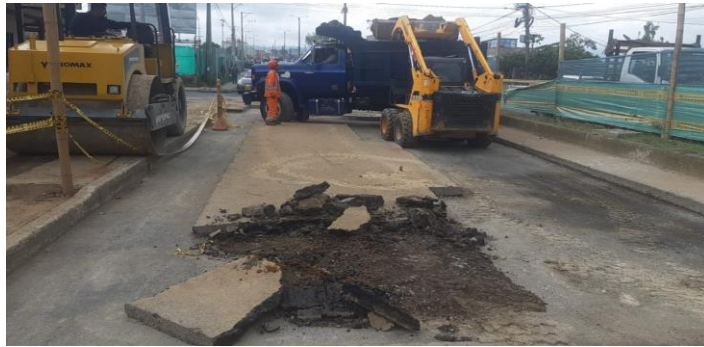
Ilustración 57. Retiro y excavacion carp. asfáltica eje 8 Fuente: Autor
