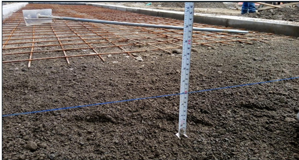
Ilustración 23 . Chequeo subbase y malla electrosoldada ciclo ruta entre eje 2 y 3 Fuente: Autor
