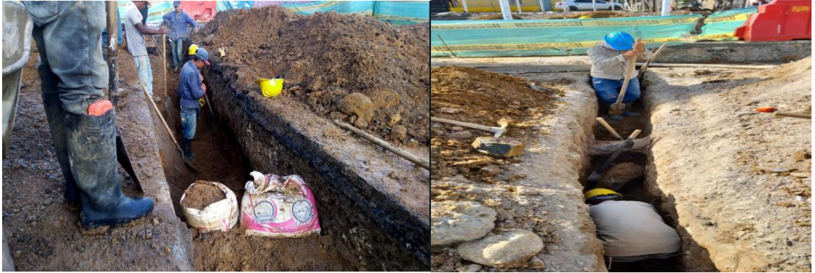
Ilustración 39. Excavación manual en eje 8 Fuente: Autor
