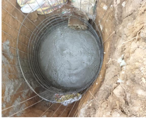
Ilustración 35. Solado cámara de inspección Sanitaria en eje 8 Fuente: Autor
