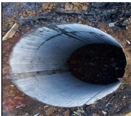
Ilustración 45. cámara inspección pluvial fundida eje 8 Fuente: Autor
