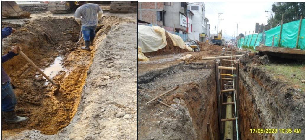
Ilustración 28. Entibado alcantarillado sanitario eje 8 Fuente: Autor
