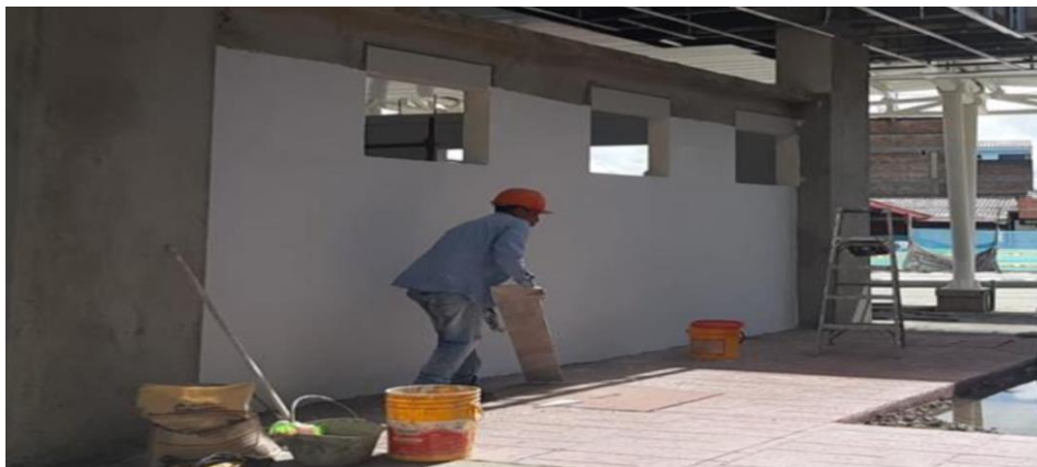
Ilustración 16. Estuco cara exterior modulo administrativo #1 C.A.D.E Fuente: consorcio OXIKAB
