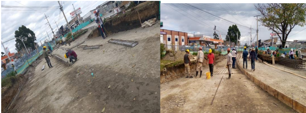
Ilustración 77. Formaleta metálica y de madera ejes 2 y 3. Fuente: Autor
