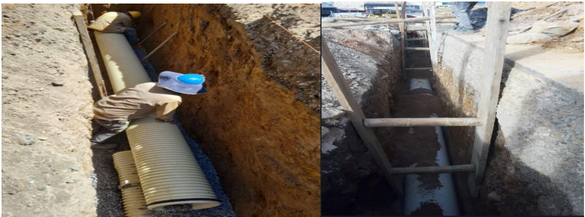
Ilustración 40. Empalme y atraque tubería de 16" Fuente: Consorcio OXIKAB
