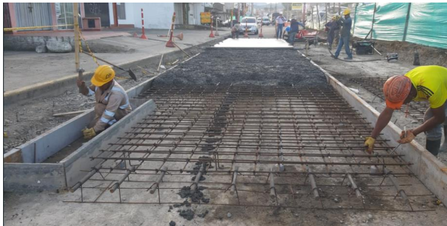
Ilustración 66. Parrillas acero de refuerzo de ½ " en eje 8 Fuente: Autor
