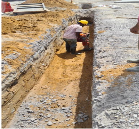
Ilustración 49. Relleno tipo I tubería acueducto eje 8 Fuente: Autor
