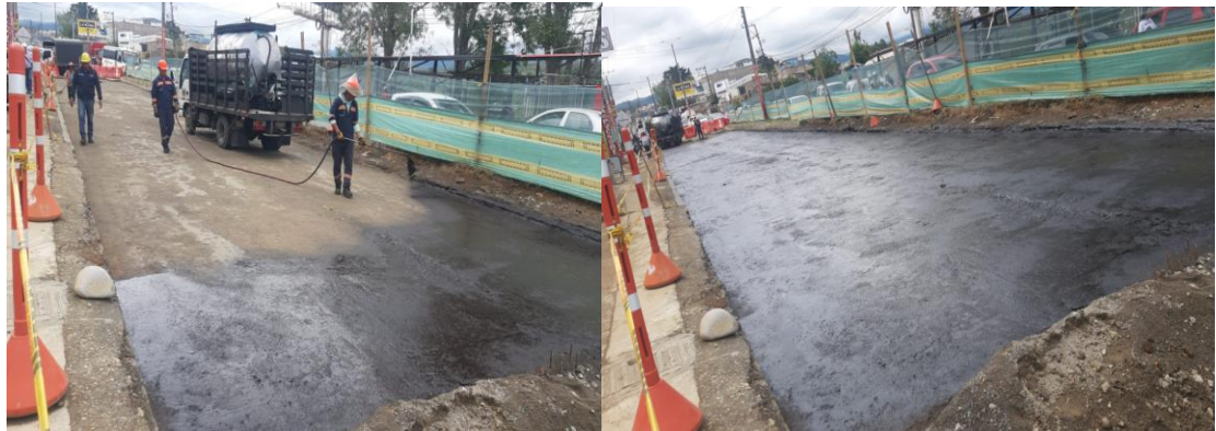
Ilustración 60. Imprimación con emulsión asfáltica tipo CRL-1 en eje 8 Fuente: Consorcio OXIKAB
