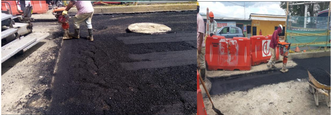
Ilustración 62. Compactación con vibro compactador MDC-19 en eje 8 Fuente: Consorcio OXIKAB
