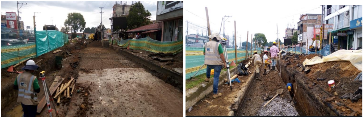
Ilustración 38. Nivelación y excavación con Comisión topográfica Fuente: Autor
