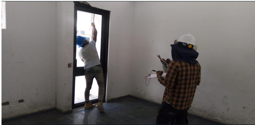
Ilustración 14. Medicion de vanos puerta de salon de capacitaciones. Fuente: Autor
