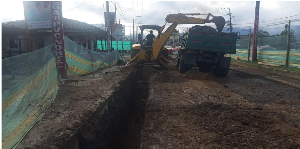
Ilustración 32. Transporte de material sobrante eje 8 Fuente: Autor
