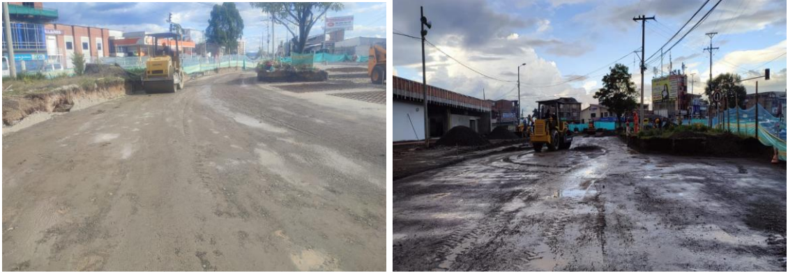
Ilustración 76. Compactacion subse ejes 2 y 3. Fuente: Autor
