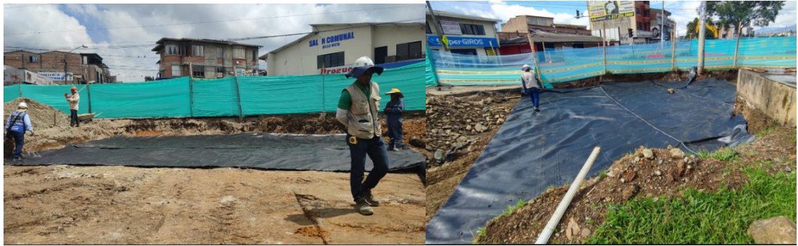
Ilustración 74. Geotextil tejido eje 2. Fuente: Consorcio OXIKAB
