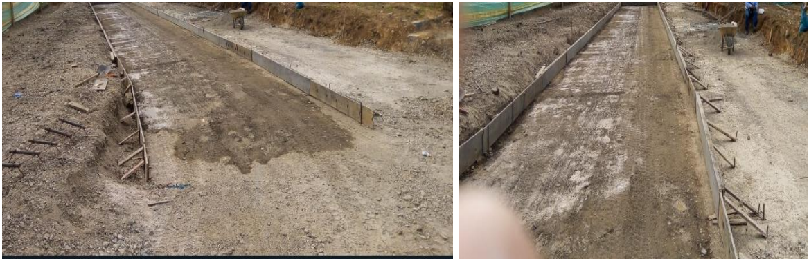
Ilustración 64. Formaleta eje 8 Fuente: Consorcio OXIKAB
