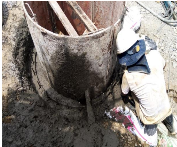
Ilustración 36. Fundición cámara inspección Sanitaria con formaleta metalica en eje 8 Fuente: Autor
