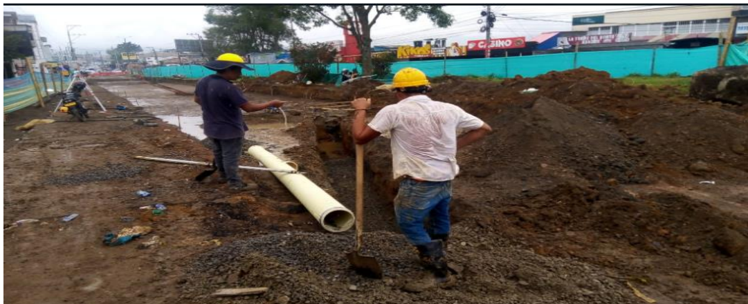
Ilustración 29. Instalación tubo 8" alcantarillado sanitario Fuente: Acueducto y alcantarillado de Popayán.
