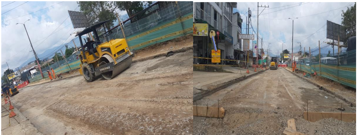
Ilustración 58. Compactacion rodillo liso Subbase eje 8 Fuente: Autor
