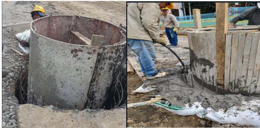
Ilustración 44. Proceso de fundición cámara inspección pluvial eje 8 Fuente: Autor
