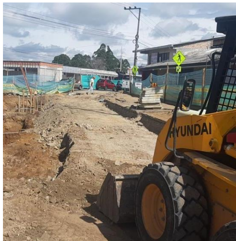
Ilustración 51. Nivelacion eje 8 con mejoramiento Fuente: Autor
