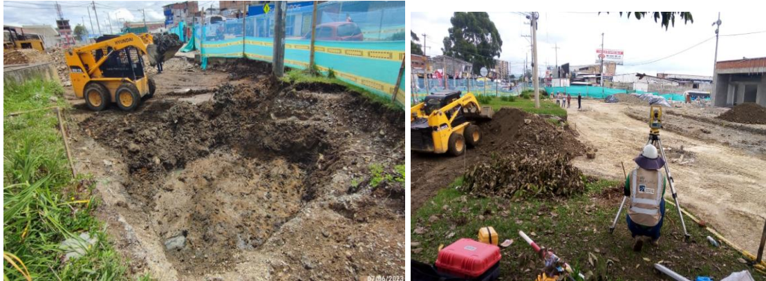
Ilustración 72. Excavación y retiro de material eje 2 y 3 Fuente: Autor
