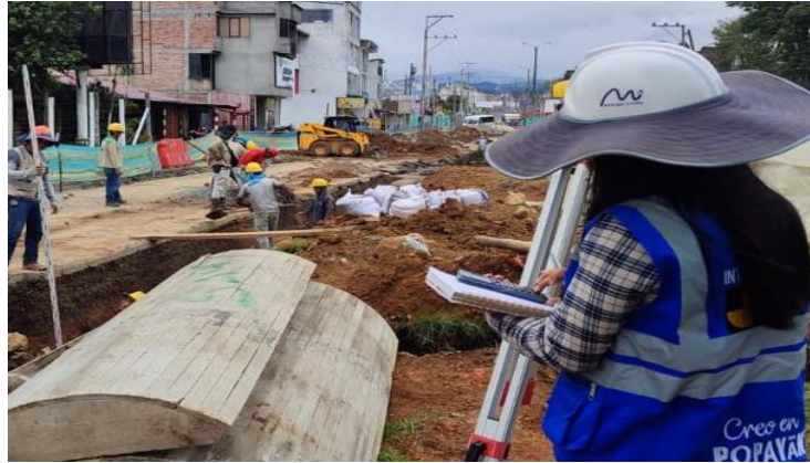
Ilustración 47. Altimetria comision topografica acueducto eje 8 Fuente: Consorcio OXIKAB
