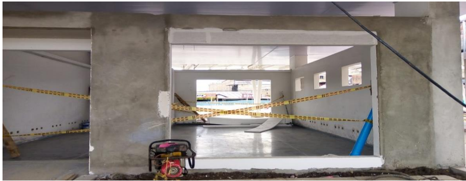
Ilustración 15. Repello cara exterior modulo administrativo #1 C.A.D.E Fuente: consorcio OXIKAB
