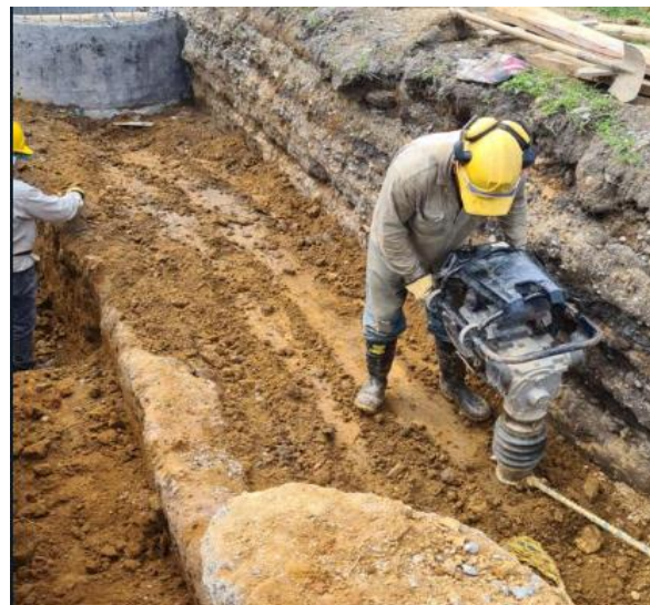
Ilustración 31. Compactación Relleno superior eje 8 Fuente: Autor
