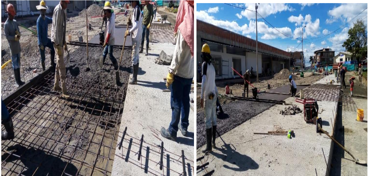
Ilustración 79. Vaciado de concreto ejes 2 y 3. Fuente: Autor
