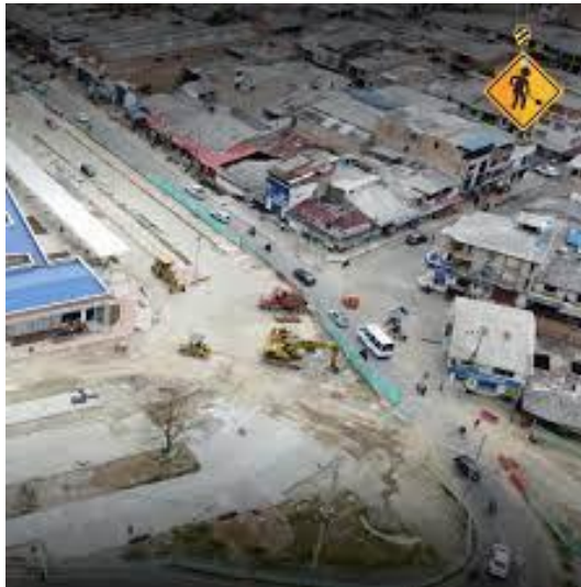
Ilustración 10. Avance de obra en la iniciación de la pasantía Fuente: Movilidad Futura S.A.S.
