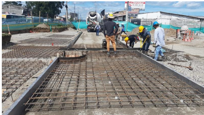
Ilustración 78. Parrillas de refuerzo D=1/2" ejes 2 y 3. Fuente: Autor
