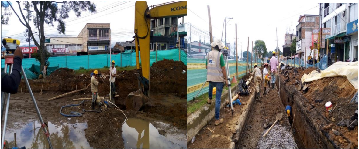
Ilustración 26. Trabajo topográfico nivelación, demarcación y excavación. Fuente: Autor
