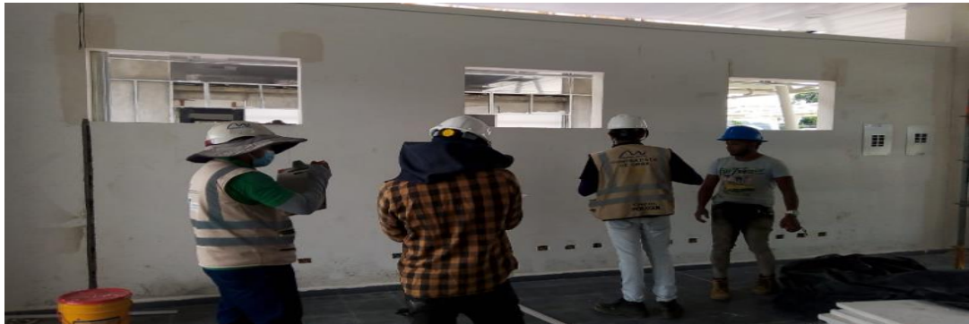
Ilustración 11. Medición con interventoría procesos arquitectónicos Fuente: Autor
