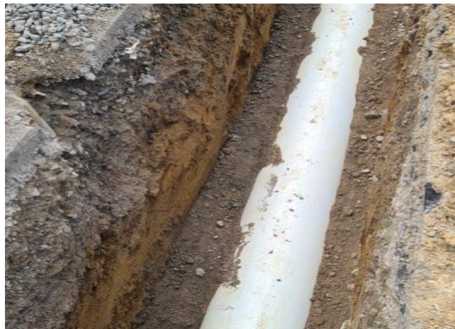
Ilustración 48. Encamado tubería acueducto eje 8 Fuente: Autor
