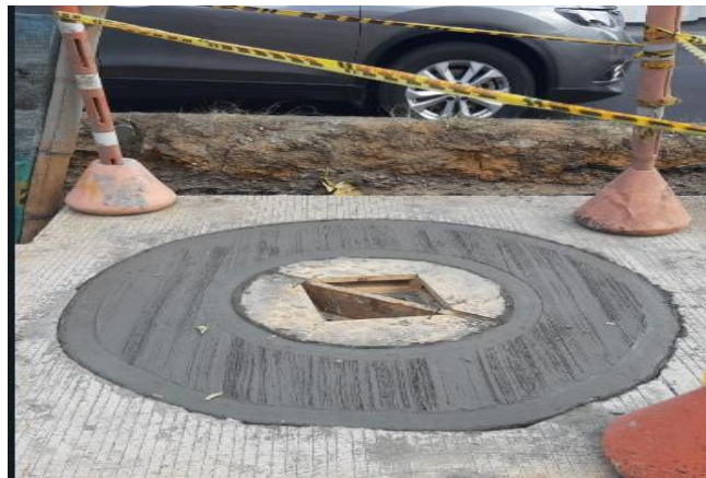
Ilustración 70. Fundición de brocales en eje 8 Fuente: Consorcio OXIKAB
