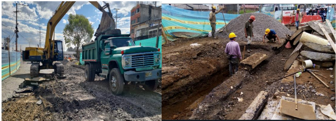
Ilustración 46. Excavación y retiro material sobrante acueducto eje 8
