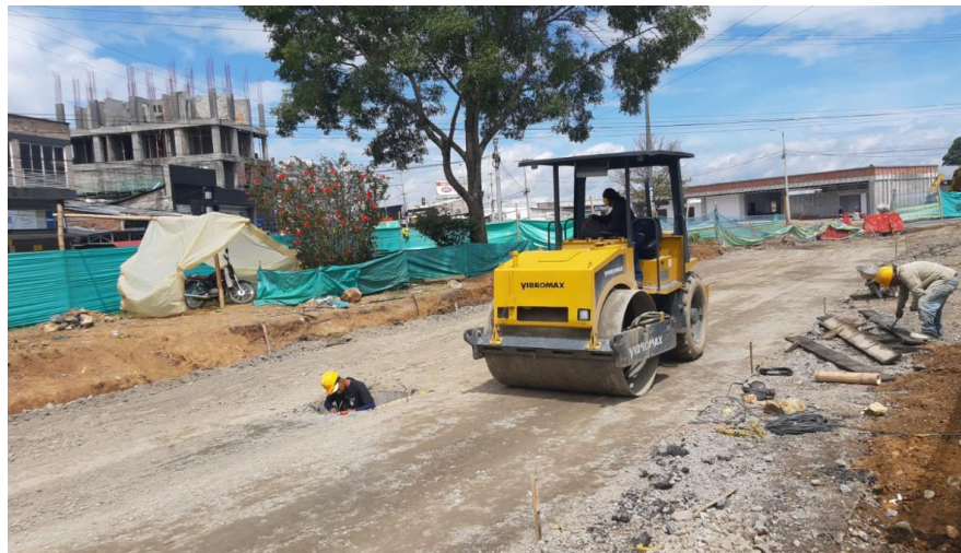
Ilustración 55. Compactacion Subbase eje 8 Fuente: Autor
