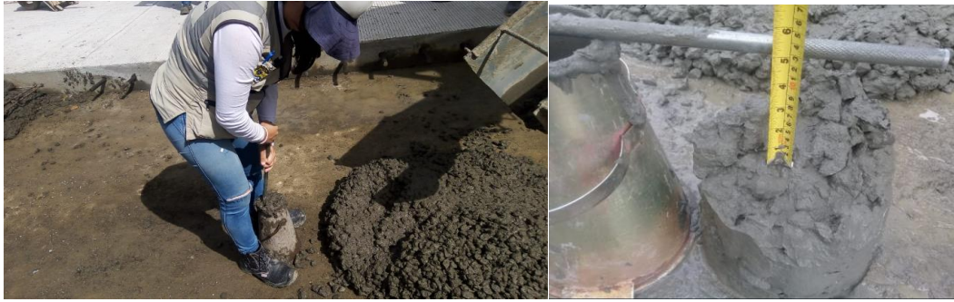
Ilustración 67. Ensayo slump en eje 8 Fuente: Autor
