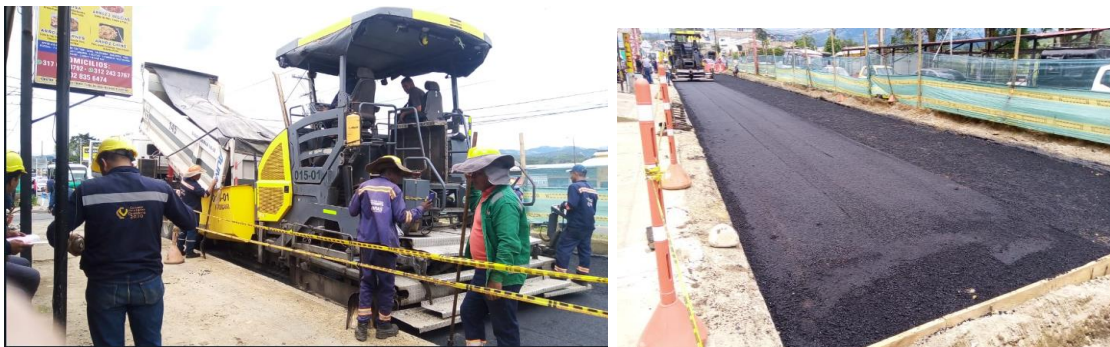
Ilustración 61. Riego mezcla asfáltica en eje 8 Fuente: Consorcio OXIKAB
