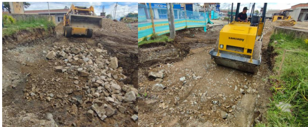
Ilustración 73. Riego y compactación pedraplén eje 2. Fuente: Autor
