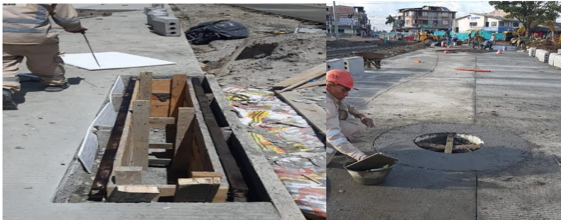
Ilustración 82. Fundición de brocales y sumideros ejes 2 y 3. Fuente: Autor
