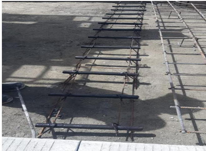
Ilustración 65. Canastilla pasajuntas en eje 8 Fuente: Autor
