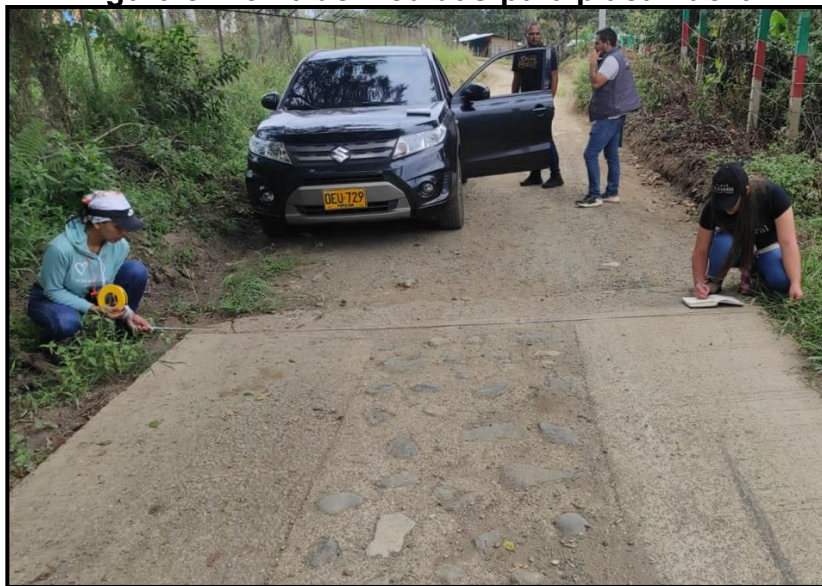
Figura 8. Toma de medidas para placa huella
