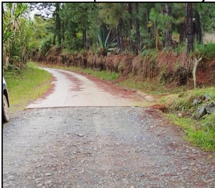
Figura 31. Estado actual placa huella vereda Bajo Cauca
