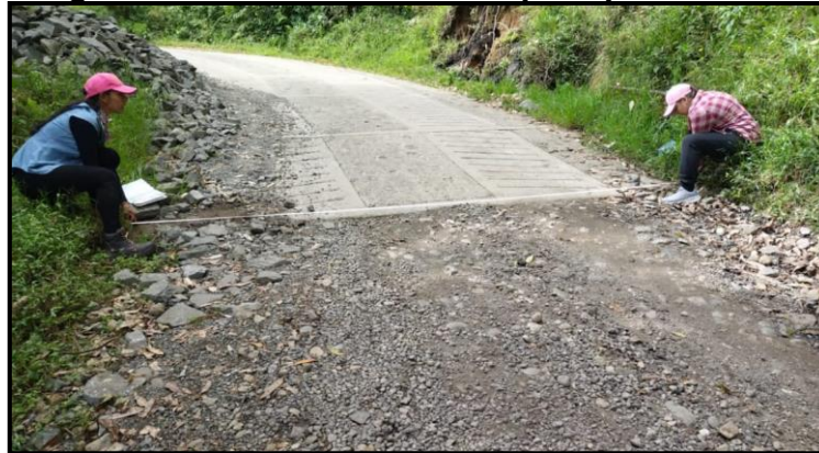
Figura 21. Toma de medidas para placa huella
