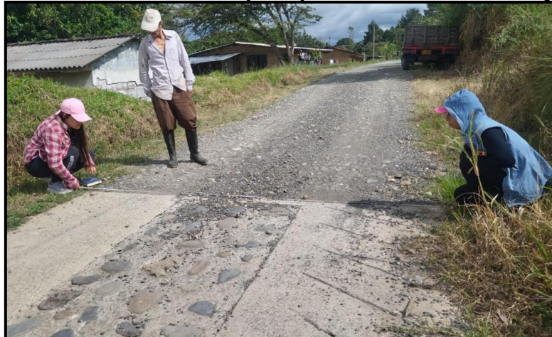
Figura 37. Toma de medidas para placa huella vereda Cajamarca
