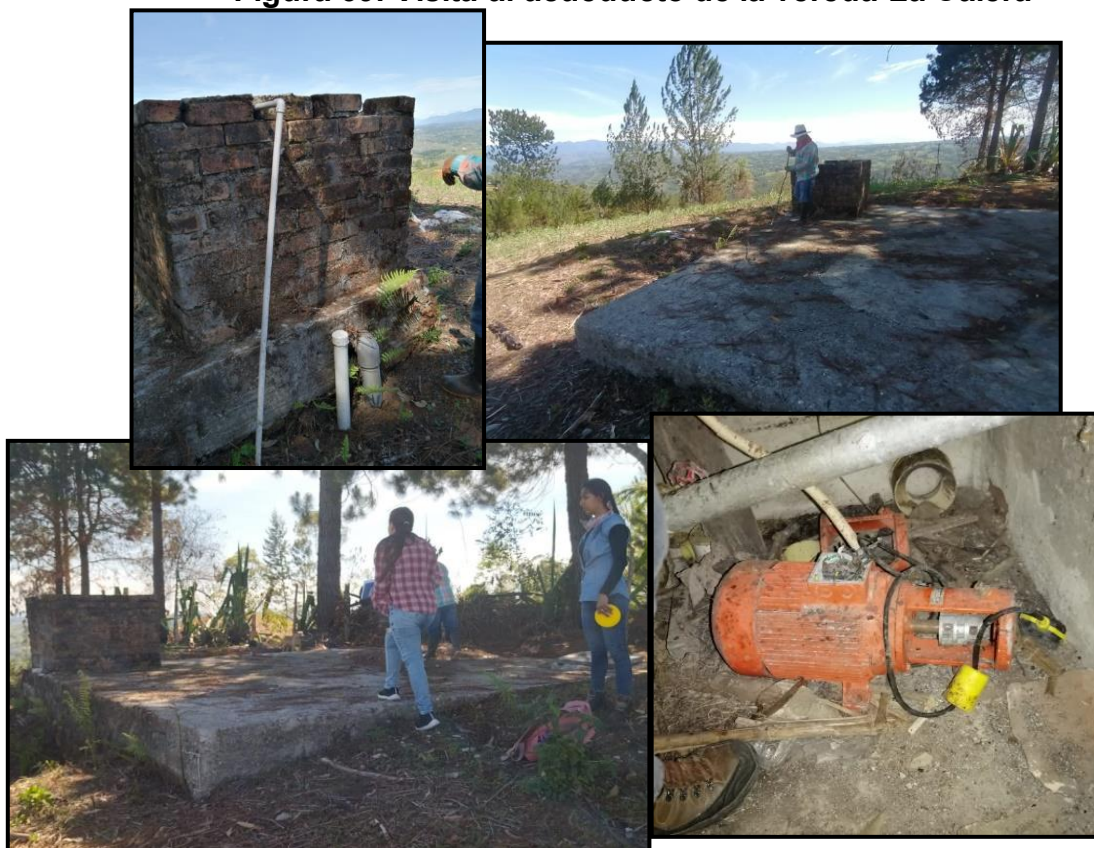
Figura 69. Visita al acueducto de la vereda La Calera
