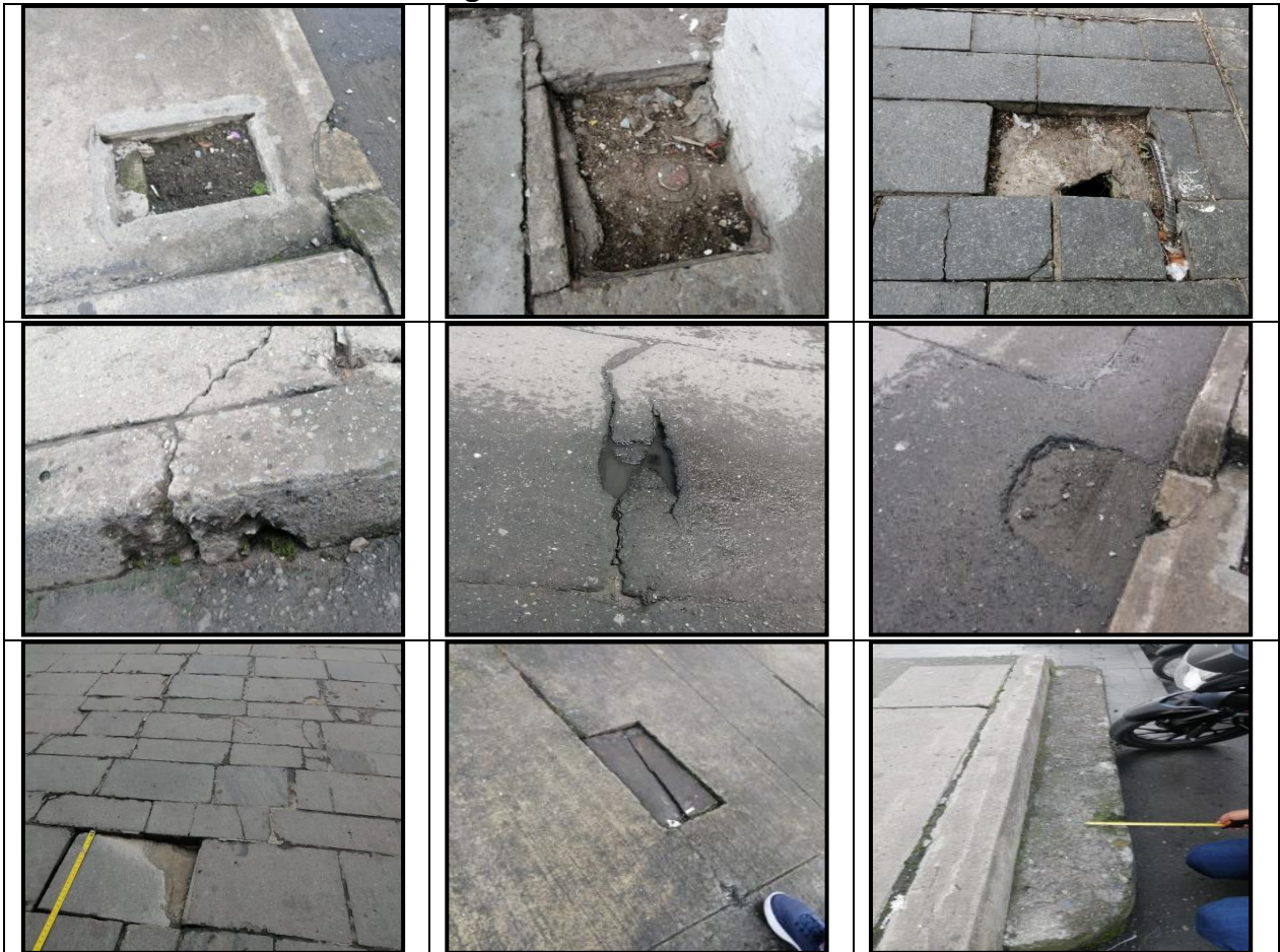
Figura 84. Toma de medidas y evidencia del estado de las calles sector de la gobernación del Cauca
