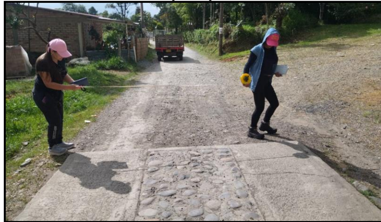
Figura 54. Toma de medidas para placa huella vereda Santana 1
