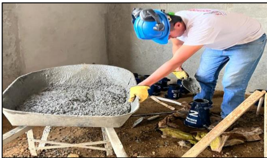
Imagen 7. Vertido del concreto en el molde tronco-cónico
