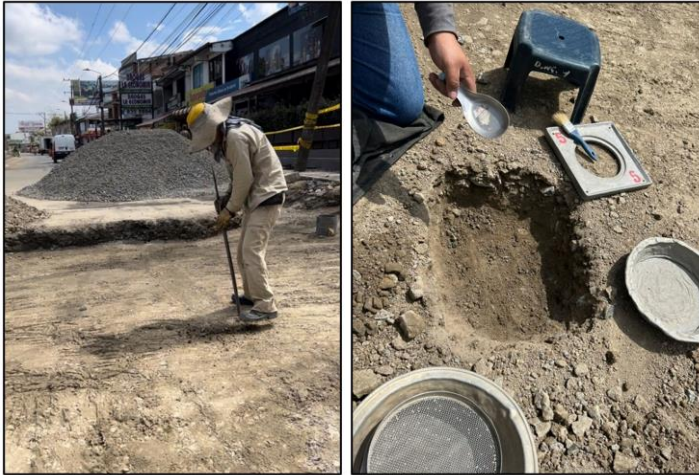
Imagen 13. Excavación para toma de densidad en el eje de la vía
