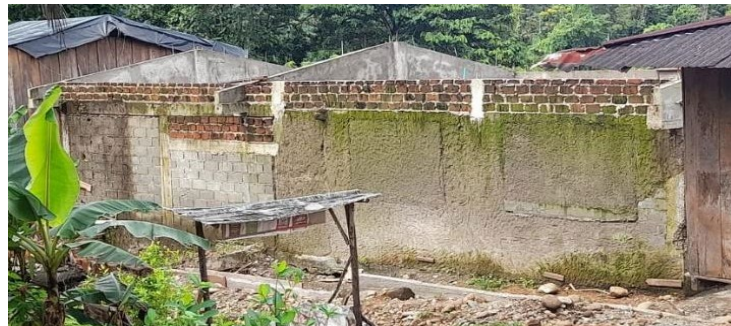
Fuente: Fotografía en sitio – C.E. Arenal.
