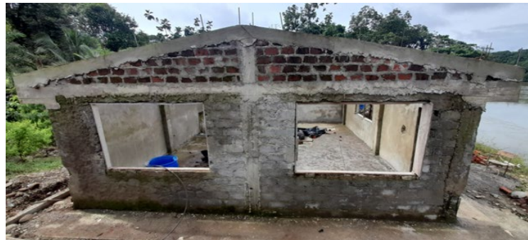
Fuente: Fotografía en sitio – C.E. Arenal.
