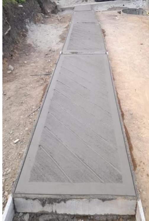
Figura 46. Placa con superficie texturizada para garantizar seguridad al usuario, el Rodeo, Páez
