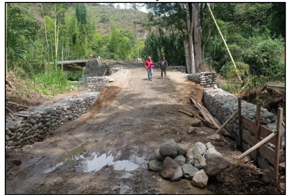
Figura 102. Proceso de relleno de la estructura de aproximación
