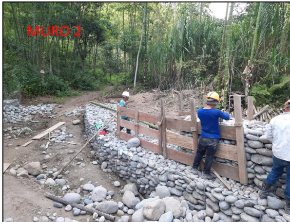
Figura 99. Proceso constructivo de estructura de aproximación, puente la Macana, muro 2
