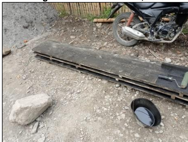
Figura 34. Aplicación de desmoldante (aceite quemado) en la formaleta, resguardo de San Andres, Inzá
