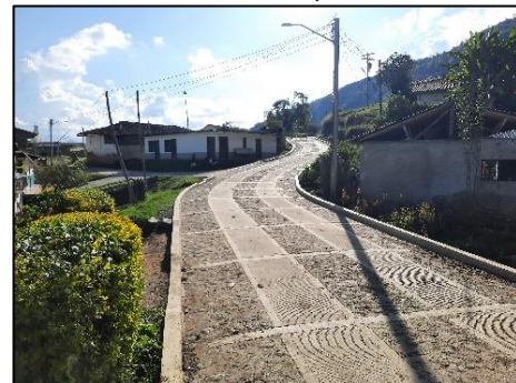
Figura 71. Pavimento con placa huella, Santa Rosa, Inzá.
