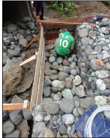
Figura 93. Entibado y llenado de la unidad de gavión, Ricaurte
