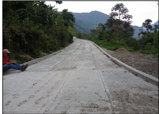
Figura 10. Placa huella eje vial Talaga, Páez
