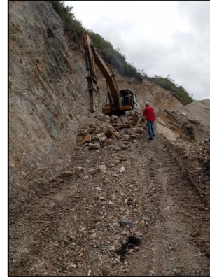
Figura 84. Construcción el eje vial Lame-Suin-Chinas-Guaquiyo.
