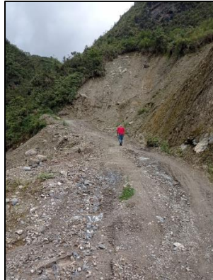
Figura 87. Construcción el eje vial Lame-Suin-Chinas-Guaquiyo.
