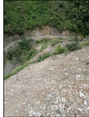
Figura 86. Construcción el eje vial Lame-Suin-Chinas-Guaquiyo.
