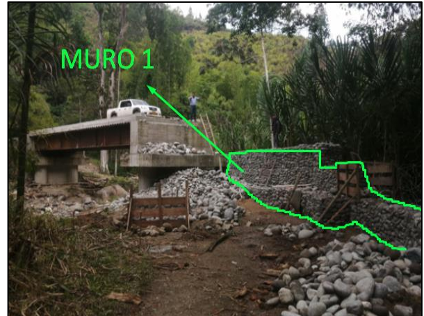
Figura 98. Proceso constructivo de estructura de aproximación, puente la Macana, muro 1
