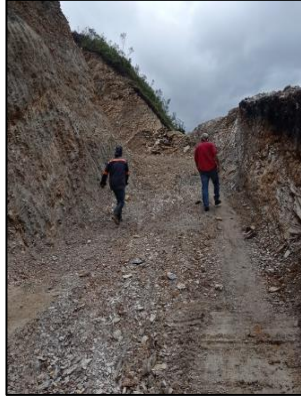
Figura 83. Construcción el eje vial Lame-Suin-Chinas-Guaquiyo.
