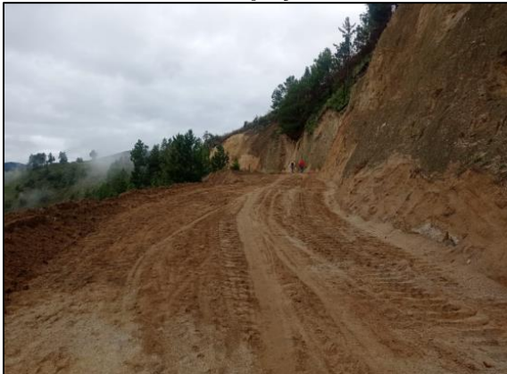
Figura 81. Construcción eje vial Taravira - Guaquiyo – Avirama.
