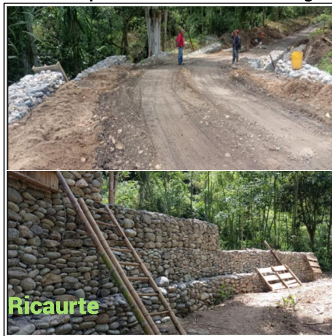
Figura 89. Estructura de aproximación con muros en gaviones, Ricaurte.
