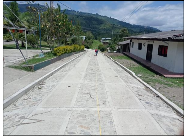
Figura 16. Placa huella Calderas, Inzá
