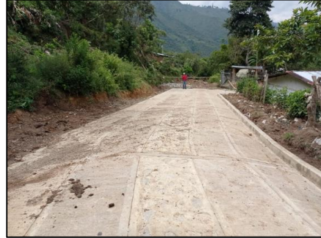
Figura 67. Pavimento con placa huella, Guapio, Páez.
