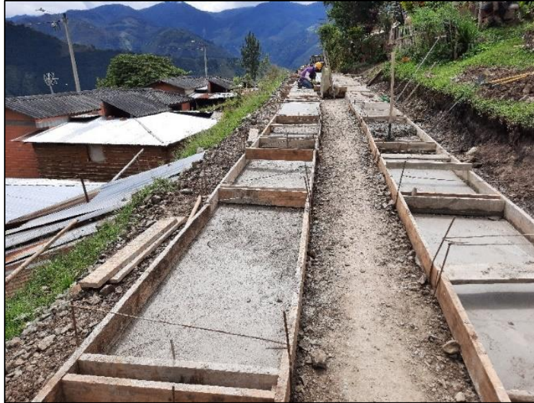
Figura 36. Solado de limpieza para losa de concreto, Aguacatico, Páez
