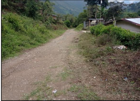
Figura 66. Sitio de la obra, Guapio, Páez.
