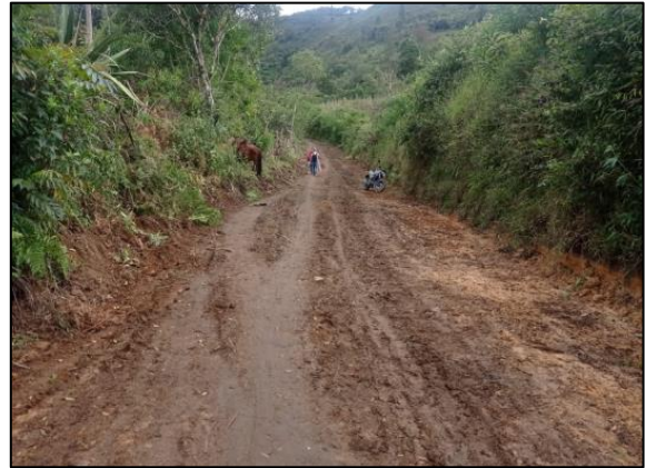
Figura 80. Construcción eje vial Taravira - Guaquiyo – Avirama.
