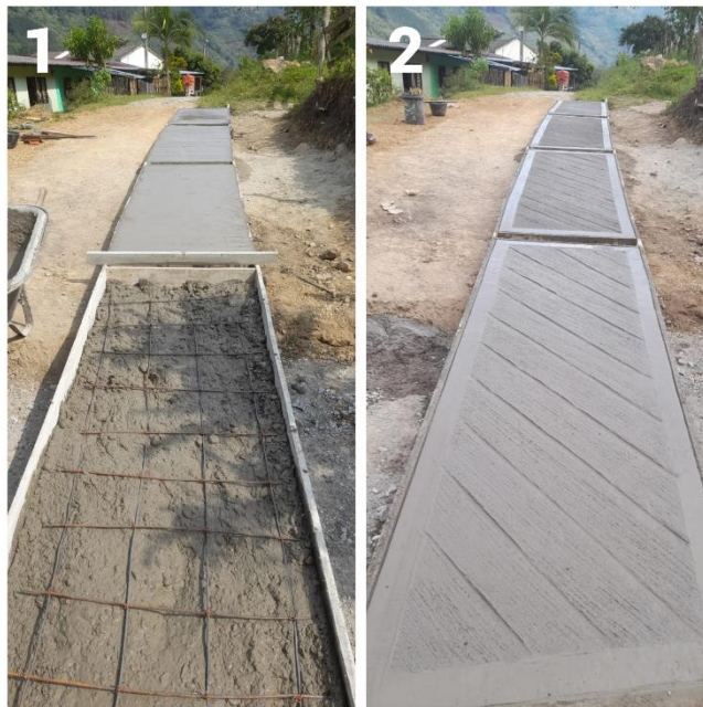
Figura 37. fundición de placas de concreto armado, El Rodeo, Páez.
