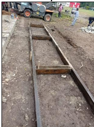
Figura 33. Formaleta de placa huella, módulos, placa huella en el asentamiento Guapio
