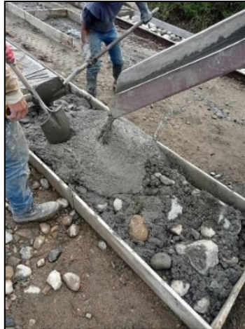
Figura 38. Fundición de concreto ciclópeo 60% concreto de 21Mpa y 40% piedra, San Miguel, Páez
