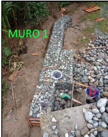
Figura 97. Proceso constructivo de estructura de aproximación, puente la Macana, muro 1
