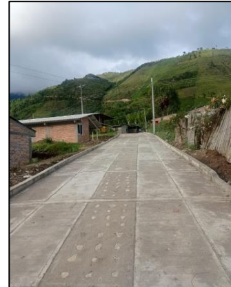
Figura 69. Pavimento con placa huella, Talaga, Páez.
