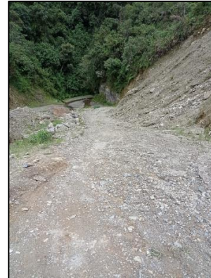
Figura 88. Construcción el eje vial Lame-Suin-Chinas-Guaquiyo.
