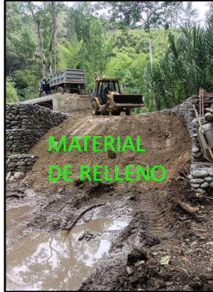
Figura 101. Proceso de relleno de la estructura de aproximación
