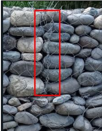
Figura 95. Unión tejida entre unidades de gavión, Puente la Macana, Ricaurte
