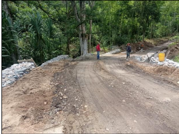
Figura 20. Obras de mejoramiento del eje vial Ricaurte-San Luis
