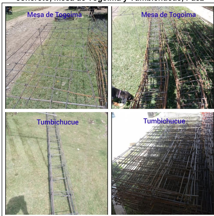
Figura 35. Figurado y armado de acero para vigas riostras bordillos y placas de concreto, mesa de Togoima y Tumbichucue, Páez
