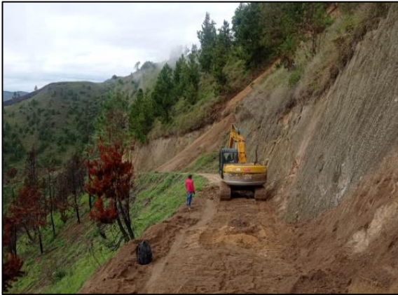
Figura 79. Construcción eje vial Taravira - Guaquiyo – Avirama.
