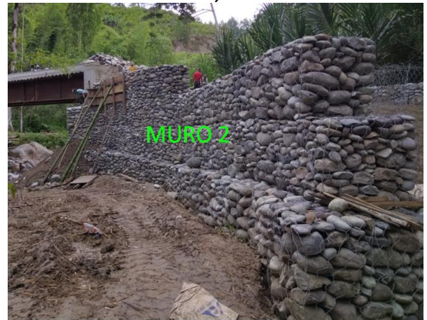
Figura 100. Proceso constructivo de estructura de aproximación, puente la Macana, muro 2
