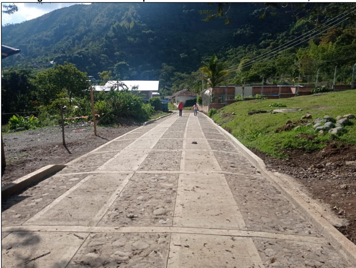
Figura 27. Pavimento con placa huella terminado en Santa Rosa, Inzá
