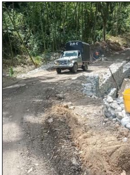
Figura 103. Vehículo subiendo por la estructura de aproximación puente la Macana
