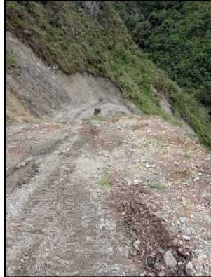
Figura 85. Construcción el eje vial Lame-Suin-Chinas-Guaquiyo.
