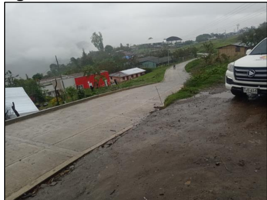
Figura 12. Placa huella Lame, Páez
