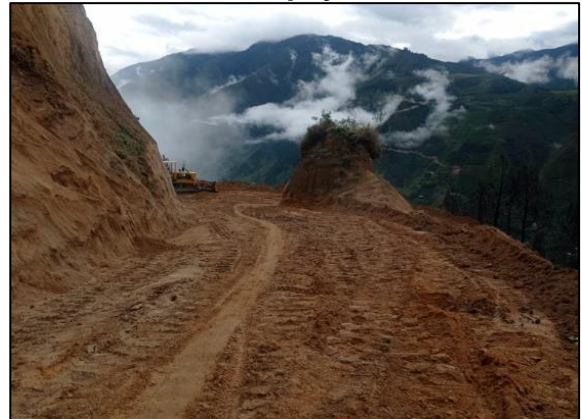
Figura 82. Construcción eje vial Taravira - Guaquiyo – Avirama.
