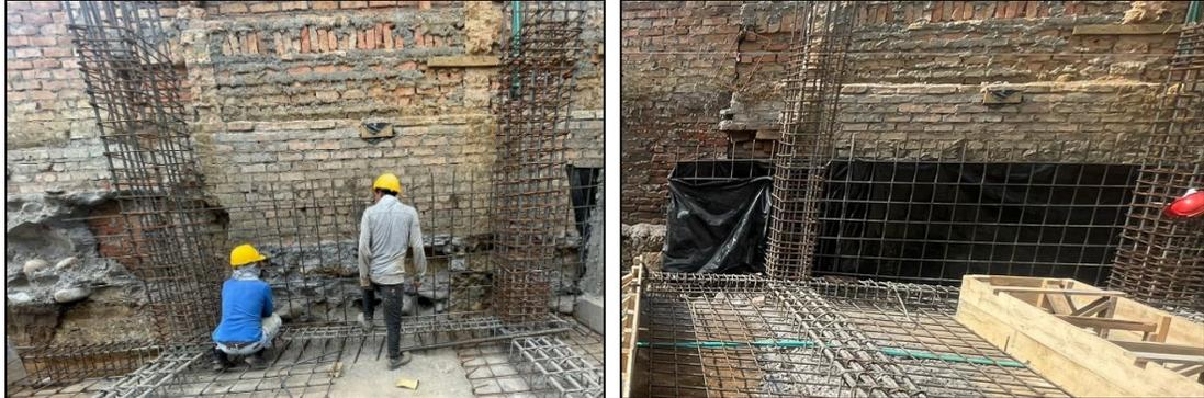
*Ilustración 85, Armado muro de contención, Fuente: Elaboración propia.*
