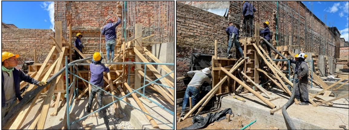
*Ilustración 92, fundición arranques de columnas de los ejes 7 y 8, Fuente Elaboración propia*
