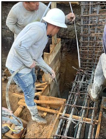
*Ilustración 26, Vibrado de Cabezales eje 11 E. Fuente: Constructora Open House.*
