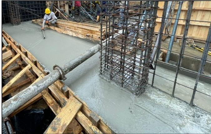
*Ilustración 58, Fundición de zarpa del eje 9, Fuente: Elaboración propia.*
