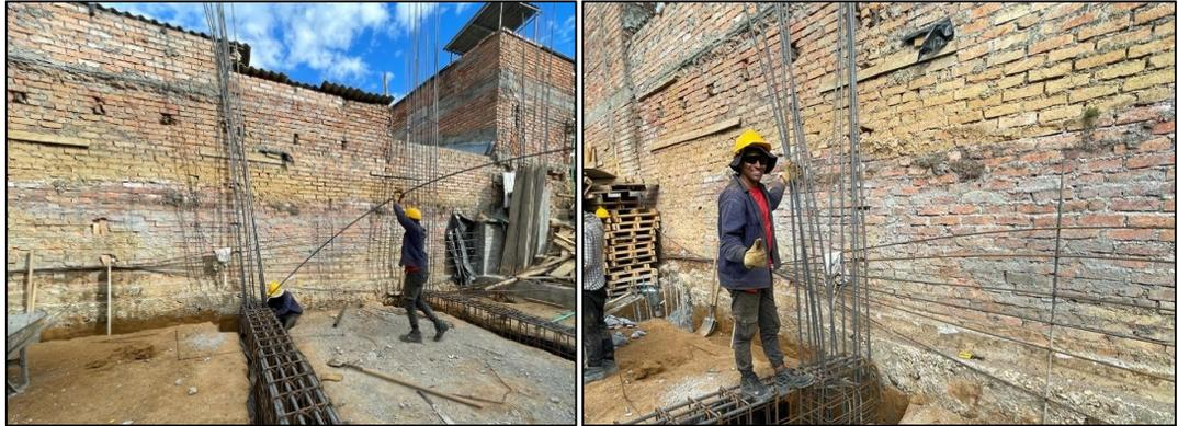
Ilustración 107, Arranque de columnas, Fuente: Elaboración propia.
