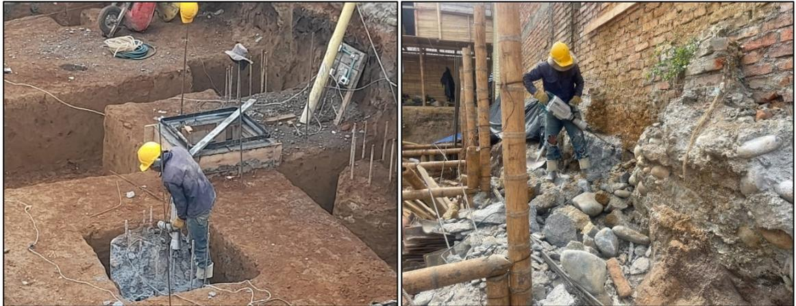
*Ilustración 98, demolición y descabezado de pilotes, Fuente: Elaboración propia.*
