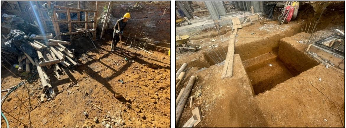
*Ilustración 97, Excavaciones cimentación superficial, Fuente: Elaboración propia*
