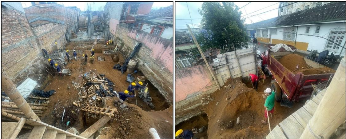
*Ilustración 99, Demolición y transporte de escombros, fuente Elaboración propia*
