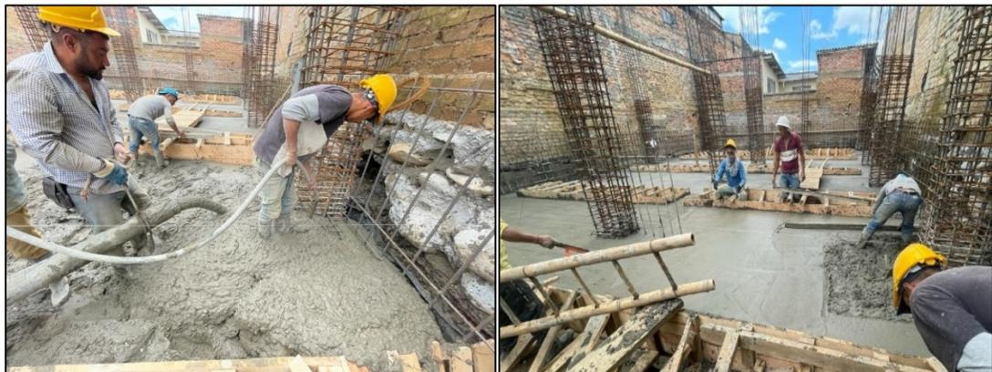
*Ilustración 48, vibrado y nivelación de concreto*
