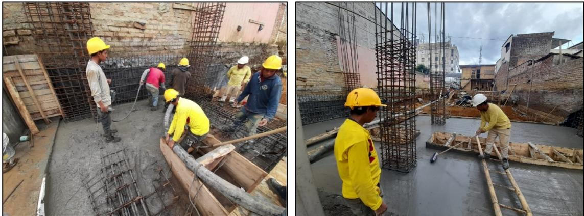
Ilustración 88, Fundición concreto Zarpas ejes 7 y 8, Fuente: Elaboración propia.
