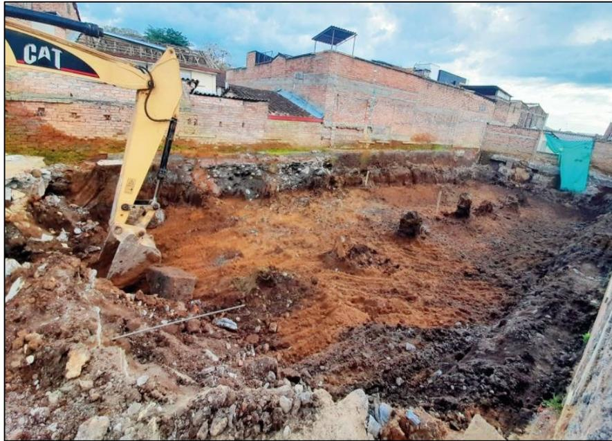
*Ilustración 12, Excavación y descapote de terreno, fuente Constructora Open House*
