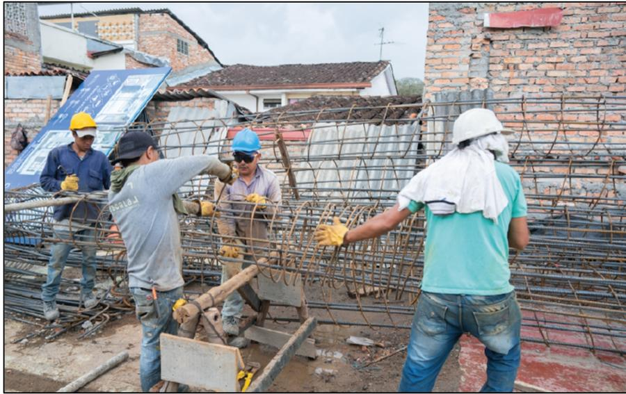
*Ilustración 10, armado de acero para pilotes, fuente constructora open house*
