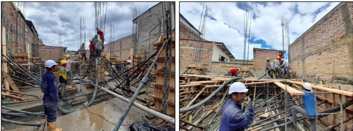
Ilustración 57, Vaciado y vibrado de concreto
