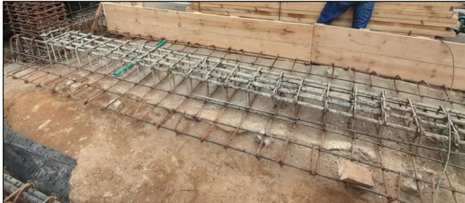
*Ilustración 53, Armado de zarpa eje 9, Fuente: Elaboración propia.*
