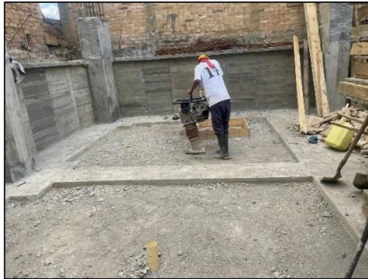
*Ilustración 93, compactación losas entre eje 12 y 14, Fuente: elaboración propia.*
