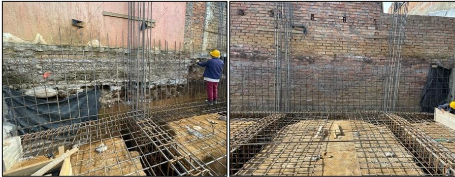
Ilustración 112, Armado muros de contención Fuente: Elaboración Propia.
