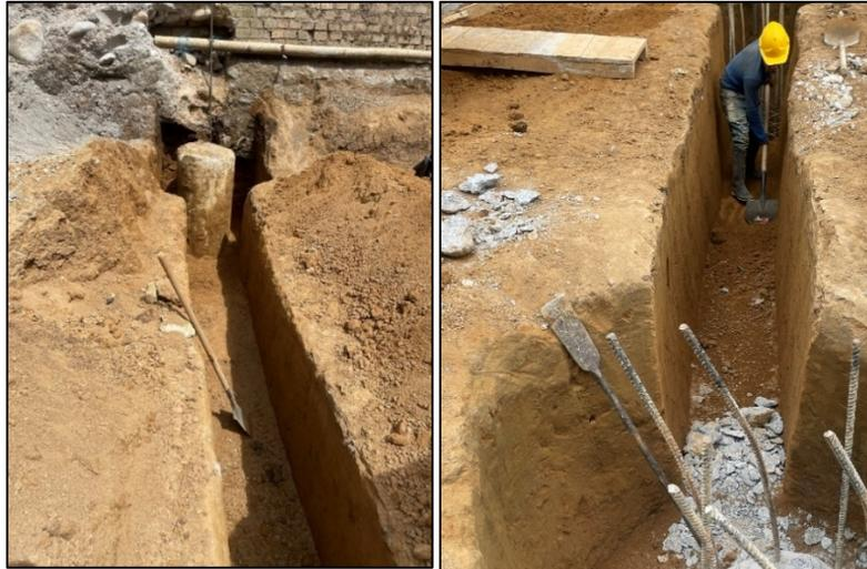
*Ilustración 70, excavación y perfilado vigas de cimentación y cabezales eje 8 y 7, Fuente: Elaboración propia.*
