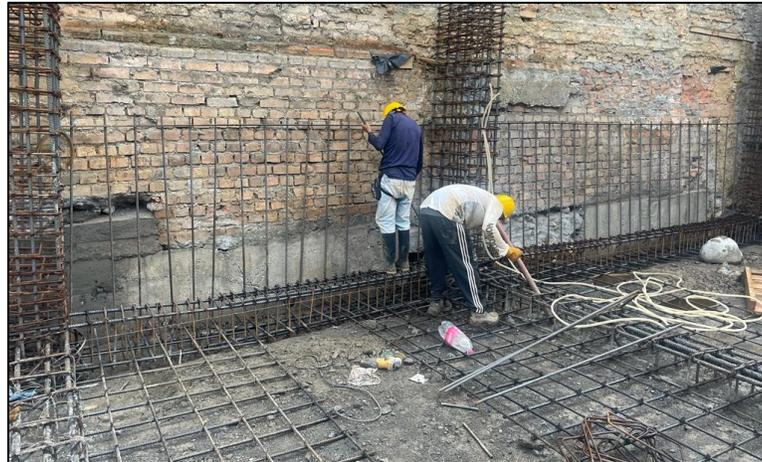
*Ilustración 39, Armado muro de contención eje A, fuente elaboración propia*
