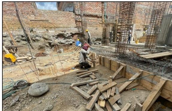
*Ilustración 86, Encofrado zapatas ejes 7 y 8, Fuente: Elaboración propia.*
