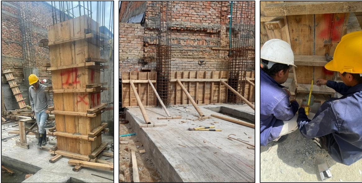
Ilustración 90, Encofrado Columnas y muros de contención ejes 7 y 8. fuente: Elaboración propia.
