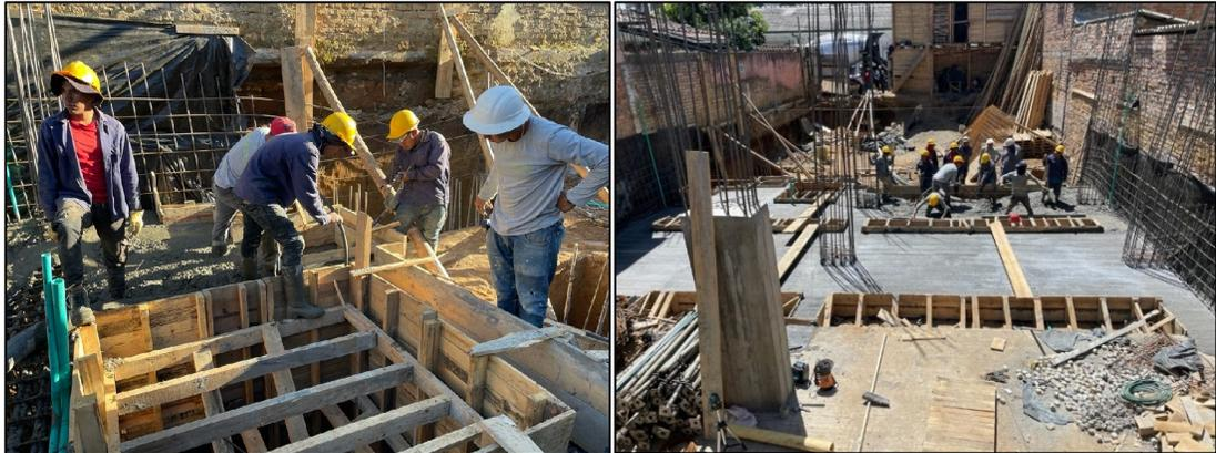
Ilustración 117, Fundición zapatas ejes 5 y 6, y foso del elevador, Fuente: Elaboración propia.
