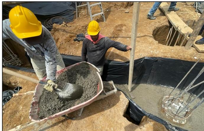
Ilustración 16, fundición de concreto de solado resistencia  $f'c$  17 MPa, elaboración Ing. Héctor López
