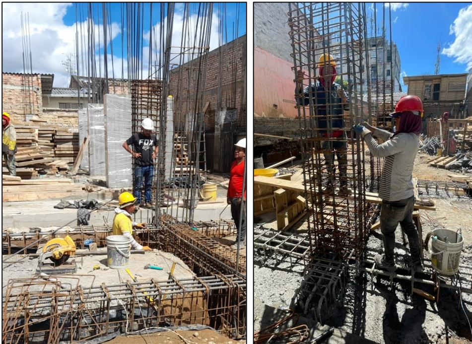
*Ilustración 77, instalación de arranques de columnas, Fuente: Elaboración propia.*
