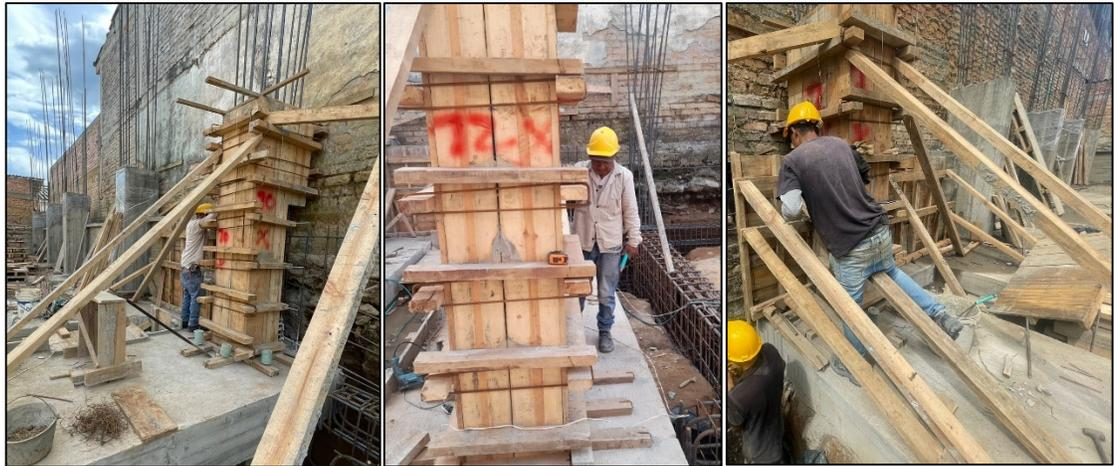
Ilustración 78, Encofrado columnas 9A, 9C, 9F y muros de contención. Fuente: Elaboración propia.
