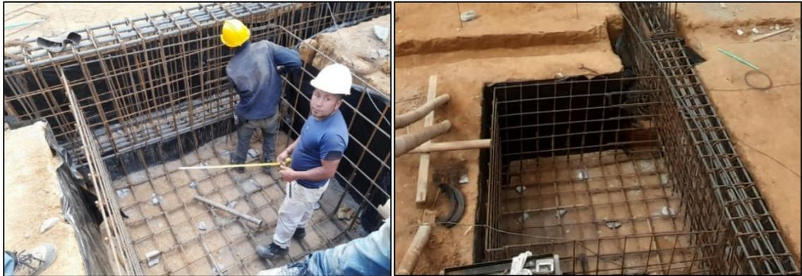
Ilustración 105, Armado foso del elevador, Fuente: Elaboración propia.
