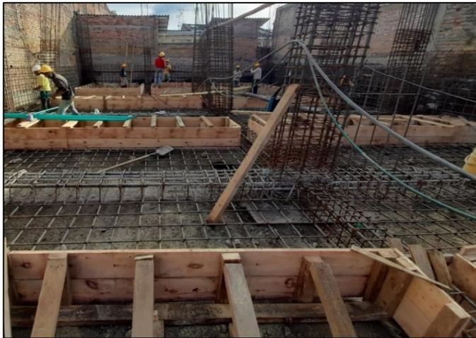
*Ilustración 42, Encofrado de zarpas, Fuente: Elaboración propia.*
