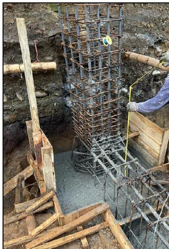
*Ilustración 27, Nivelación de concreto, fuente: Elaboración Ing. Héctor López*
