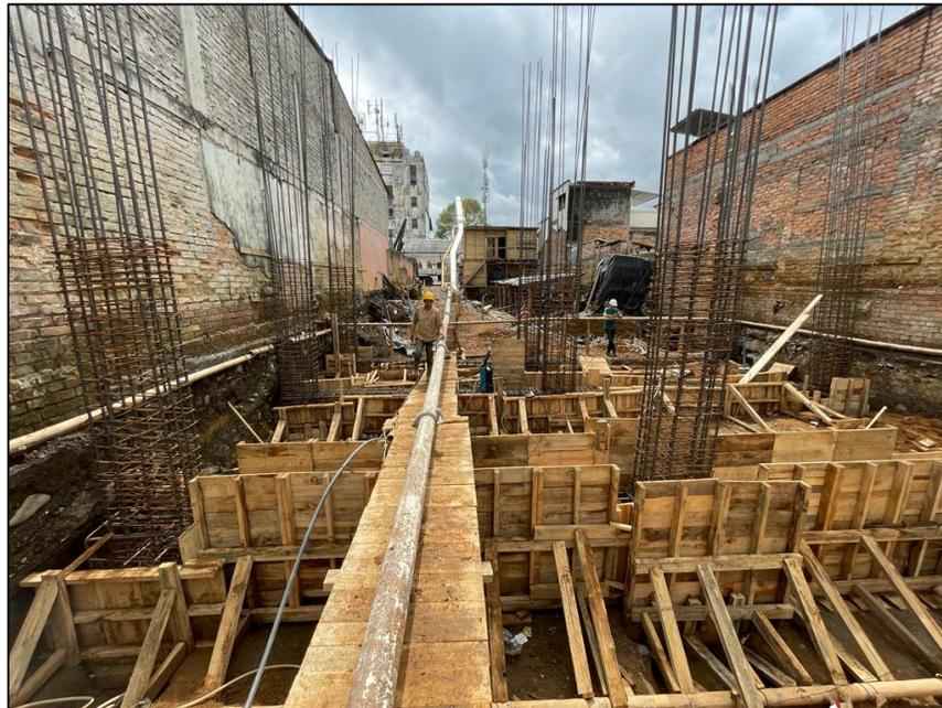
Ilustración 27, encofrado y armado de acero de vigas, parrillas y columnas del bloque 2, Elaboración Ing. Héctor López
