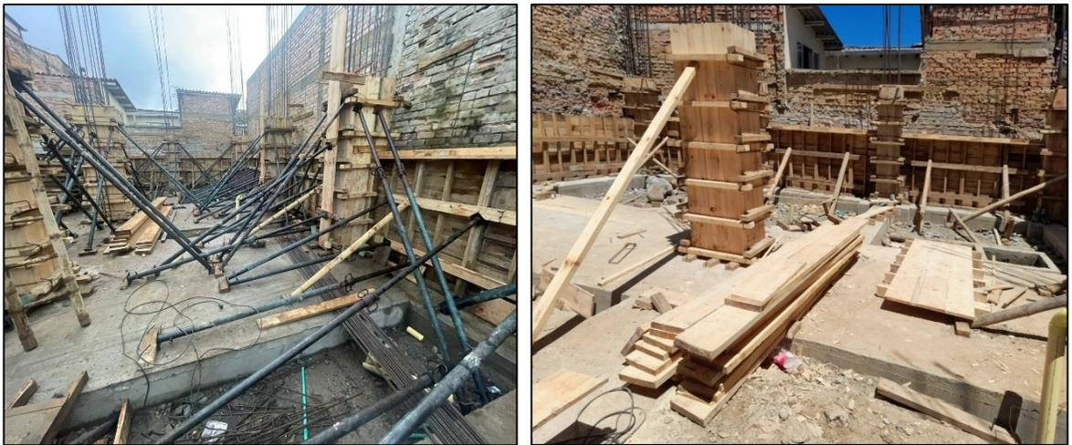
Ilustración 55, Encofrado y apuntalado de muros eje 14, A de 14 a 10, E-F de 14 a 10, y columnas 14A, 14B, 14D, 14E-F, 12A, 12C, 12E-F, 11A, 11C, 11E-F, 10A, 10C, 10E-F Fuente: Elaboración propia
