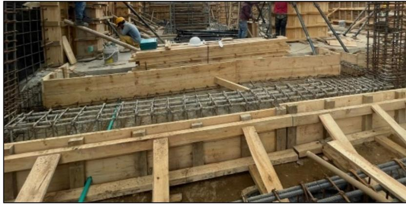
Ilustración 54, Encofrado de zarpa eje 9, Fuente: Elaboración propia.
