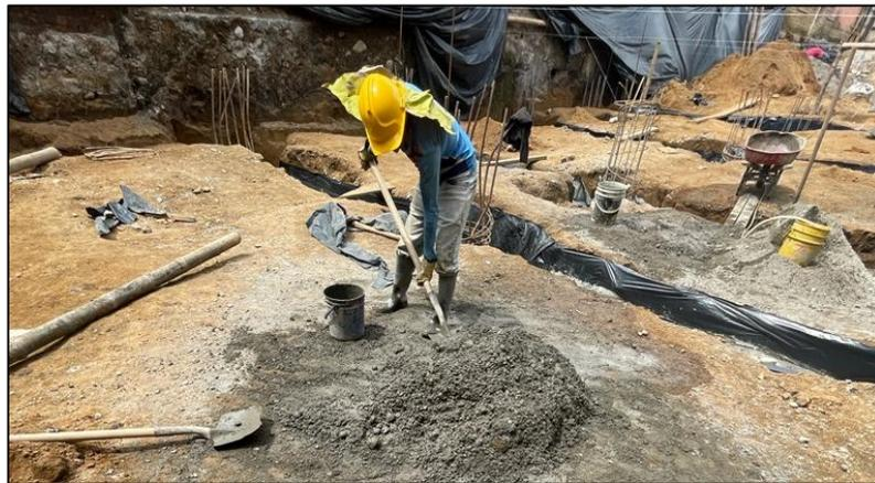
Ilustración 15, Preparación concreto de resistencia  $f'c=17\text{MPa}$  Fuente: Constructora Open House
