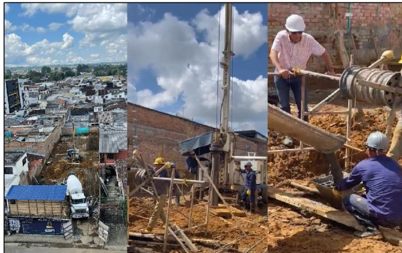
*Ilustración 11, fundición pilotes, Fuente: constructora Open House*
