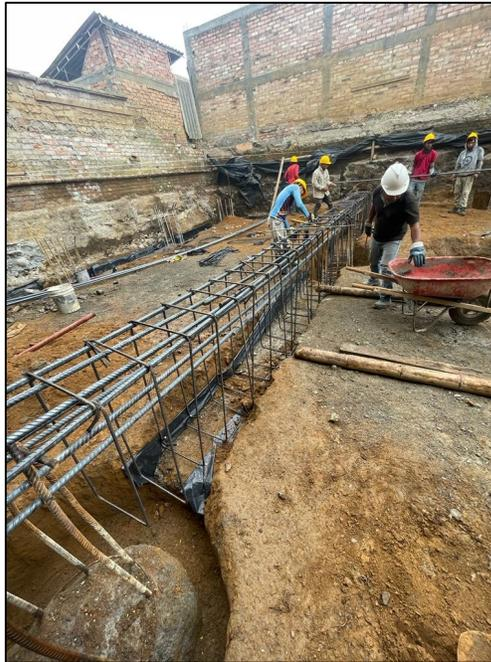
Ilustración 21, Armado de acero de refuerzo vigas transversales bloque 2, Fuente: Constructora Open House
