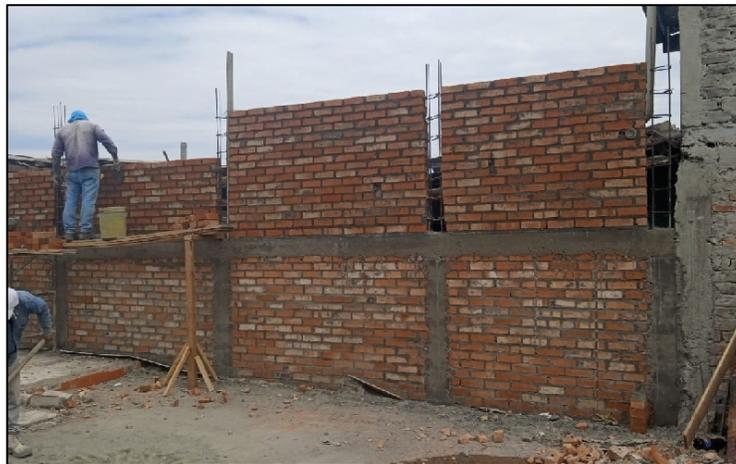
*Ilustración 5, construcción muro en mampostería en propiedad colindante, fuente: Constructora Open House.*
