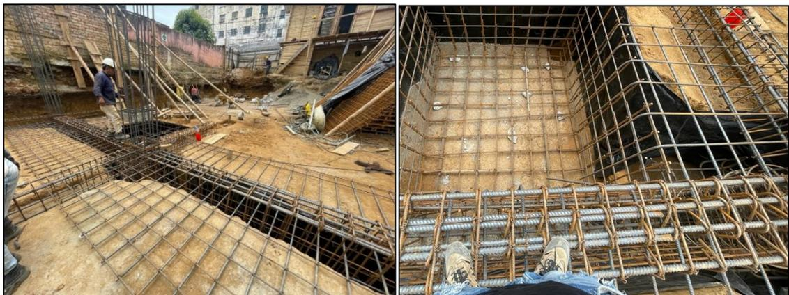
Ilustración 109, Armado zarpa ejes 5, y 6, Fuente: Elaboración propia.
