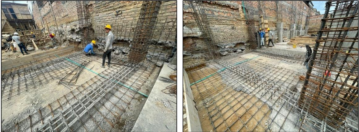
Ilustración 83, Armado Zarpas eje 7 y 8, Fuente: Elaboración propia.
