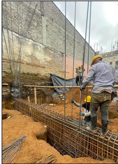
*Ilustración 23, Colocación aceros de columna 9C, Fuente: Constructora Open House*
