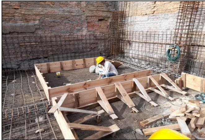
*Ilustración 41, Encofrado de zarpas, Fuente: Elaboración propia.*
