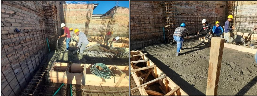
*Ilustración 47, vaciado y nivelación de concreto, Fuente: elaboración propia*
