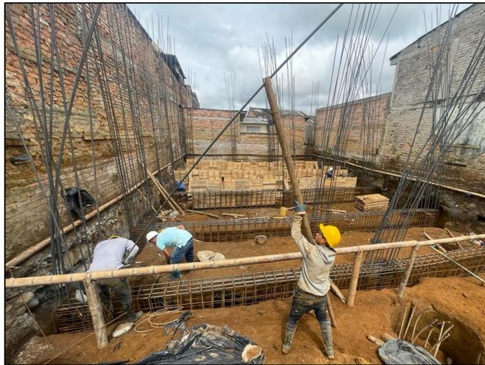
*Ilustración 25, Colocación acero de columna 9ª, encofrado ejes 14,12,11, Elaboración Ing. Héctor López*
