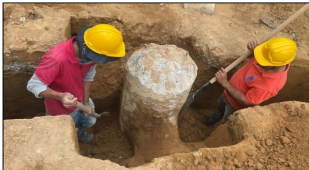
*Ilustración 13, excavación eje y cabezal de pilote 12C. Fuente: Constructora Open House.*
