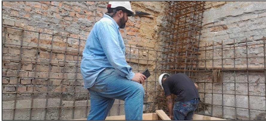
Ilustración 43, medición para volumen de concreto en campo Fuente: Elaboración propia
