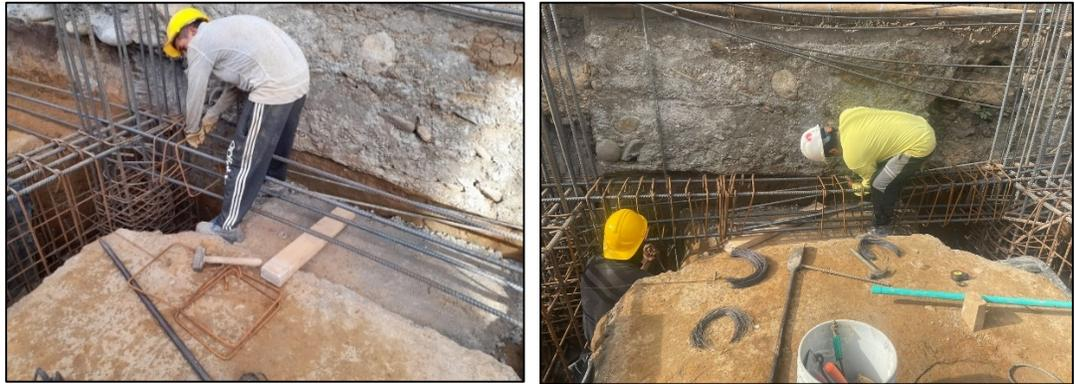
Ilustración 75, armado viga A, tramo de 7 a 8, fuente: Elaboración propia.
