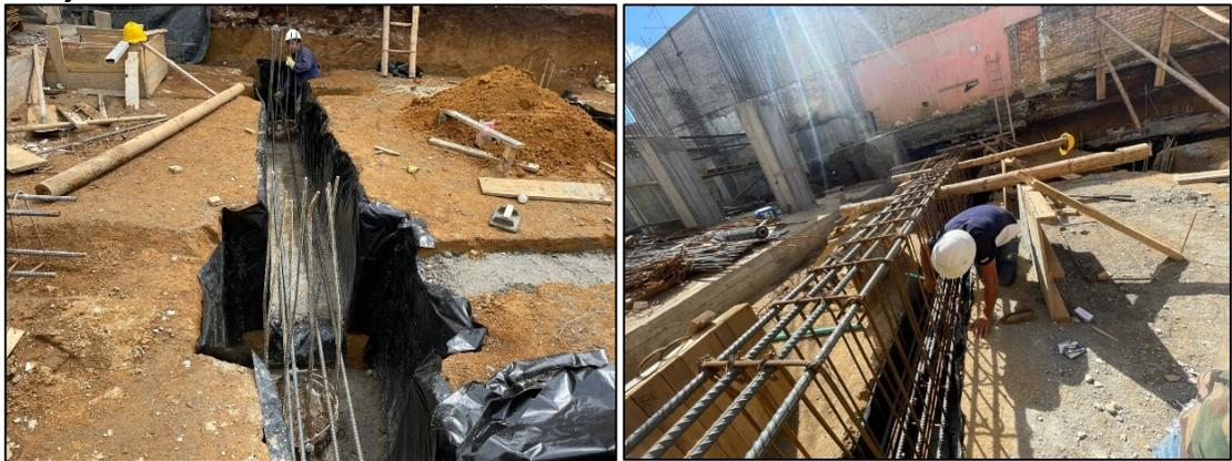
Ilustración 103, Armado de vigas eje 5 y 6, Fuente: Elaboración propia.
