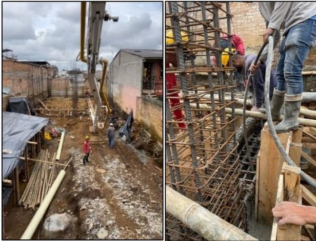
*Ilustración 25, Vaciado de concreto por medio de Autobomba, elaboración Ing. Héctor López*
