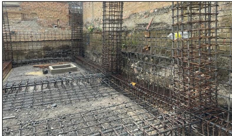
*Ilustración 40, Armado muro de contención ejes E-F, 14, Fuente: elaboración propia*
