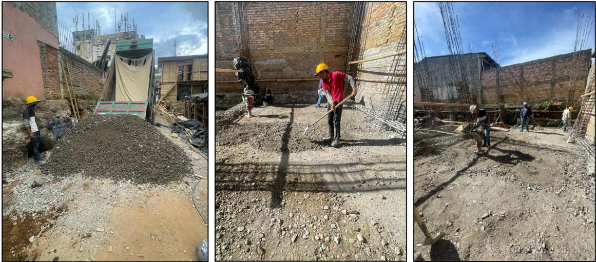
*Ilustración 28, Relleno y compactación bloque 2, Fuente: Elaboración propia.*
