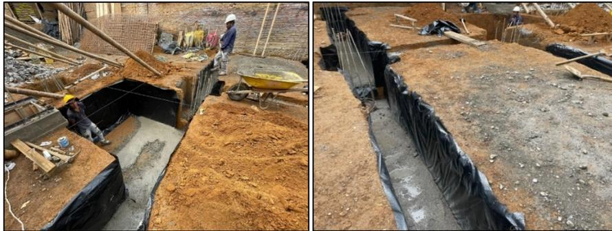
Ilustración 101, Colocación plástico y fundición de solados, Fuente: Elaboración propia.
