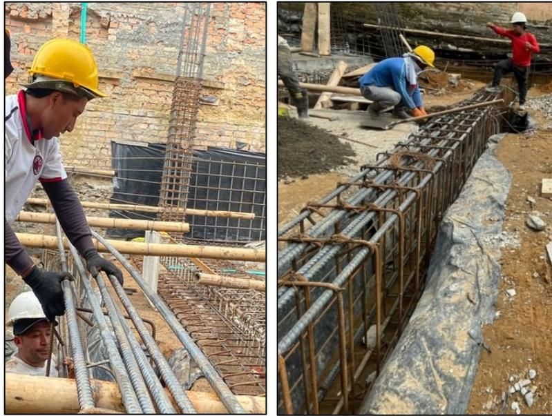
Ilustración 73 Fundición de Solado y armado de acero de viga eje 8, Fuente: Elaboración propia
