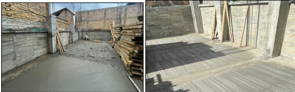
*Ilustración 95, fundición losas, fuente: Elaboración propia*
