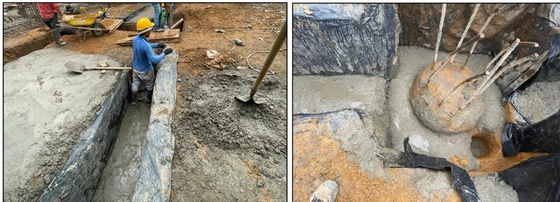
*Ilustración 71, Instalación de plásticos, y Fundición de solados de concreto de resistencia  $f'c$  17 MPa*
