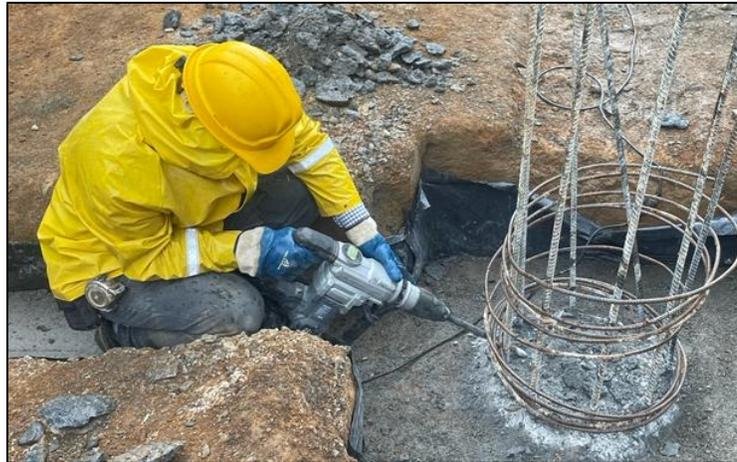
Ilustración 17, demolición de concreto superior de pilotes, elaboración Ing. Héctor López
