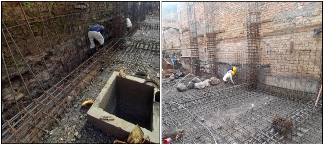
*Ilustración 37, Amarre de vigas de cimentación eje A y E-F, Elaboración propia*
