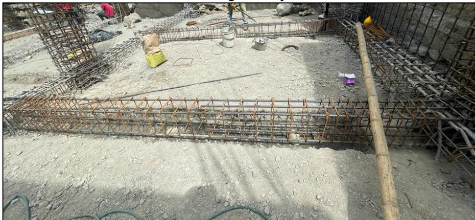
Ilustración 31, Armado viga B y D. Fuente: Elaboración propia.
