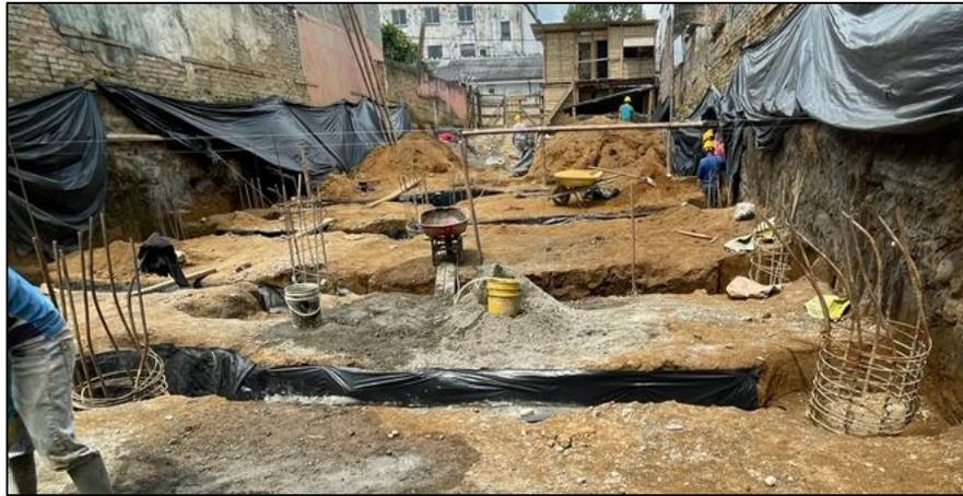
Ilustración 14, vista general excavaciones de vigas (ejes 12 – 11- 10 - 9), Fuente: Constructora Open House
