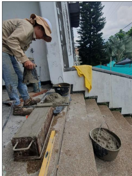
Ilustración 23. Ensayo de asentamiento y toma de muestras del concreto
