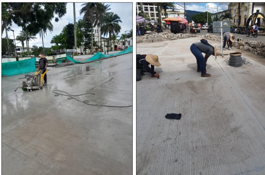
Ilustración 25. Corte y sellado de juntas
