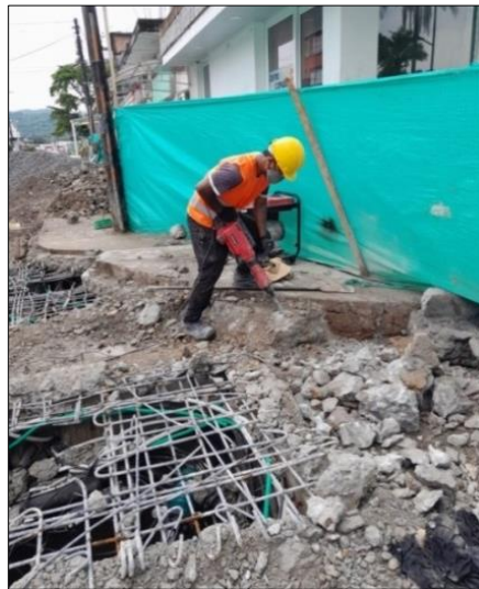
Ilustración 16. Demolición de sardineles
