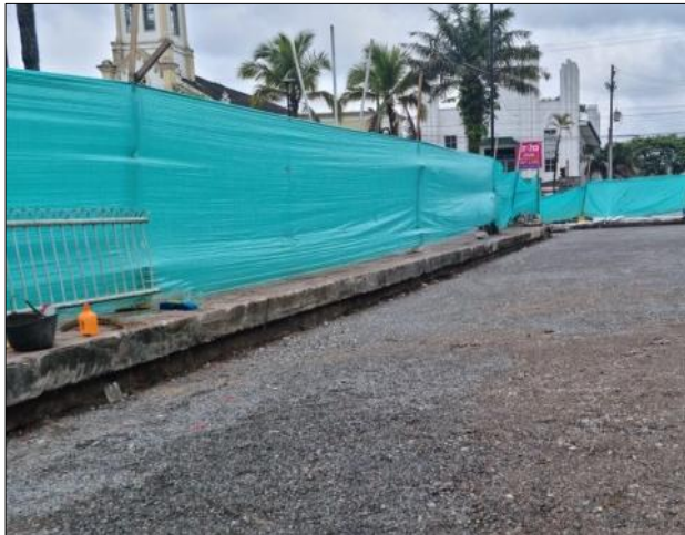
Ilustración 20. Subbase granular compactada
