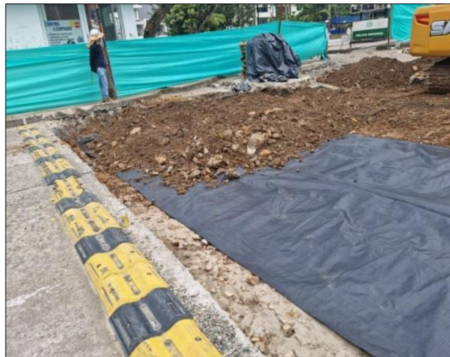
Ilustración 18. Instalación del geotextil y capa de subbase.
