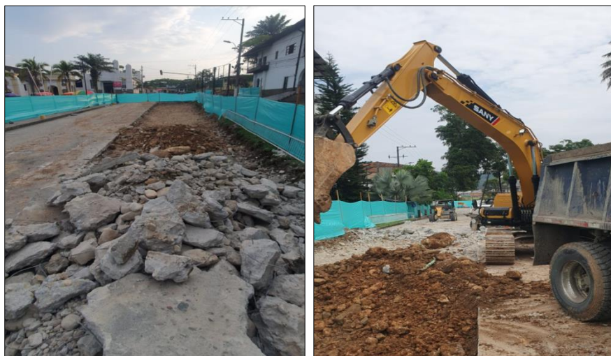
Ilustración 15. Desalojo y retiro de los escombros de demolición
