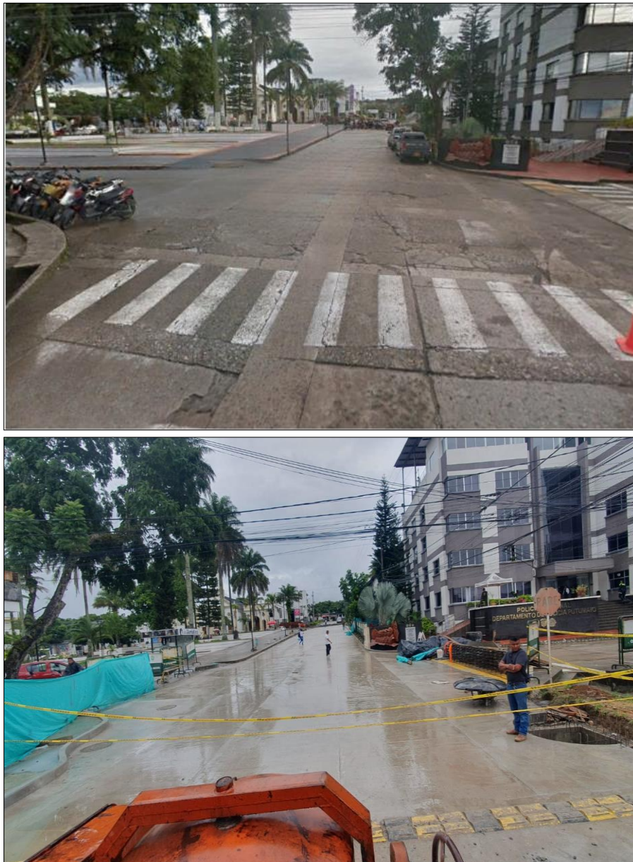
Ilustración 27. Antes y después de la reposición de la losa de concreto
