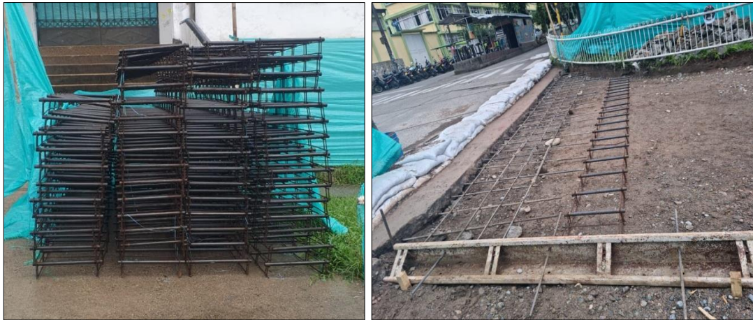
Ilustración 21. Colocación de la formaleta y acero
