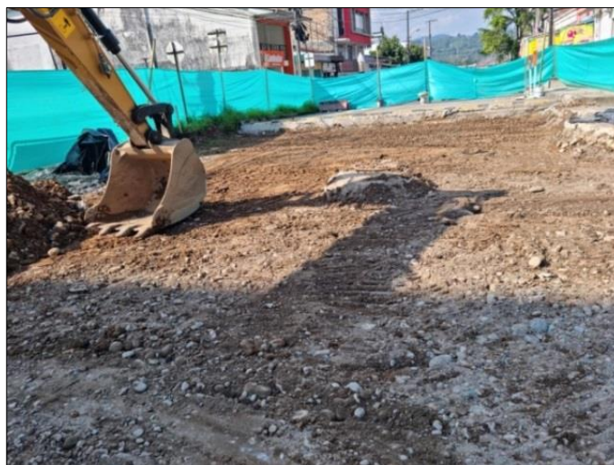
Ilustración 17. Limpieza de la subrasante
