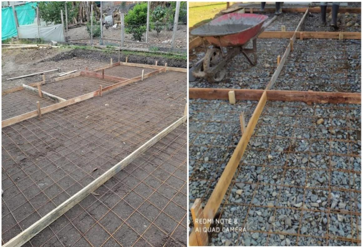
*Ilustración 38. Fundición de losas (personal con elementos de bioseguridad).*
