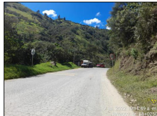
Ilustración 26. PR 10+0250, PR 20+0500 Sectores presentan fisuras, baches, desgaste del pavimento.
