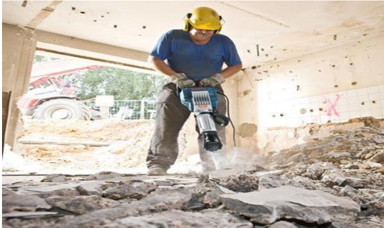
Figura 3. Proceso de demolición mecánica.
