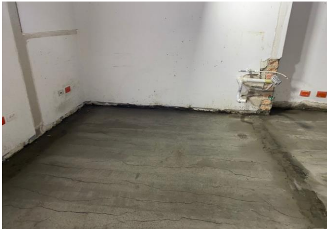
Figura 46. Afinado de piso
