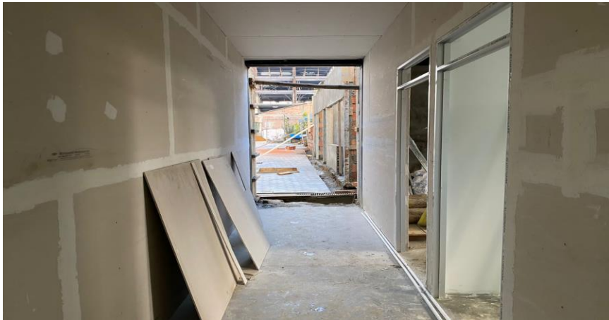
Figura 36. Muros en super board instalados.
