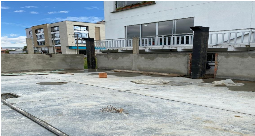
Figura 28. Columnas metálicas instaladas.
