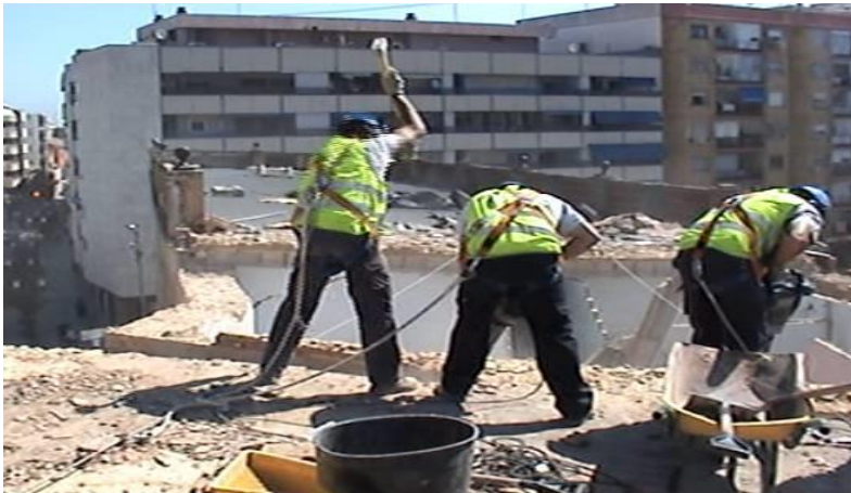
Figura 2. Proceso de demolición mecánica.
