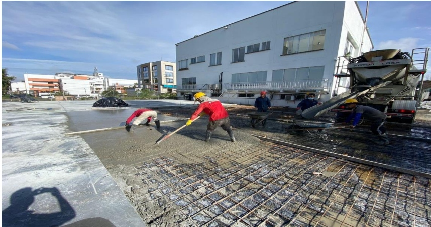
Figura 24. Proceso constructivo de losa de entpiso.
