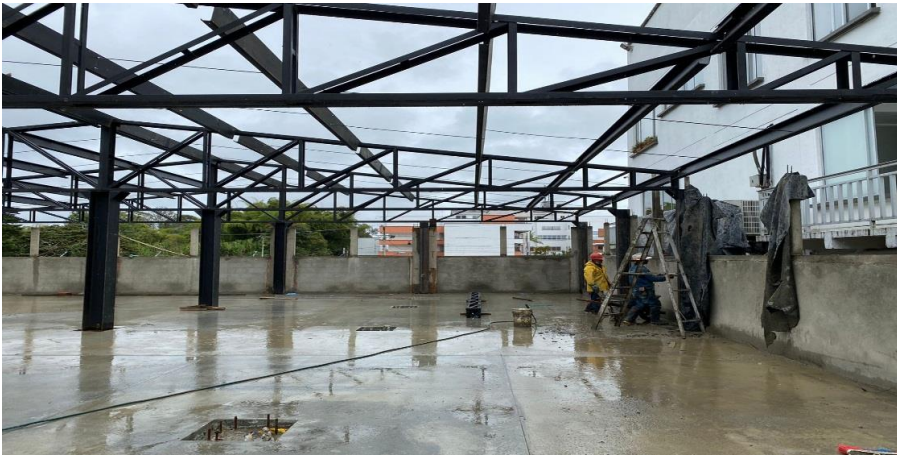
Figura 31. Instalación de cerchas
