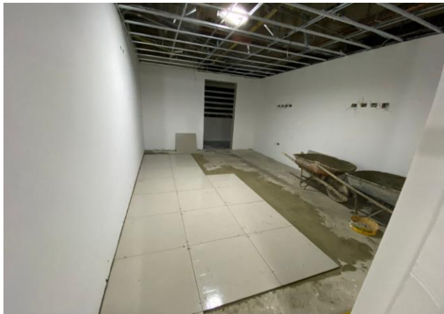
Figura 62. Proceso de instalación de porcelanato
