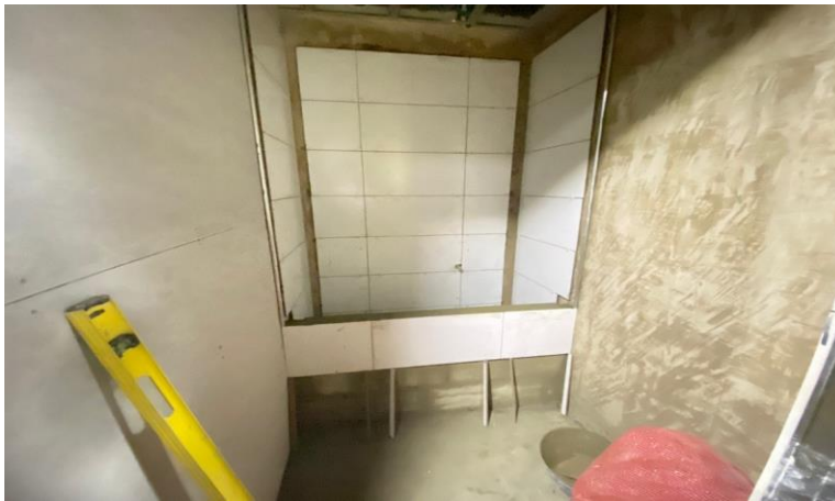
Figura 61. Proceso de enchapado en muro de baño
