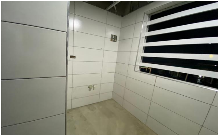
Figura 60. Cerámica en muros de baño
