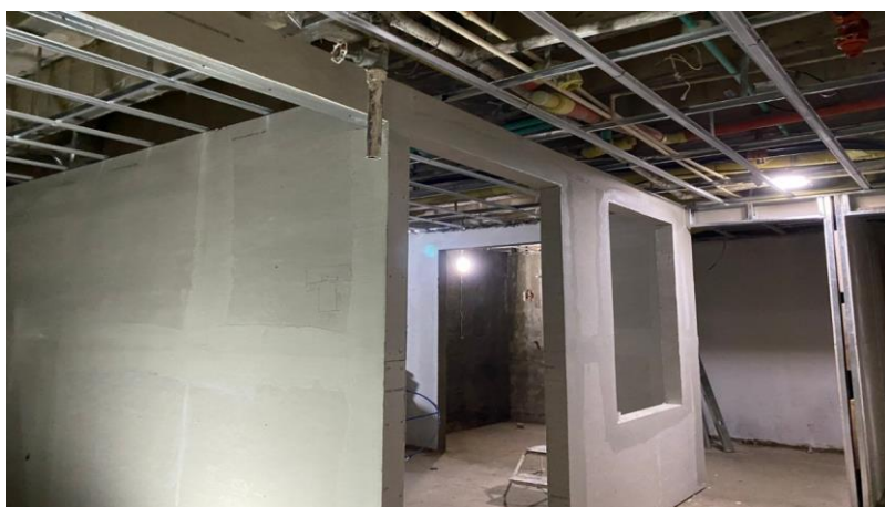
Figura 52. Red contra incendio
