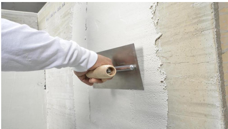
Figura 10. Proceso de estucado
