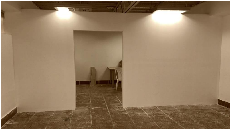
Figura 9. Muros en Super Board
