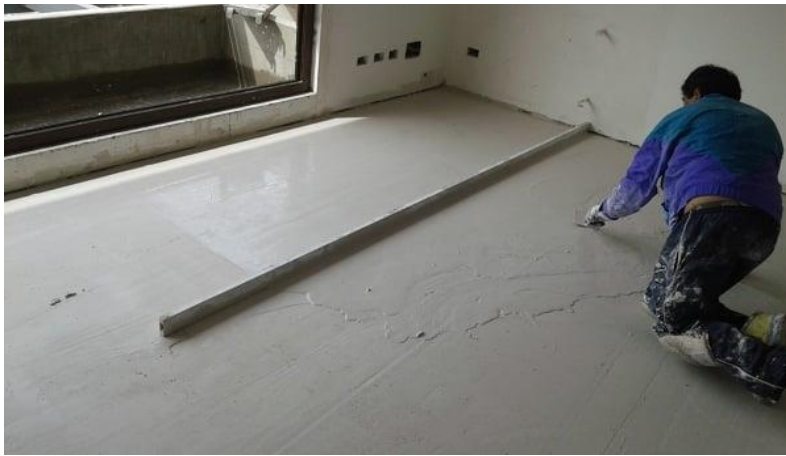
Figura 7. Proceso de afinado de piso.
