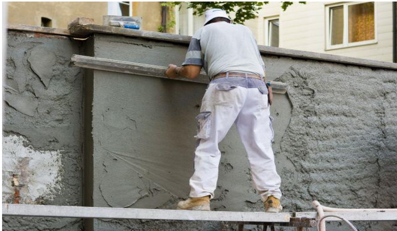
Figura 6. Proceso de repellado em muros de bloque.
