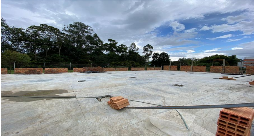
Figura 25. Muros perimetrales en bloque.
