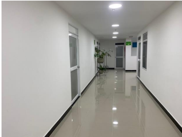
Figura 63. Porcelanato instalado e instalación de puertas y ventanas
