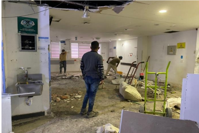
Figura 44. Proceso de demolición mecánica.
