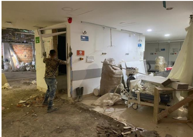
Figura 45. Proceso de demolición manual.
