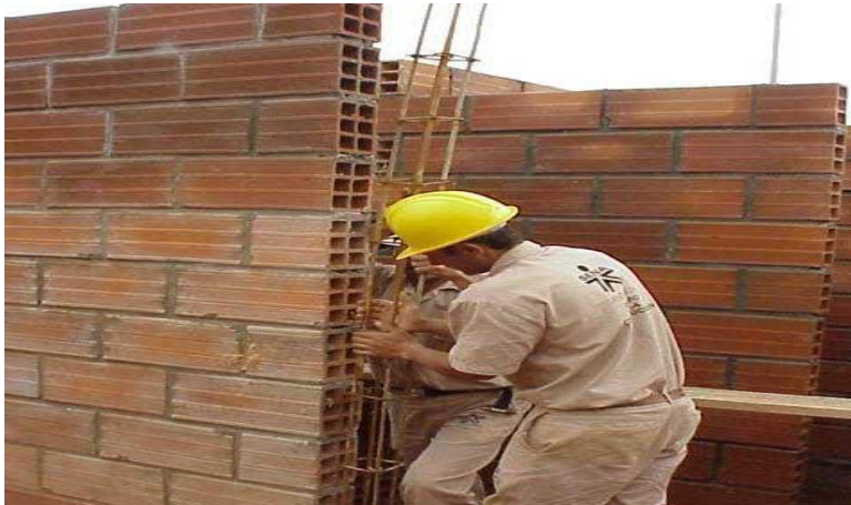
Figura 4. Instalación de muros en bloque.
