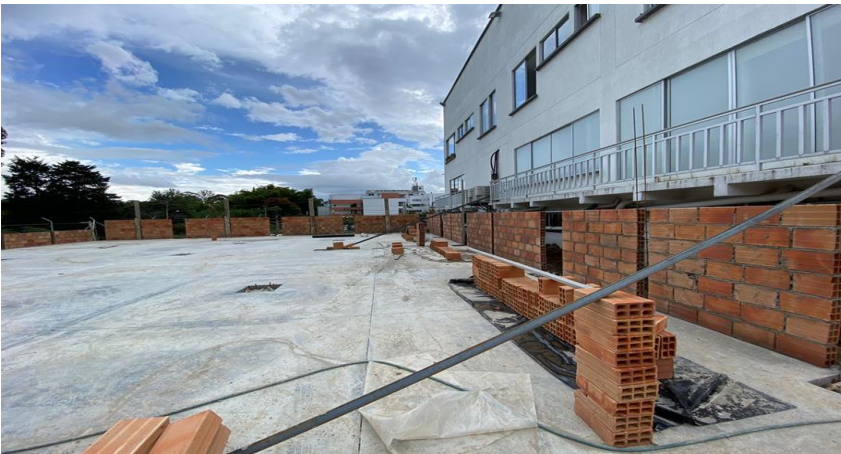
Figura 26. Muros perimetrales en bloque.
