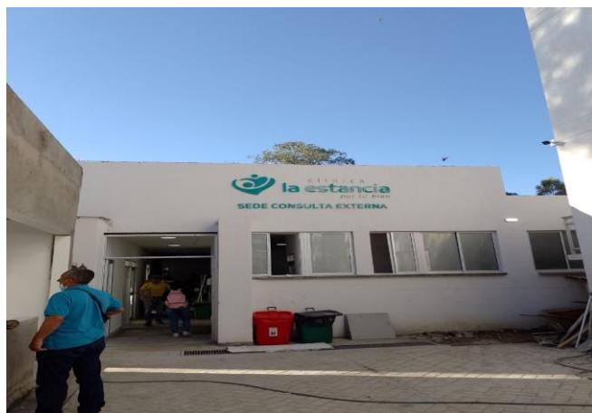
Figura 41. Puertas y ventanas instaladas
