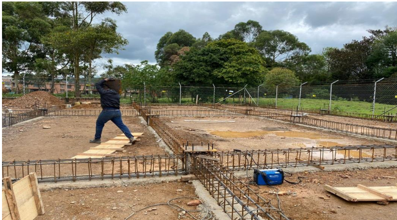
Figura 21. Proceso de armado de viga de cimentación.
