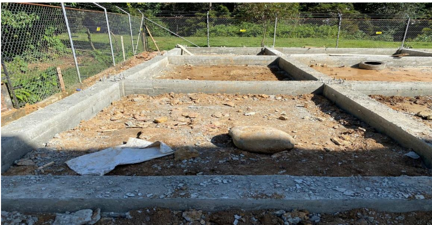
Figura 22. Proceso constructivo de viga de cimentación.
