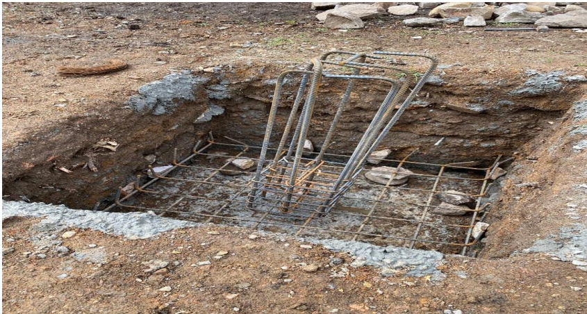
Figura 19. Proceso de armado y construcción de zapata y pedestal.
