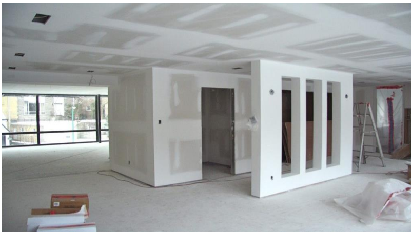
Figura 8. Muros en Drywall.
