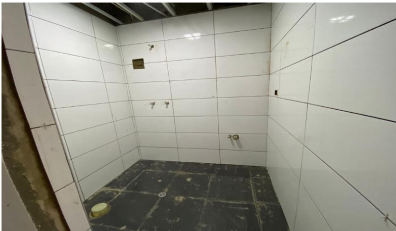
Figura 59. Enchapado en muros de baño
