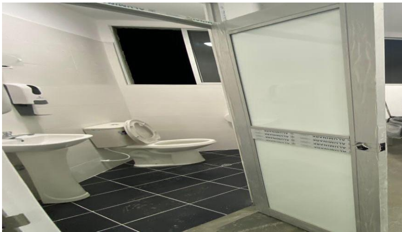
Figura 37. Baño y lavamanos instalado
