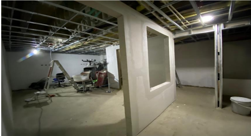
Figura 50. Muro en súper board instalado.
