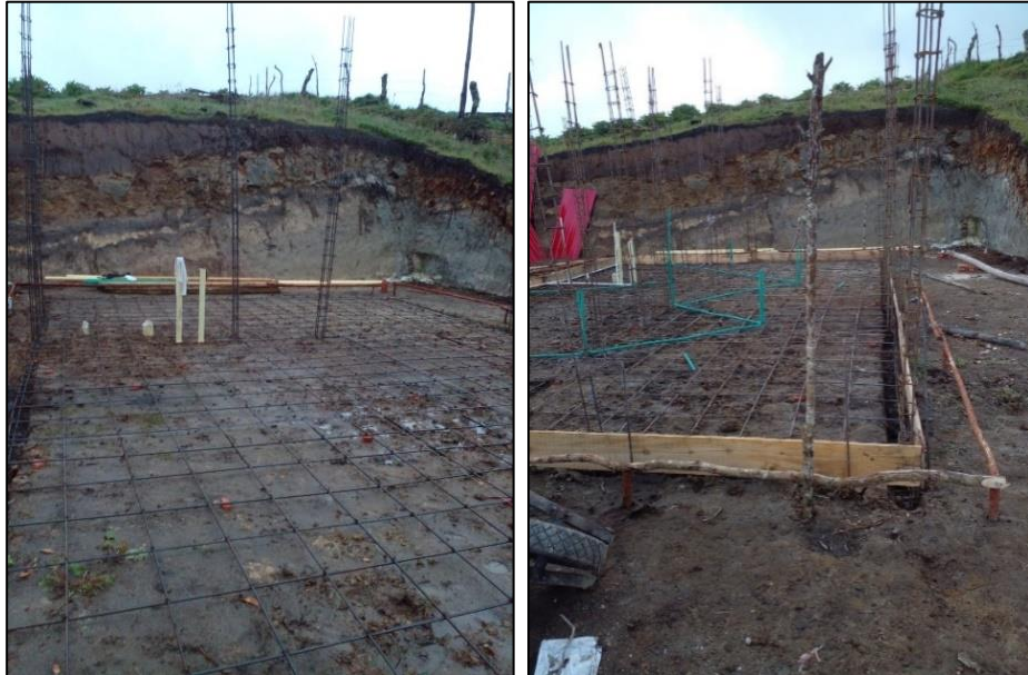
Figura 30. Refuerzo de losa de cimentación
