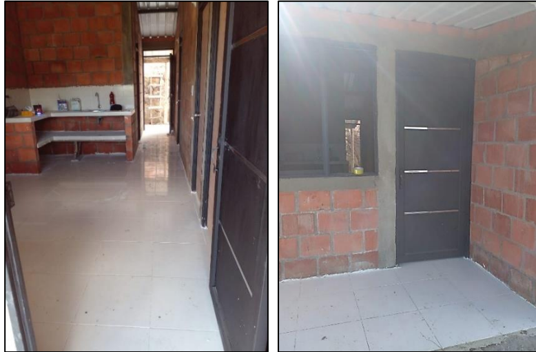
Figura 39. Instalación de puertas y ventanas
