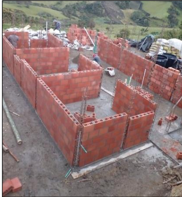
Figura 35. Formaleta y fundición de columnas
