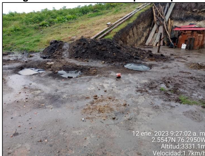
Figura 40. Instalación de pozo séptico
