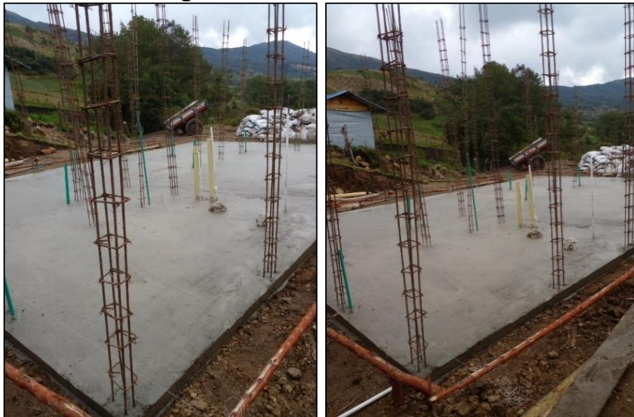
Figura 32. Fundición de la losa
