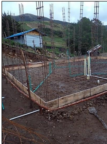
Figura 31. Instalación de tubería hidrosanitaria y eléctrica
