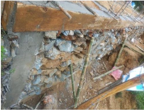
Imagen 12. Construcción del muro de contención en la vía de la Vereda Sauce alto
