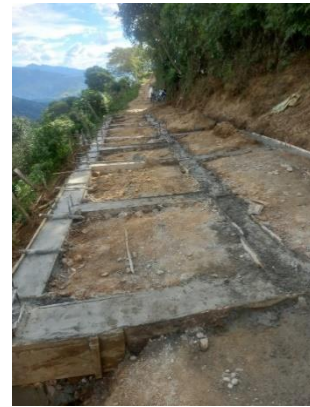
Imagen 13. Cimentación de muro de contención
