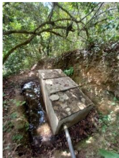
Imagen 26. Tapa en mal estado del desarenador
