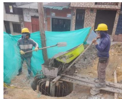
Imagen 11. Visita al terreno de construcción de la plaza de mercado
