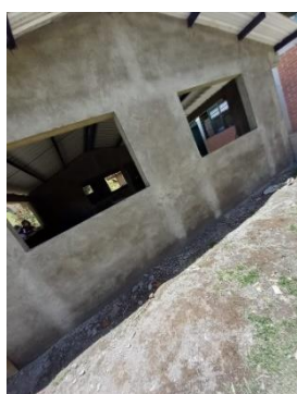
Imagen 16. Construcción de restaurante escolar
