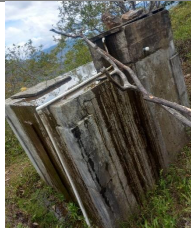
Tanque de almacenamiento en mal estado
