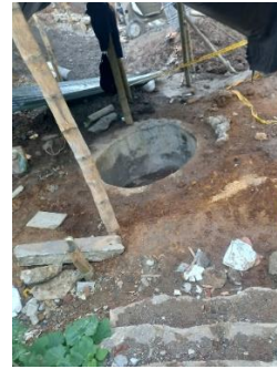
Imagen 7. Construcción de caissons de cimentación
