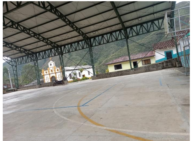
Imagen 33. Vista de todo el polideportivo sin enmallado
