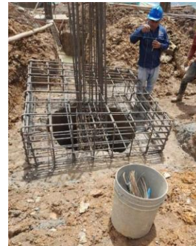
Imagen 9. Construcción del sistema de cimentación
