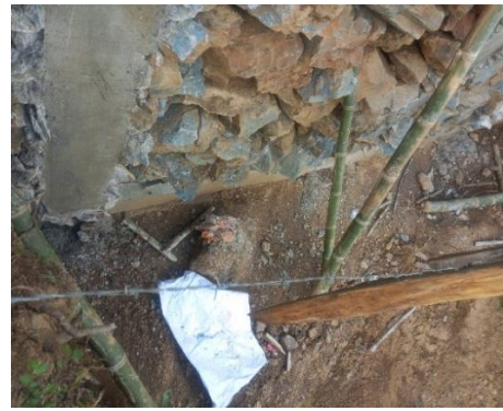
Imagen 15. Muro de contención
