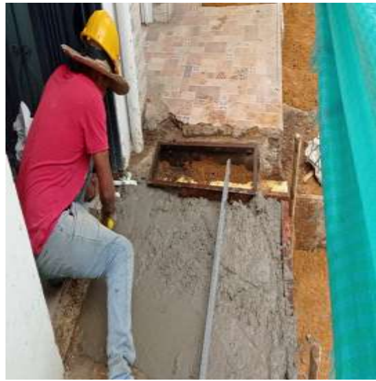
Ilustración 47. Fundición andenes.
