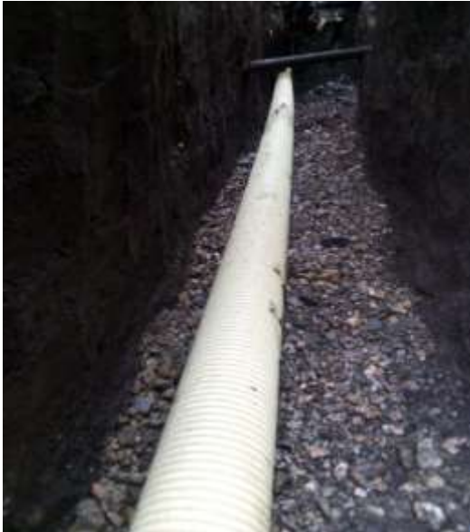
Ilustración 20. Encamado material granular e instalación tubería red principal.
