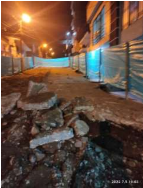
Ilustración 7. Demolición pavimento rígido.
