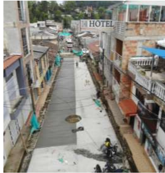
Ilustración 45. Estado final, vía pavimentada.
