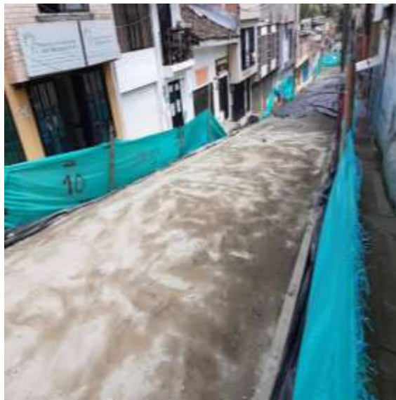
Ilustración 39. Subbase mejorada.
