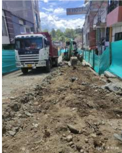
Ilustración 6. Continuación demolición pavimento rígido.
