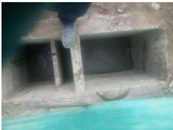
Ilustración 27. Construcción de sumidero.
