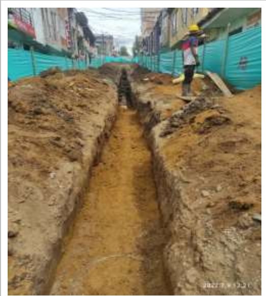
Ilustración 30. Material de relleno compactado.
