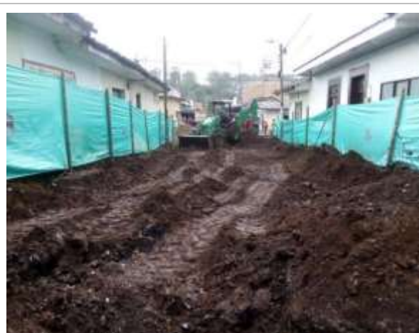
Ilustración 14. Continuación excavación a máquina.
