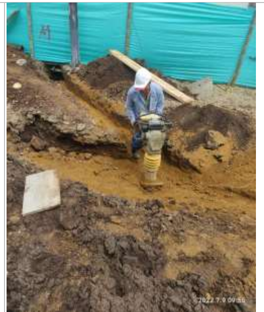
Ilustración 29. Compactación de material de relleno haciendo uso de saltarín.
