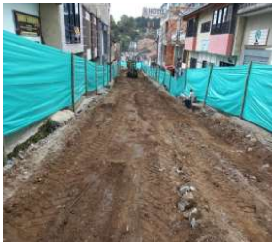
Ilustración 31. Adecuación de la rasante
