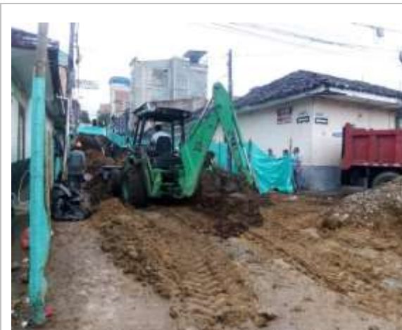
Ilustración 13. Excavación con retroexcavadora.
