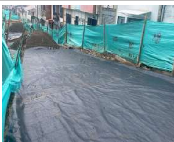
Ilustración 35. Extensión de geotextil.
