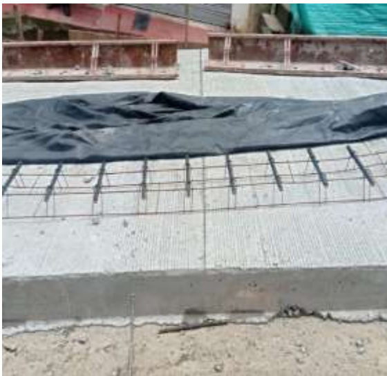
Ilustración 42. Dovelas para juntas transversales.
