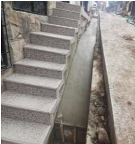
Ilustración 48. Elaboración de cunetas.
