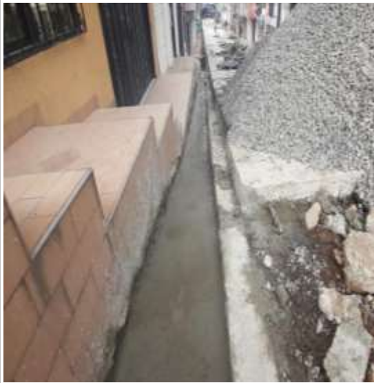
Ilustración 49. Elaboración de cunetas.
