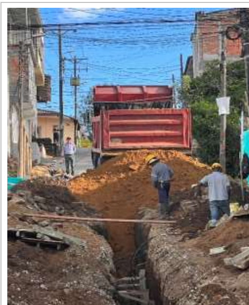
Ilustración 28. Vaciado de material de relleno.
