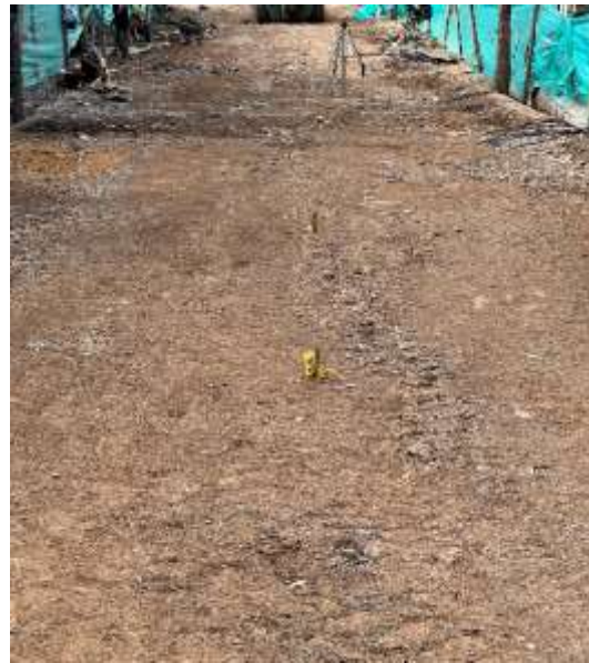
Ilustración 34. Colocación de niveles por parte de la comisión topográfica.
