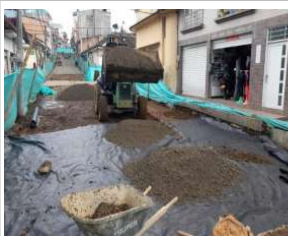
Ilustración 36. Riego de material de subbase.
