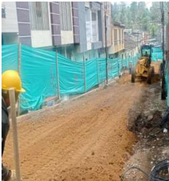
Ilustración 33. Compactación de la rasante.
