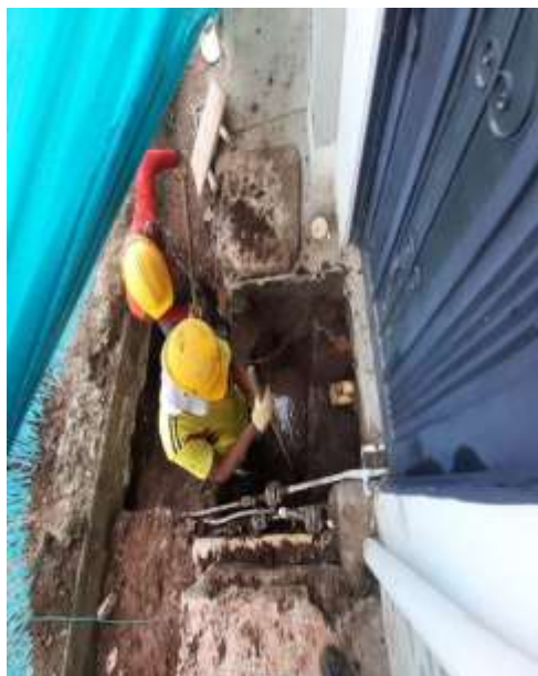
Ilustración 11. Demolición andenes y cámaras de inspección.
