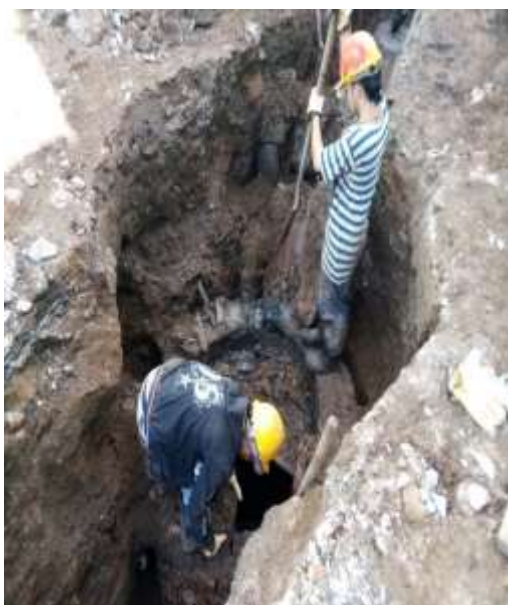
Ilustración 9. Demolición recamaras existentes.
