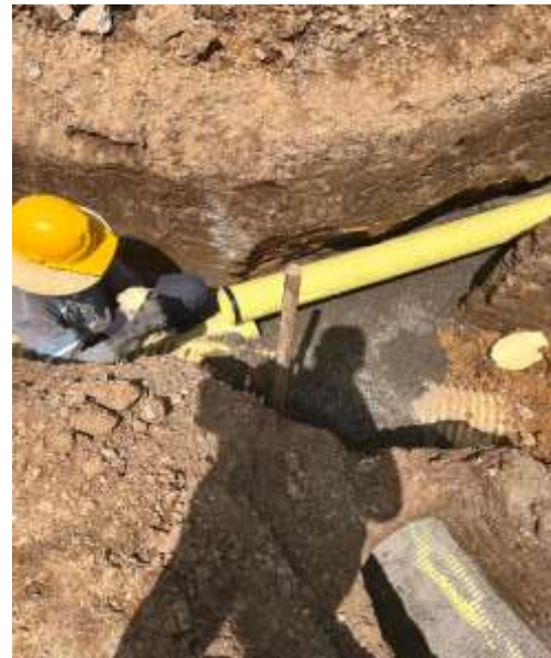
Ilustración 22. Instalación tubería para acometidas domiciliarias.
