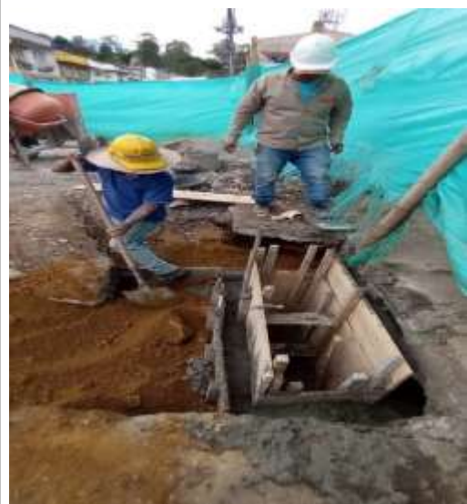
Ilustración 26. Instalación de formaletas para construcción de sumidero.
