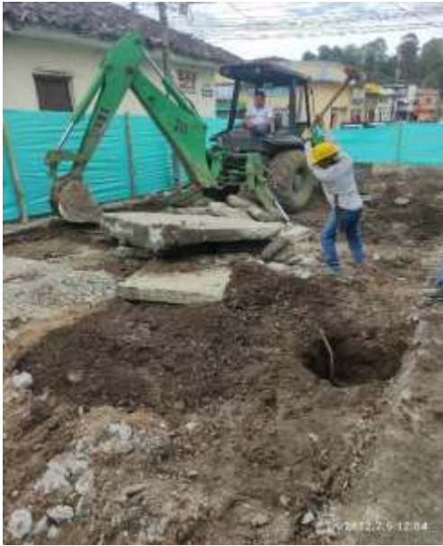
Ilustración 5. Demolición pavimento existente.
