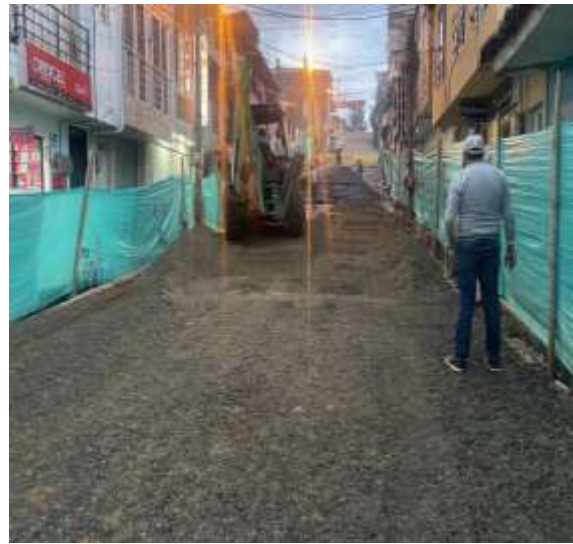
Ilustración 38. Conformación de la subbase.
