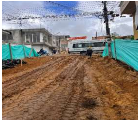
Ilustración 32. Perfilación de la vía.
