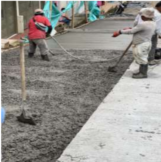
Ilustración 44. Vibrado del concreto hidráulico.
