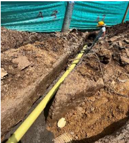
Ilustración 21. Instalación tubería para acometidas domiciliarias.
