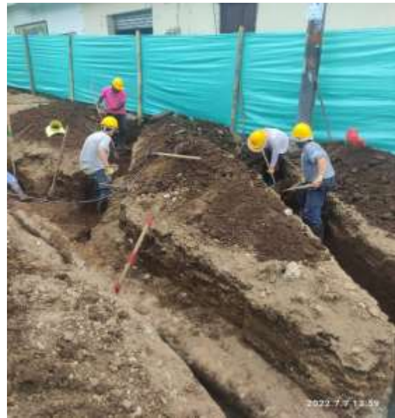
Ilustración 16. Excavación manual.
