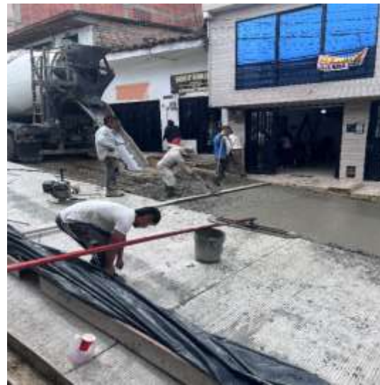
Ilustración 43. Vaciado de concreto hidráulico.
