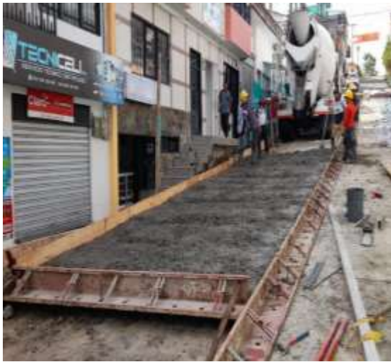
Ilustración 41. Instalación de formaletas y vaciado de concreto.
