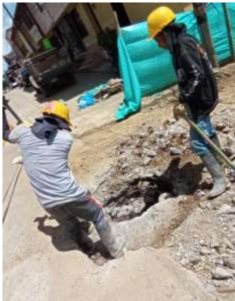
Ilustración 10. Continuación demolición recamaras.
