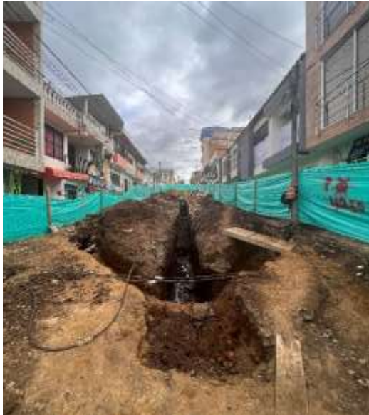
Ilustración 17. Zanjas para instalación de tubería.
