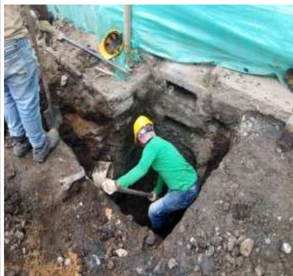
Ilustración 25. Excavación para construcción de sumidero.
