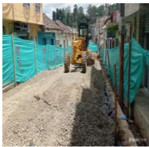
Ilustración 37. Conformación de la subbase utilizando motoniveladora.
