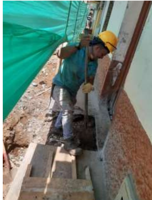
Ilustración 8. Demolición cajas de inspección.
