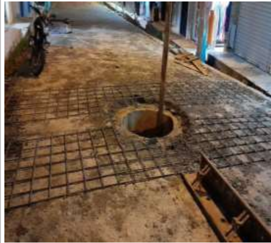
Ilustración 40. Armado de parrillas de acero de refuerzo alrededor de las recamaras.
