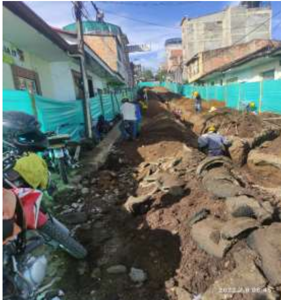
Ilustración 15. Excavación manual y retiro de tubería existente.
