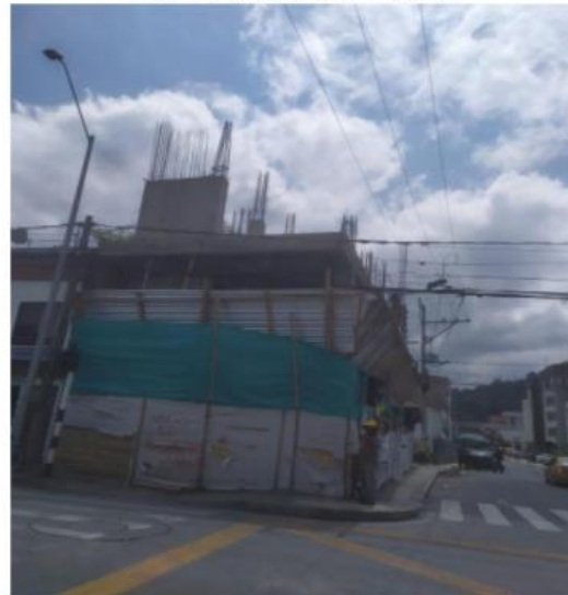
FOTO 6 Obra vista sobre Cra 6.
