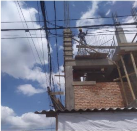
FOTO 3 Detalle de líneas eléctricas
