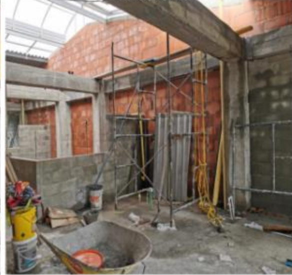
FOTO 6 Estado actual piso 4.
