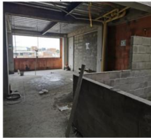
FOTO 4 Detalle de mampostería estructural y muros en bloque de concreto.
