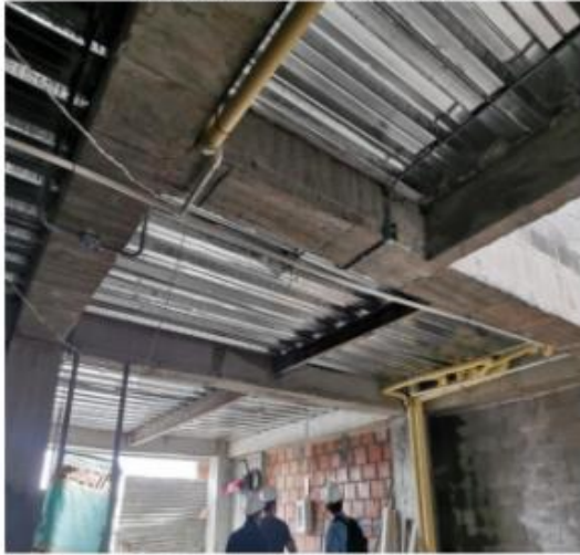
FOTO 3 Detalle de losa en Steel deck.
