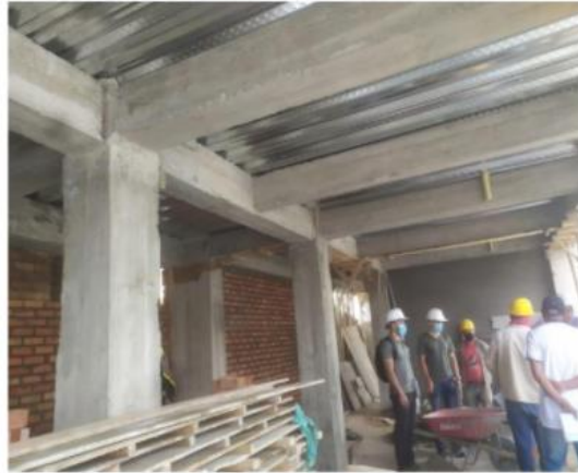
FOTO 4 Detalle de sistema de losa Steel Deck
