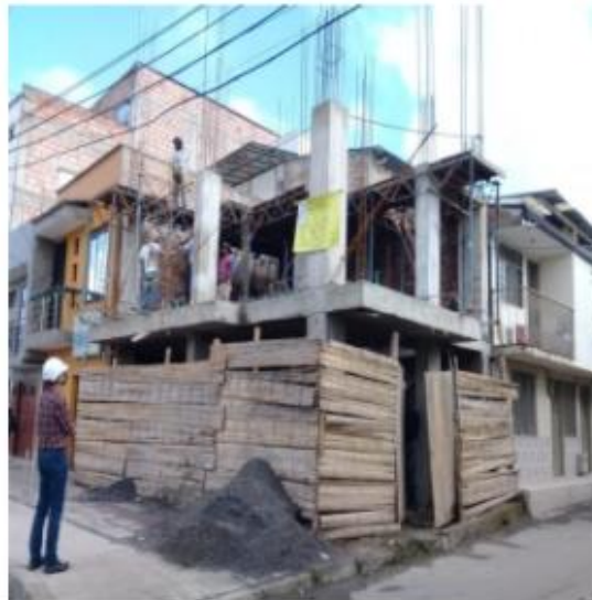
FOTO 6 Estado actual obra, fachadas frontal y lateral.
