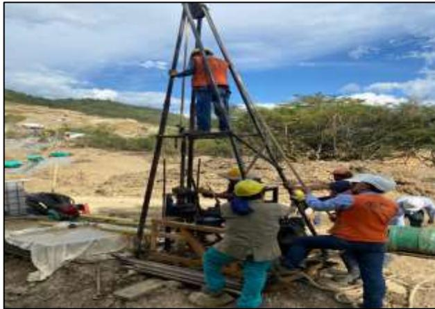
**Foto 50** Perforación por rotación
