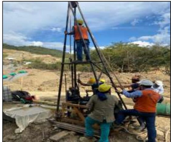
**Foto 71** Procedimiento perforación por rotación
