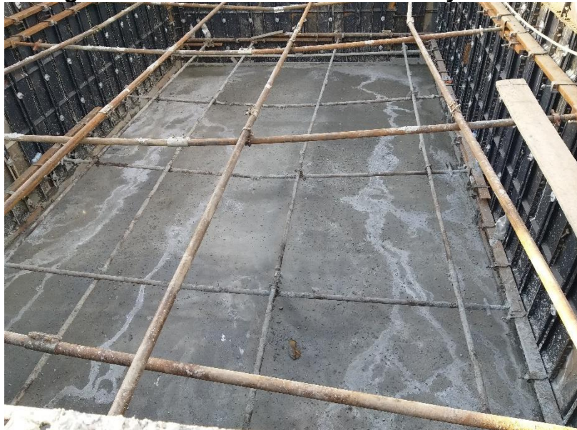
Figura 43 Losa Inferior con Acabado y Antisol
