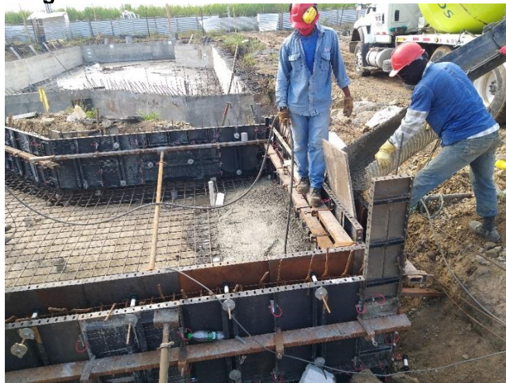
Figura 99 Inicio del Vaciado Piscina de Niños
