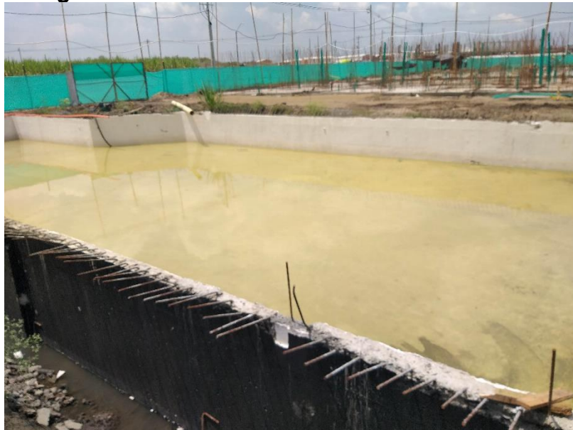
Figura 107 Prueba Hidrostática Piscina Adultos
