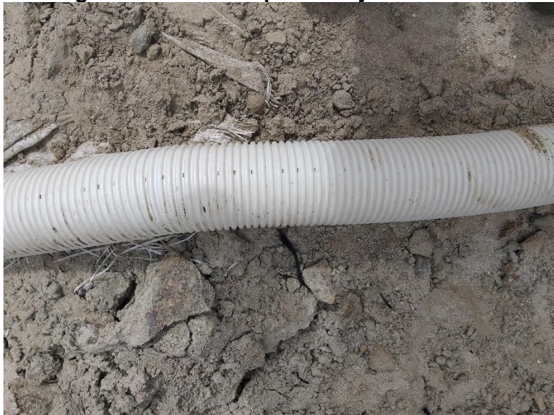
Figura 52 Tubería Tipo Drenaje 4" Instalada
