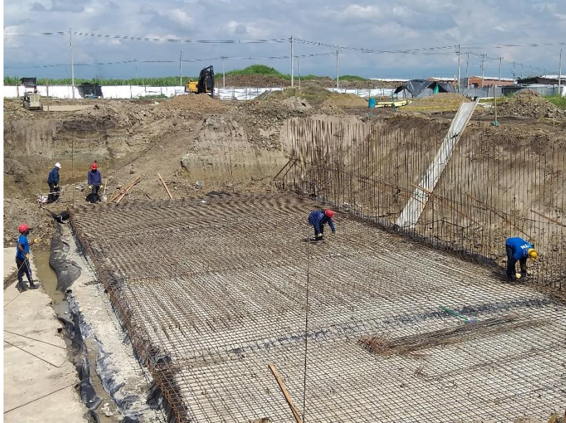
Figura 24 Armado de Acero Vertical de Muros y Segunda Parrilla
