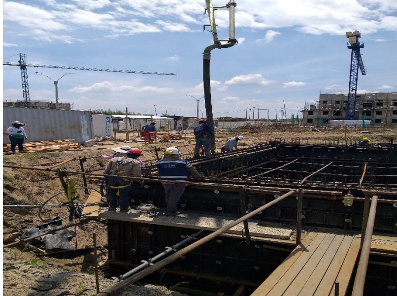
Figura 42 Vaciado del Concreto Sobre Muros
