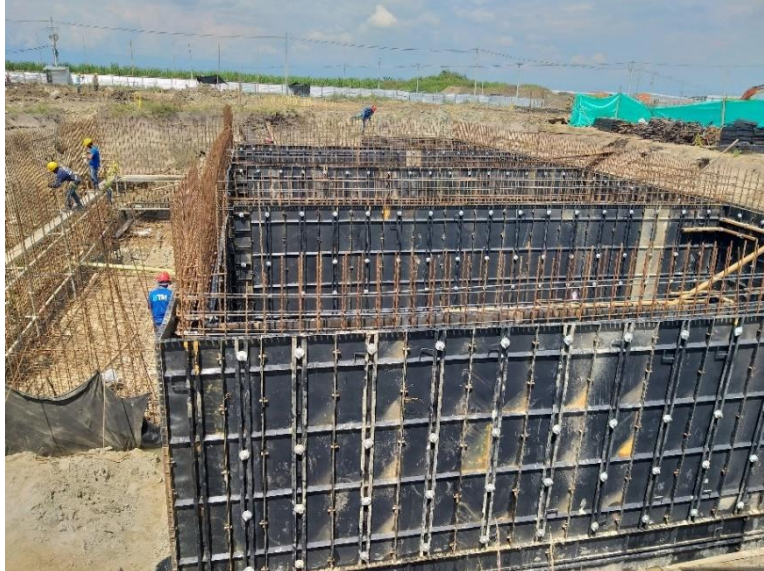
Figura 35 Instalación de Formaleta Sobre Tanque
