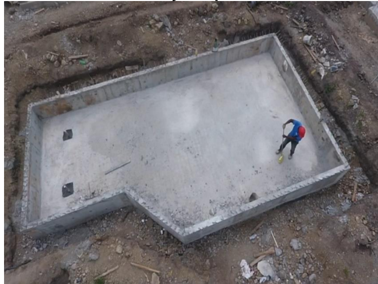
Figura 102 Desencofrado y Limpieza de Piscina de Niños
