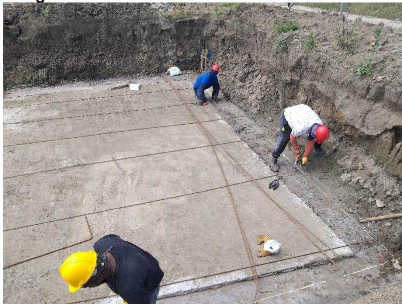
Figura 81 Planteo Inicial de Acero Parilla Inferior
