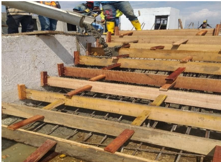
Figura 104 Encofrado en Madera de Escalones e Inicio de Vaciado
