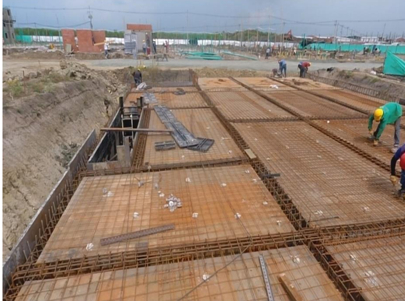
Figura 59 Armado de Vigas y Malla Electrosoldada
