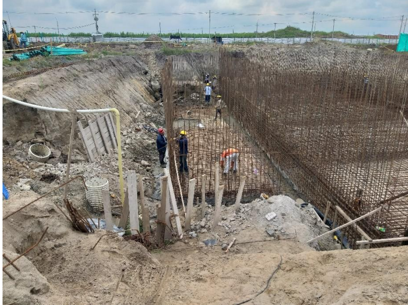
Figura 30 Instalación Acero Vertical Muros Cuarto de
