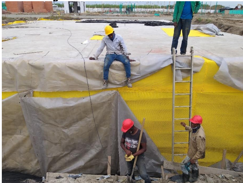
Figura 56 Instalación de Alveodren
