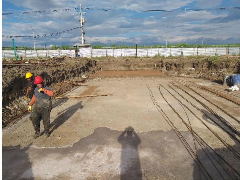
Figura 82 Avance Parilla Inferior
