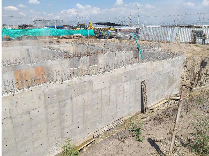
Figura 48 Retiro Total de Formaleta
