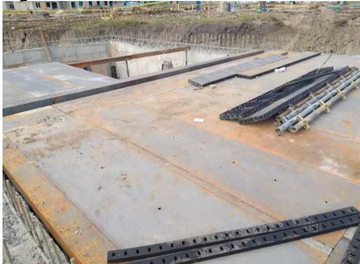
Figura 58 Instalación de Formaleta Sobre Losa
