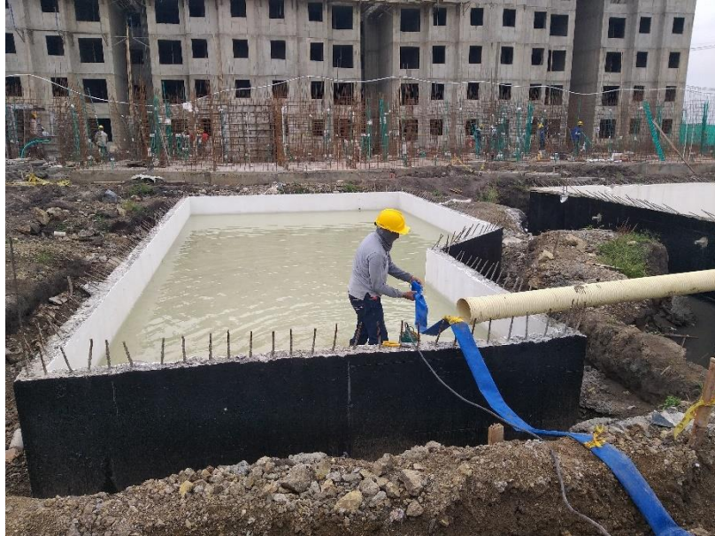
Figura 108 Prueba Hidrostática Piscina Niños
