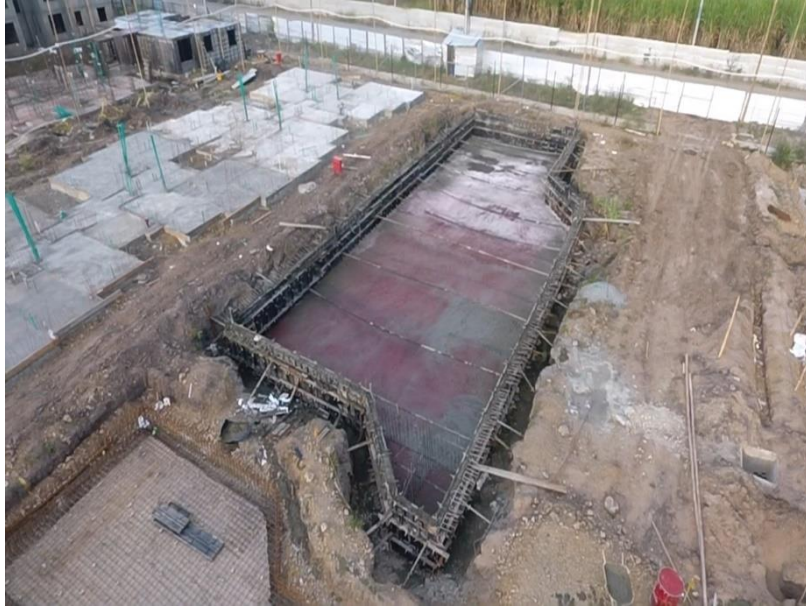
Figura 94 Llenado de Muros y Finalización de Fundición
