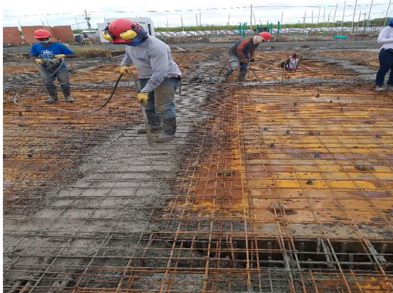
Figura 61 Inicio del Vaciado sobre las Vigas internas
