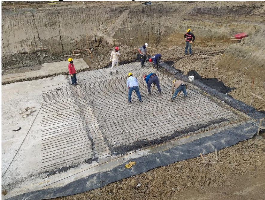
Figura 21 Planteo y Armado de Acero
