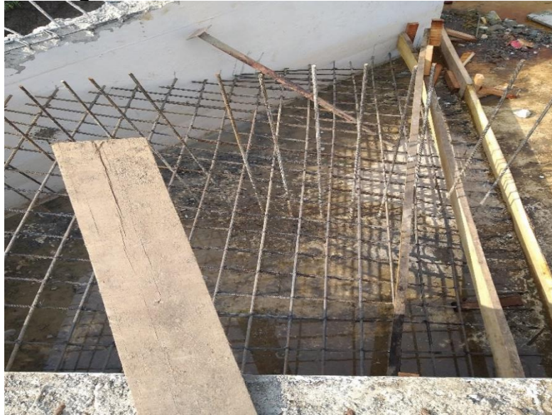
Figura 103 Armado de Acero de Refuerzo
