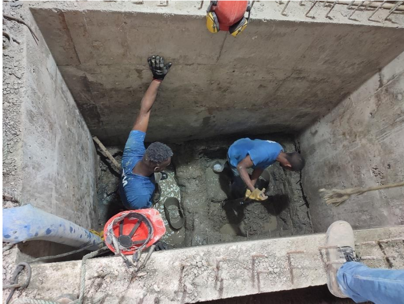
Figura 75 Excavación e Hinca Manual Interna del Pozo
