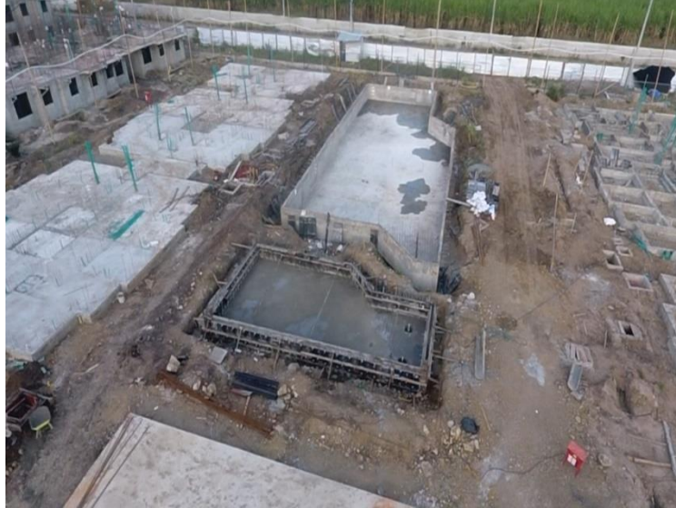
Figura 98 Encofrado Entregado y Aprobado Piscina Niños
