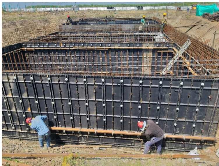
Figura 36 Instalación de Alineadores
