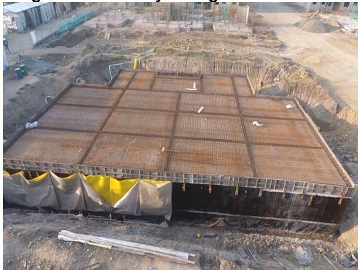
Figura 60 Armado y Entrega del Acero de la Losa
