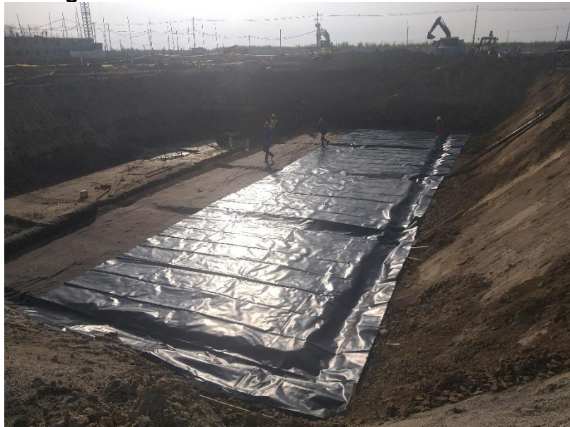
Figura 17 Instalación de Geomembrana HDPE
