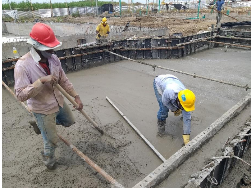
Figura 100 Acabado sobre losa Inferior y Llenado Sobre Muros
