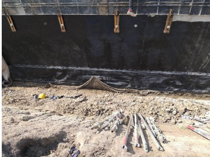
Figura 53 Aplicación de Igol Denso Plus
