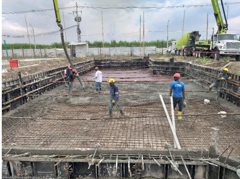
Figura 92 Avance General de la Fundición
