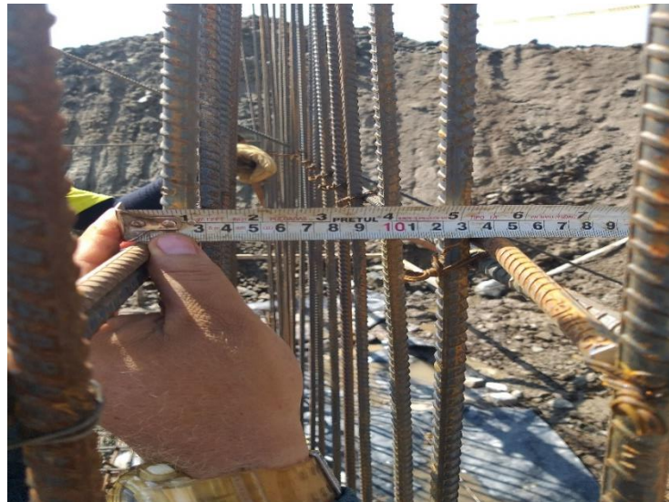
Figura 28 Separación de Aceros Verticales
