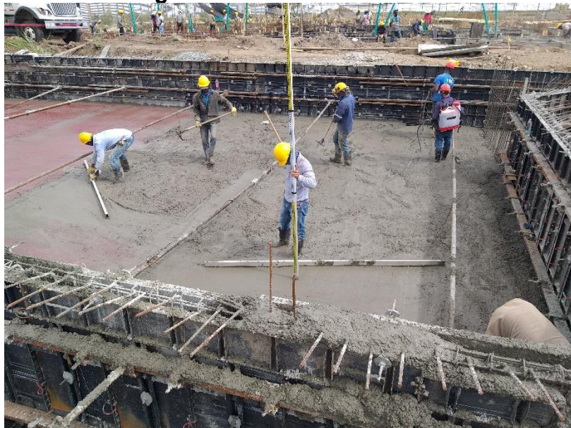
Figura 93 Llenado Final Losa
