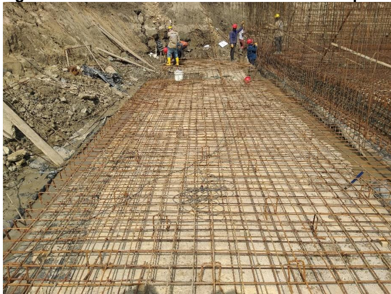
Figura 29 Instalación Acero Losa Cuarto de Maquinas
