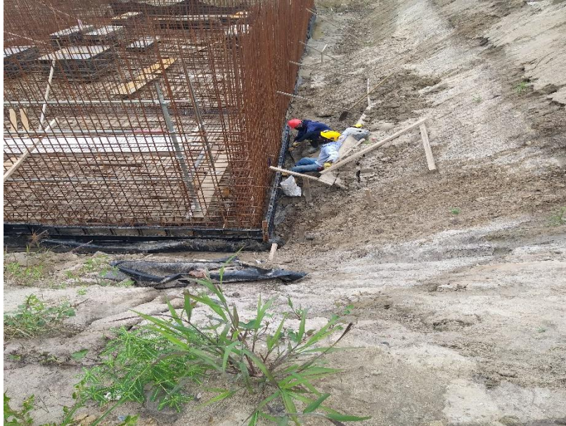
Figura 33 Inicio de instalación Formaleta
