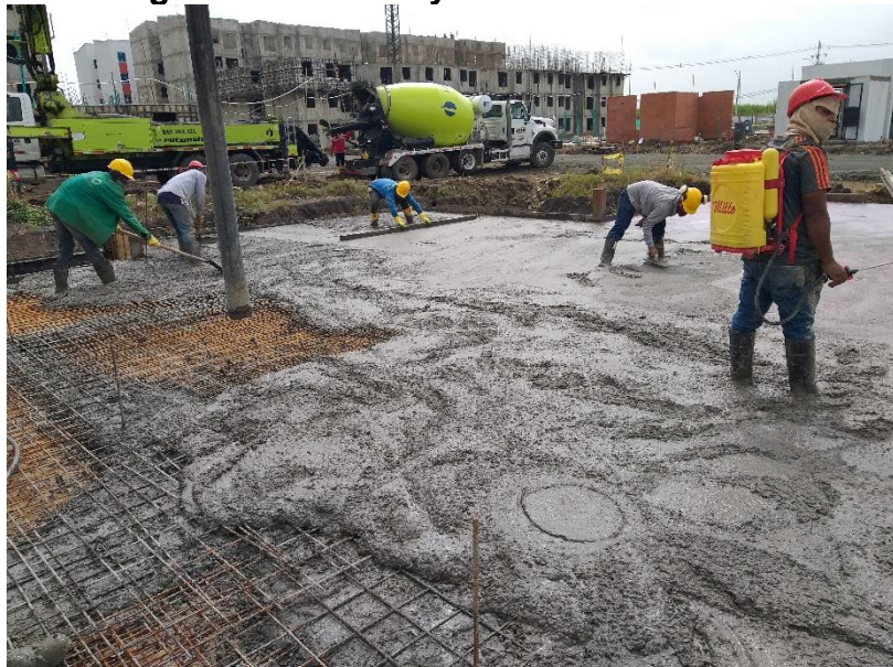
Figura 63 Vaciado y Acabado de la Losa
