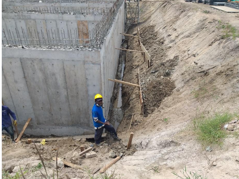
Figura 49 Excavación de Zanja Perimetral
