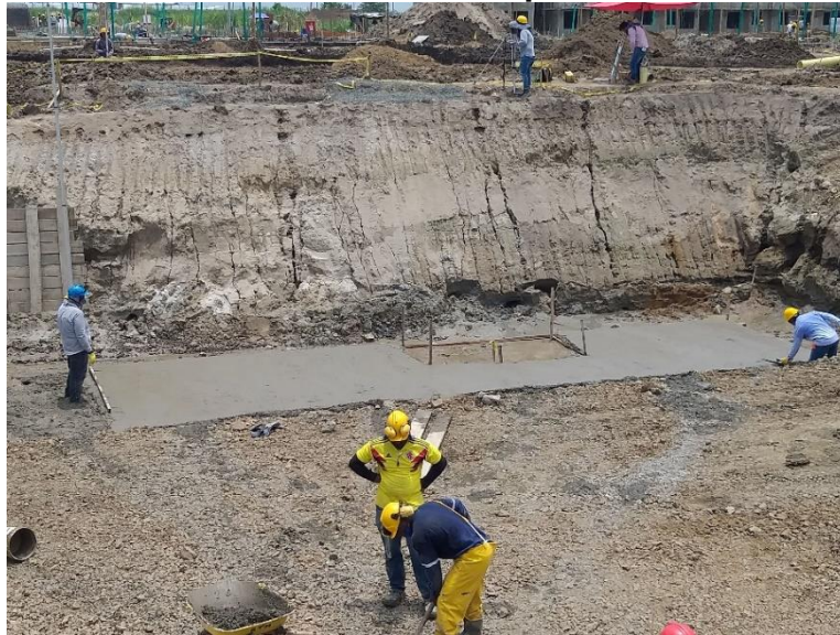
Figura 15 Instalación Solado de Limpieza Cuarto de Bombas
