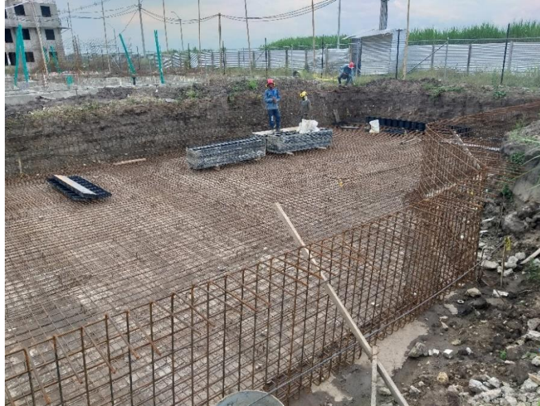
Figura 85 Finalización del Acero e Inicio del encofrado
