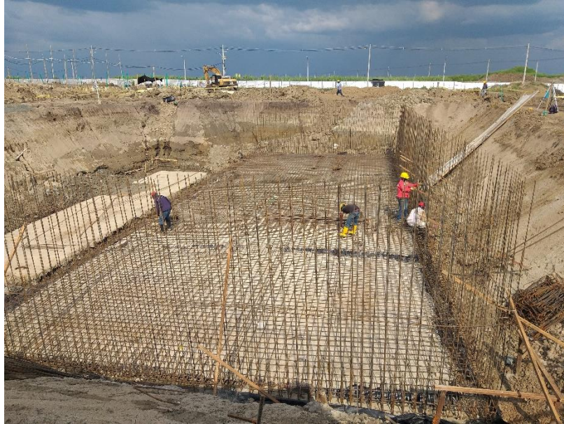
Figura 26 Instalación Acero Vertical Muros Tanque
