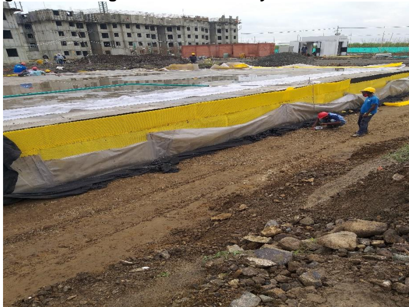
Figura 66 Entrega Filtro Perimetral y Relleno Sobre Muro
