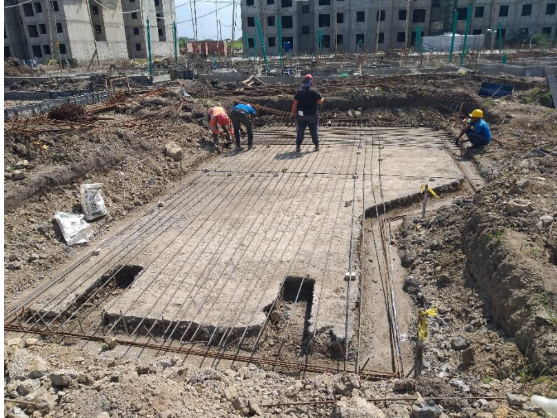
Figura 87 Armado de Acero Piscina Niños
