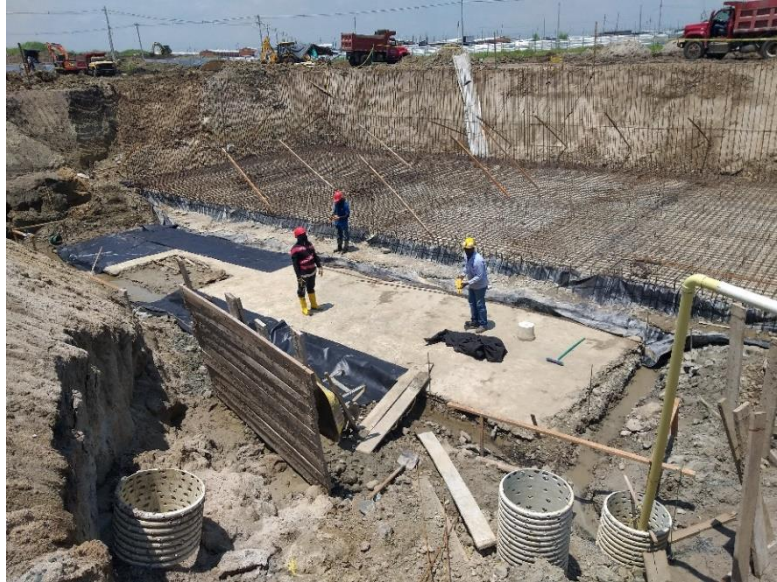
Figura 27 Amarre de Acero Vertical Muros
