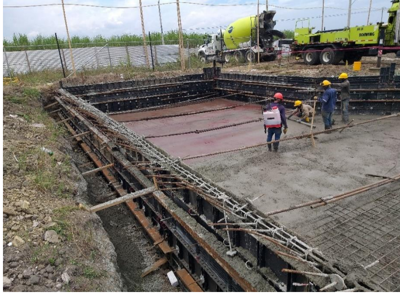
Figura 91 Vaciado sobre Losa + Acabado
