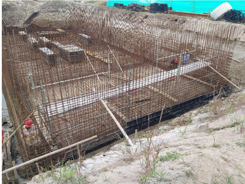
Figura 32 Finalización del Armado de Acero
