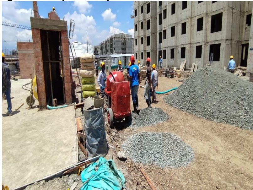
Figura 76 Preparación y Fundición de Concreto Tremie
