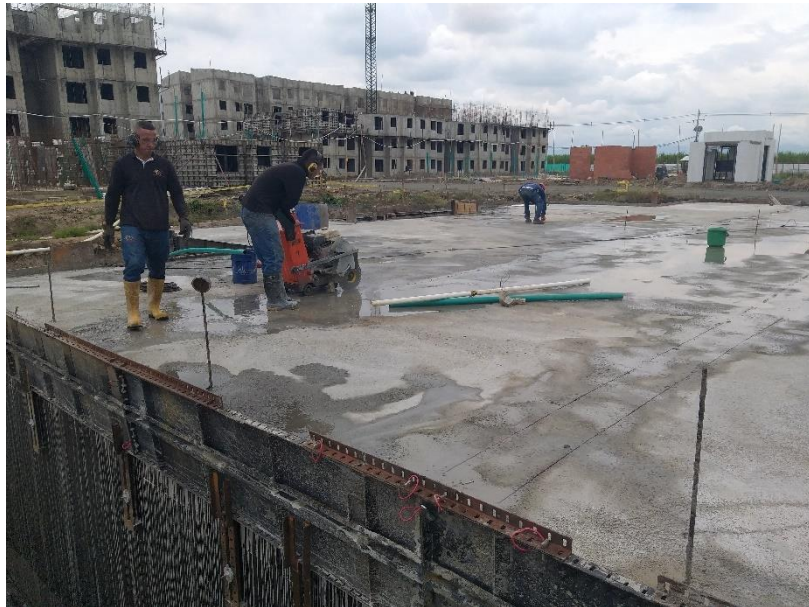
Figura 65 Corte de Losa - Marcación de elementos Estructurales
