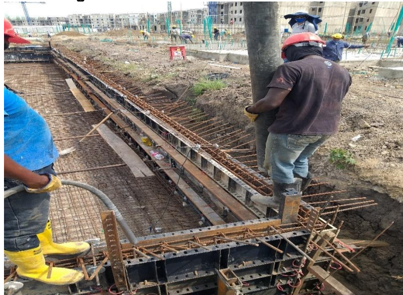
Figura 90 Vaciado Inicial sobre Muros
