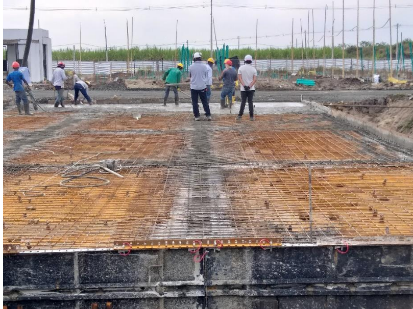
Figura 62 Inicio de Vaciado sobre Losa
