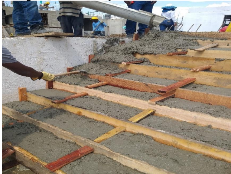
Figura 105 Vaciado y Llenado de Escalones
