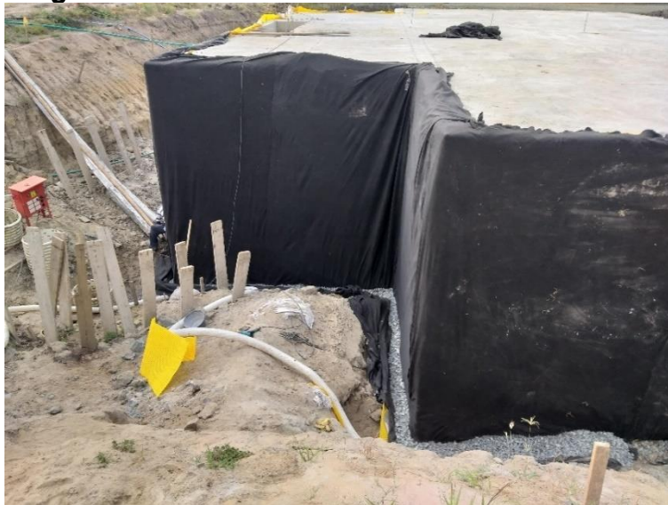
Figura 54 Instalación de Geotextil sobre Muros
