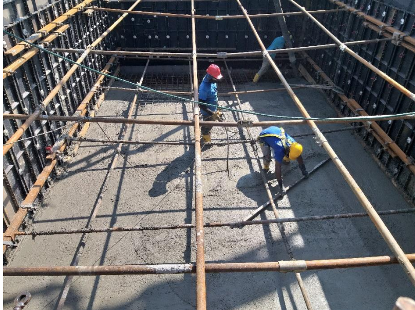
Figura 41 Proceso de Vibrado y Tallado del Concreto
