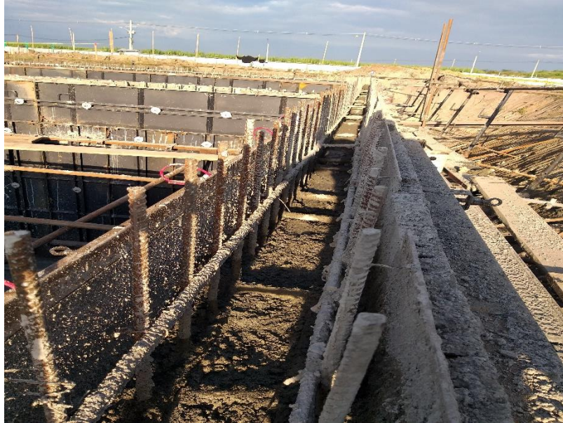
Figura 44 Avance de Vaciado sobre Muros
