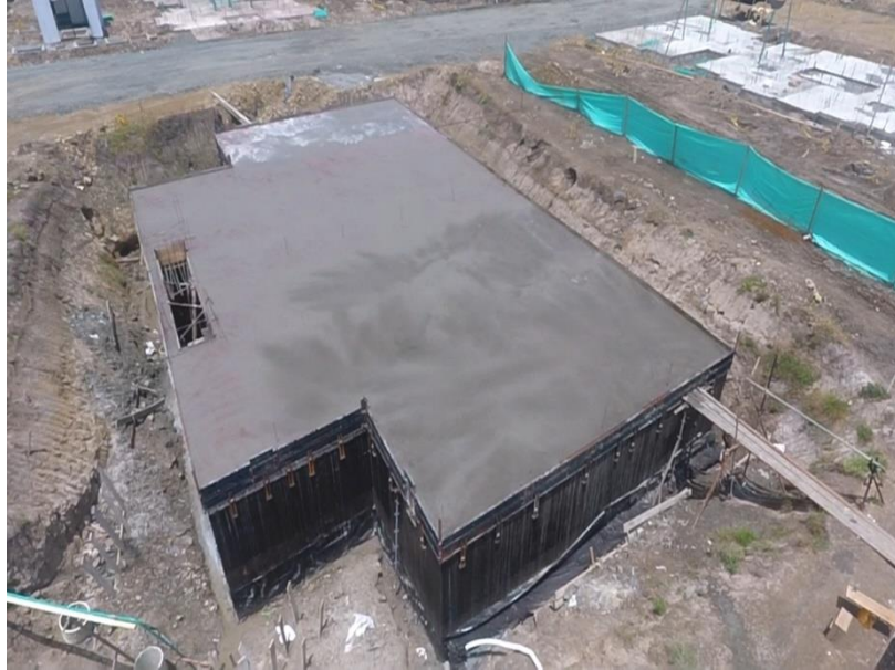
Figura 64 Acabado Final y Aplicación de Antisol
