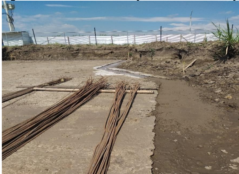
Figura 80 Traslado de Acero y Excavación de Zanja
