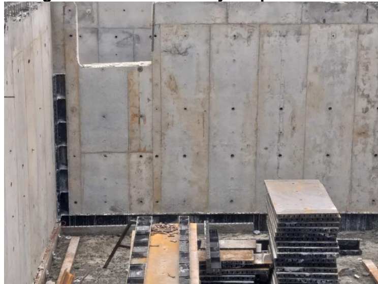
Figura 47 Desencofrado y Limpieza Interna
