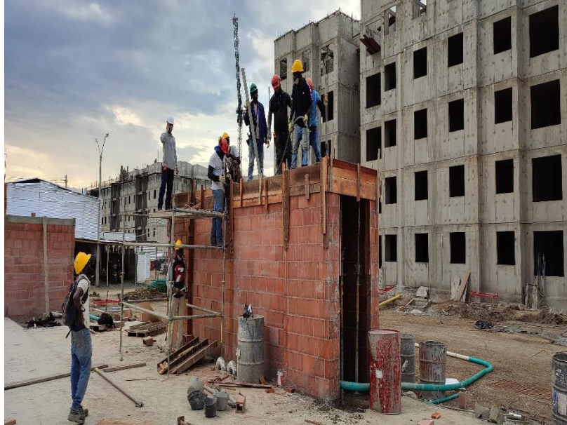
Figura 73 Fundición de Losa Superior Acceso Tanque
