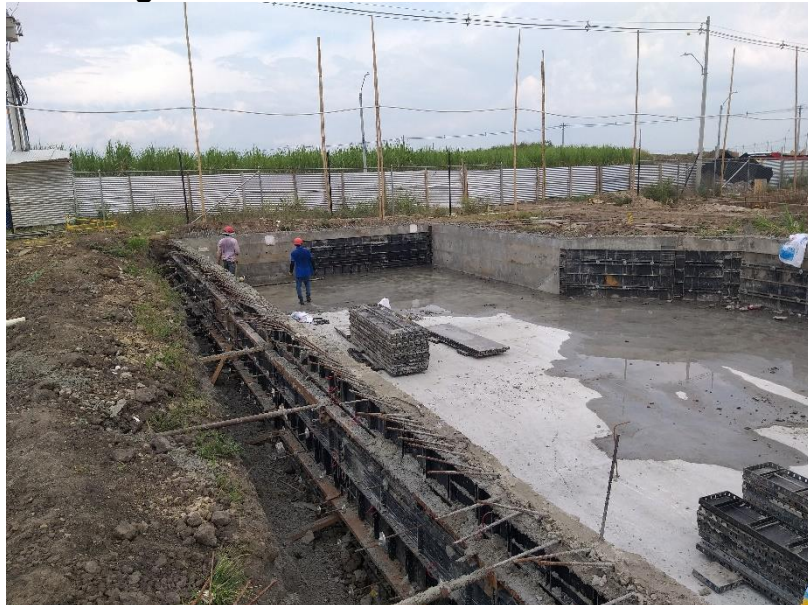
Figura 95 Inicio Actividad Desencofrado
