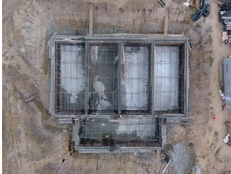
Figura 46 Finalización de la Fundición
