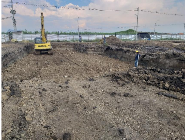
Figura 78 Excavación y Movimiento de Tierras Piscinas
