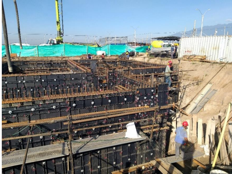
Figura 39 Inicio Actividad Fundición Monolítica
