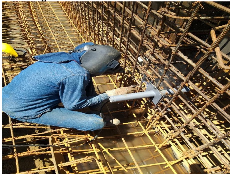
Figura 37 Instalación de Pasamuros 3"
