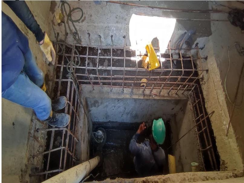
Figura 77 Anclajes de Acero para Acabado de Pozo
