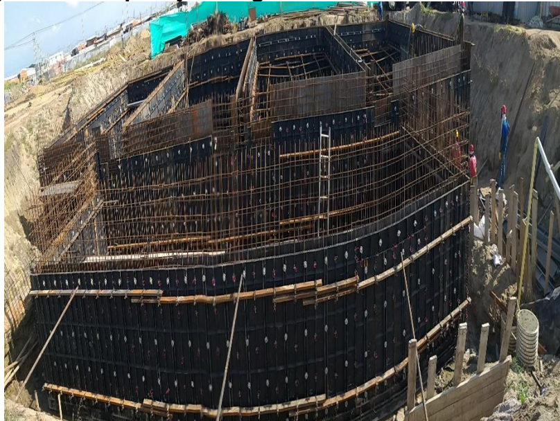
Figura 38 Chequeo y Entrega Final Encofrado de Estructura
