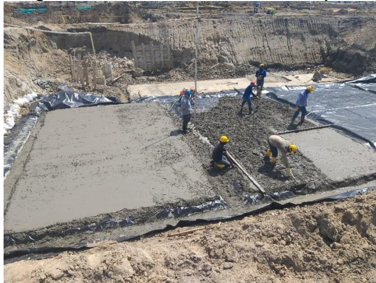
Figura 18 Instalación de Solado de Limpieza
