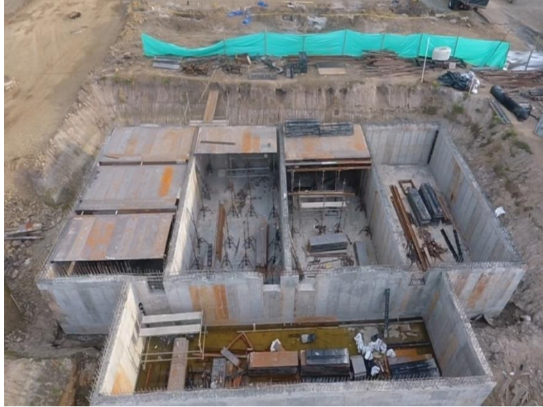
Figura 57 Armado de Soporte y Encofrado Losa Superior
