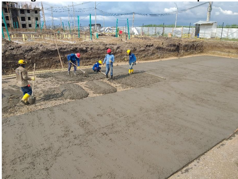
Figura 79 Instalación de Solado de Limpieza
