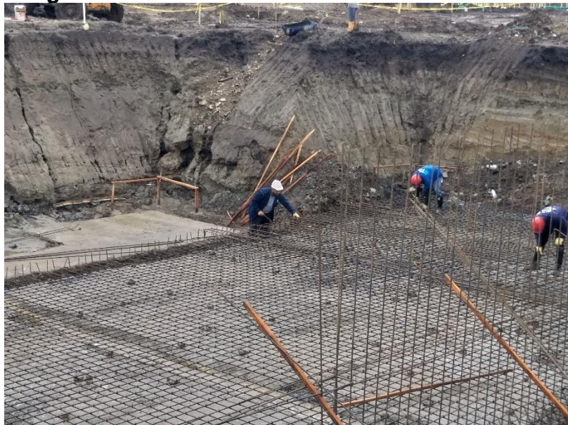
Figura 23 Finalización de Armado Parrilla Inferior
