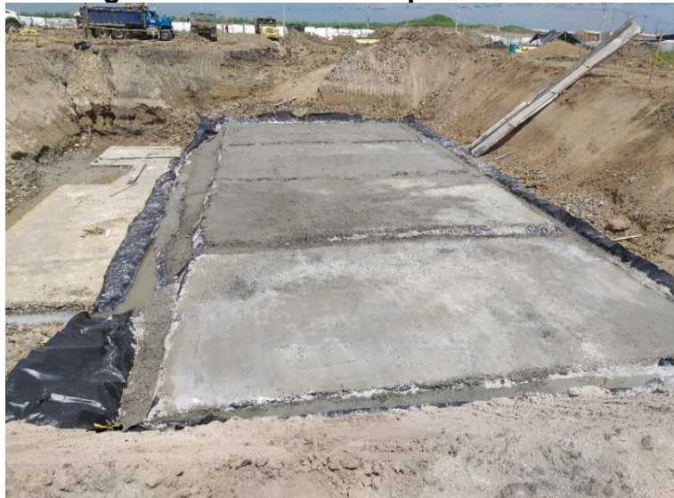
Figura 19 Solado de Limpieza Instalado
