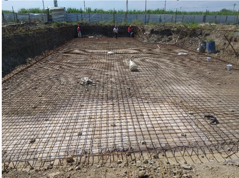
Figura 83 Finalización de Parilla Inferior y Acero Vertical
