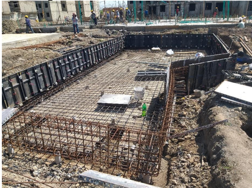
Figura 97 Encofrado Piscina de Niños
