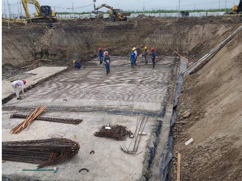
Figura 22 Avance de Armado Acero
