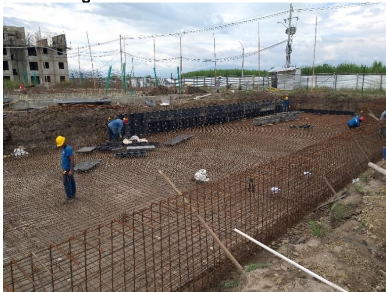
Figura 86 Avance en el Encofrado
