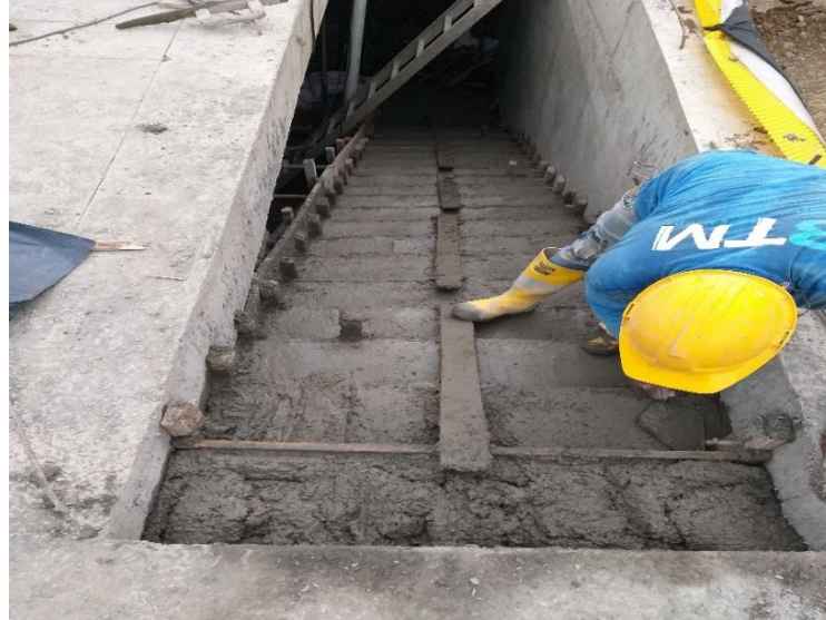
Figura 71 Fundición de Escalera
