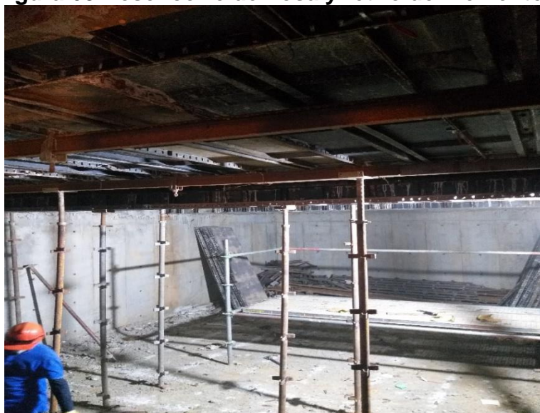
Figura 68 Desencofre de Losa y retiro de Elementos
