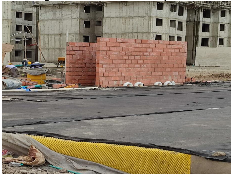
Figura 72 Instalación de Mampostería
