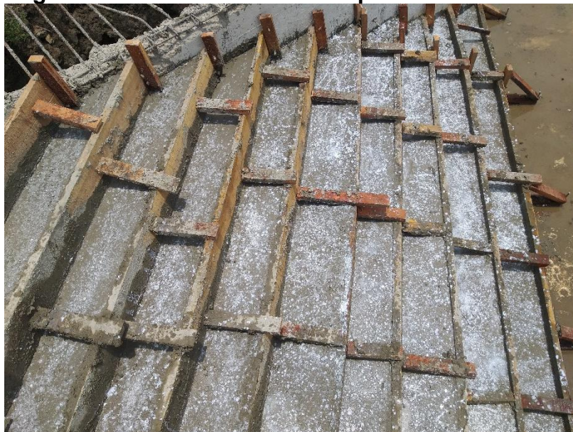
Figura 106 Acabado Final con Aplicación de Antisol
