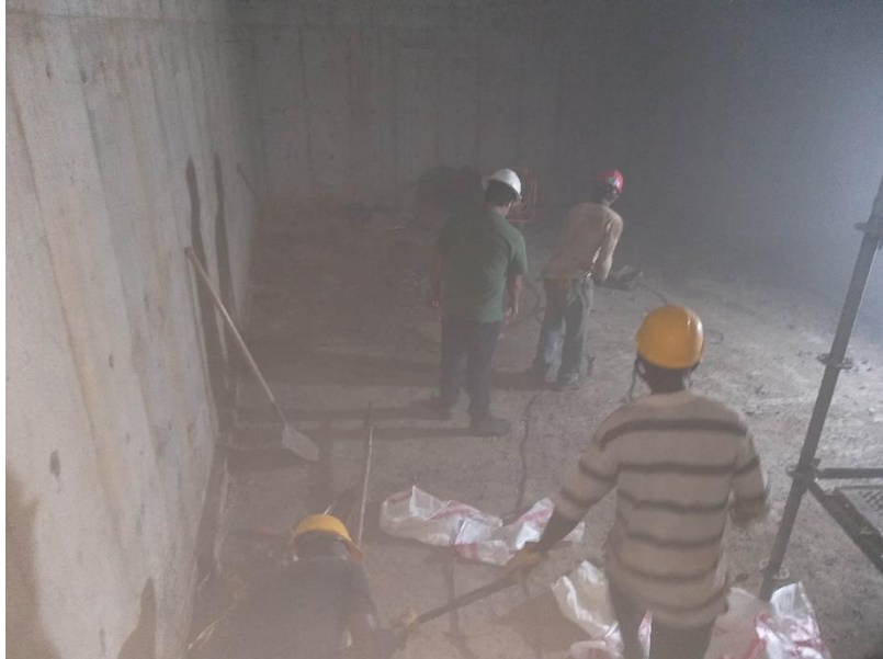
Figura 69 Limpieza y Retiro de Elementos de Encofrado
