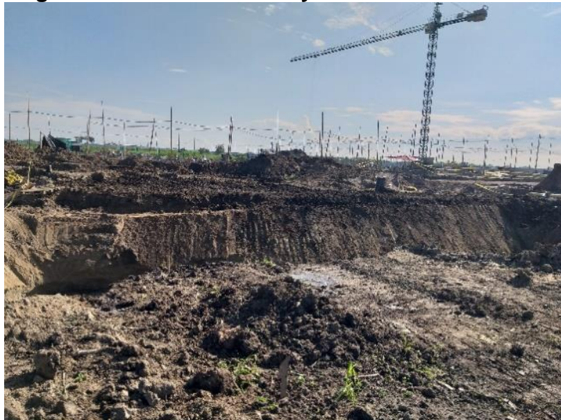
Figura 7 Inicio Excavación y Movimiento de Tierras
