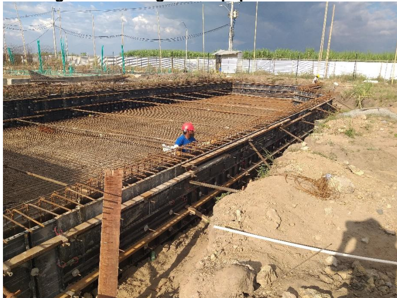
Figura 88 Entrega del Equipo de Encofrado
