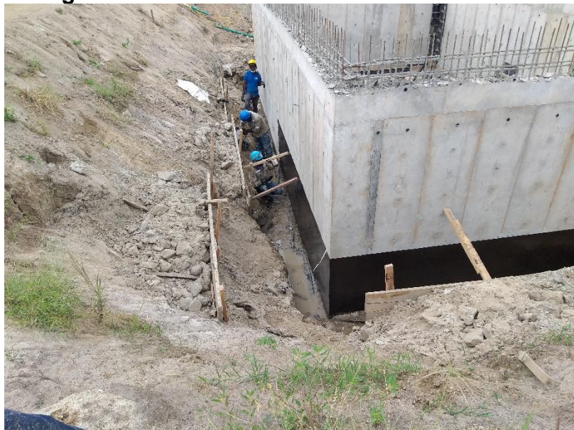
Figura 50 Instalación del Masterseal HLM 5000
