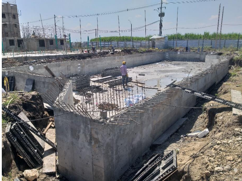
Figura 96 Limpieza de Interna y Retiro de Formaleta
