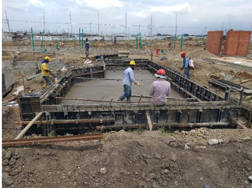
Figura 101 Finalización de Actividad Fundición Piscina
