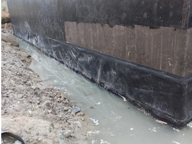
Figura 51 Continuación de la Geomembrana HDPE
