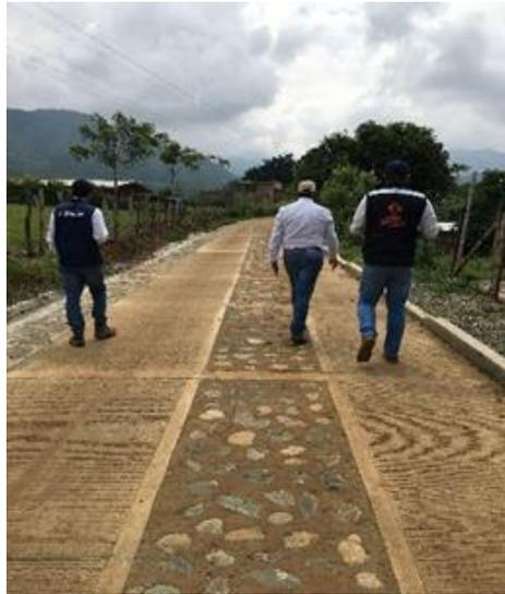
*Ilustración 45: Placa Huella, Municipio de Caloto*
