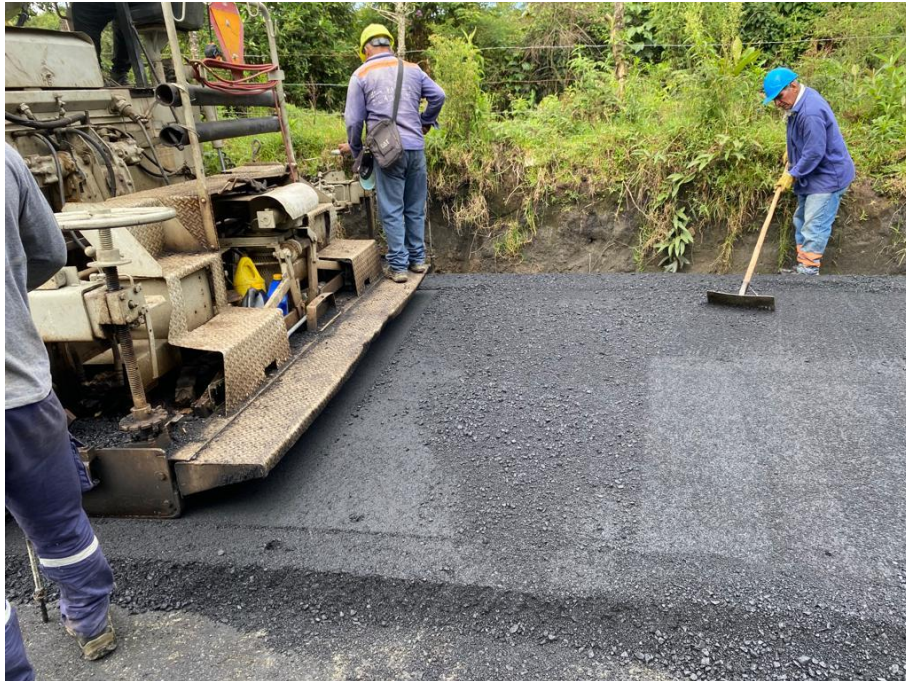
Figura No. 36 Instalación de carpeta asfáltica
