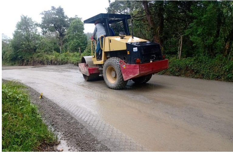
Figura No. 29 Base granular nivelada y compactada con humedad óptima
