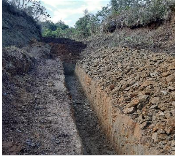
Figura No. 5 Excavación manual para construcción de geodrenes de RCD
