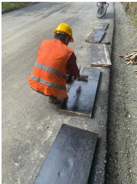
Figura No. 39 Alistado de superficie para cunetas y encofrado
