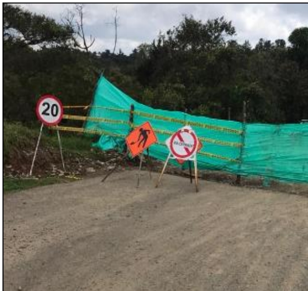
Figura No. 8 Cierre de vía eje rural No 01 e instalación de señalización provisional
