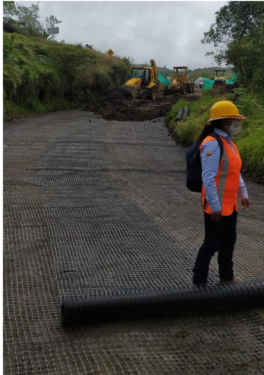
Figura No. 24 Instalación de geomalla biaxial extruida
