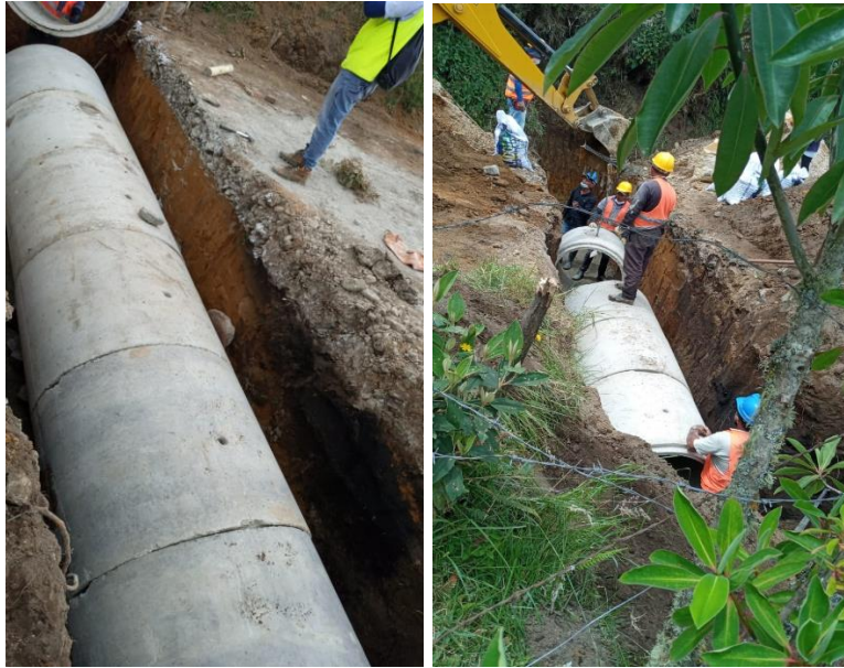
Figura No. 12 Instalación de tubería de 36"
