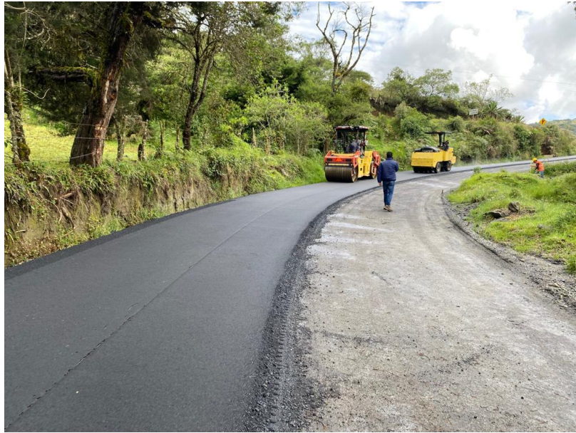
Figura No. 37 Compactación de carpeta asfáltica
