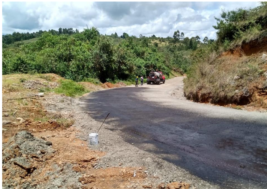
Figura No. 31 Riego de imprimación asfáltica CRL-1
