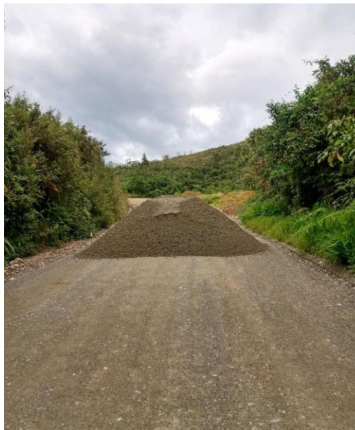
Figura No. 28 Suministro de material base granular
