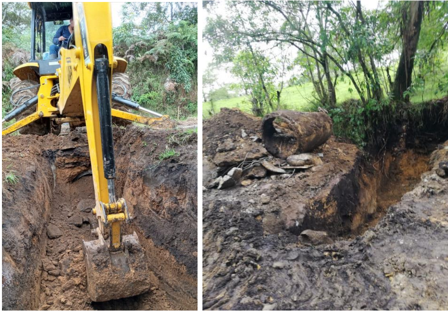
Figura No. 10 Excavación a máquina para la remoción de alcantarillas de 24” y la instalación de tuberías de 36”
