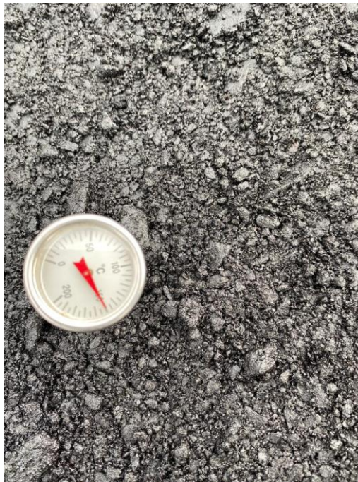
Figura No. 33 Control de temperatura de mezcla asfáltica
