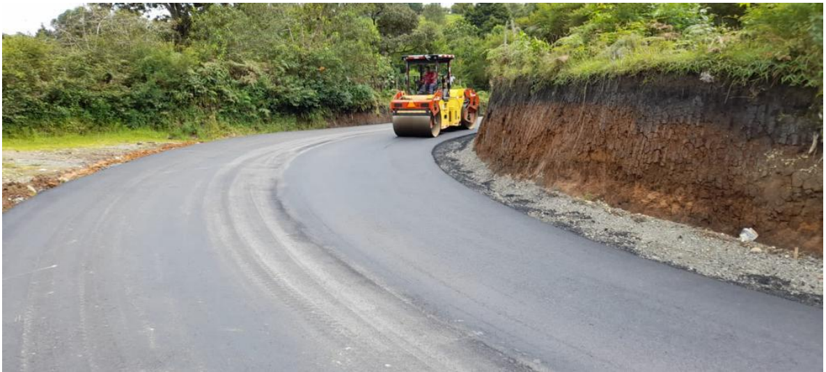
Figura No. 38 Carpeta de rodadura instalada y acabada
