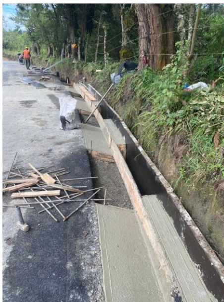
Figura No. 40 Encofrado apuntalado y organizado
