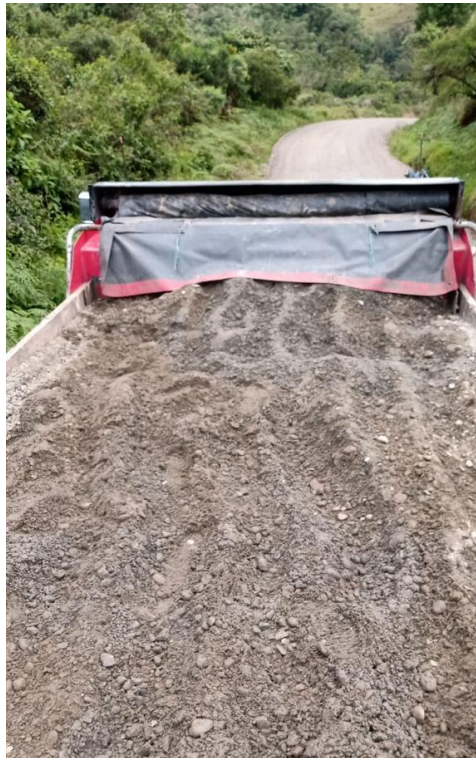
Figura No. 22 Control de material de mejoramiento para la subrasante suministrado con verificación de volumen de capacidad de volquetas suministradoras
