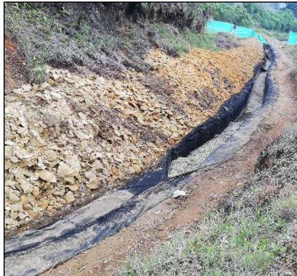
Figura No. 7 Instalación de tubería perforada de colector central y lleno con material filtrante grava triturada de 3/4"
