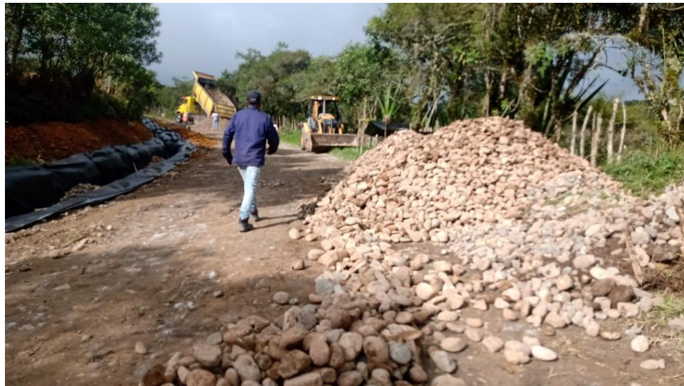
Figura No. 20 Instalación de geotextil para filtros y suministro de piedra filtro 2"
