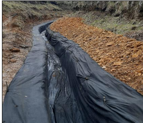
Figura No. 6 Colocación de geotextil No Tejido
