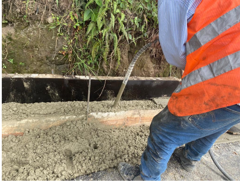
Figura No. 41 Vibración de concreto en las cunetas
