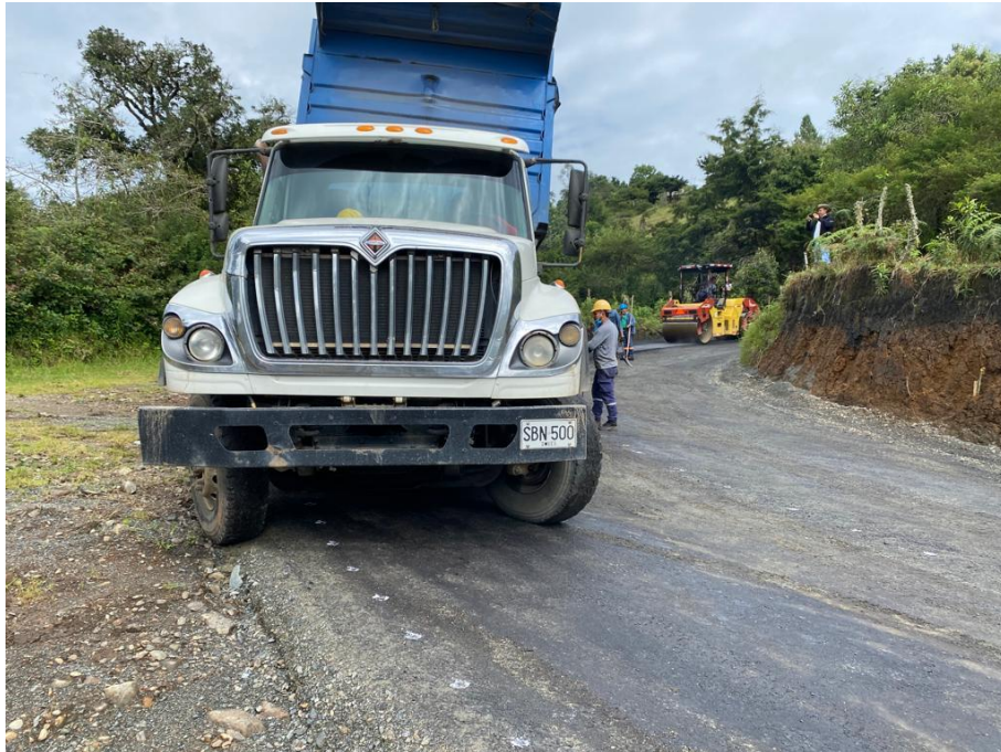
Figura No. 34 Puntos de marcación con cal de bordes en vía
