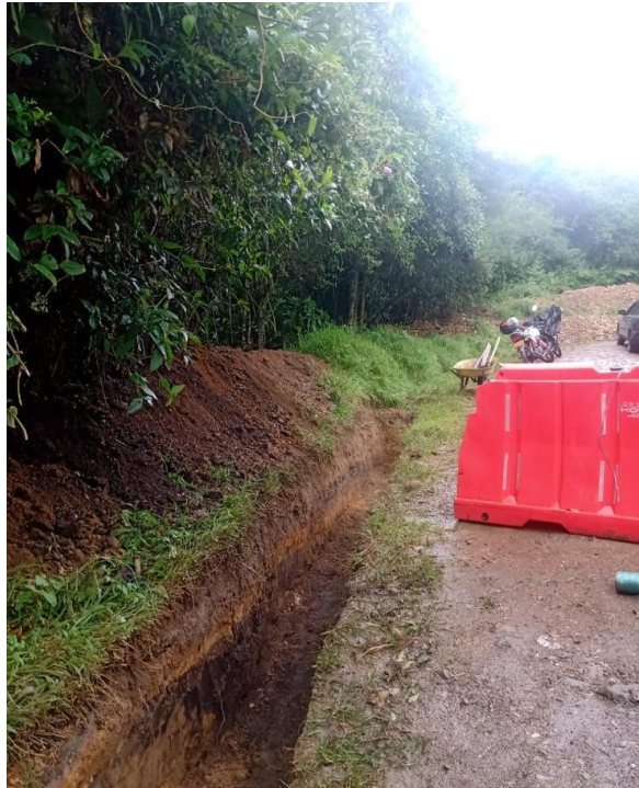
Figura No. 19 Excavación manual para zonas de filtro o subdrenes
