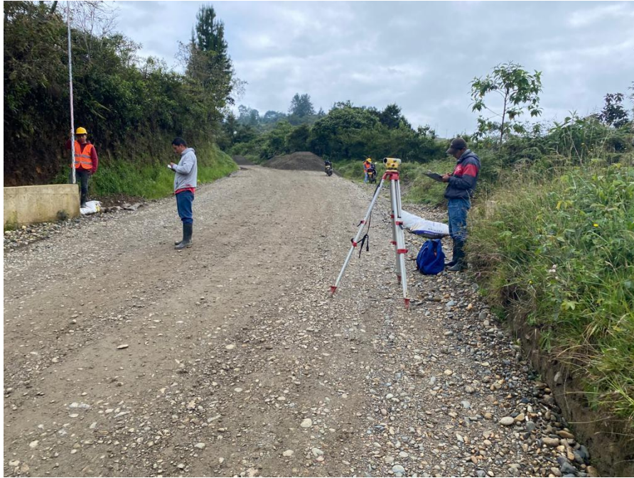
Figura No. 25 Recepción de niveles por parte de topografía de la interventoría
