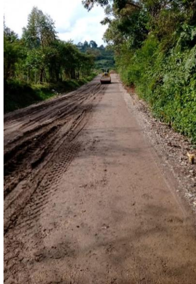
Figura No. 23 Instalación de material de mejoramiento de subrasante 220 INV E-13
