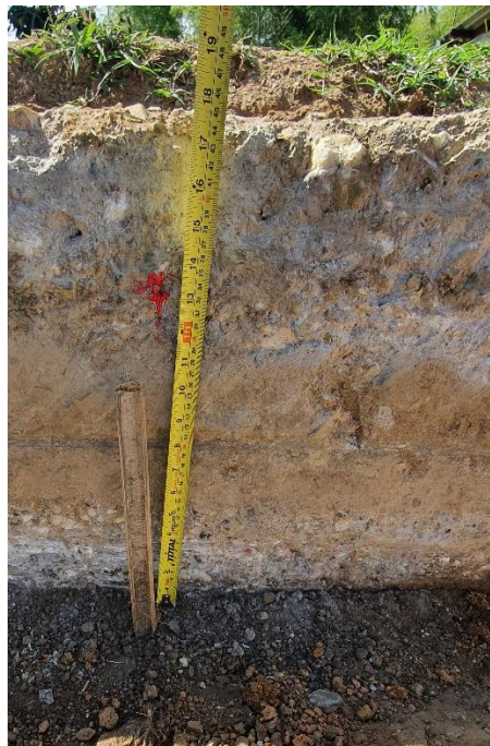
Ilustración 18. Niveles para el respectivo cereo de la subbase Fuente: Elaboración Propia
