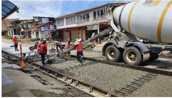
Ilustración 93. Continuación de la fundición del primer carril.
