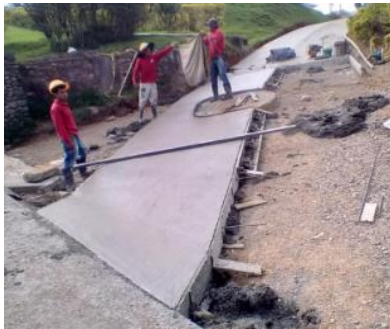
Ilustración 73. Acabados de las losas de concreto.
