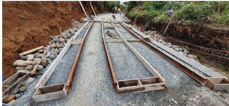
Ilustración 137. Modulación de la formaleta para la placa huella Fuente: Elaboración propia
