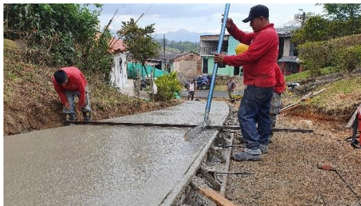
Ilustración 67. Macrotexturizado del pavimento rígido.
