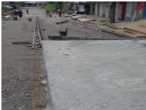
Ilustración 91. Continuación de la instalación de formaletas y adecuación para la respectiva fundición.
