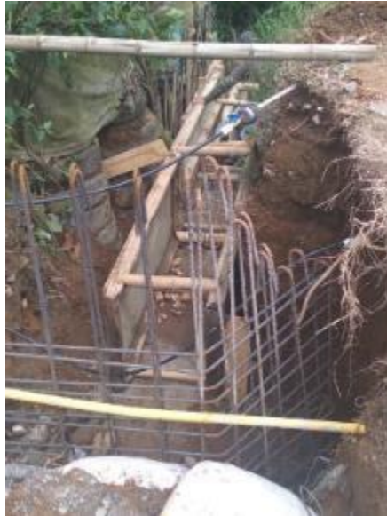
Ilustración 120. Armado de acero de refuerzo para las paredes de los disipadores Fuente: Elaboración propia
