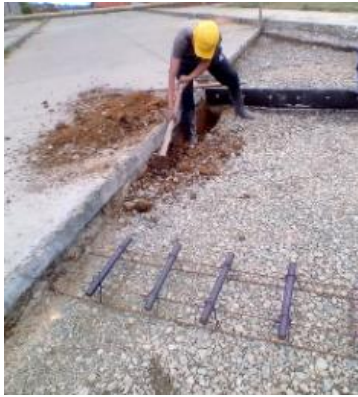
Ilustración 41. Instalación de las parrillas cada 3m.
