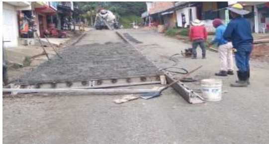
Ilustración 89. Inicio de pavimentación del primer carril.
