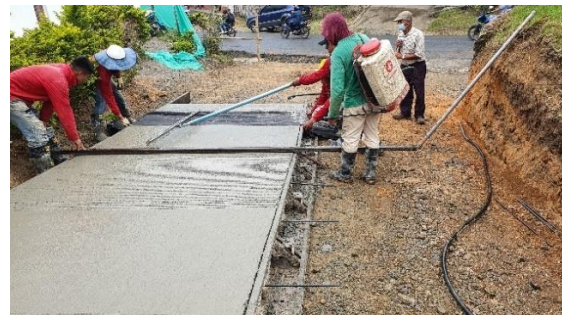
Ilustración 68. Curado del concreto.
