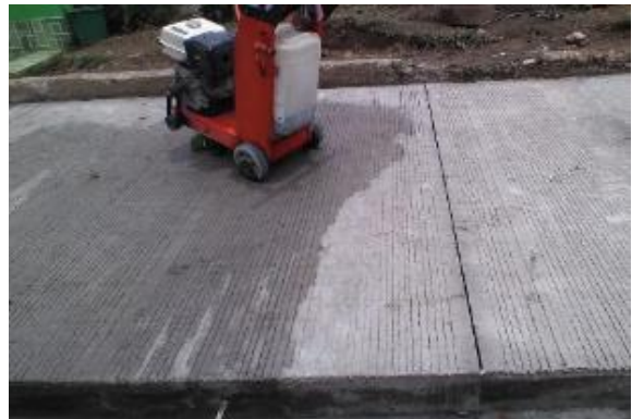
Ilustración 50. Corte de las dilataciones con cortadora del concreto.
