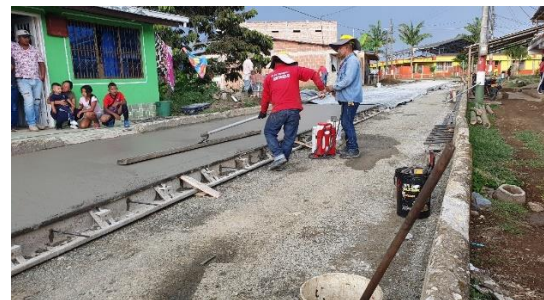
Ilustración 44. Flotado del concreto.
