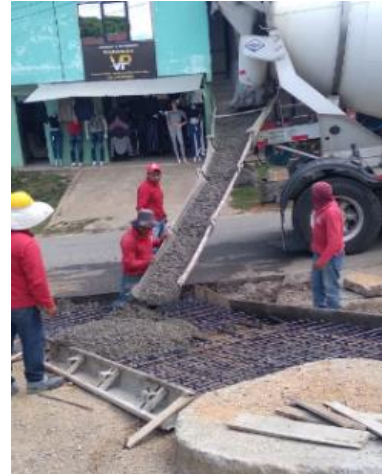
Ilustración 72. Fundición de las losas reforzadas y primer carril hasta el empalme.
