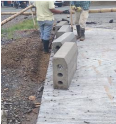
Ilustración 107. Se inicio con la instalación de bordillos de concreto prefabricado (263.20 ml).
