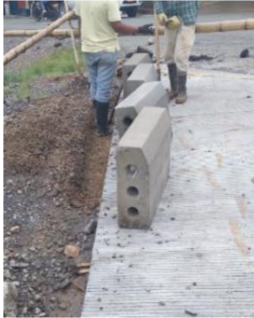
Ilustración 30. Instalación de bordillos prefabricados Fuente: Elaboración propia
