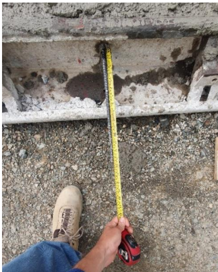
Ilustración 45. Medida del refuerzo longitudinal.
