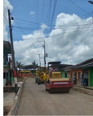
Ilustración 19. Conformación y compactación de la sub-base granular clase A Fuente: Elaboración propia
