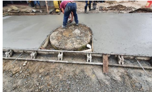
Ilustración 98. Fundición y acabados de las losas que tienen refuerzo.
