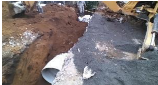
Ilustración 118. Relleno de la zanja sobre el tubo de 36" con la retroexcavadora Fuente: Elaboración propia
