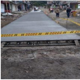
Ilustración 95. Cerramiento y estado final de las losas fundidas.
