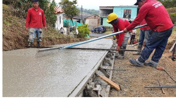
Ilustración 48. Macrotexturizado del pavimento rígido.
