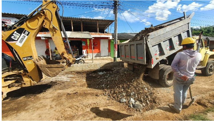
Ilustración 125. Descargue de material de mejoramiento para fallos Fuente: Elaboración propia
