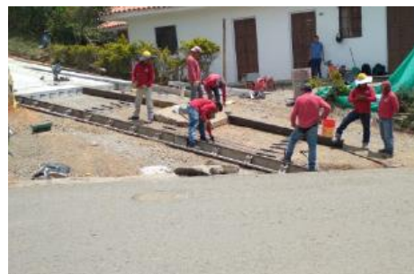
Ilustración 70. Instalación de formaletas para continuar con la fundición.
