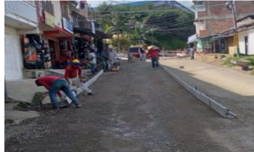
Ilustración 88. Instalación de formaletas metálicas.
