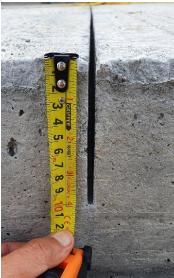
Ilustración 51. Medida de la profundidad del corte de las juntas.
