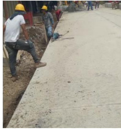
Ilustración 108. Continuación de la instalación de bordillos y excavación manual.
