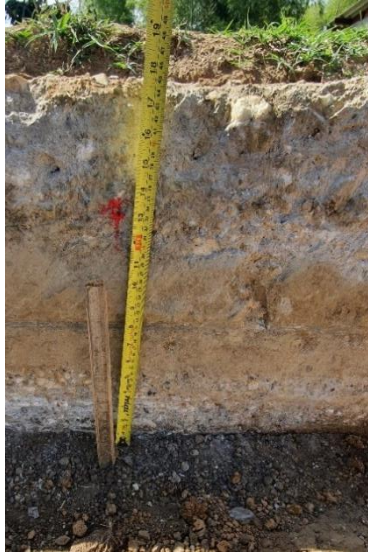
Ilustración 35. Niveles para el respectivo cereo de la subbase granular clase A.
