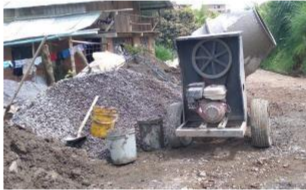
Ilustración 122. Mezclador mecánico para la fundición Fuente: Elaboración propia
