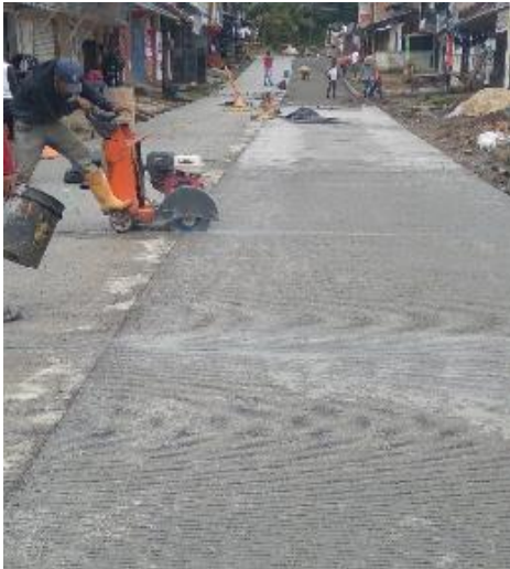
Ilustración 101. Corte de las dilataciones con la cortadora de concreto.
