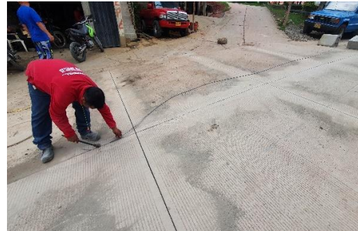
Ilustración 110. Instalación del sellamiento en las juntas de dilataciones para el estado final de la vía.
