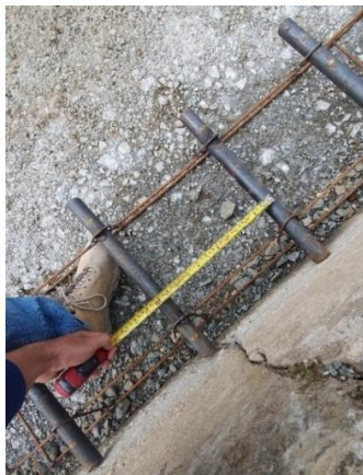
Ilustración 39. Verificación del espaciamiento entre dovelas
