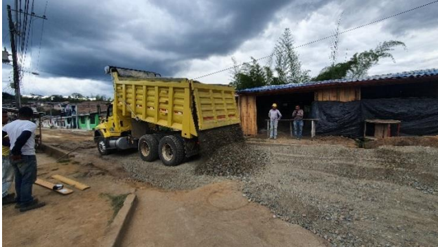
Ilustración 19. Conformación y compactación de la sub-base granular clase A Fuente: Elaboración propia
