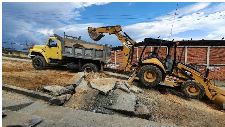
Ilustración 16. Demolición y remoción de pavimento rígido Fuente: Elaboración propia
