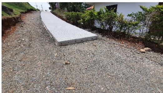
Ilustración 69. Control de calidad de la primera jornada de fundición.
