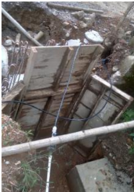
Ilustración 121. Instalación de formaletas para las aletas de salida Fuente: Elaboración propia
