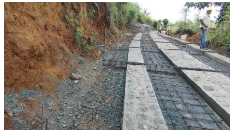
Ilustración 145. Instalación del acero de refuerzo para la riostra y la placa huella.
