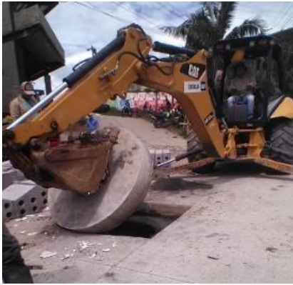
Ilustración 109. Instalación de tapa de concreto para una recamara la cual estaba en mal estado.
