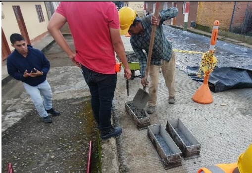
Ilustración 55. Toma de muestras del concreto en formaletas de vigas.
