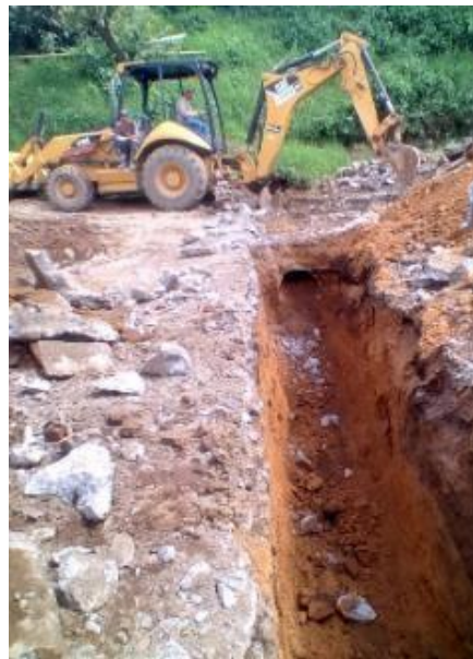
Ilustración 116. Excavación con la retroexcavadora de la zanja para instalar el tubo de 36" Fuente: Elaboración propia
