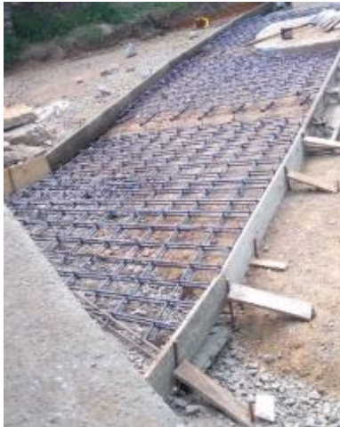
Ilustración 71. Armado de refuerzo con doble parrilla en losas irregulares.
