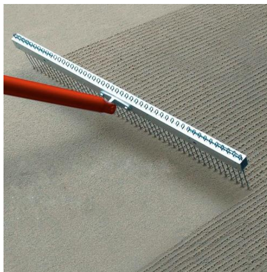
Ilustración 25. Proceso de macrottexturizado con un cepillo metálico texturizador para concreto Fuente: Compañía SUMPROYEQUIPOS
