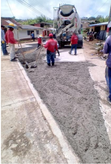
Ilustración 53. Fundición de losas irregulares.
