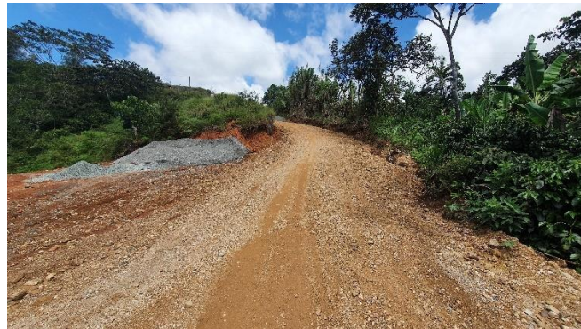
Ilustración 134. Estado del material de afirmado en los tramos a intervenir Fuente: Elaboración Propia
