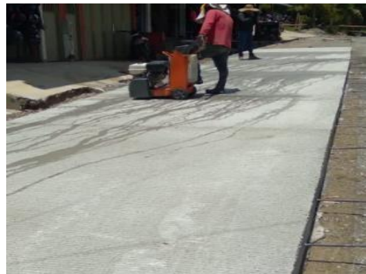
Ilustración 92. Corte de las dilataciones con la cortadora de concreto.
