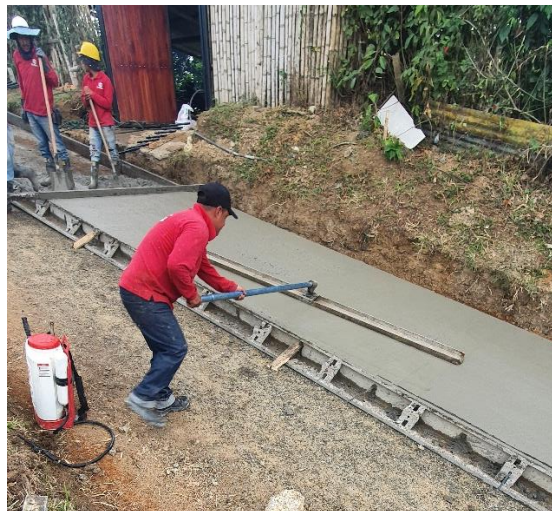
Ilustración 23. Flotado del concreto hidráulico Fuente: Elaboración propia
