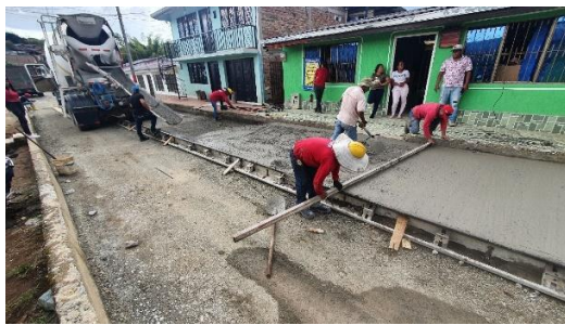
Ilustración 43. Esparcimiento del concreto con la ayuda de una regla metálica.
