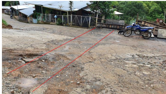
Ilustración 123. Estado final del avance en el tramo 4 Barrio San Fernando Fuente: Elaboración propia
