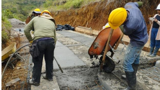
Ilustración 146. Fundición y vibrado de la franja de la placa huella.
