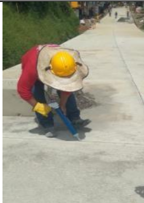
Ilustración 111. Aplicación del sellante de poliuretano que cura con la humedad presente en el ambiente. Proporcionando una resistencia excepcional al desgaste y la ruptura en áreas de alto tráfico.
