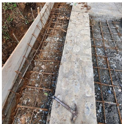
Ilustración 138. Armado del acero de refuerzo Fuente: Elaboración propia
