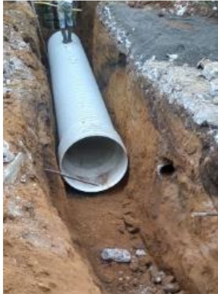
Ilustración 117. Instalación del tubo de 36" con la ayuda de la retroexcavadora Fuente: Elaboración propia
