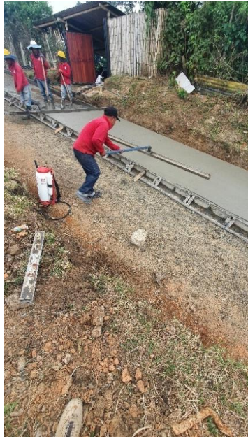
Ilustración 65. Flotado del concreto hidráulico.
