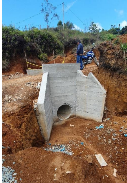
Ilustración 140. Toma de medidas a la estructura que compone la alcantarilla Fuente: Elaboración Propia
