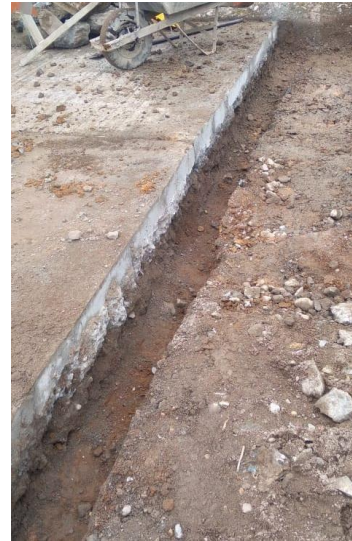
Ilustración 102. Excavación manual de la viga de sobre espesor para el empalme.
