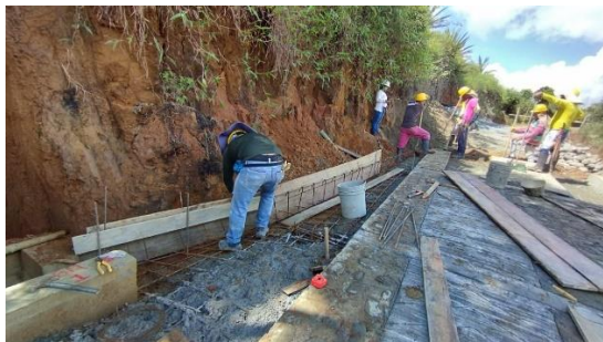
Ilustración 148. Instalación de formaleta de madera para fundir los bordillos y berma.
