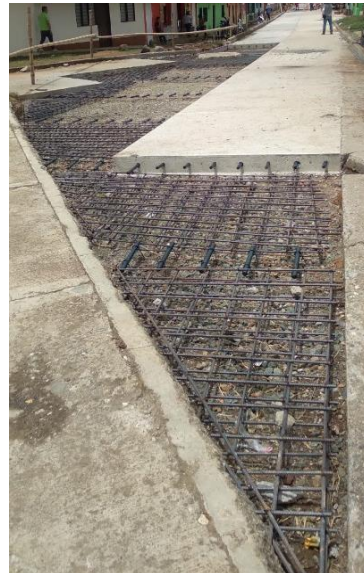
Ilustración 52. Armado de parrillas de refuerzo para losas irregulares.
