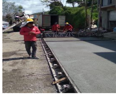
Ilustración 94. Tallado y acabados para estado final de las losas de concreto.
