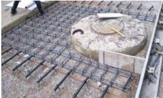
Ilustración 97. Armado de parrillas dobles para refuerzo de la losa alrededor del brocal.
