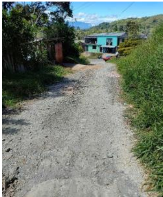
Ilustración 58. Estado inicial del pavimento tramo 2 Fuente: Informe de interventoría
