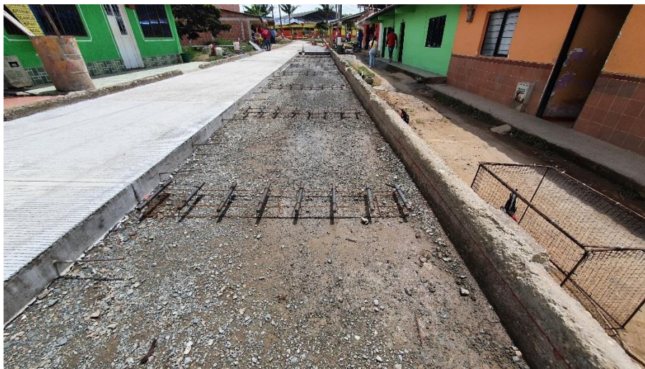
Ilustración 21. Instalación de las canastillas cada 3m Fuente: Elaboración propia
