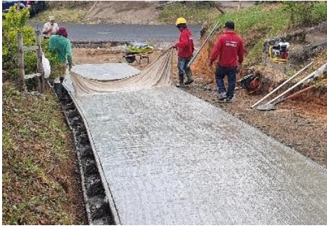
Ilustración 47. Microtexturizado del pavimento rígido.
