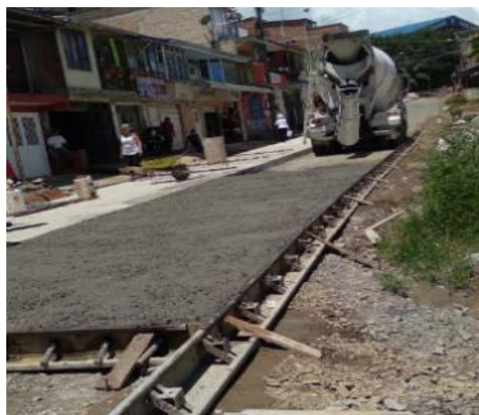
Ilustración 98. Fundición y acabados de las losas que tienen refuerzo.
