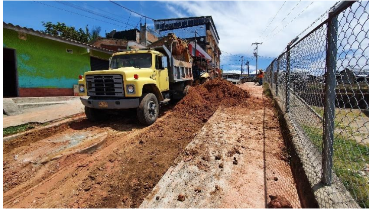
Ilustración 17. Excavación y retiro sin clasificar Fuente: Elaboración propia
