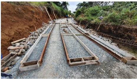
Ilustración 144. Instalación de formaletas metálicas y cajones en madera.
