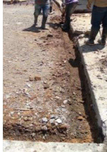
Ilustración 54. Excavación manual para las vigas de sobre espesor.
