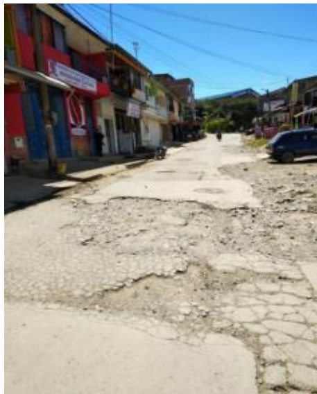
Ilustración 86. Estado inicial del pavimento tramo 3 Fuente: Informe de interventoría
