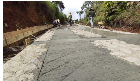
Ilustración 147. Acabados y texturizado del concreto.
