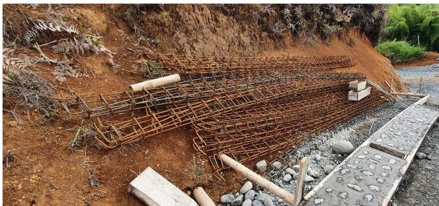
Ilustración 139. Armado de las riostras Fuente: Elaboración propia
