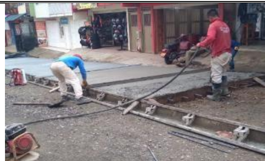
Ilustración 90. Instalación de las dovelas para las dilataciones. .
