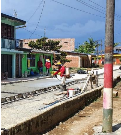
Ilustración 26. Curado del concreto Fuente: Elaboración propia
