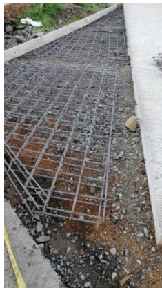
Ilustración 103. Instalación de parrillas dobles para las losas irregulares.
