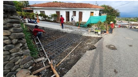
Ilustración 76. Armado de parrillas en acero de 1/2" para refuerzo.
