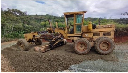
Ilustración 142. Riego de la Subbase granular clase C.
