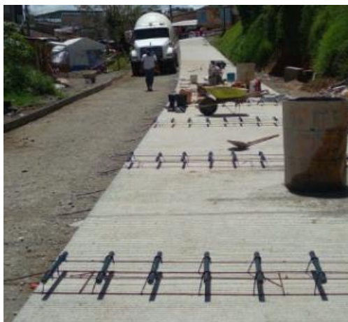
Ilustración 97. Armado de parrillas dobles para refuerzo de la losa alrededor del brocal.
