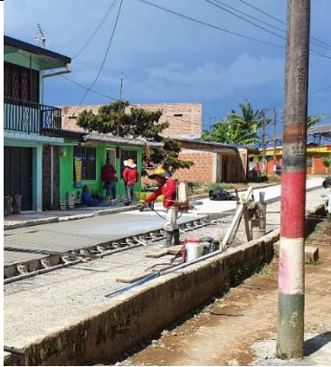
Ilustración 47. Microtexturizado del pavimento rígido.
