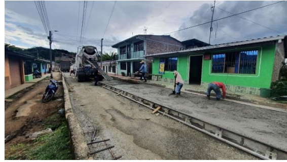
Ilustración 42. Vaciado del concreto hidráulico MR-39.
