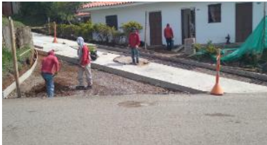
Ilustración 75. Curado del concreto.
