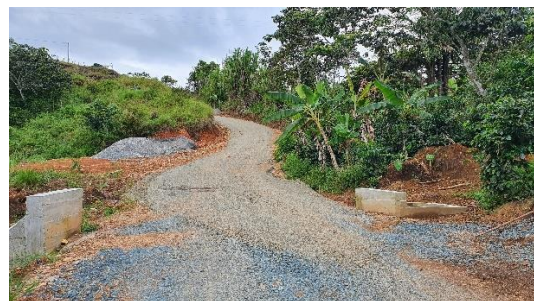
Ilustración 149. Estado actual de los otros 2 tramos, la superficie (Subbase) está lista para el armado de formaletas.
