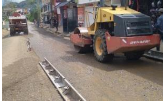
Ilustración 87. Riego de agua con volqueta y tanque, compactación con el vibrocompactador.
