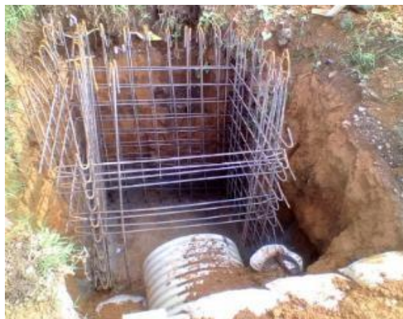
Ilustración 119. Armado de acero de refuerzo para la caja de entrada Fuente: Elaboración propia
