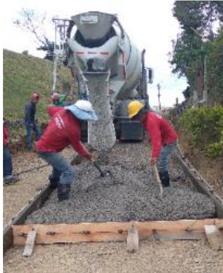
Ilustración 22. Descarga del material de pavimento hidráulico MR-39 Fuente: Elaboración propia
