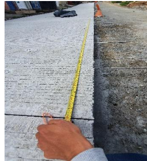
Ilustración 96. Verificación de la relación largo/ancho de la losa (1.13).
