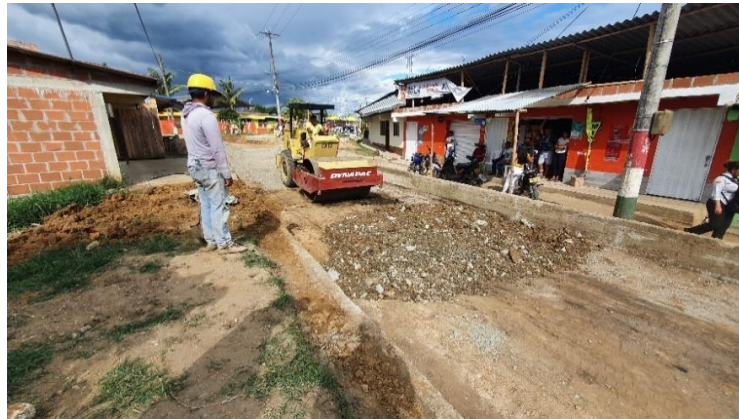
Ilustración 126. Compactación de material de mejoramiento Fuente: Elaboración propia
