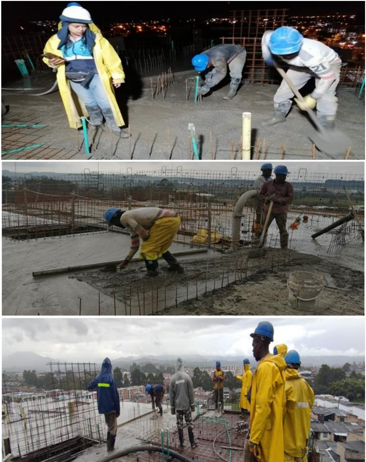
Ilustración 17. Vaciado y nivelación de superficies
