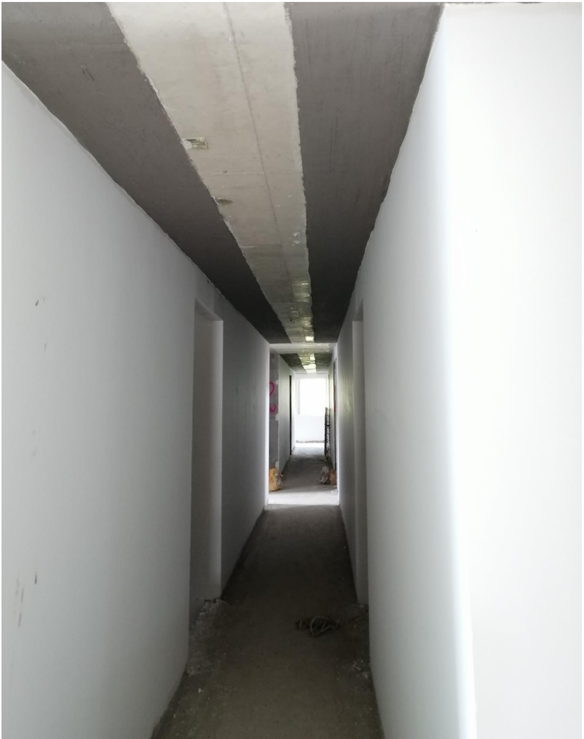
Ilustración 53. Estucado y pintura de los muros del pasillo interior
