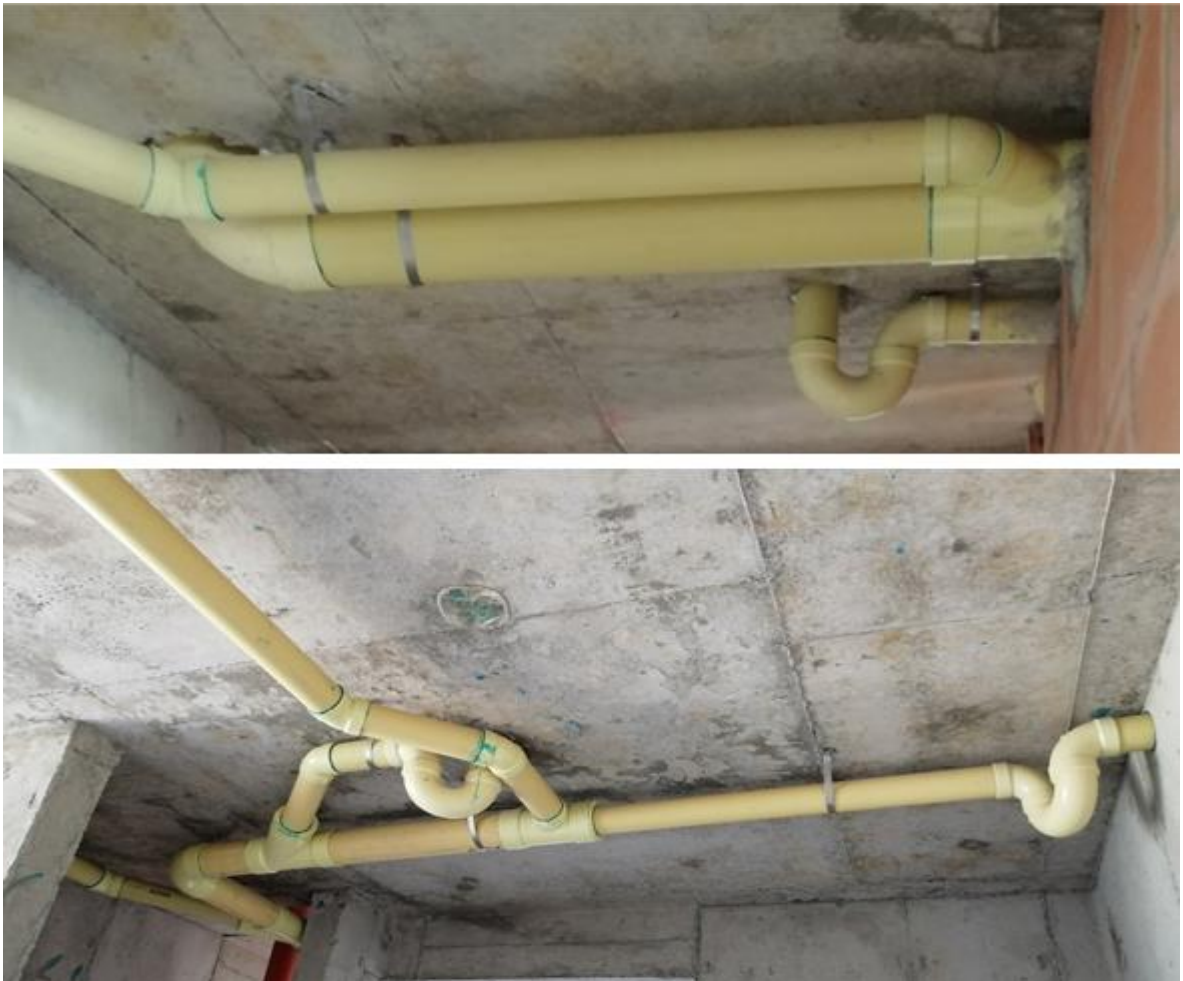
Ilustración 62. Ramales sanitarios
