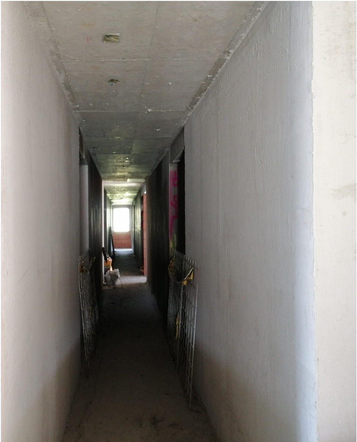
Ilustración 52. Relleno de los muros del pasillo interior
