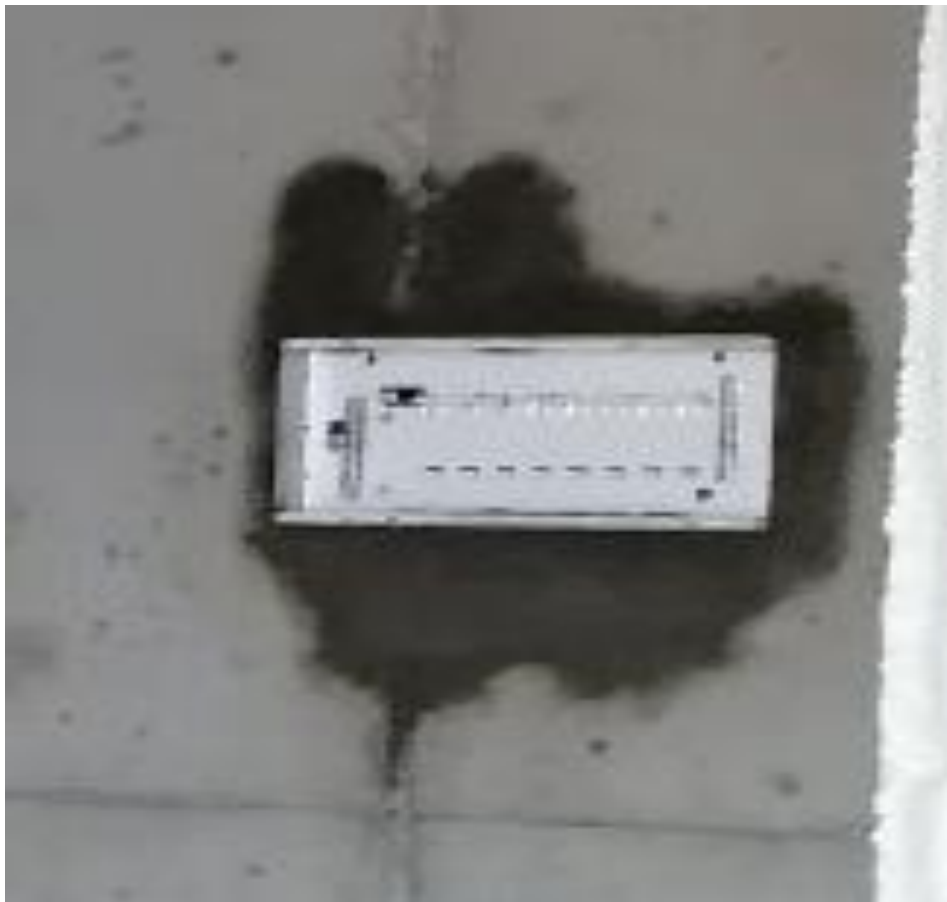
Ilustración 59. Caja de tablero instalada y recalzada
