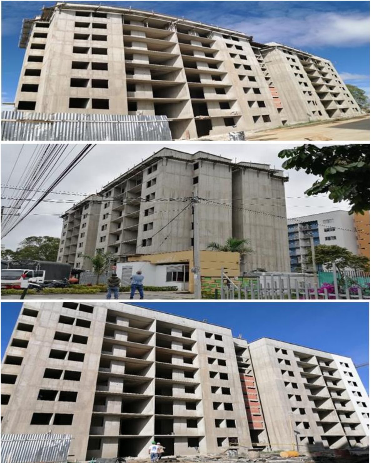
Ilustración 25. Avance de fundición 4
