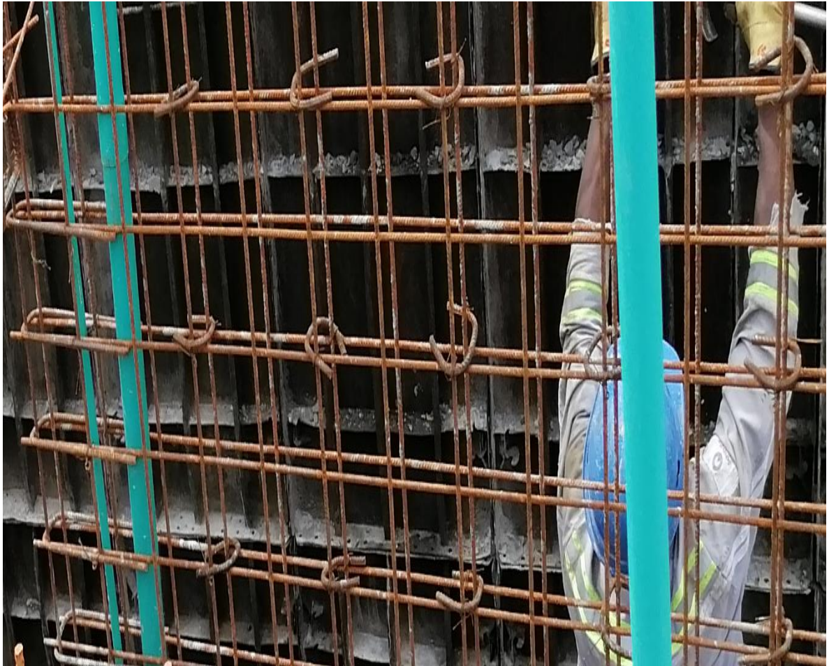
Ilustración 34. Muro con doble malla
