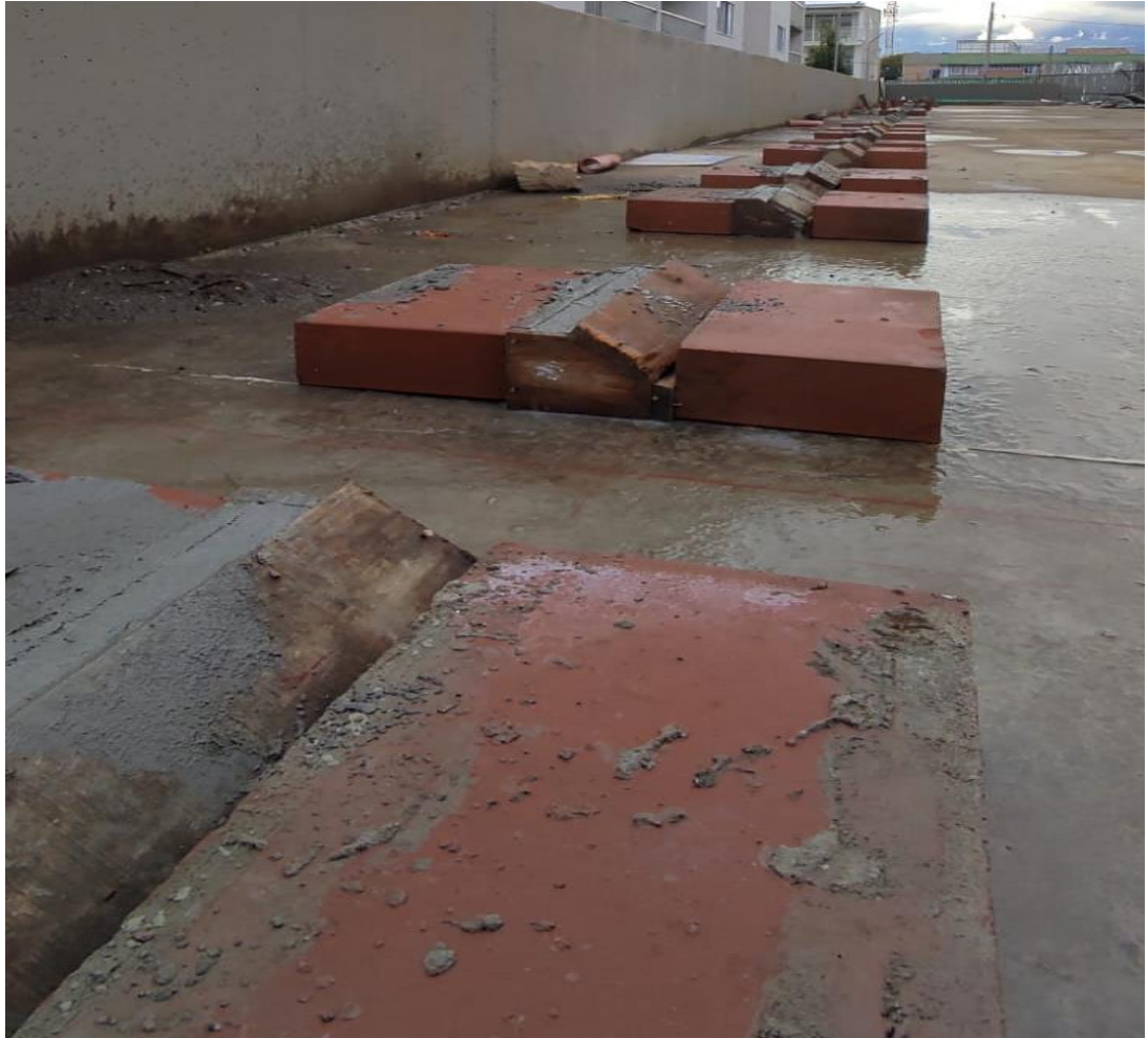
Ilustración 68. Fundición de topellantas
