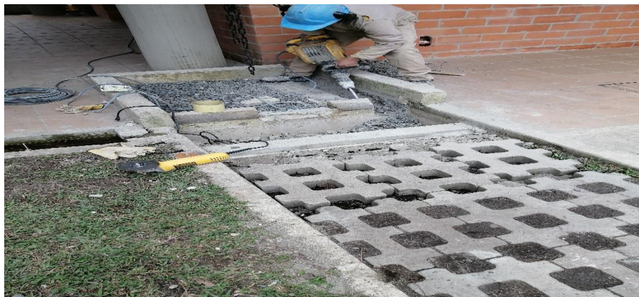
Ilustración 84. Trabajos de modificación de espacios
