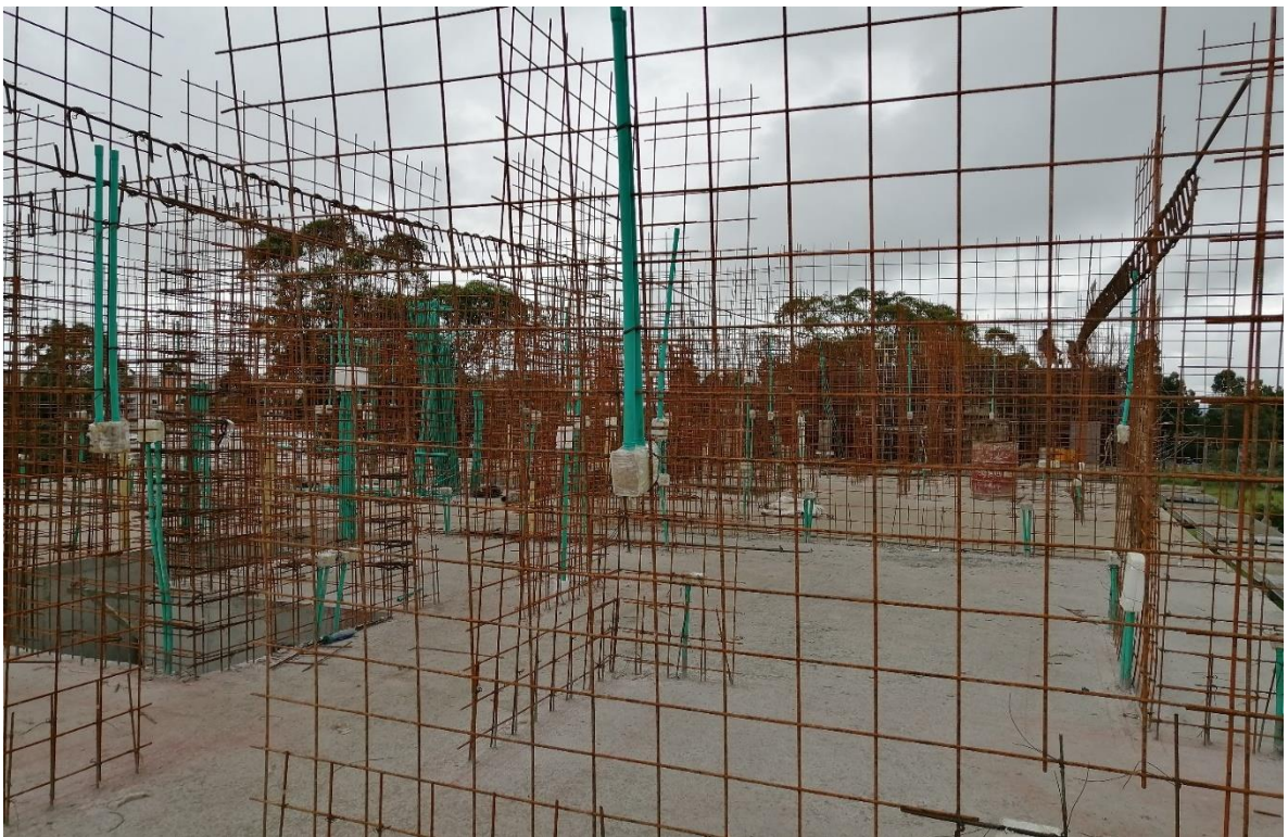
Ilustración 26. Armaduras de los muros
