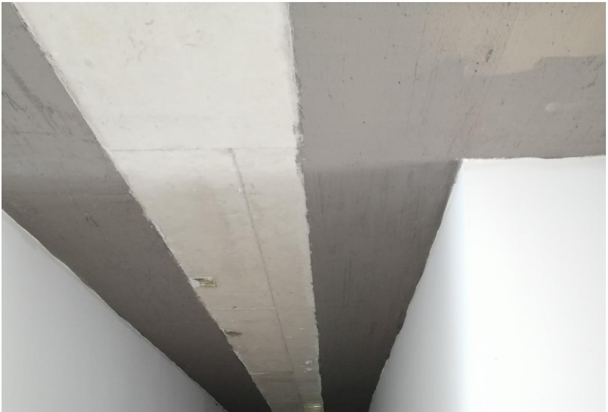
Ilustración 54. Relleno y pintura del cielo del pasillo interior
