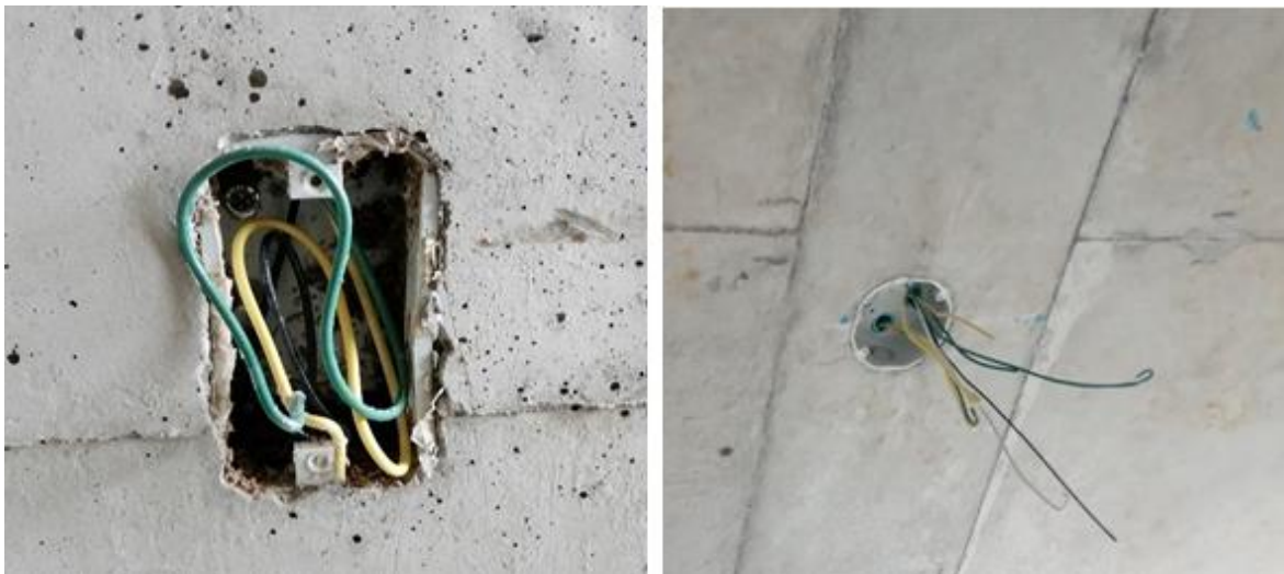
Ilustración 60. Alambrado de apartamentos
