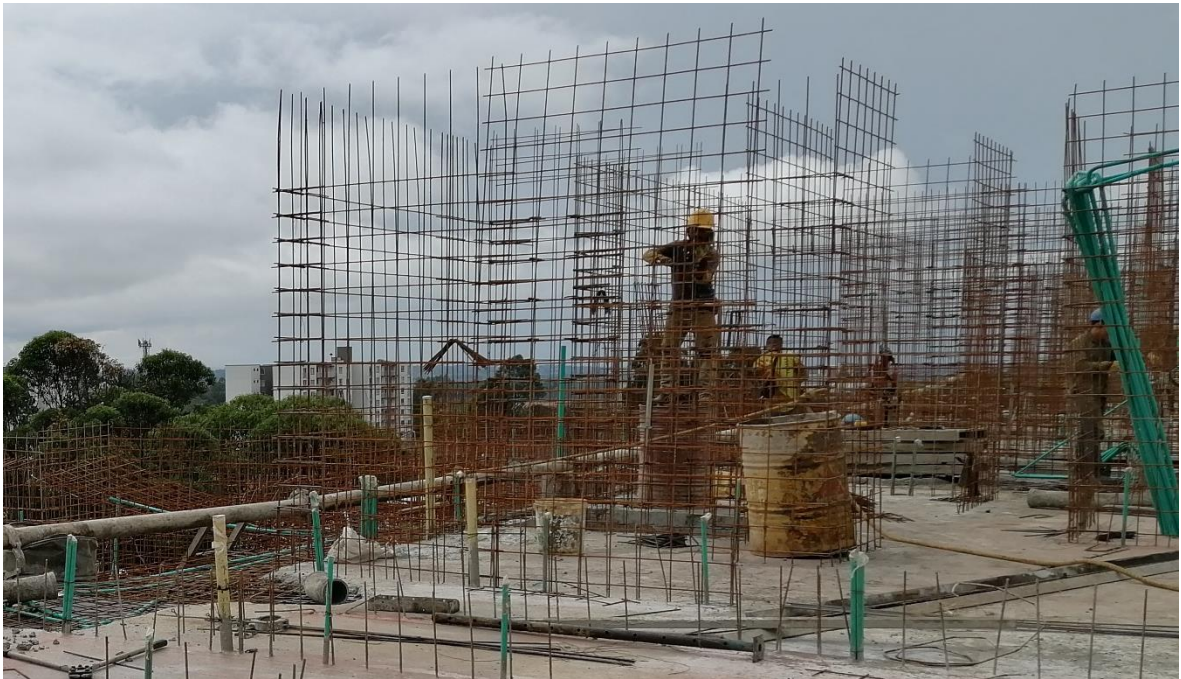
Ilustración 27. trabajos de armado de mallas
