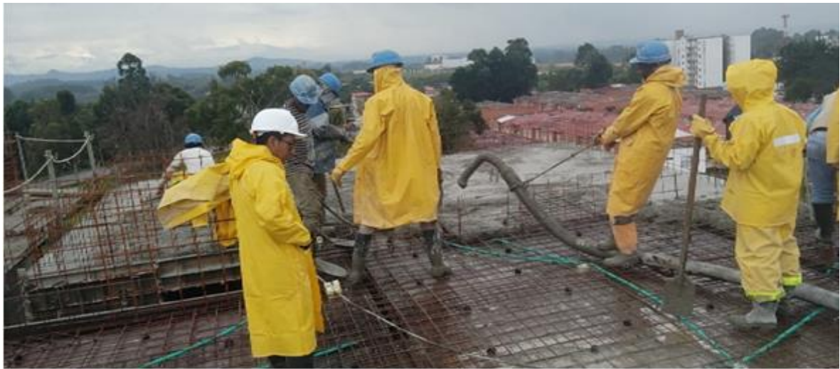
Ilustración 16. Vaciado del concreto
