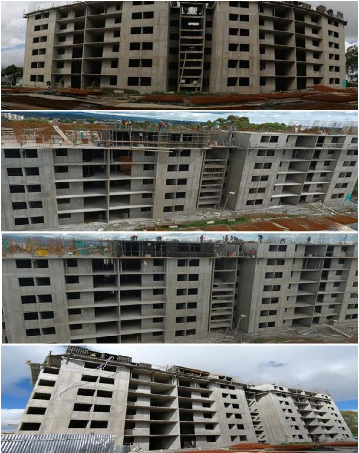
Ilustración 23. Avance de fundición 2
