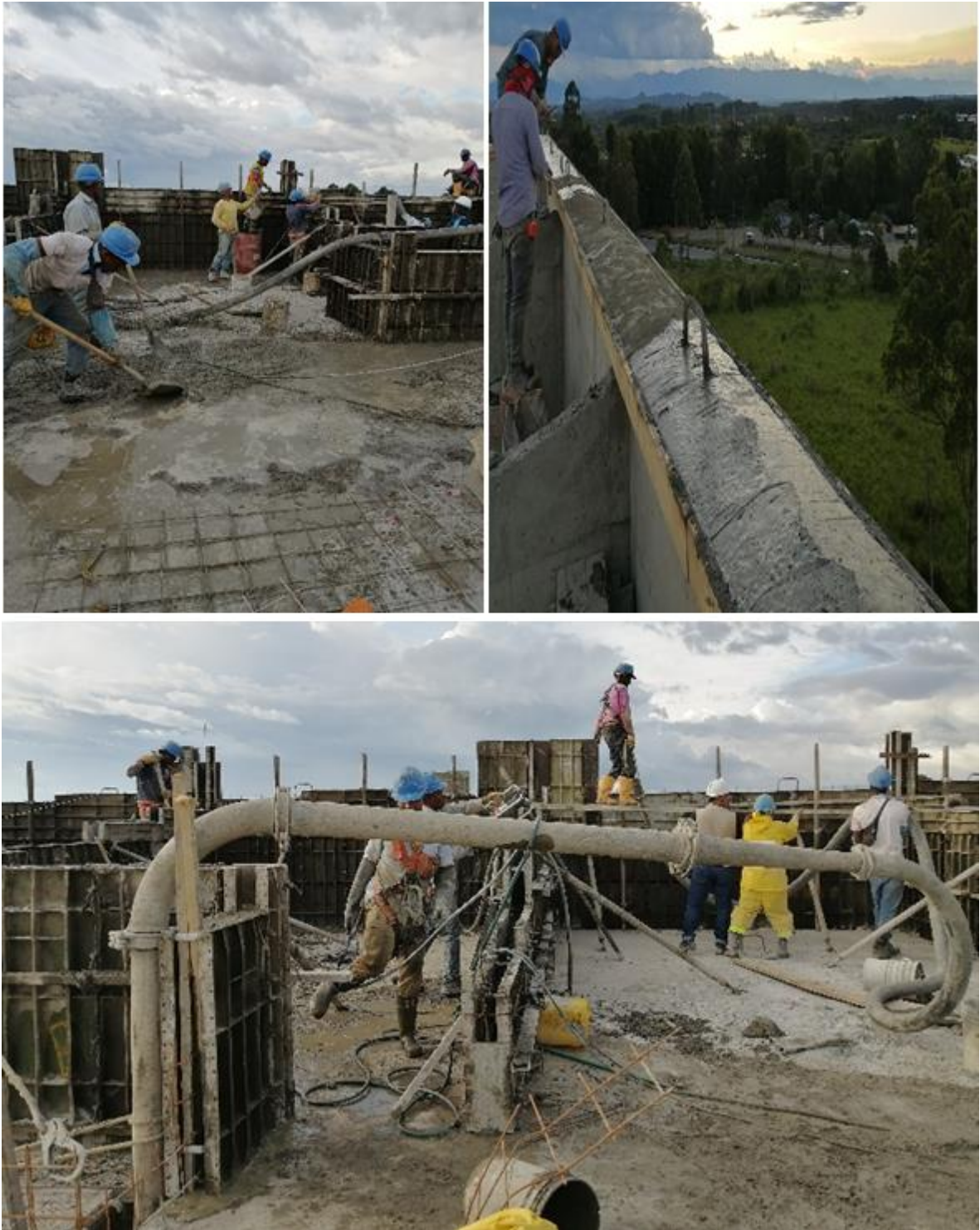
Ilustración 20. Fundición del ático
