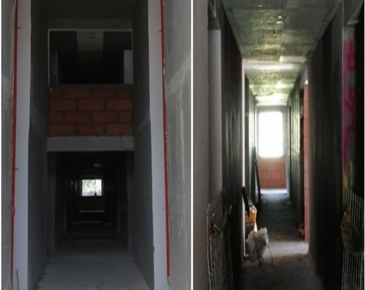
Ilustración 51. Muro de final de pasillo
