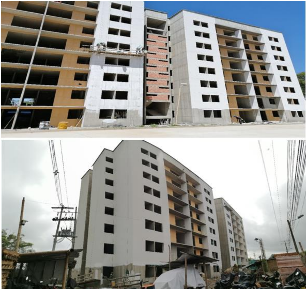
Ilustración 57. Regado de graniplast
