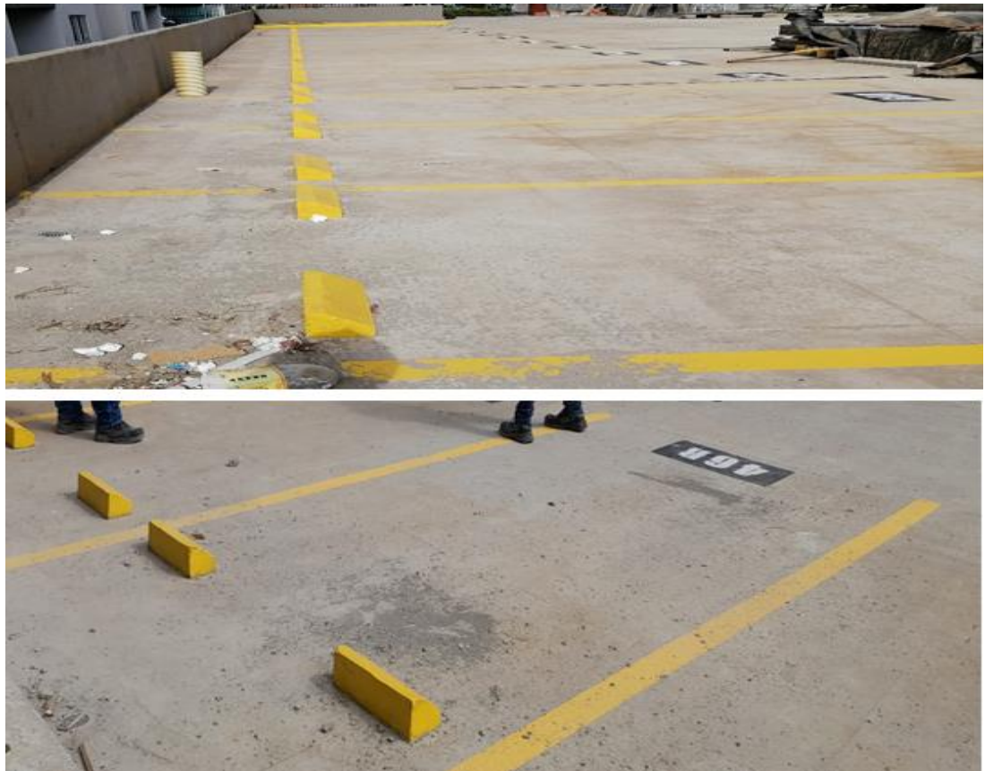
Ilustración 67. Zonas de parqueo
