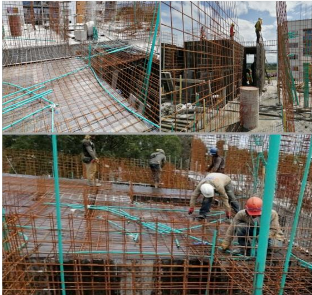
Ilustración 10. Actividades preliminares a la fundición
