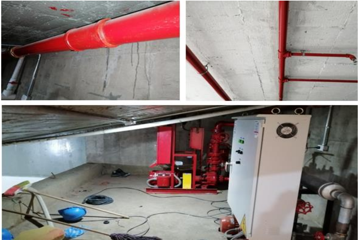
Ilustración 83. Pruebas de funcionamiento de la red contraincendios
