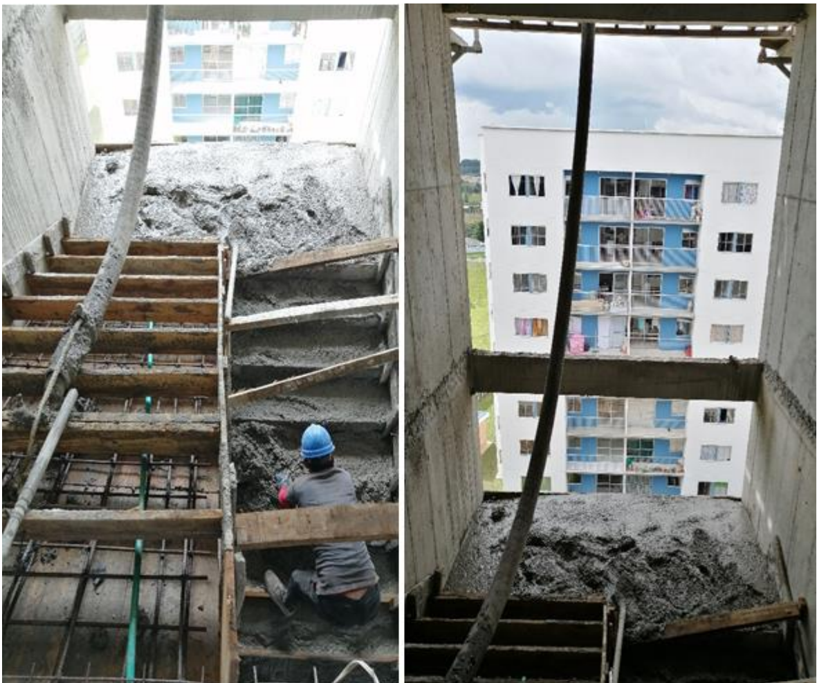
Ilustración 18. Fundición de gradas
