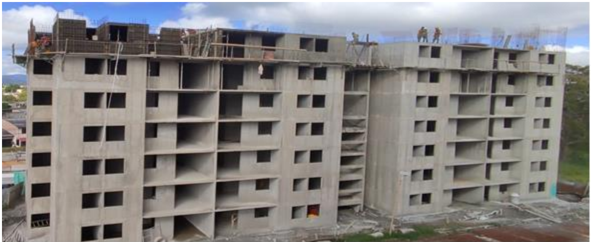
Ilustración 24. Avance de fundición 3
