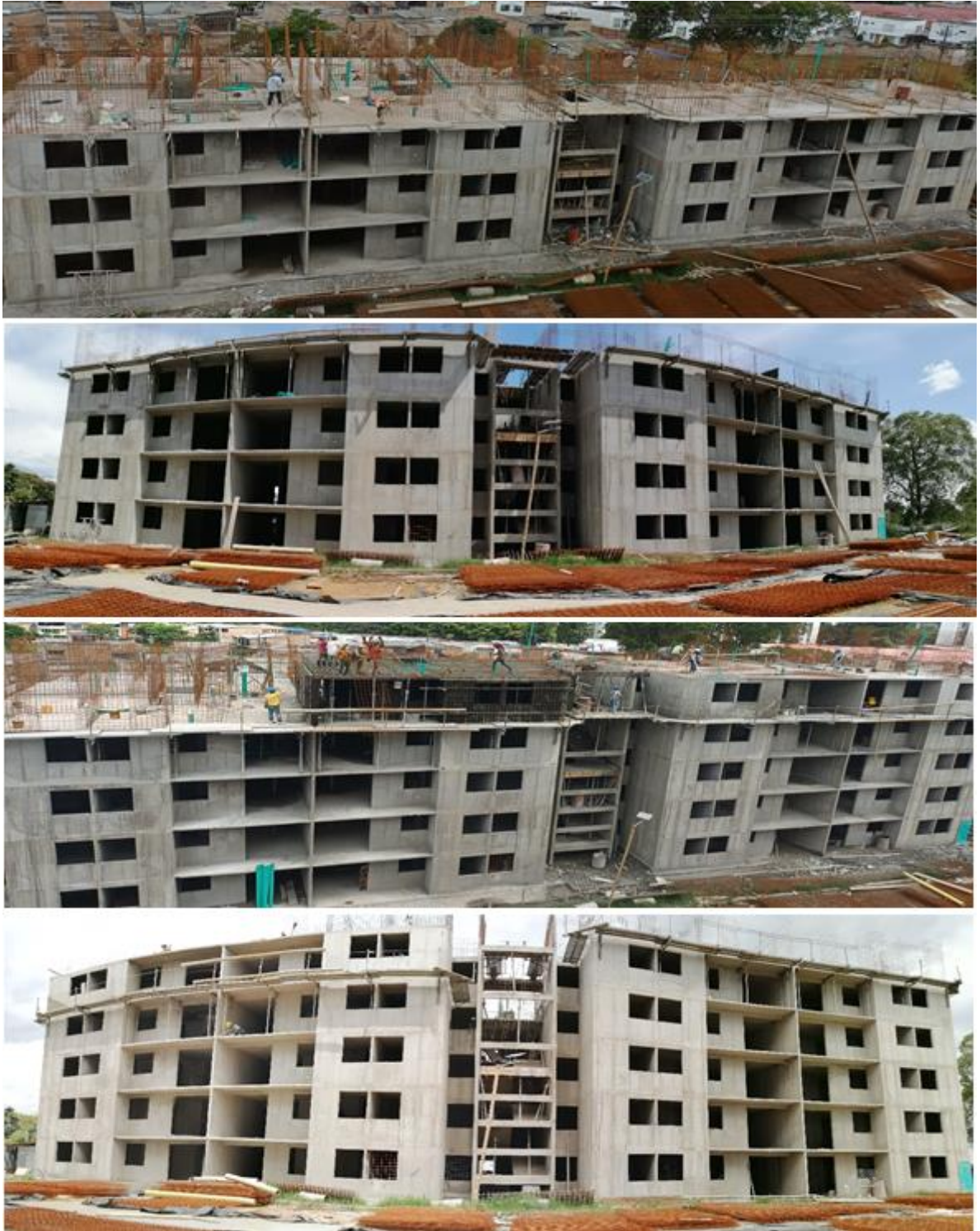
Ilustración 22. Avance de fundición 1
