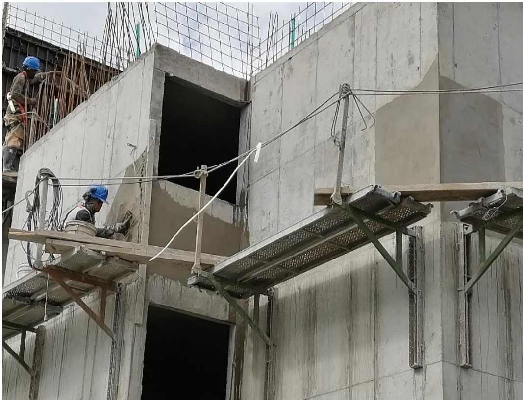
Ilustración 42. Resanes en el exterior de la torre
