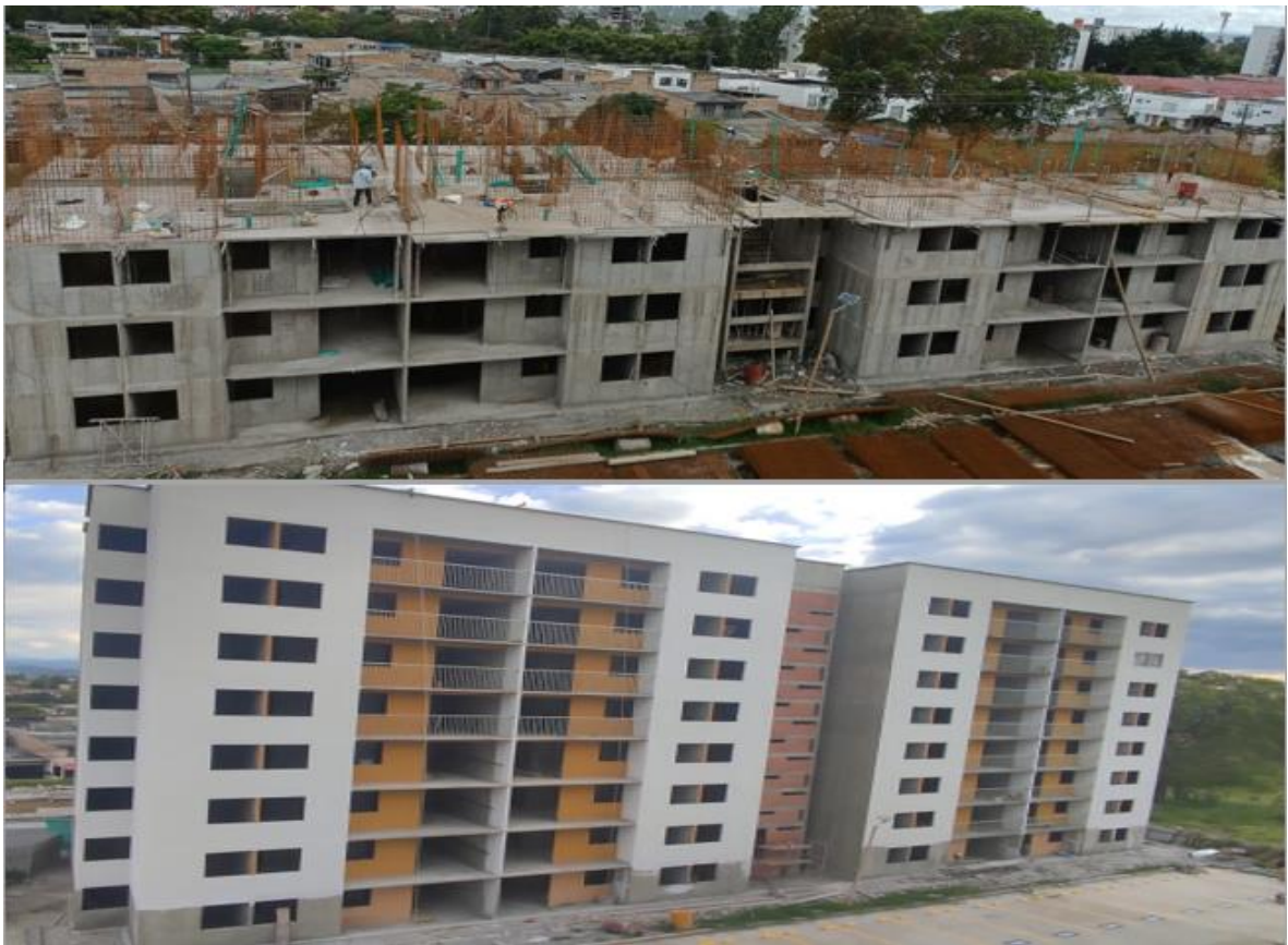
Ilustración 4. obra al inicio y final de las actividades
