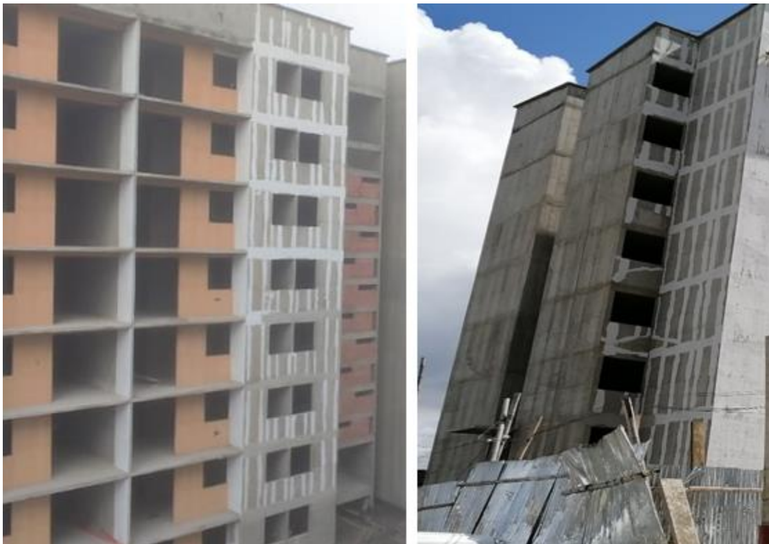
Ilustración 55. Impermeabilización de juntas
