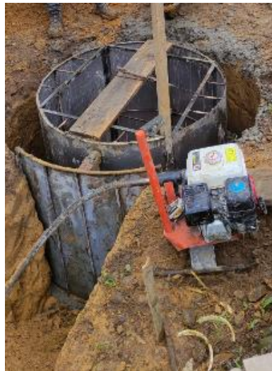
Ilustración 37. Encofrado con formaleta metálica
