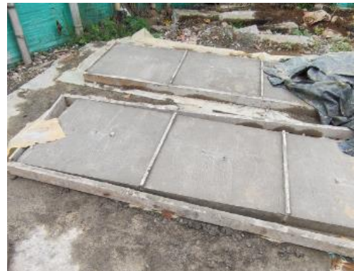
Ilustración 52. Fundición de tapas de cajas
