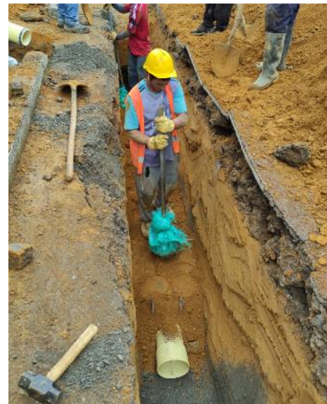
Ilustración 21. Relleno y compactación con pisón
