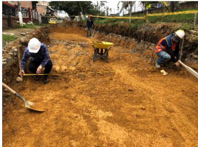
Ilustración 66. Chequeos en sub rasante
