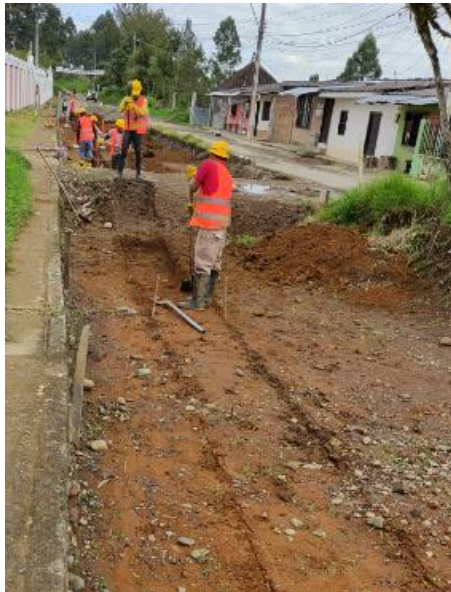
Ilustración 9. Trazado para excavación
