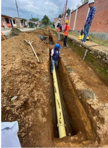
Ilustración 19. Instalación de tubería de red principal
