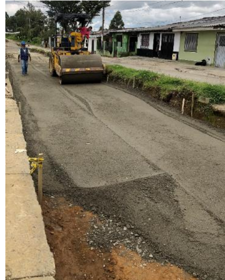
Ilustración 67. Compactación de capa subbase
