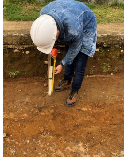
Ilustración 60. Verificación de subrasante en extremos con niveles en estacas
