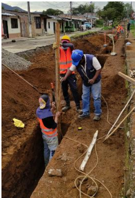
Ilustración 14. Verificación de pendiente de excavación
