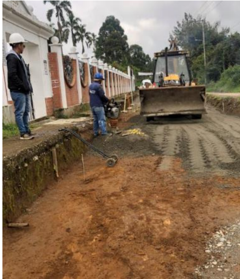
Ilustración 68. Extendido de material de subbase
