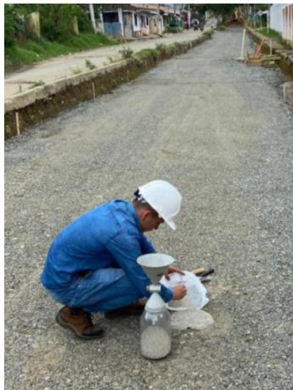
Ilustración 73. Ensayo de densidad, método cono y arena, capa subbase
