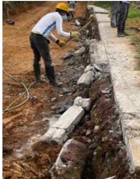
Ilustración 58. Demolición de anden
