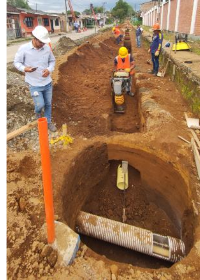
Ilustración 34. Excavación recamara
