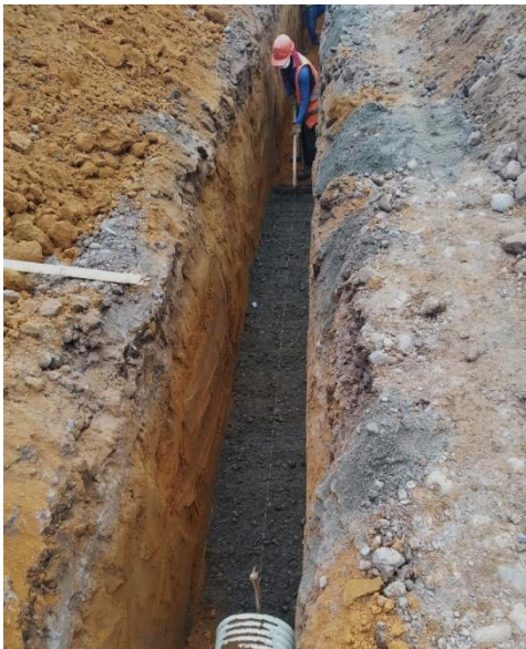
Ilustración 17. Conformación de encamado de arena
