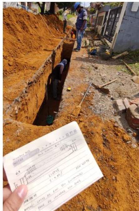
Ilustración 13. Revisión de cotas y pendientes de excavación.
