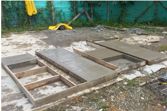
Ilustración 53. Elaboración de moldes para tapas de cajas
