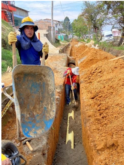
Ilustración 22. Relleno lateral del tubo con arena
