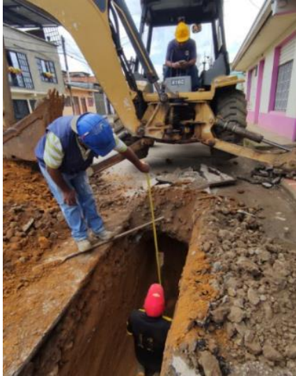
Ilustración 16. Control de profundidad de excavación
