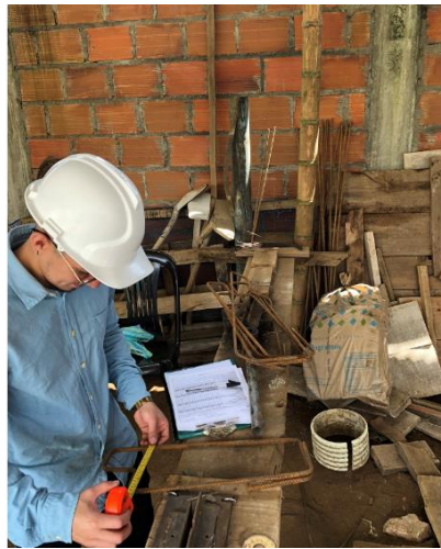
Ilustración 47. Control de acero
