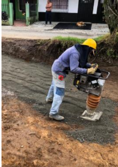
Ilustración 64. Mejoramiento de zonas de subrasante
