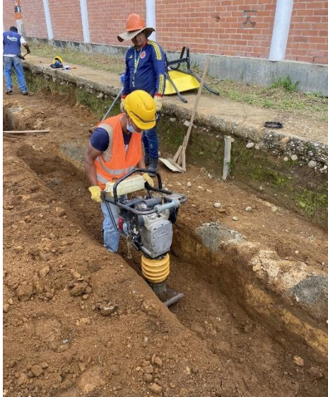
Ilustración 24. Compactación mecánica con saltarín
