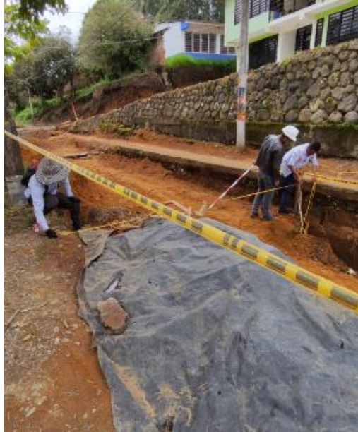
Ilustración 8. Chequeo de puntos y dimensiones.
