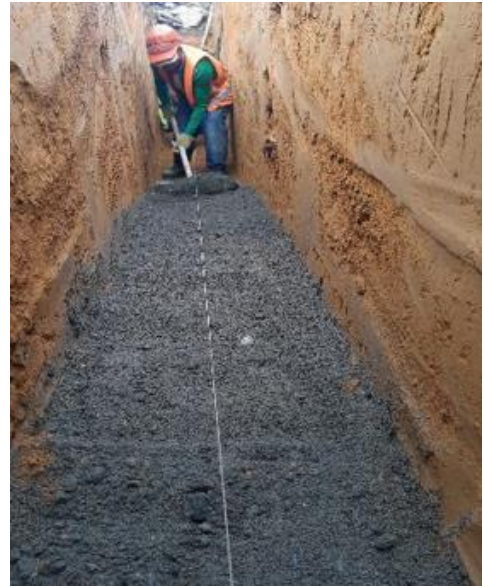
Ilustración 18. Extendido encamado de arena
