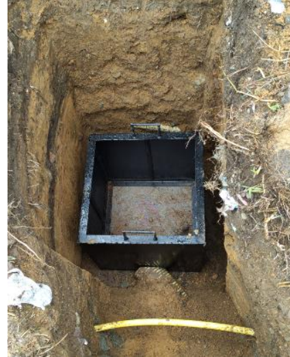
Ilustración 30. Encofrado con molde metálico
