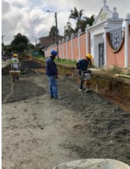
Ilustración 71. Compactación de bordes de carril
