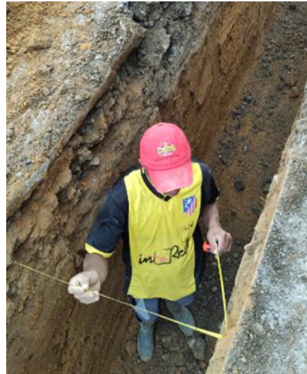
Ilustración 15. Verificación de ancho de excavación
