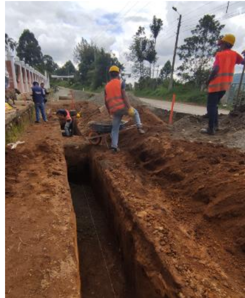
Ilustración 10. Excavación manual para red sanitaria
