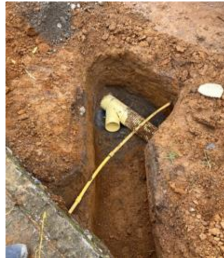
Ilustración 26. Instalación de silla Yee
