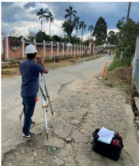
Ilustración 7. Localización y ajuste de puntos en el terreno
