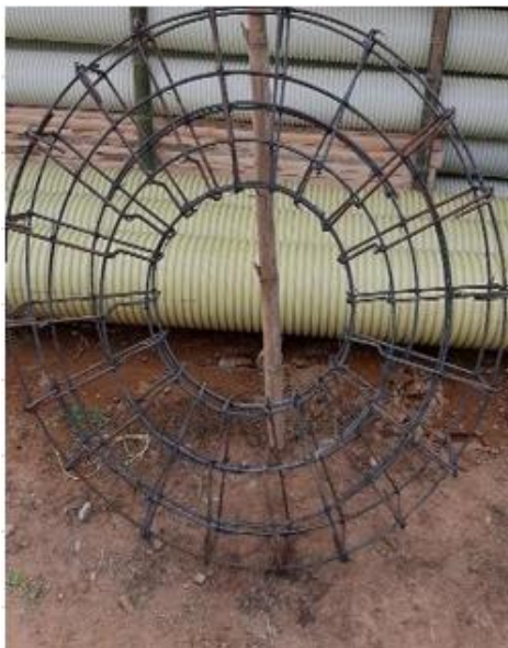
Ilustración 46. Refuerzo para tapa de cámara de inspección
