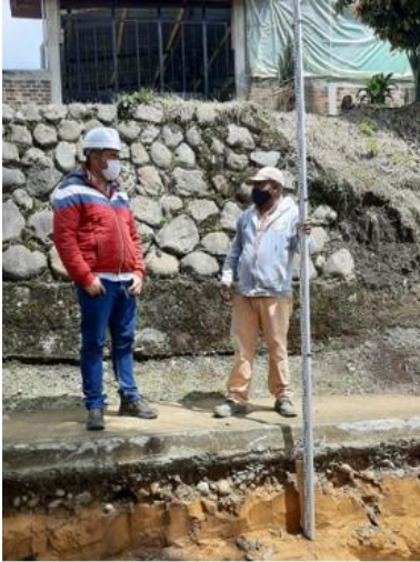
Ilustración 61. Rectificación de puntos de subrasante
