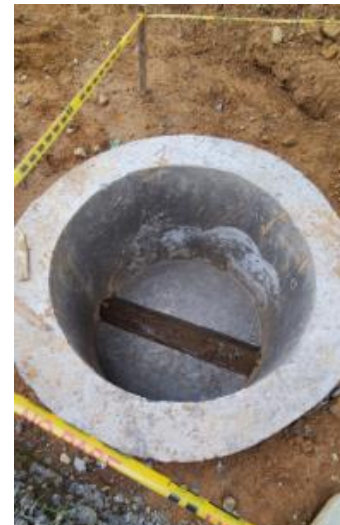
Ilustración 36. Fundición cámara de inspección
