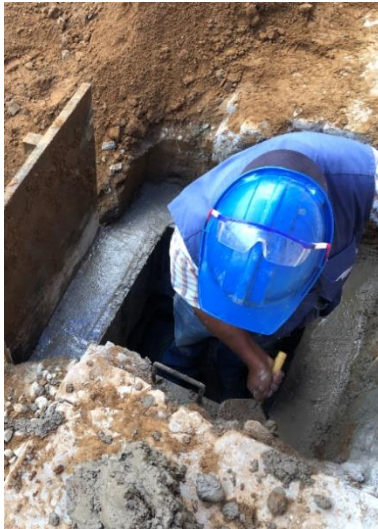
Ilustración 31. Fundición y acabado de caja
