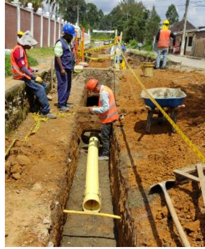
Ilustración 20. Verificación de alineamiento con plomada
