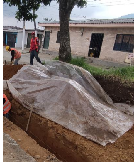
Ilustración 23. Control de material de relleno
