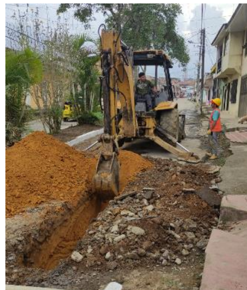
Ilustración 12. Excavación mecánica para red sanitaria
