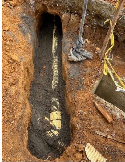
Ilustración 28. Instalación y relleno de tubería para acometida
