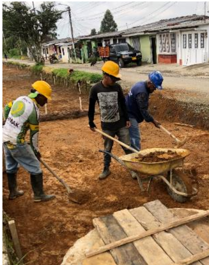
Ilustración 63. Perfilado de superficie.
