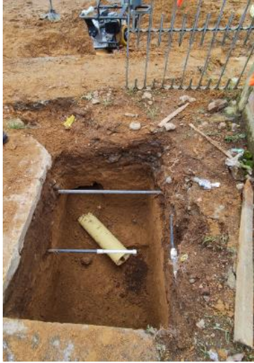
Ilustración 29. Excavación para caja de inspección
