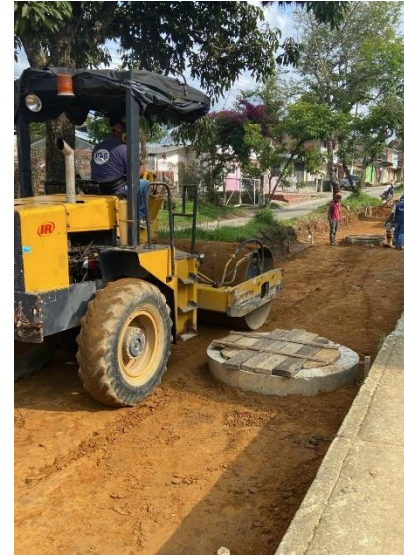
Ilustración 65. Compactación de subrasante
