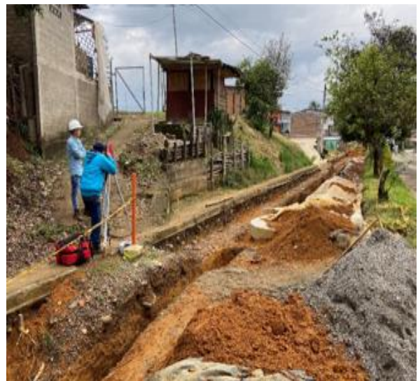
Ilustración 6. Verificación de coordenadas
