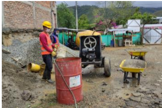
Ilustración 38. Dosificación de concreto
