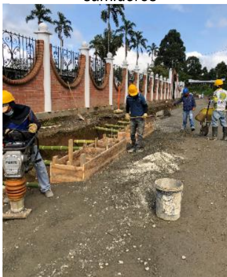
Ilustración 70. Compactación y mejoramiento de bordes de sumideros
