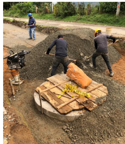
Ilustración 69. Mejoramiento de bordes de recamaras
