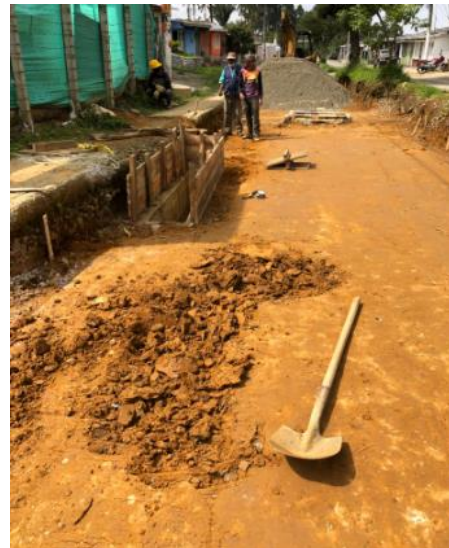
Ilustración 62. Retiro de material no deseado
