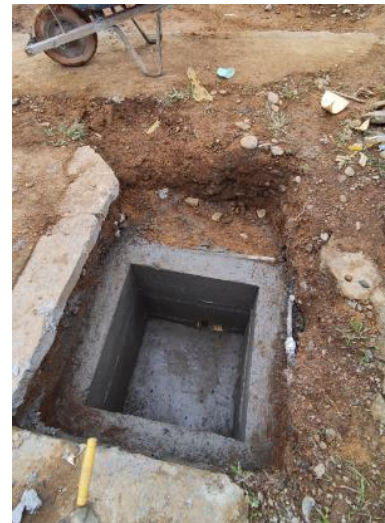
Ilustración 32. Fundición caja
