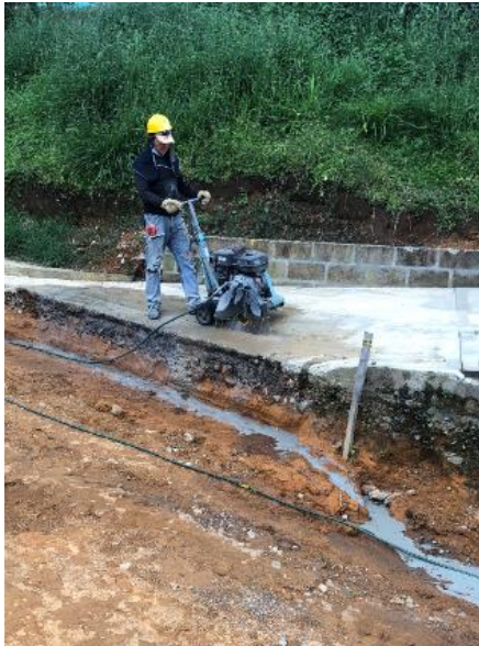
Ilustración 59. Corte de anden con cortadora industrial
