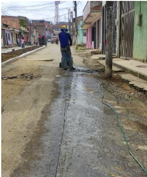
Ilustración 11. Demarcación y corte de pavimento
