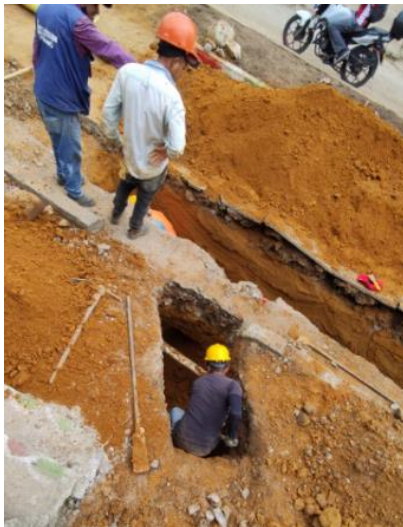
Ilustración 27. Excavación para acometida domiciliaria
