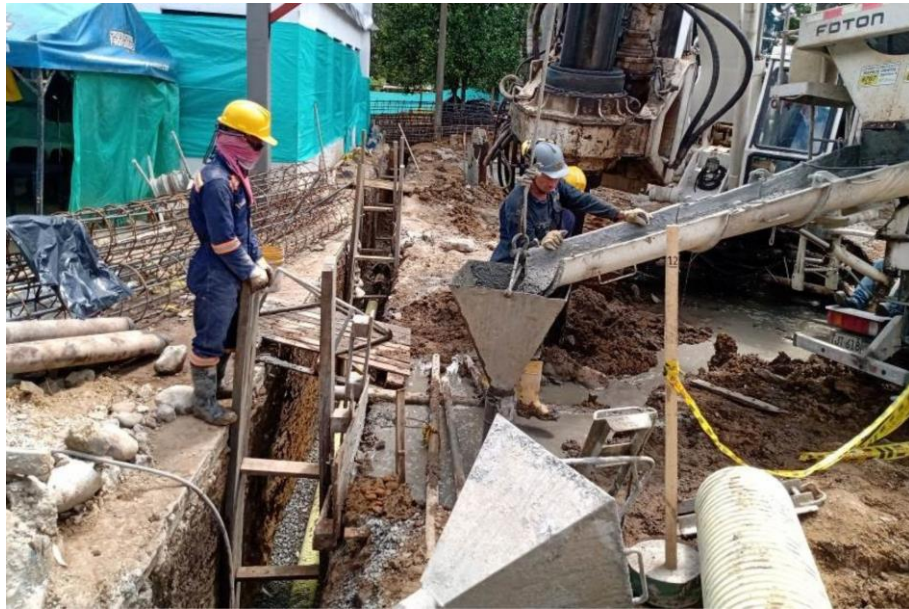
Ilustración 40. Fundición de pilotes sistema Tremie
