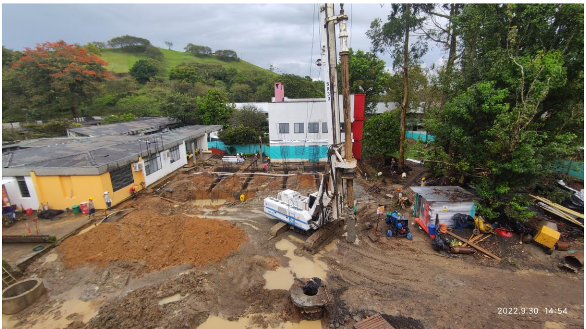
Ilustración 59. Panorámica sitio de obra y estado septiembre
