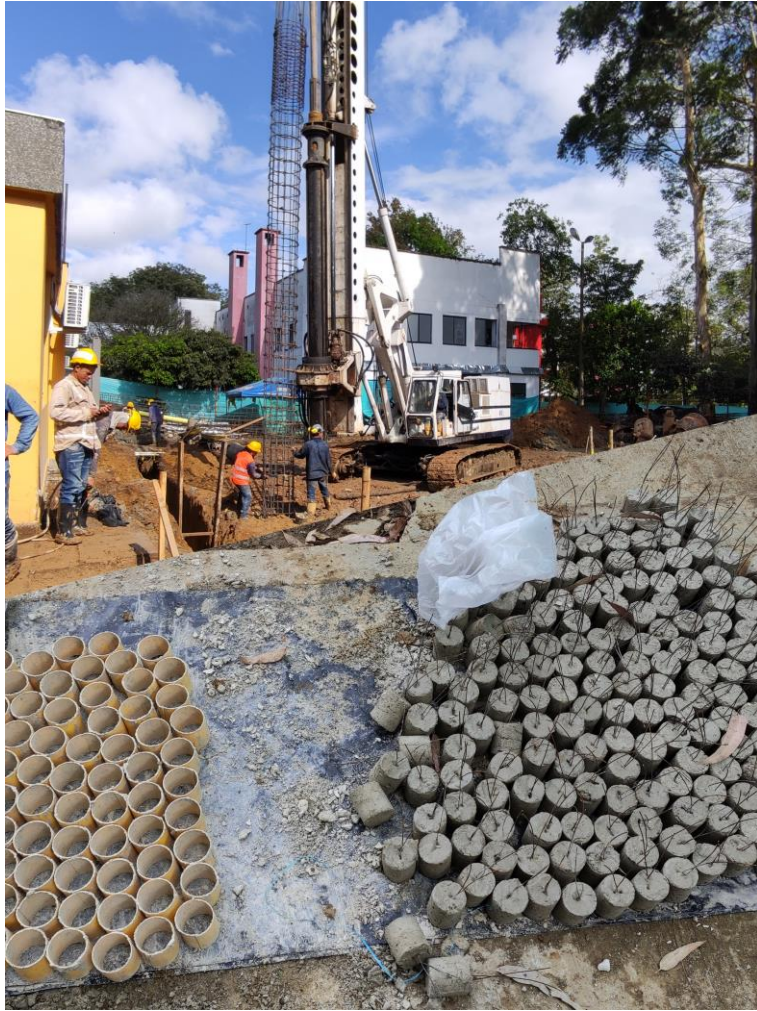
Ilustración 38. Colocación de canastilla y separadores
