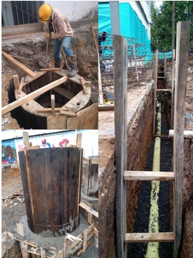
Ilustración 33. Inspección a construcción del alcantarillado julio
