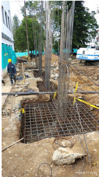
Ilustración 58. Armado de dados, columnas y vigas de cimentación
