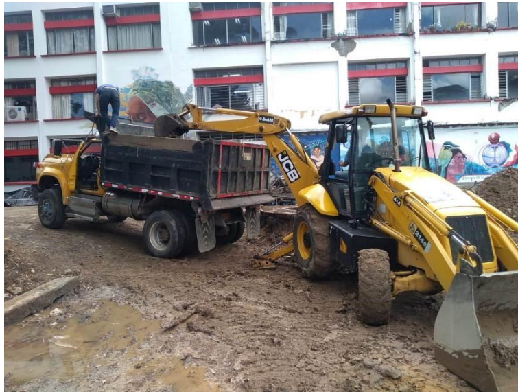
Ilustración 29. Retroexcavadora realizando labores de cargue de material sobrante
