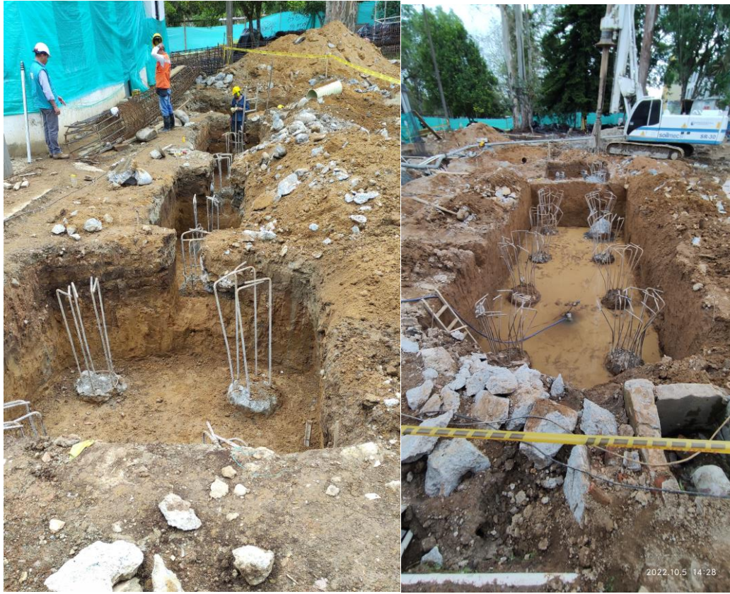
Ilustración 52. Descabece de pilotes
