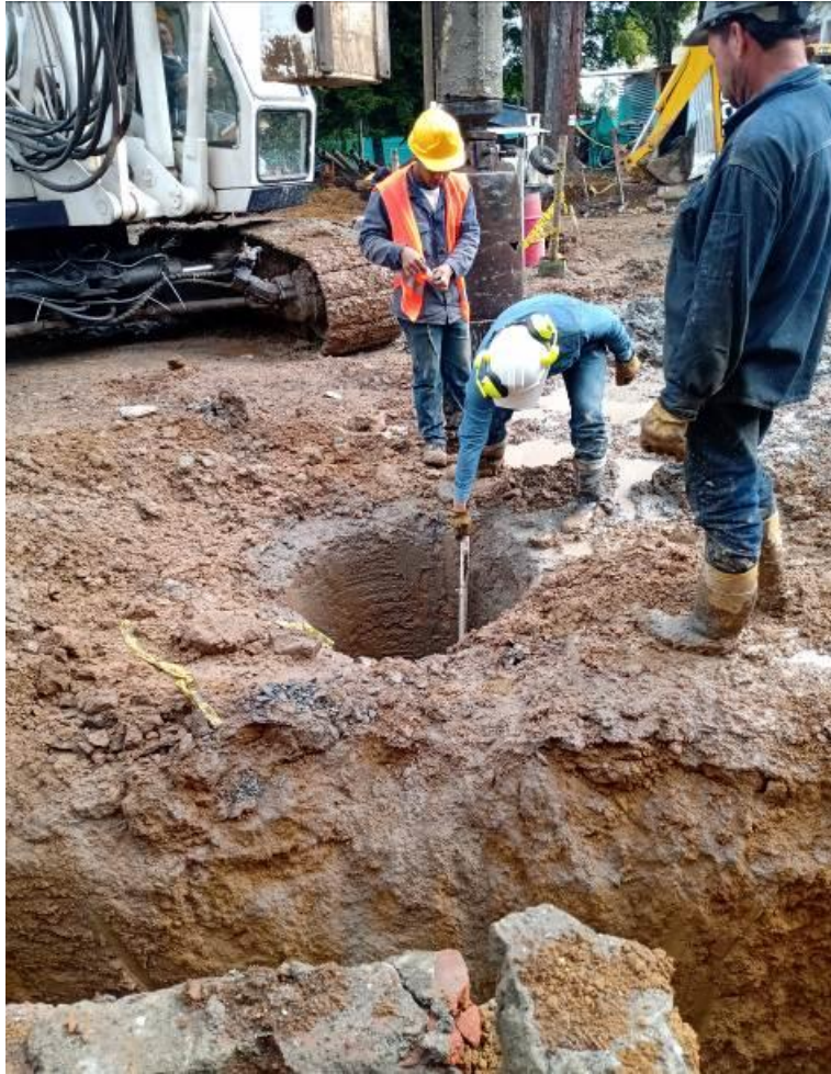
Ilustración 37. Comprobación de profundidad de pilotes
