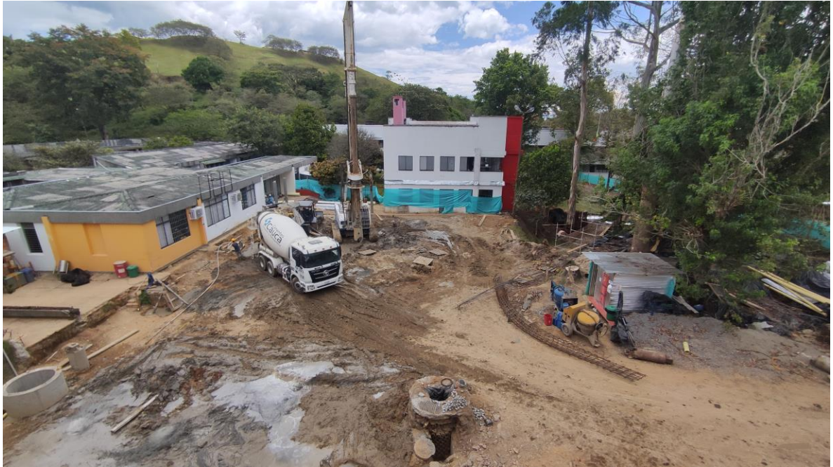
Ilustración 48. Panorámica sitio de obra y estado agosto
