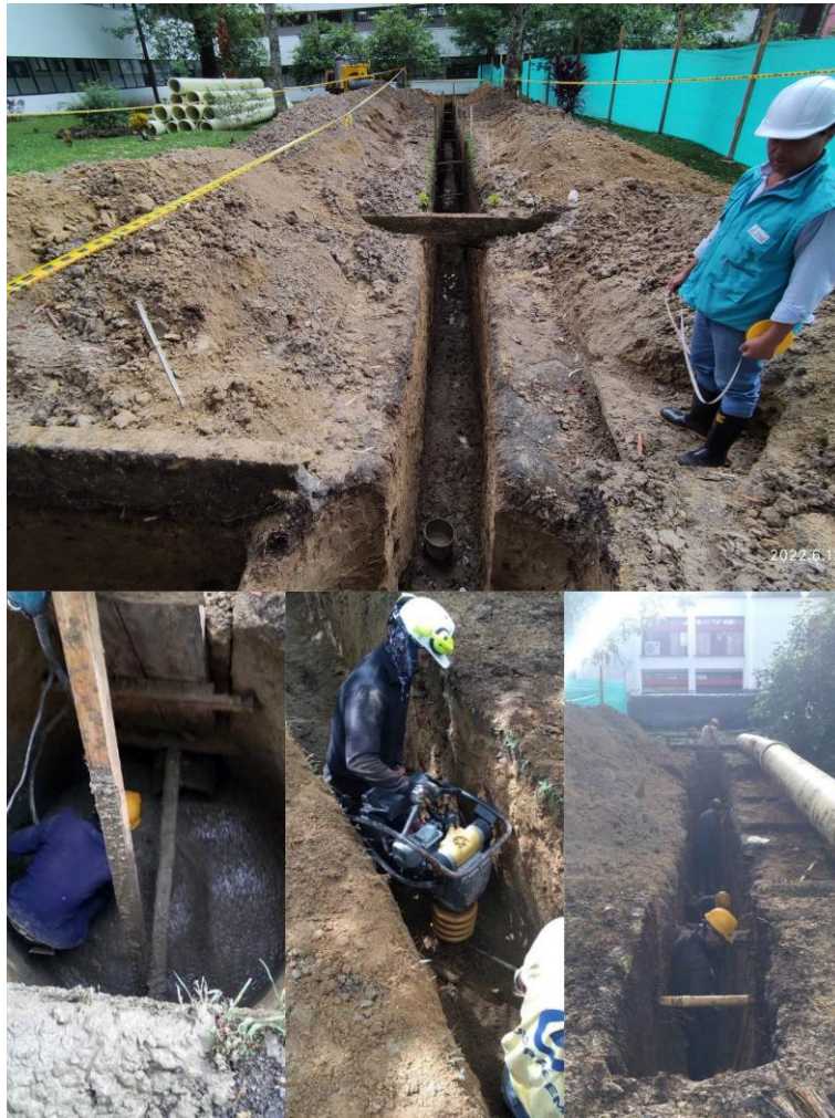
Ilustración 25. Inspección a construcción del alcantarillado junio
