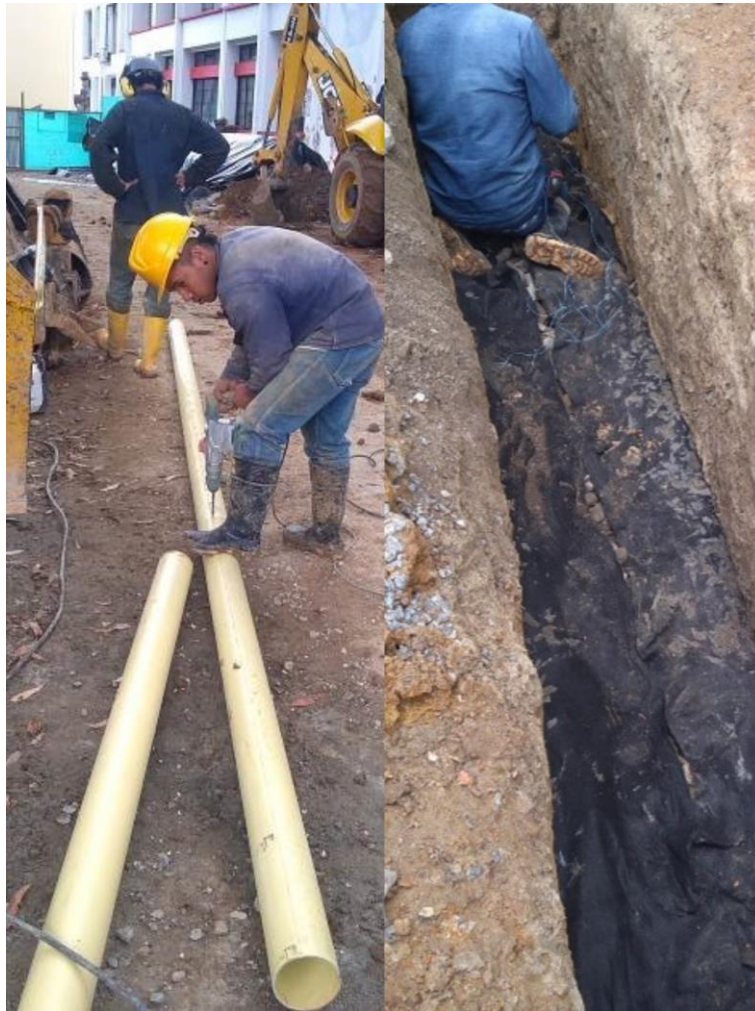
Ilustración 34. Instalación de filtro francés
