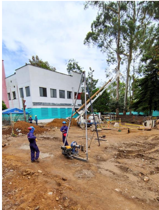
Ilustración 28. Realización de sondeos
