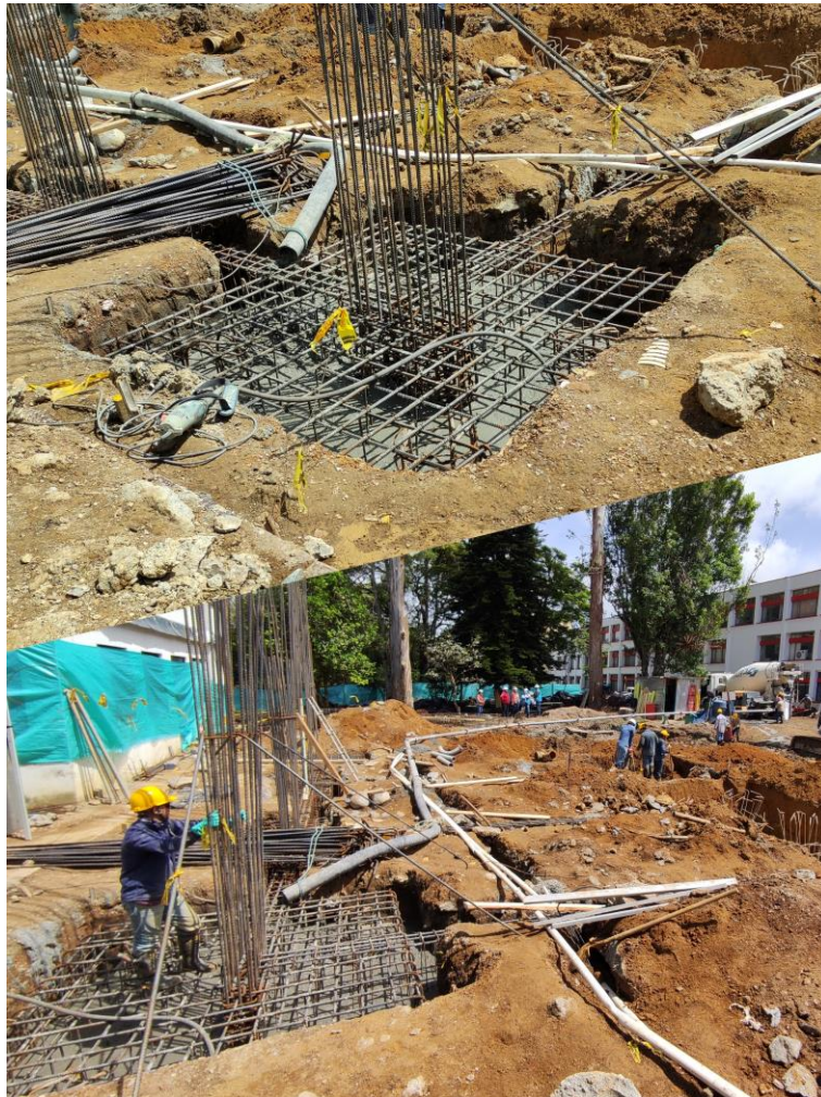
Ilustración 62. Fundición de dado con bomba estacionaria
