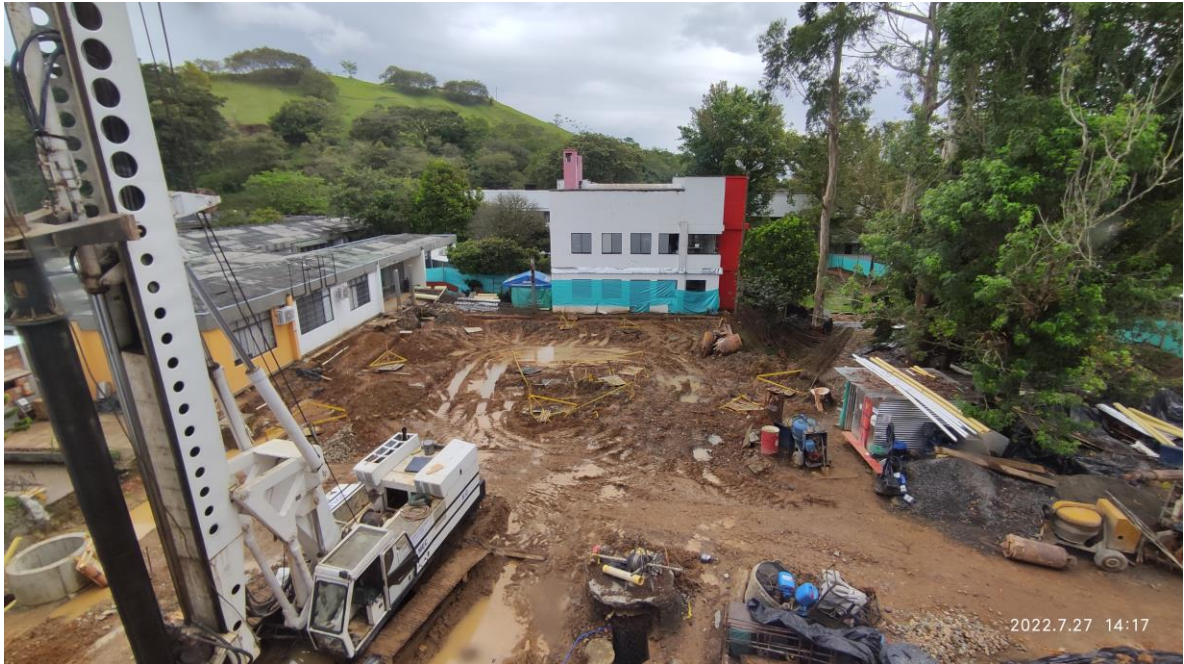
Ilustración 42. Panorámica sitio de obra y estado julio
