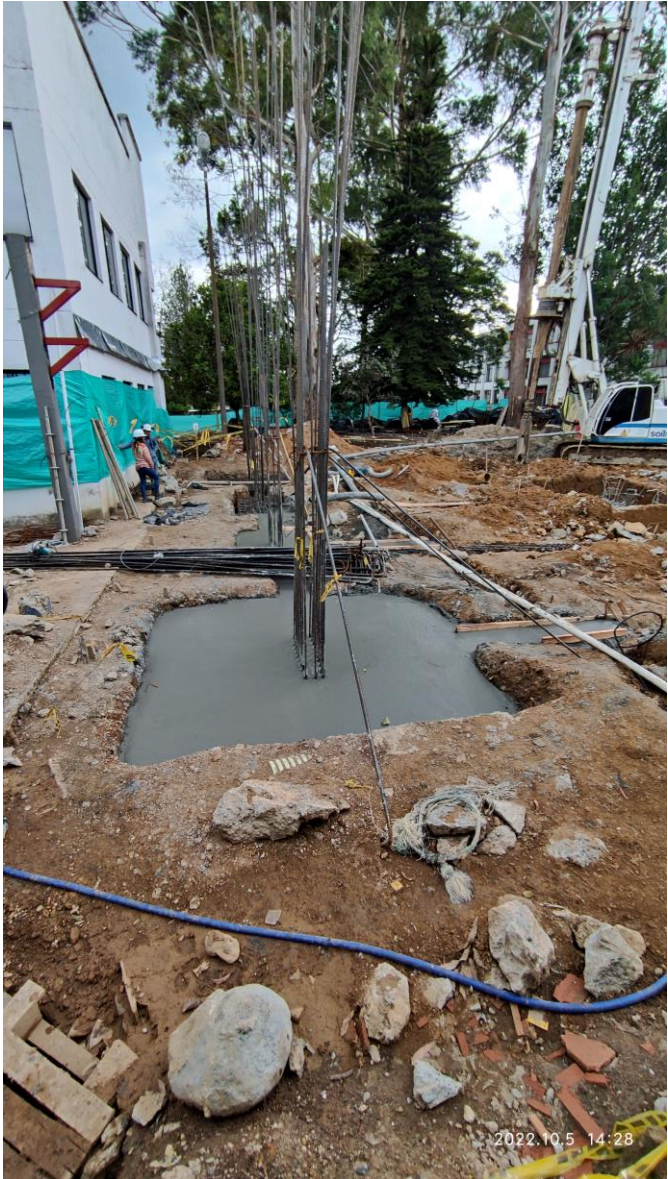
Ilustración 63. Dados eje 1 (A-D) fundidos
