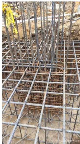
Ilustración 57. Armadura interna en dados
