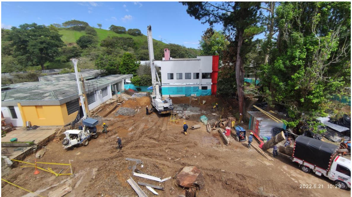
Ilustración 30. Panorámica sitio de obra y estado junio
