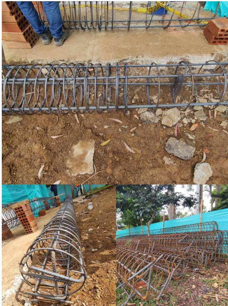
Ilustración 23. Armado de canastillas para pilotes
