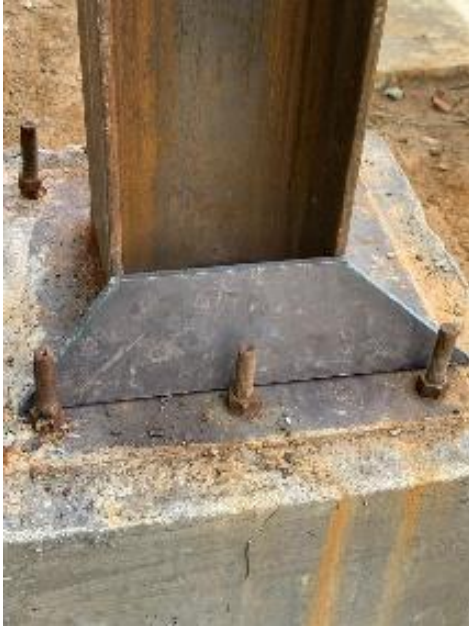
Figura 16. Instalación y anclaje para las columnas en las platinas
