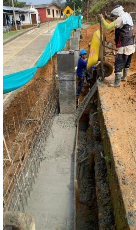
Figura 10. Vaciado de concreto para muro de cimentación, vibrado y nivelado
