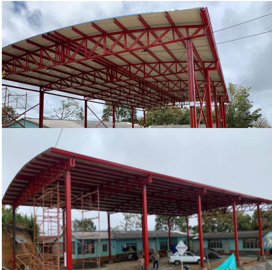
Figura 22. Instalación de teja trapezoidal para cubierta
