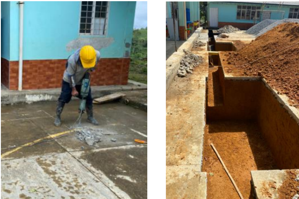
Figura 3. Corte de losa y excavación para cimentación
