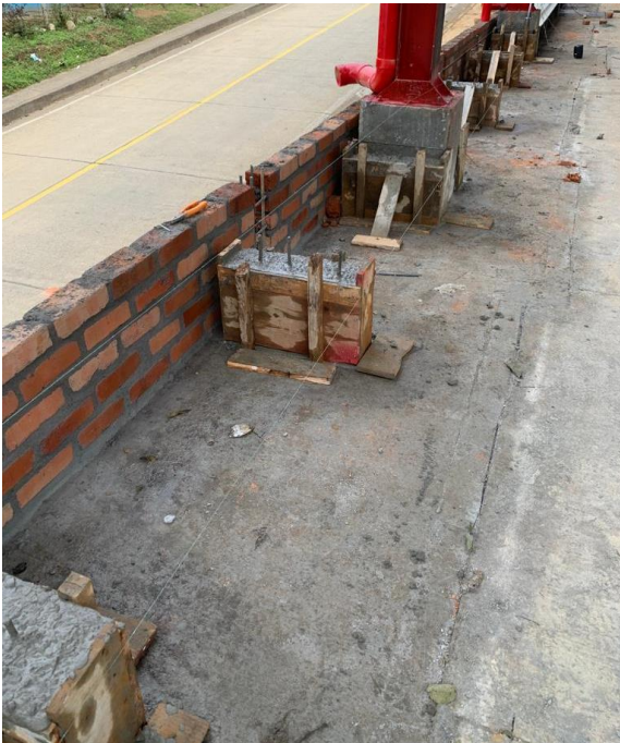
Figura 13. Construcción de la banca en concreto para el polideportivo
