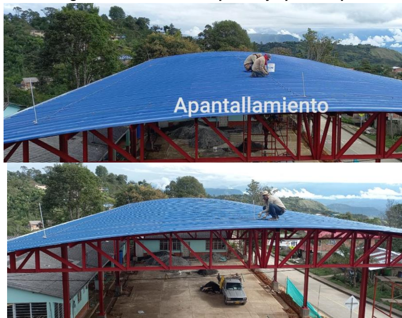
Figura 24. Instalación de pararrayo punta captora
