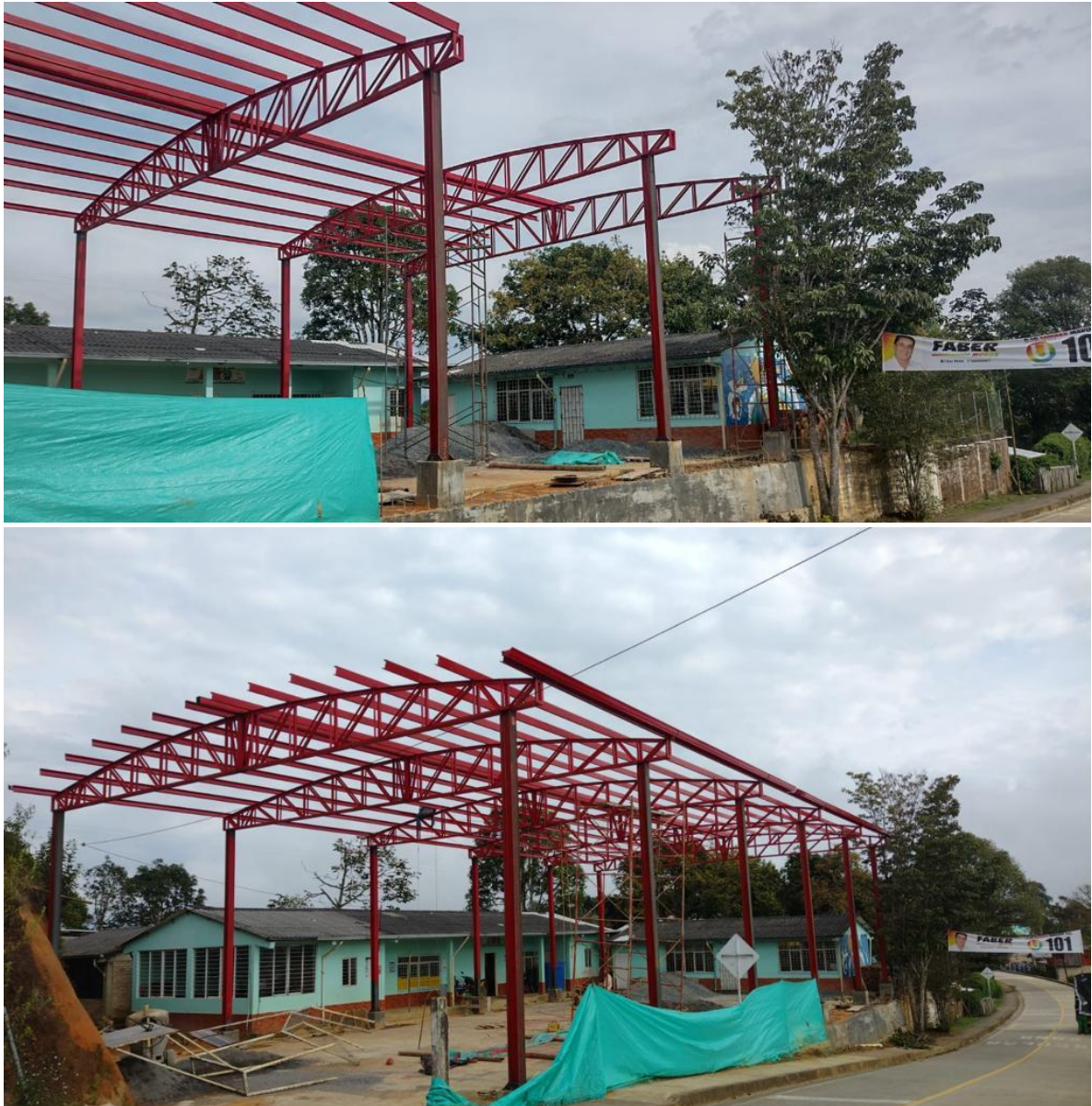
Figura 17. Instalación de cercha superior y correas
