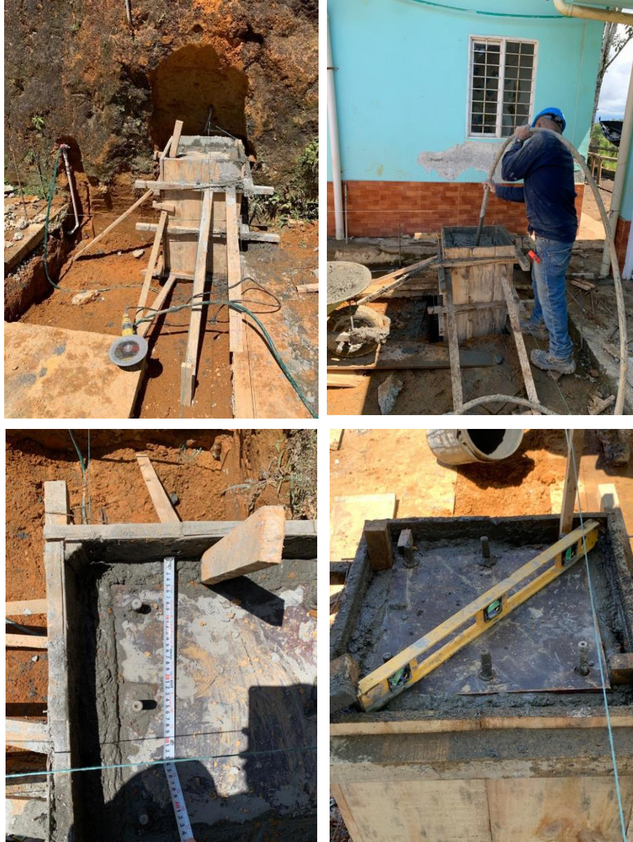
Figura 8. Vaciado de concreto para pedestales, vibrado y nivelado
