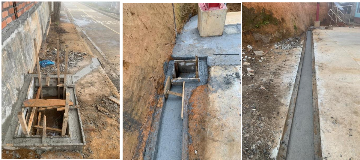
Figura 20. Construcción de cajas de inspección y canal en concreto.
