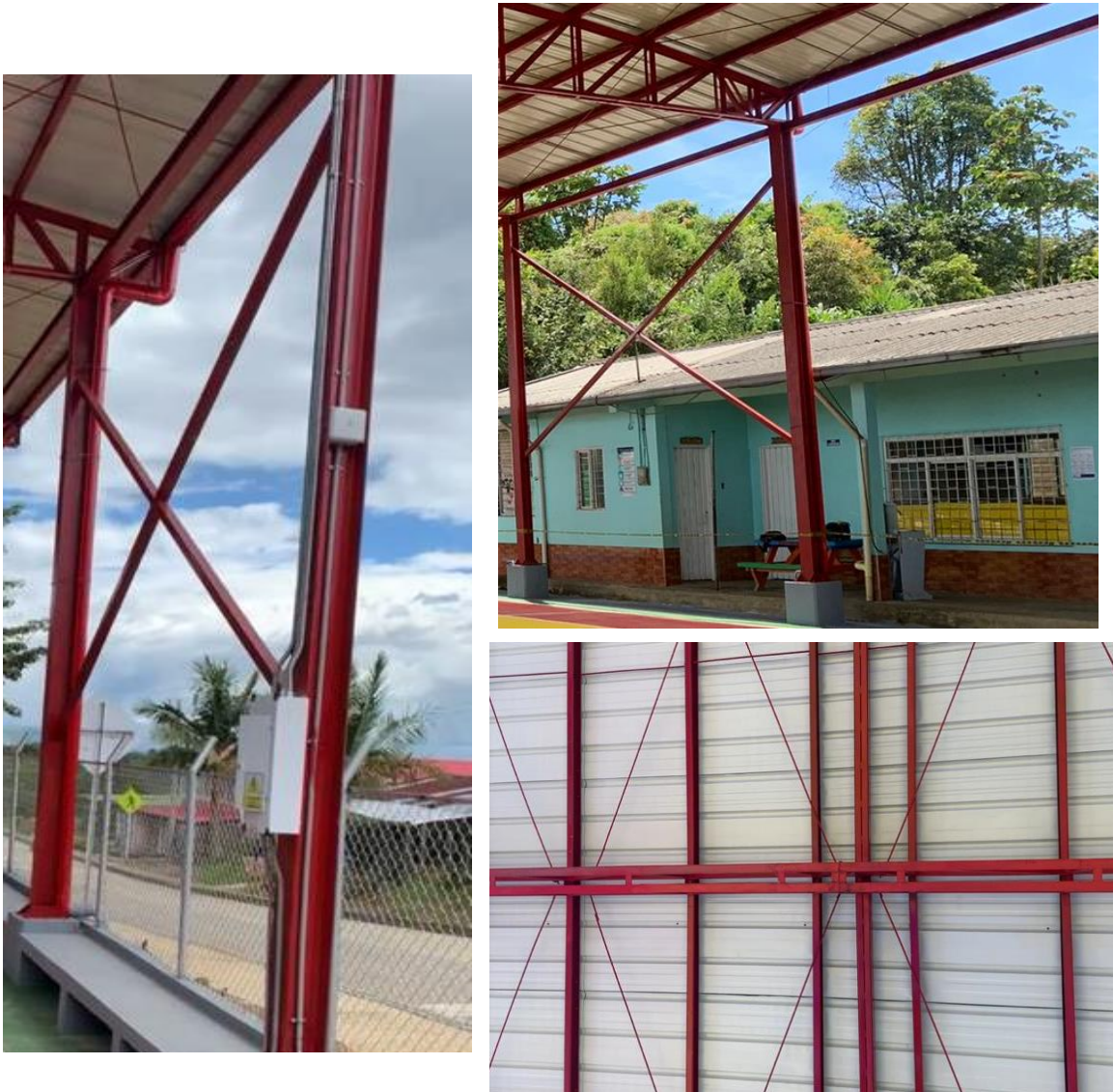
Figura 18. Instalación vigas de rigidez, arriostradores y contravientos
