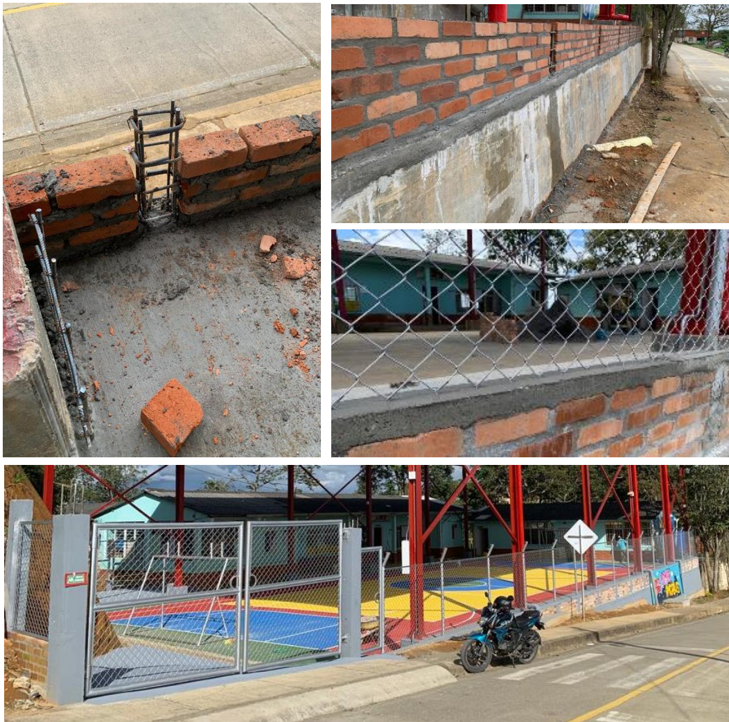
Figura 19. Construcción de cerramiento, viga muro, columneta, alfajía, instalación de malla electrosoldada y tubo galvanizado redondo
