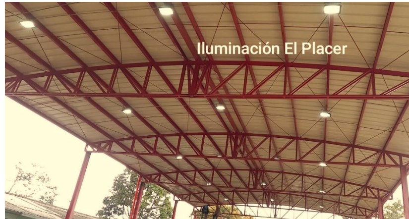
Figura 23. Tablero de distribución e instalación de reflectores led de 200 w
