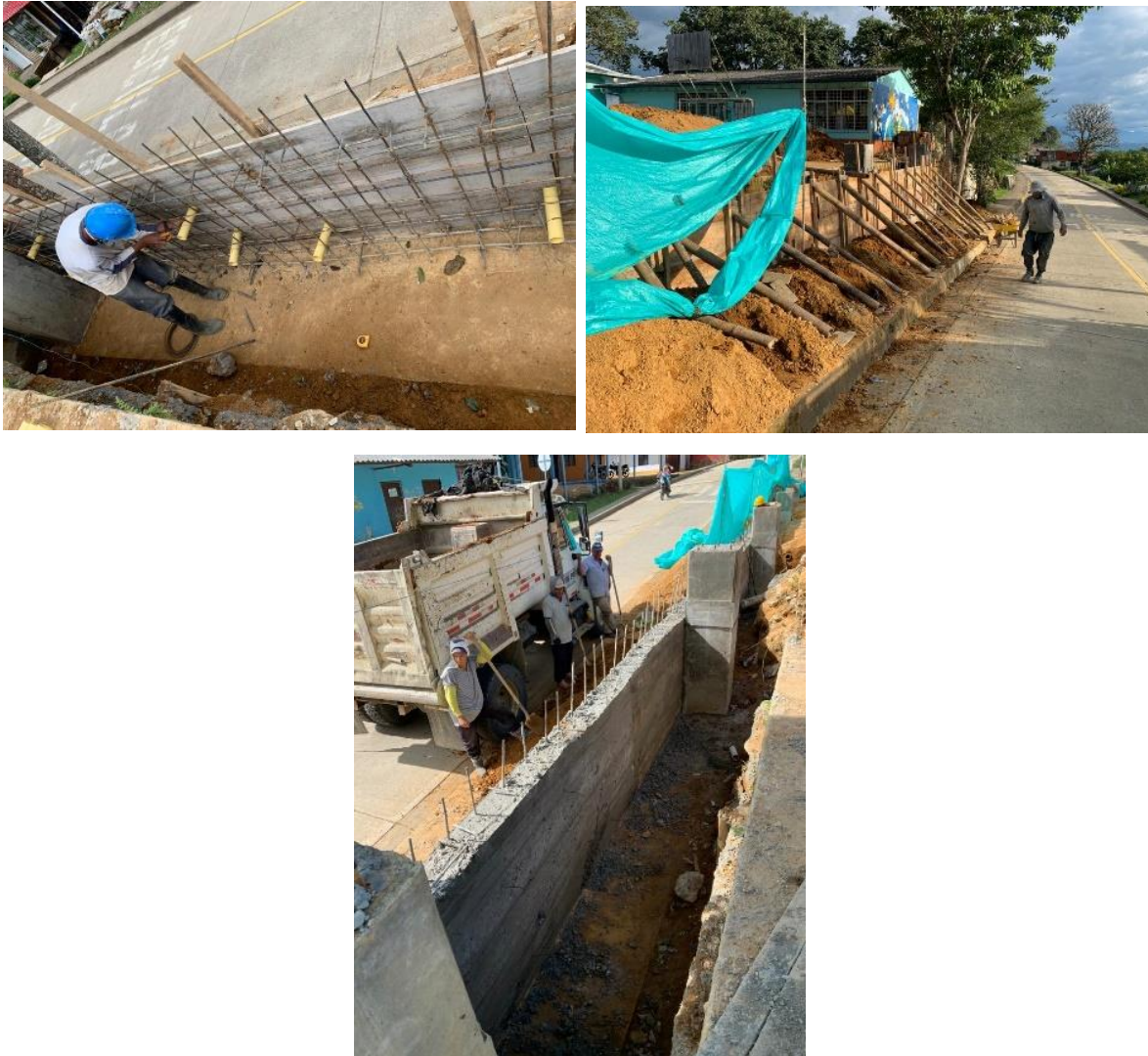
Figura 11. Vaciado de concreto para muro de cimentación, vibrado y nivelado
