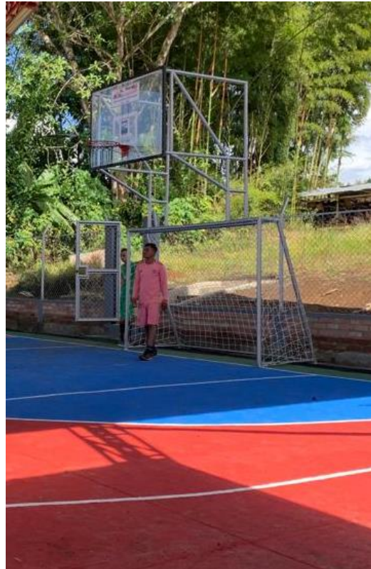
Figura 27. Suministro de cancha multifuncional
