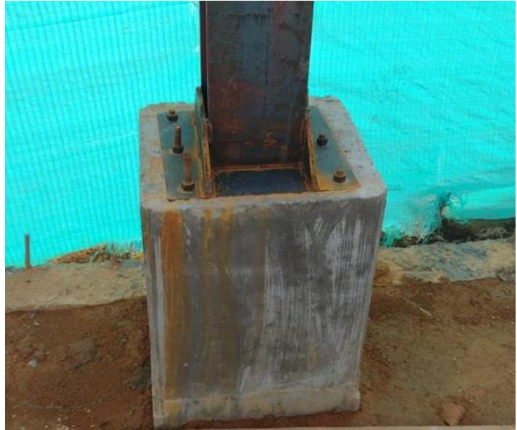
Figura 16. Instalación y anclaje para las columnas en las platinas
