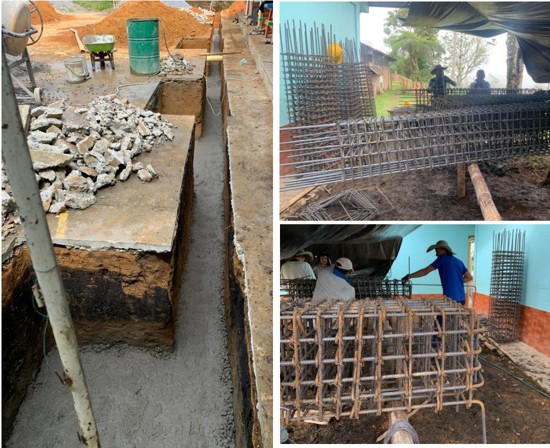
Figura 5. Solado para cimentación y flejado de acero
