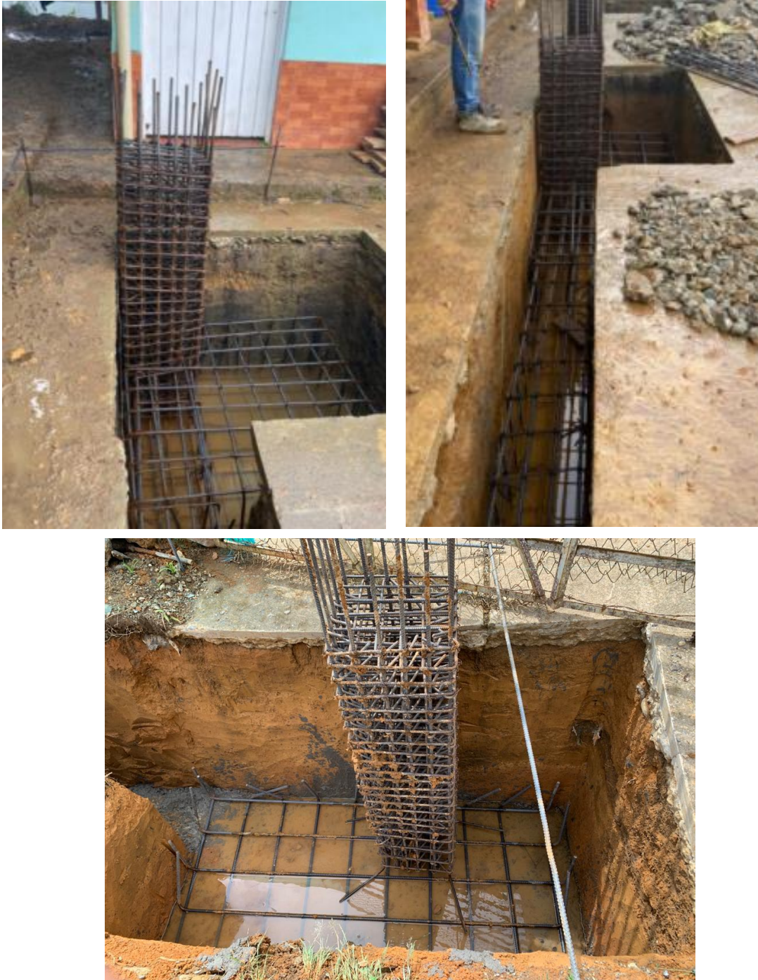
Figura 6. Acomodo de castillos sobre solados
