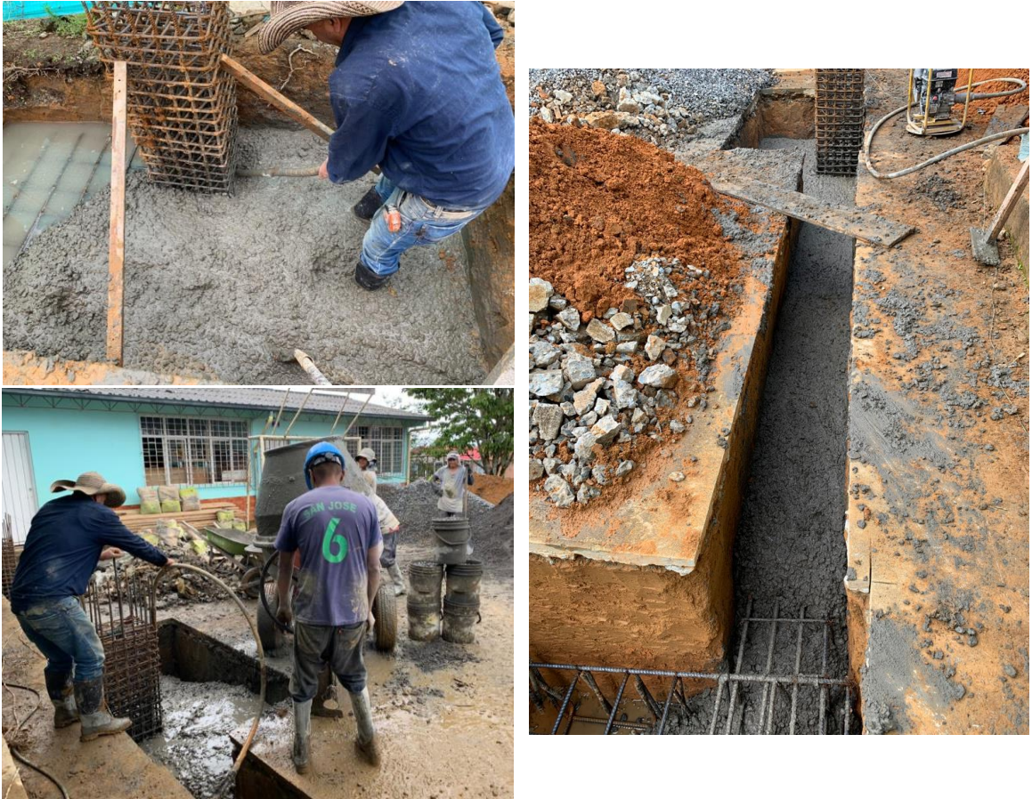
Figura 7. Vaciado de concreto para zapatas y vigas con su respectivo vibrado
