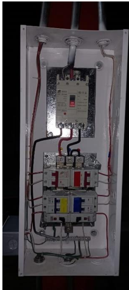
Figura 23. Tablero de distribución e instalación de reflectores led de 200 w
