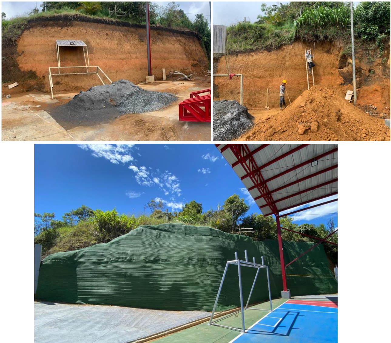
Figura 4. Perfilación de talud e instalación de geomembrana
