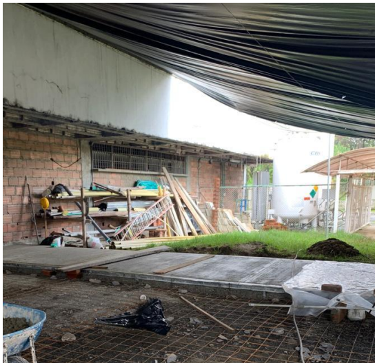
Figura 41. Foto Supervisión de obra para habilitación de los servicios (parqueadero)
