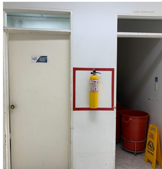
Figura 33.Foto registro de cuarto de aseo.
