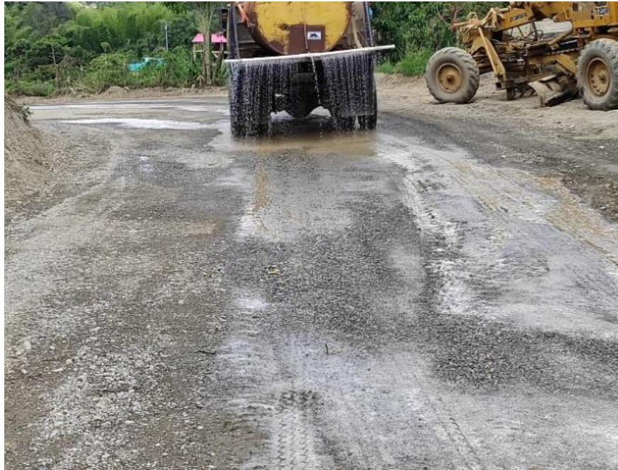
Ilustración 22. Humectación del material de base
