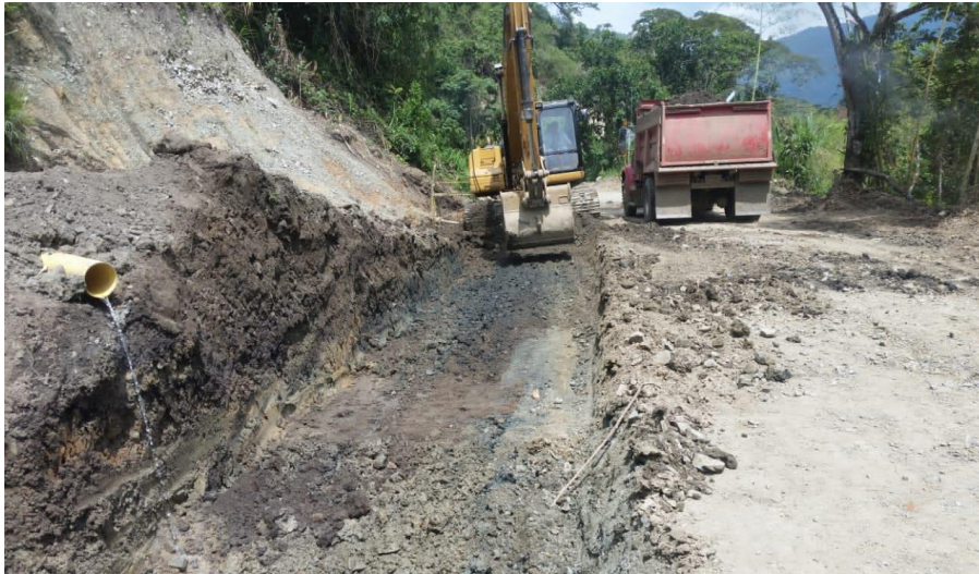
Ilustración 12. Escarificación con retroexcavadora
