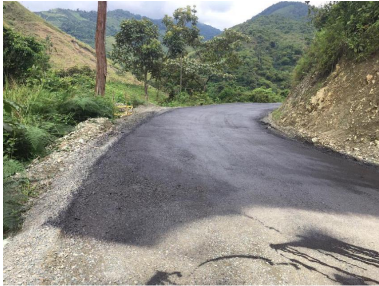
Ilustración 25. Emulsión sobre la superficie de la capa de base
