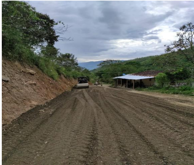
Ilustración 19. Compactación del material de subbase
