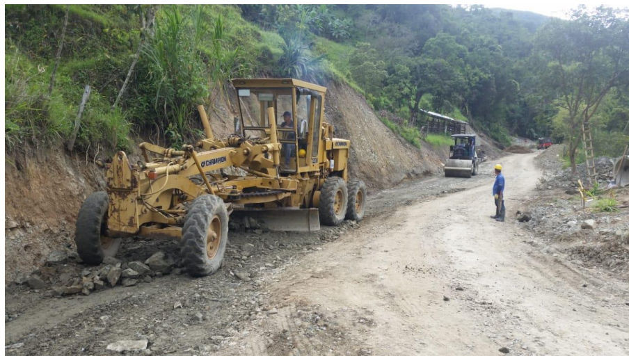
Ilustración 15. Nivelación con motoniveladora
