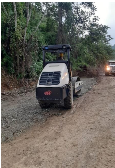
Ilustración 17. Compactación de la subrasante
