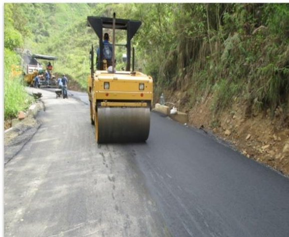
Ilustración 30. Compactación sobre la junta longitudinal
