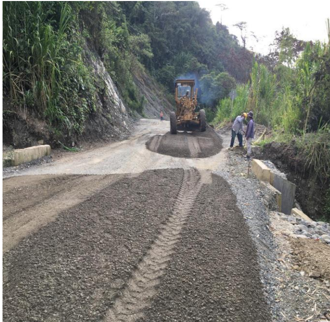
Ilustración 18. conformación de la capa subbase con motoniveladora
