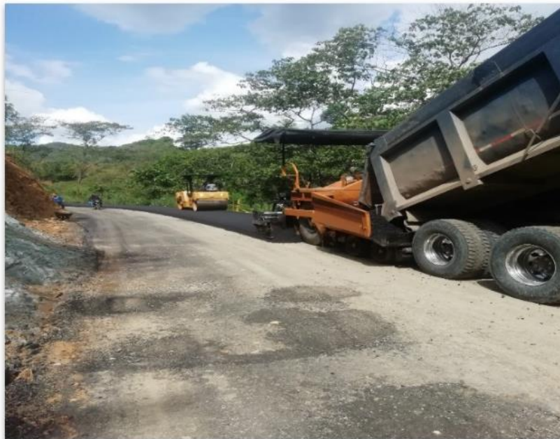
Ilustración 26. Colocación del material bituminoso con finisher
