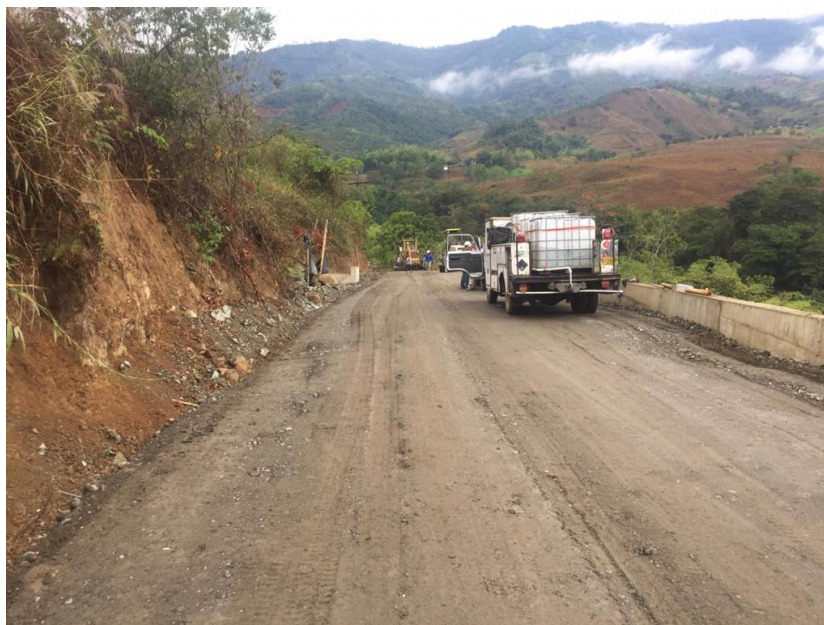
Ilustración 24. Rociado de agua previo a la imprimación
