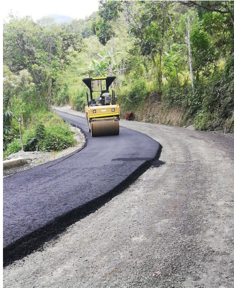
Ilustración 29. Compactación de la mezcla asfáltica
