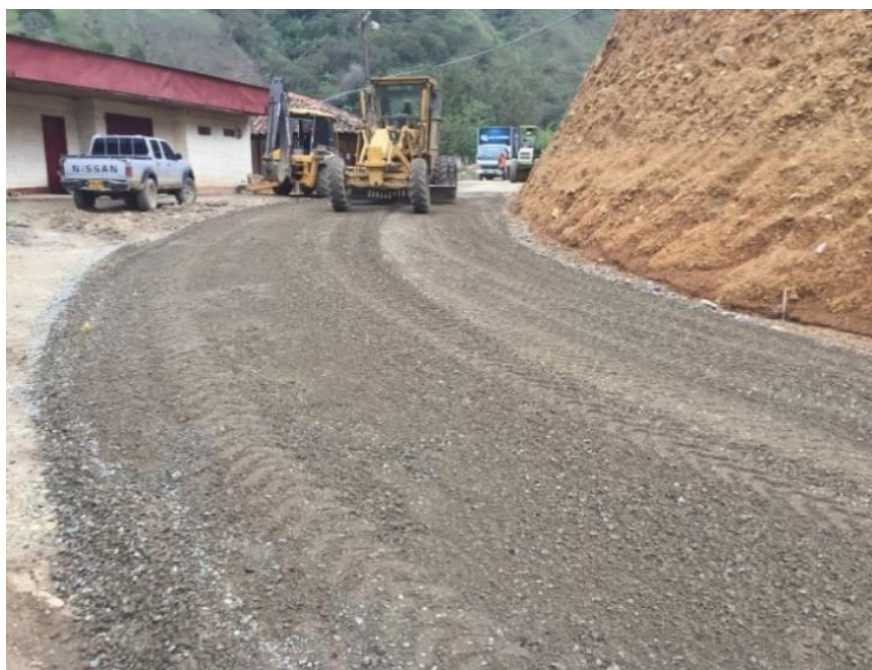
Ilustración 21. Extensión del material de base
