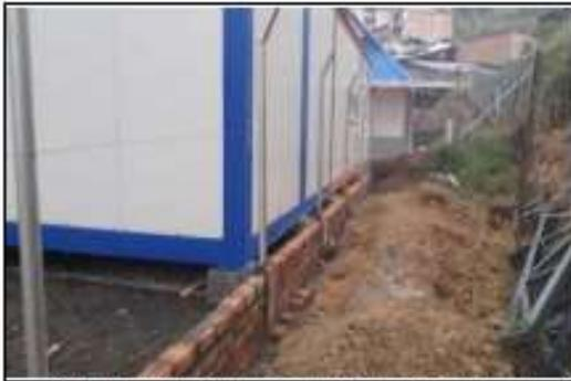
CONSTRUCCIÓN DE MURO Y FUNDICIÓN DE COLUMNETAS
