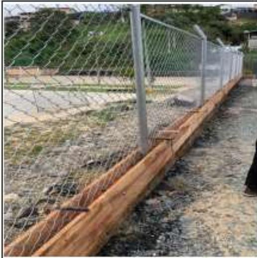
INSTALACIÓN DE MALLA Y FUNDICIÓN DE ALFAJÍA
