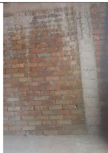
**Ilustración 48:** Sistema estructural no separados con elementos no estructurales.
