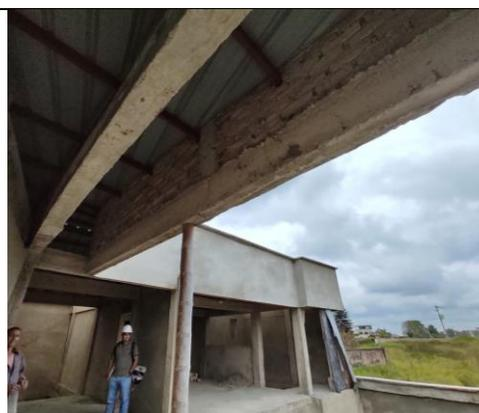
**Ilustración 32:** Elemento estructural tipo viga con dimensiones de luz grandes.
