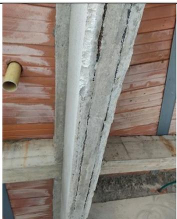
**Ilustración 27:** Acero de refuerzo longitudinal en viga, sin buen recubrimiento.
