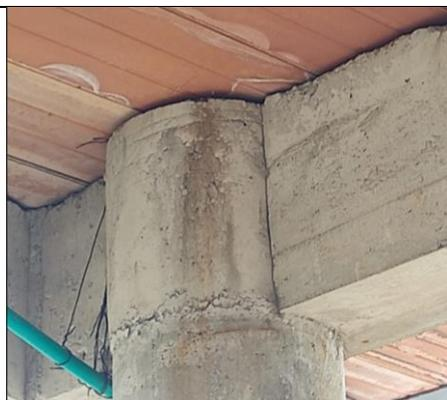
**Ilustración 29:** No hay conexión adecuada entre viga y columna.
