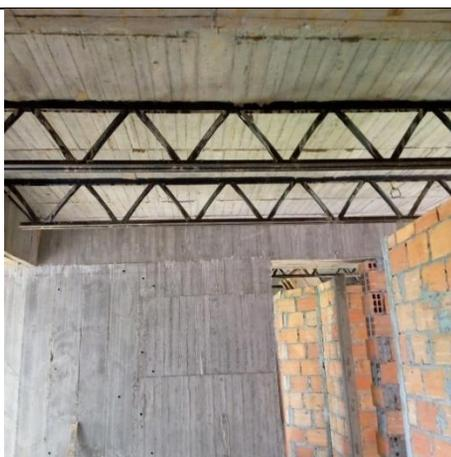
*Ilustración 20: Losa maciza, tipo joints.*
