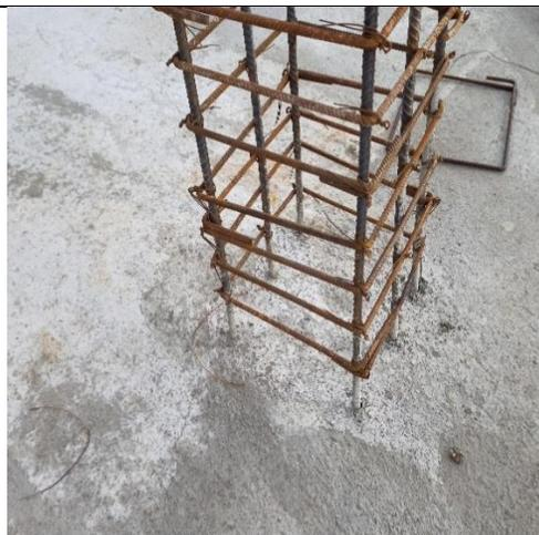
**Ilustración 11:** Estructura de estribos de columna #2.
