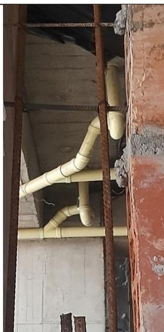
*Ilustración 90: Tubería descolgada no interfiere a los elementos estructurales.*
