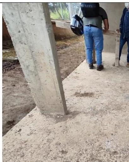
**Ilustración 34:** Elementos estructurales tipo columnas con dimensiones pequeñas.
