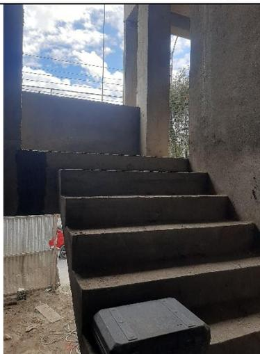
*Ilustración 80: Diferencia en altura entre contrahuellas.*
