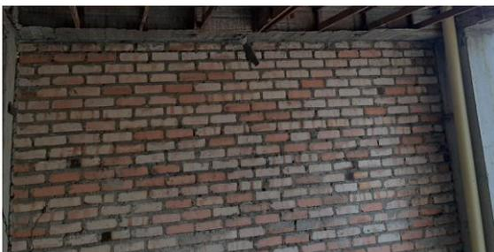
*Ilustración 61: No hay dilatación sísmica de muros no estructurales.*
