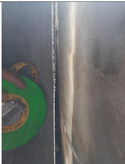
*Ilustración 75: Existe separación sísmica.*
