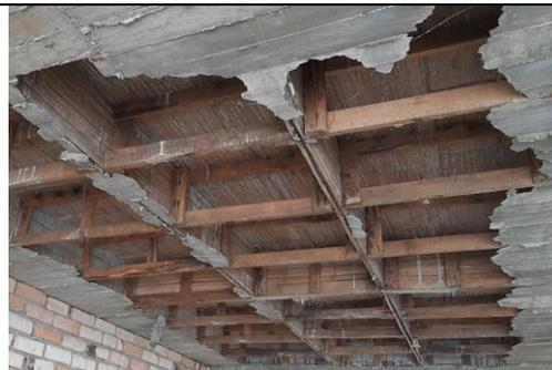
*Ilustración 60: No se respetan dimensiones de nervios.*
