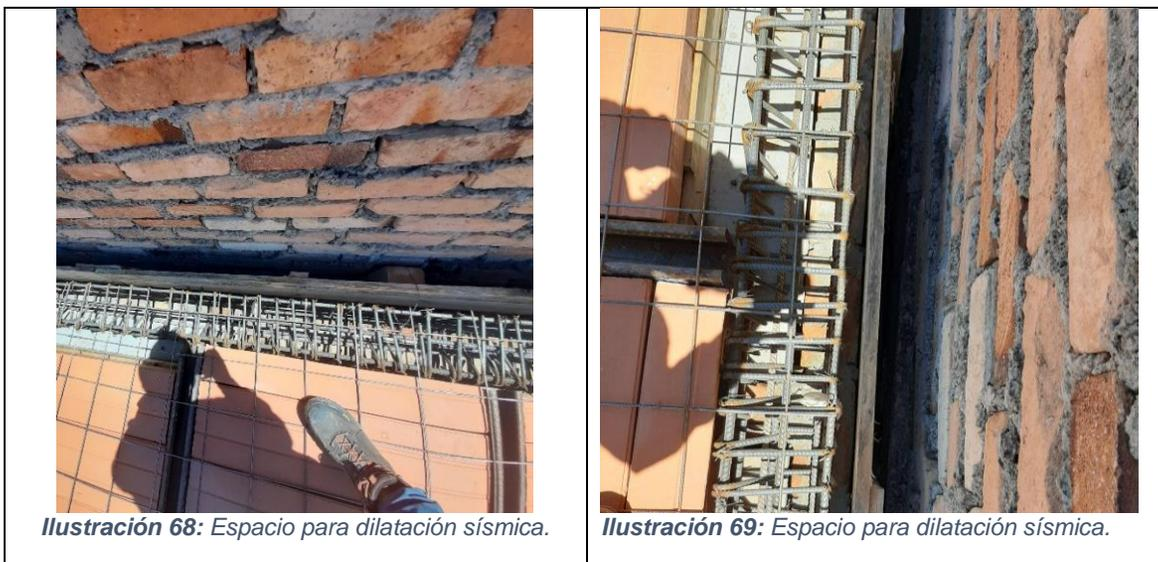
Ilustración 68: Espacio para dilatación sísmica.
