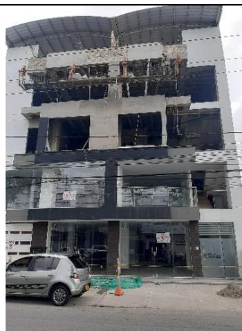
*Ilustración 62: Estructura con un piso adicional a lo establecido en planos.*
