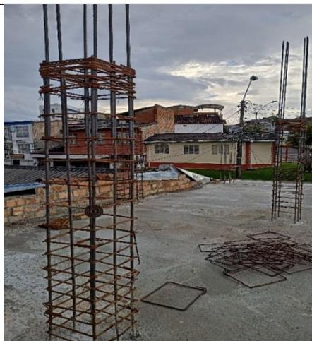
**Ilustración 10:** Estructura de estribos de columna #2.
