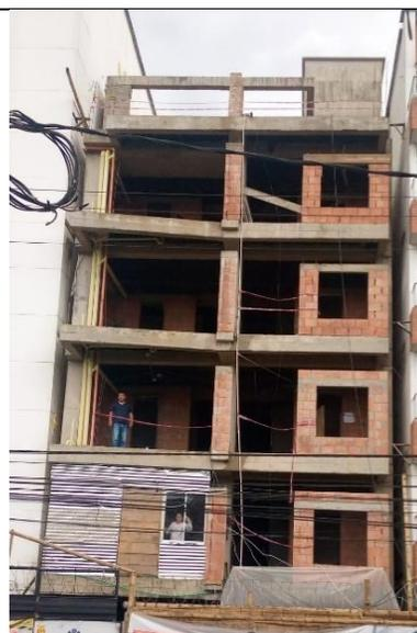
*Ilustración 89: Hay correcta separación sísmica.*
