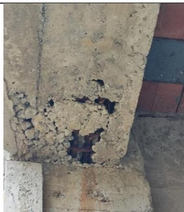
**Ilustración 28:** Acero de refuerzo longitudinal sin buen recubrimiento y mal vibrado en columna.
