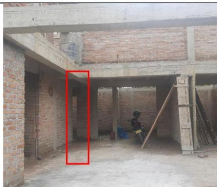
**Ilustración 46:** Elemento estructural tipo columna puesta en otra ubicación.
