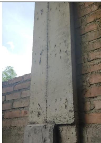
*Ilustración 105: Ausencia de dilatación de elementos no estructurales.*
