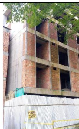
*Ilustración 21: Separación sísmica.*
