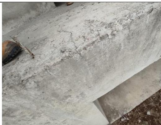
**Ilustración 30:** Fisura en elemento estructural tipo viga.
