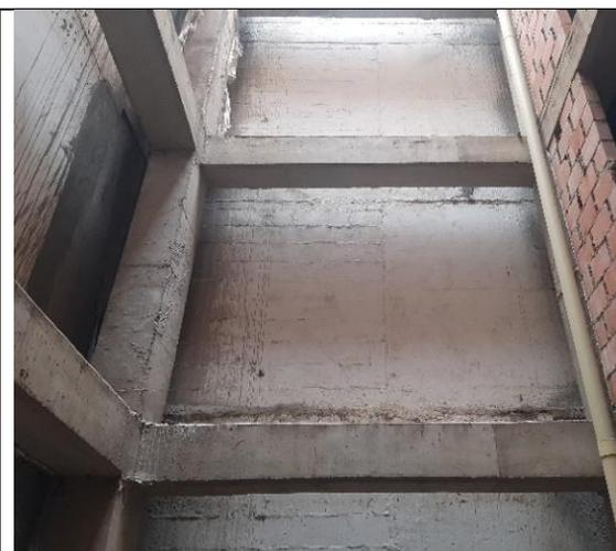
*Ilustración 88: Hay correcta separación sísmica.*
