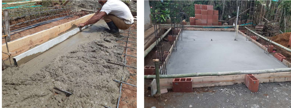
Figura 35. Fundición de la losa
