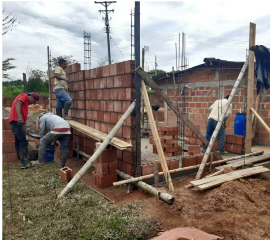
Figura 36. Levantamiento de muros en mampostería
