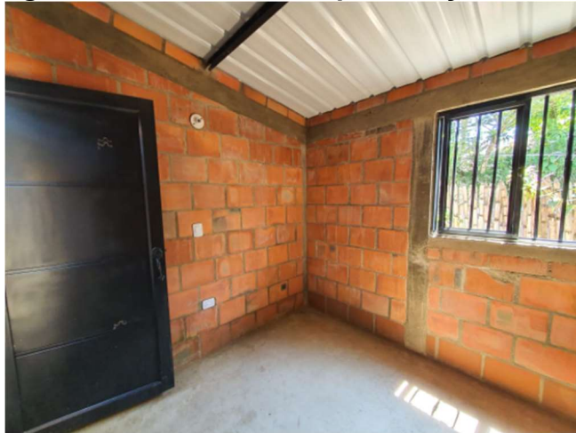
Figura 42. Instalación de puertas y ventanas
