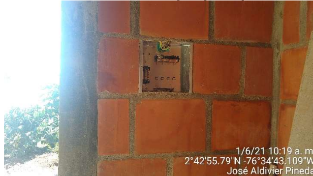
Figura 37. Perforación del bloque para puntos eléctricos
