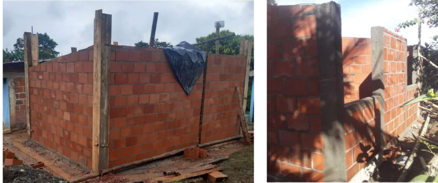
Figura 38. Formateado y fundición de columnas
