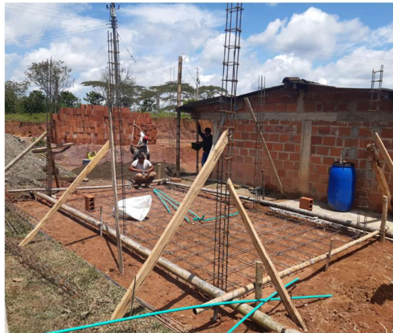
Figura 34. Instalación de tubería hidrosanitaria y eléctrica
