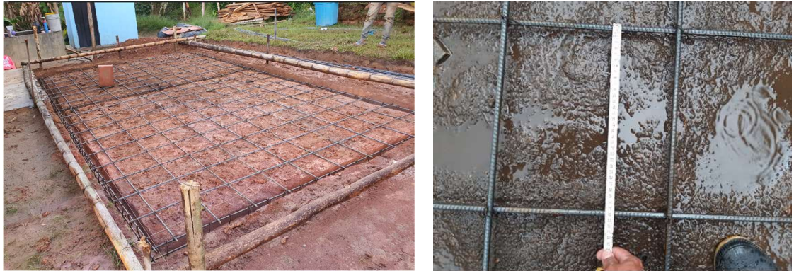
Figura 33. Refuerzo de la losa de cimentación
