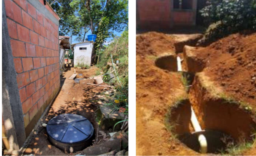
Figura 43. Instalación de pozo séptico
