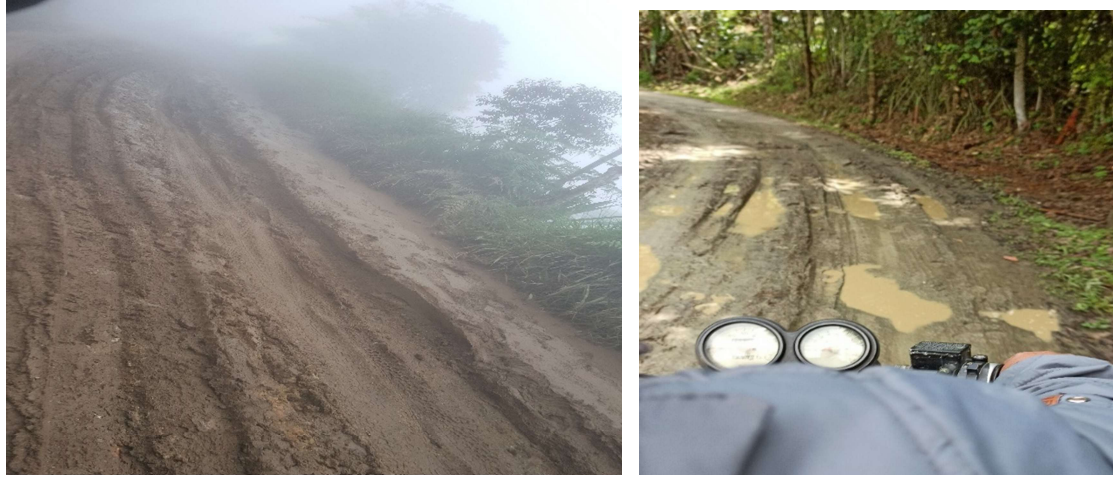
Figura 44. Vía de acceso a uno de los lotes en El Patía
