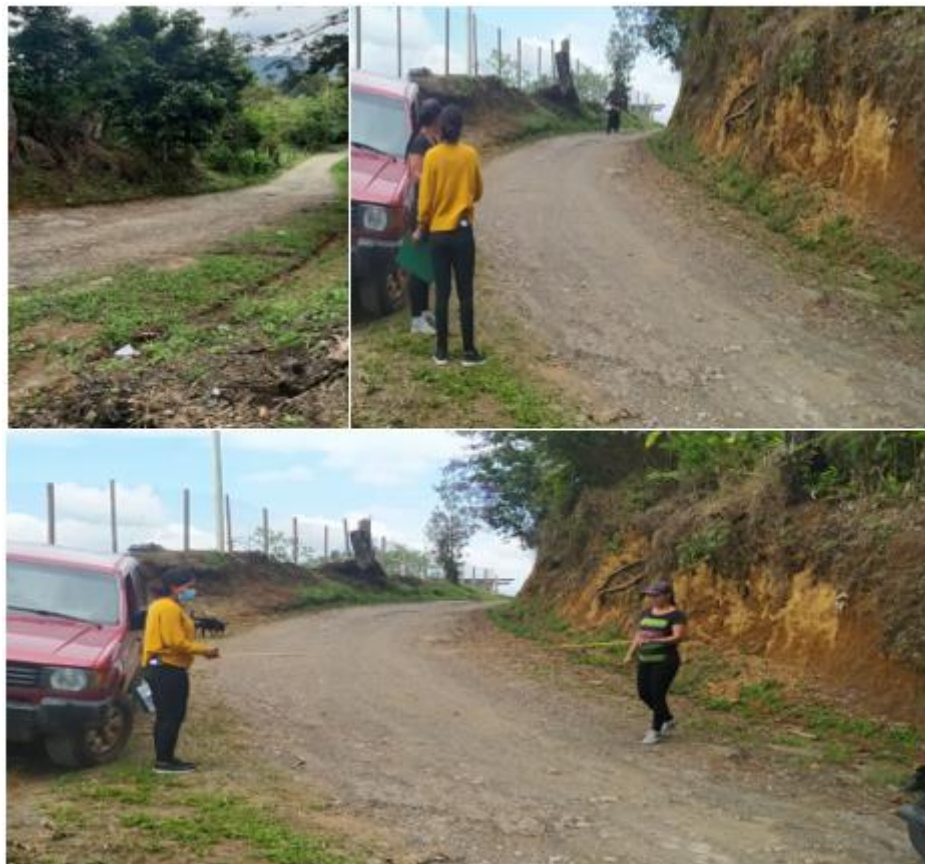
Figura. 53. Visita para la construcción de placa huella en la vereda Puentecita. Elaboración propia.
