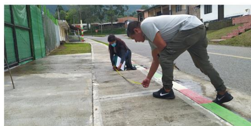
Figura 1. Toma de medidas de las juntas de dilatación
