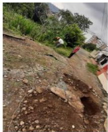
LIMPIEZA Y VERIFICACIÓN DE TUBERÍA PLUVIAL
