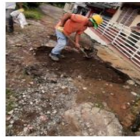
RELLENO Y COMPACTACIÓN DE MATERIAL
