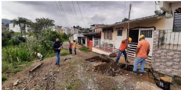
LIMPIEZA DE LA RECAMARA #1 DE ALCANTARILLADO DE AGUAS RESIDUALES
