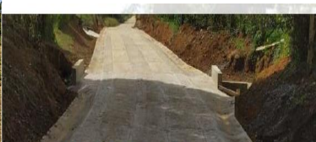
Figura 5. Alcantarilla tipo con tubería en concreto reforzado
