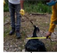
TAPONAMIENTO DE ALCANTARILLADO RESIDUAL QUE SE EXTRAJO DE LA RECAMARA #1.
