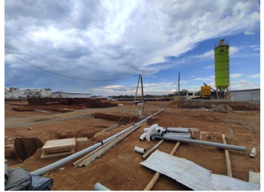
Imagen 7.5-6 Línea de suministro de concreto mediante bombeo
