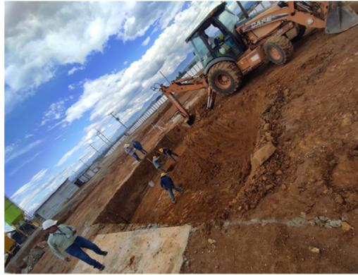
Imagen 7.5-5 Excavación tanque de almacenamiento
