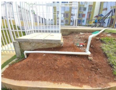
Imagen 7.1-9 Tubería provisional alimentación tanque almacenamiento
