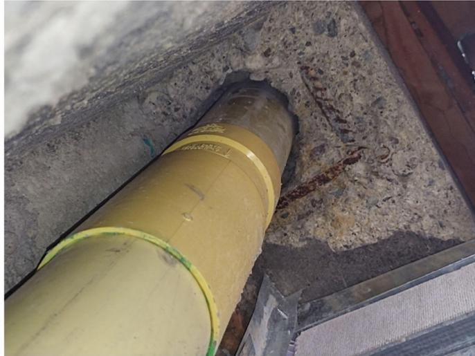
Imagen 7.6-4 Tubería de 3" en Viga cerca al nodo
