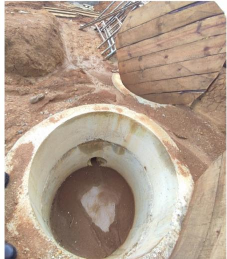
Imagen 7.5-9 Detalle recamara alcantarillado
