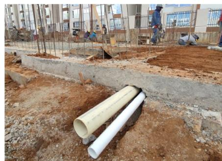
Imagen 7.5-4 Tubería sanitaria de conexión 4"y 2"
