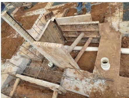
Imagen 7.5-2 Encofrado Fundición Viga
