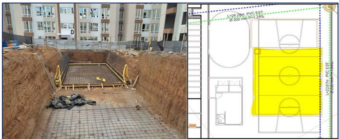
Imagen 7.4-5 Tanque de almacenamiento compartido en proceso de construcción - Esquema
