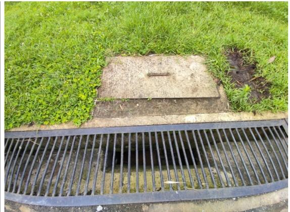
Imagen 7.3-13 Colector de aguas lluvias
