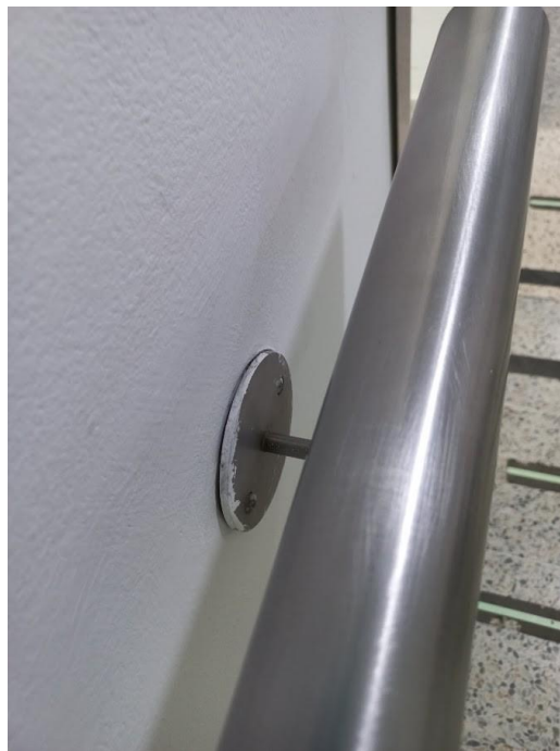
Imagen 16: Barandal con anclaje a la pared (fuente propia)
