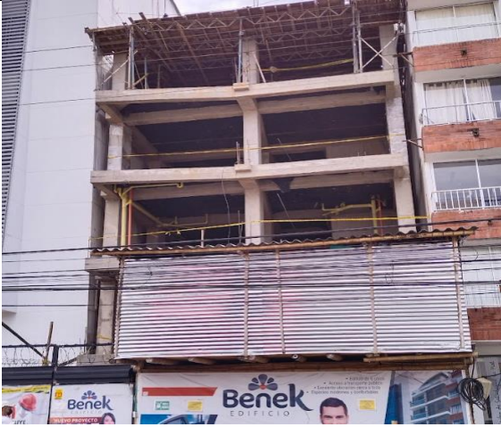
Estado de la fachada de la obra en el momento de la visita.
