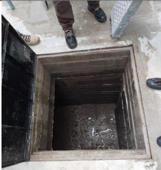
Tanque de almacenamiento el cual figura en planos, coincide en tamaño y posición.
