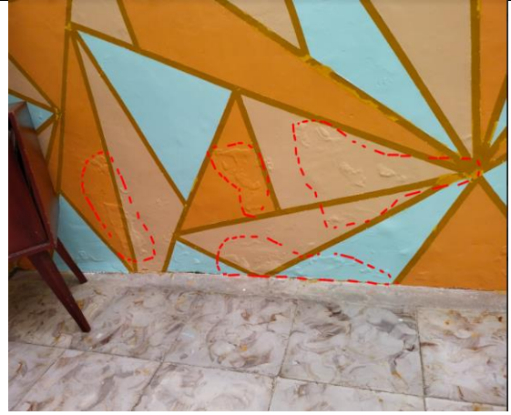
Las humedades sobre las paredes provocan daños en la pintura
