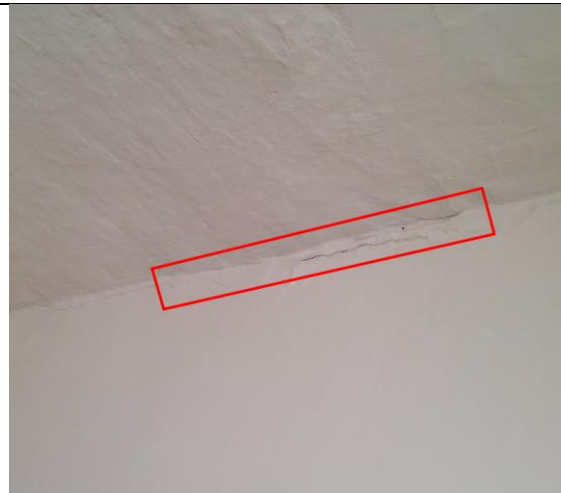
Las humedades sobre las paredes provocan daños en la pintura
