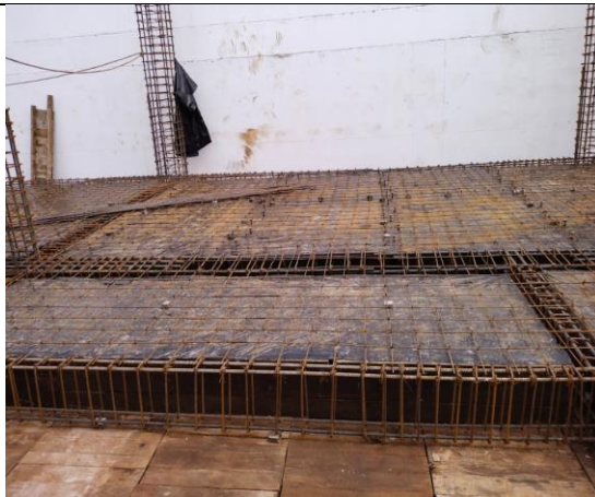
Estado actual losa de entrepiso del nivel 6 de la obra aun sin fundir.
