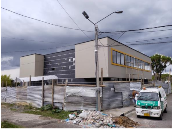
Estado actual de la obra visitada.
