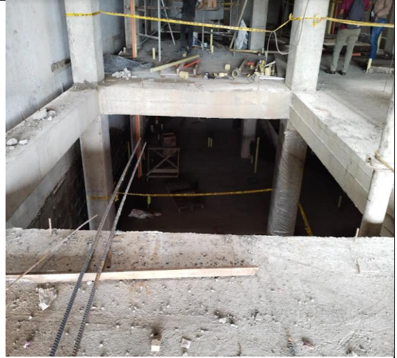
Sistema estructural aporticado en concreto reforzado.
