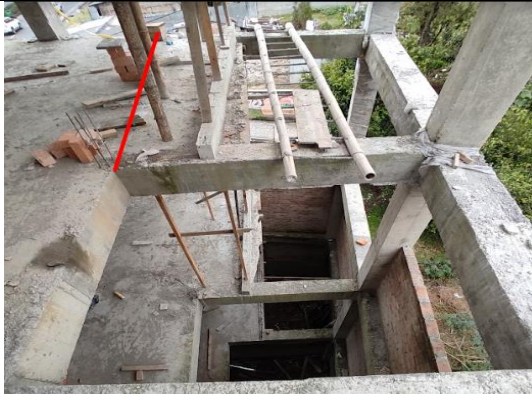
se realizó una ampliación de la losa de entrepiso en todos los niveles de la estructura, como se muestra en las imágenes anteriores, donde la línea roja indica hasta donde debió llegar la losa de entre piso.
