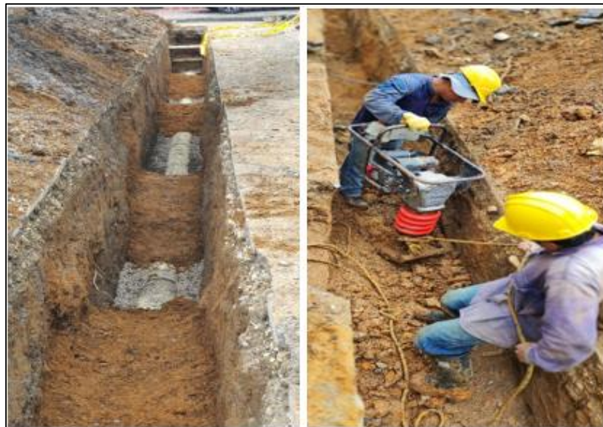
Ilustración 17. Suministro, Riego y Compactación de Relleno Tipo II
