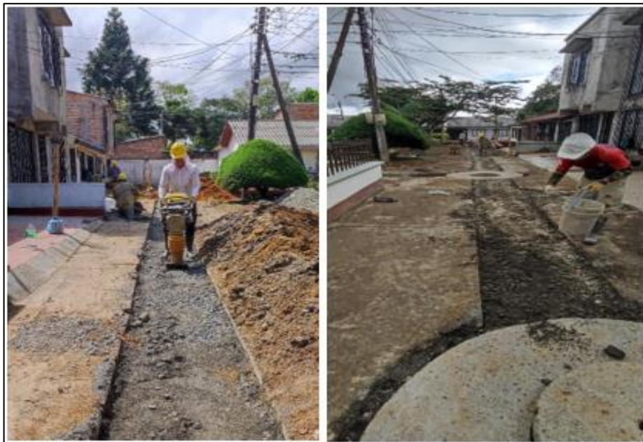
Ilustración 19. Suministro, Riego y Compactación de Base
