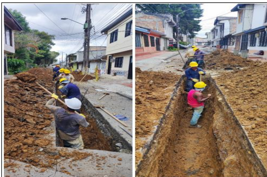
Ilustración 11. Excavación de Material Común
