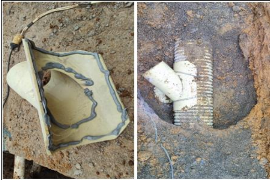
Ilustración 23. Instalación de Silla Yee 10" X 6"
