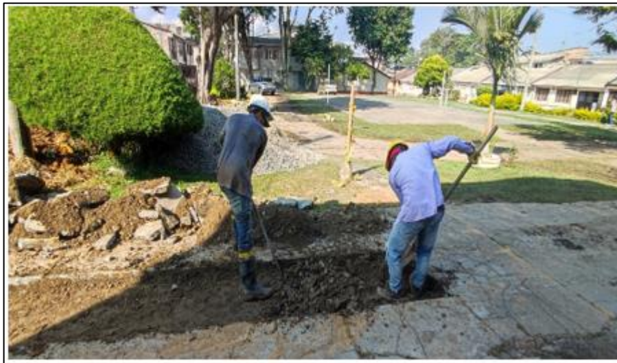
Ilustración 10. Excavación de Material Conglomerado
