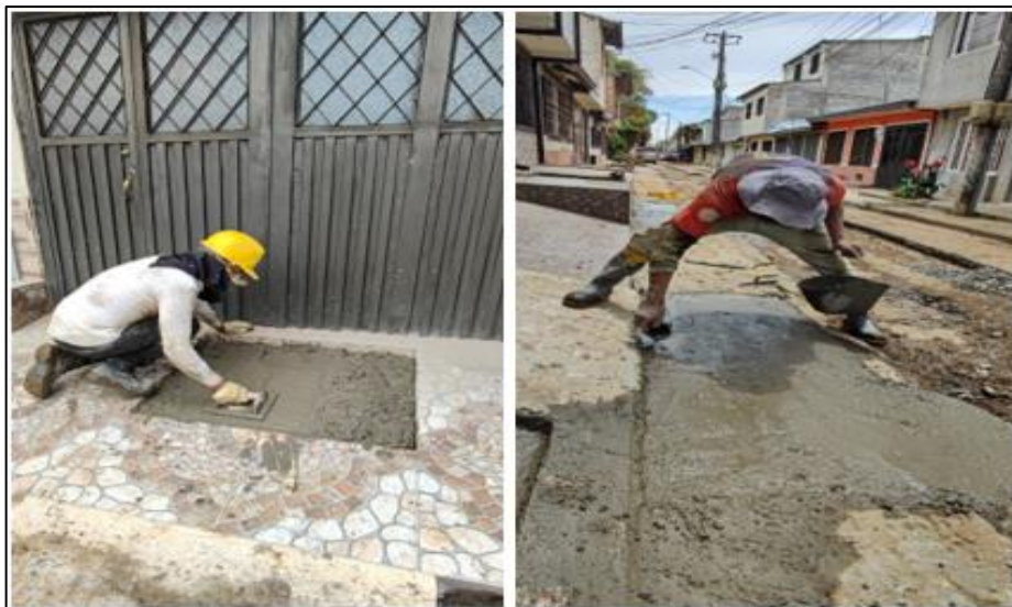
Ilustración 30. Construcción, Anden en Concreto 2500 PSI
