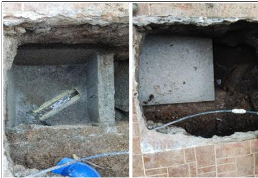
Ilustración 25. Construcción de Caja de Inspección
