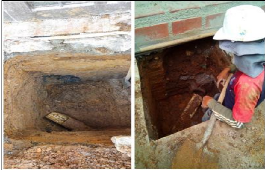
Ilustración 8. Demolición de Cajas Domiciliarias en Ladrillo
