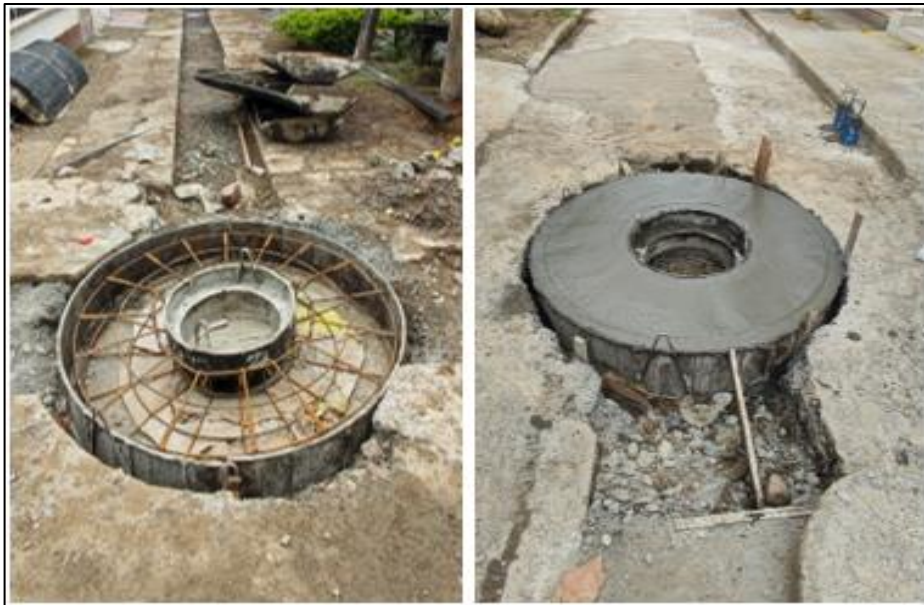
Ilustración 28. Construcción, Brocal con Tapa en Concreto 4000 PSI
