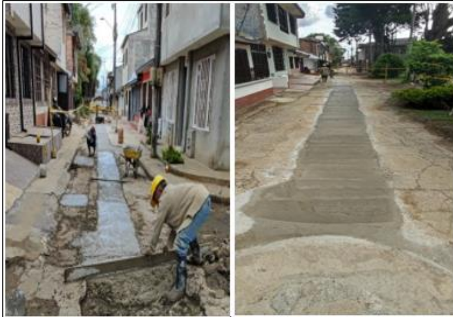
Ilustración 31. Reposición de Vía en Concreto de 3000 PSI
