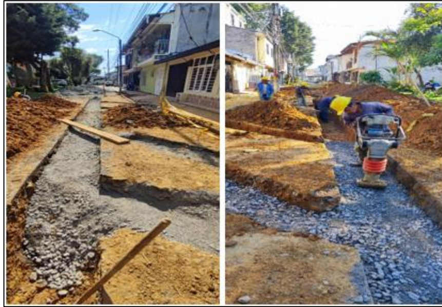
Ilustración 18. Suministro, Riego y Compactación de Sub Base
