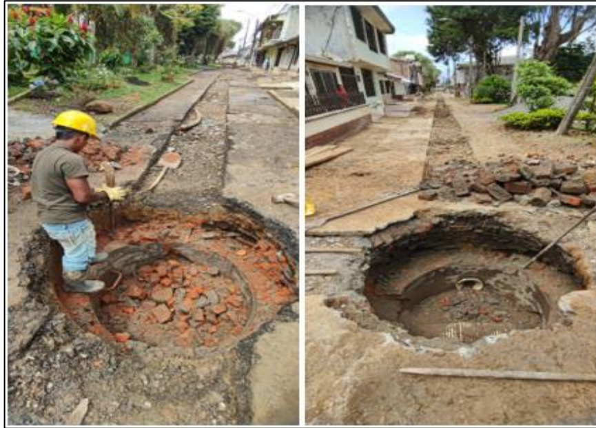
Ilustración 9. Demolición de Cámaras de Inspección
