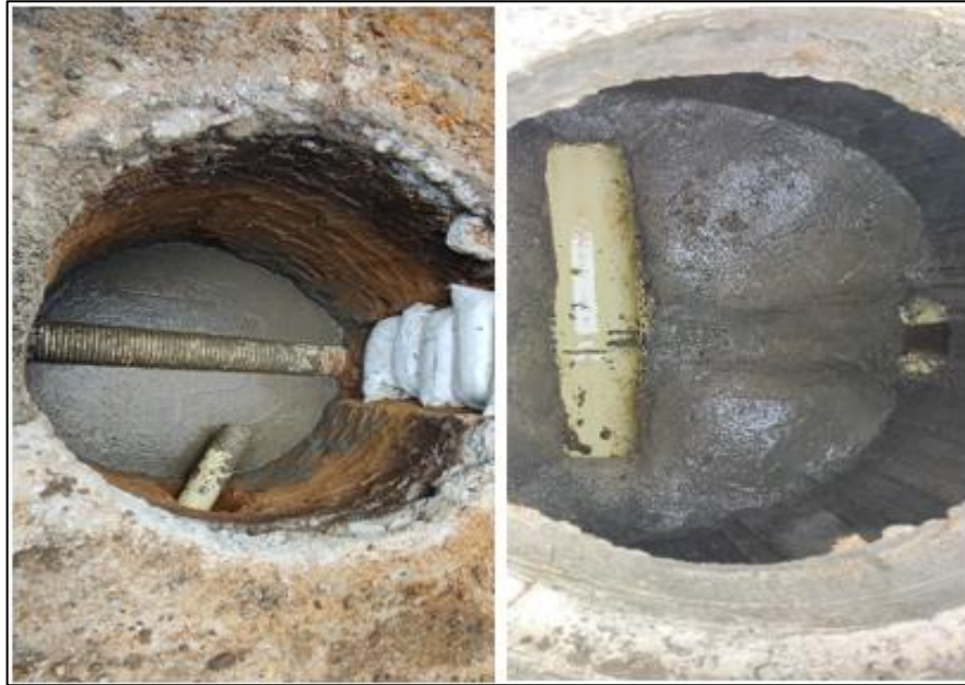
Ilustración 26. Construcción, Losa de Fondo Recamara
