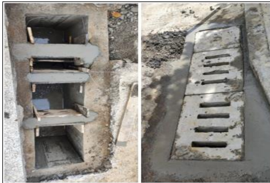
Ilustración 29. Construcción de Anden en Concreto
