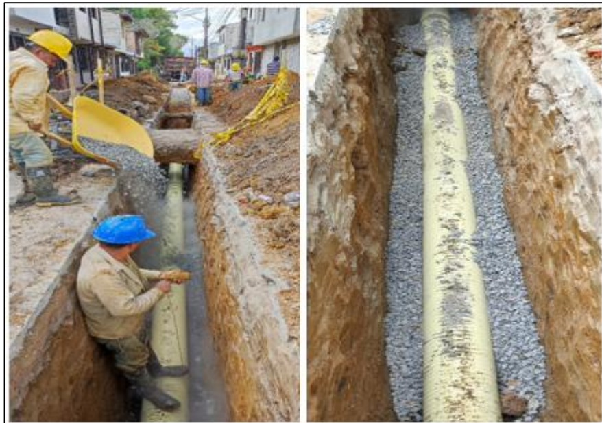
Ilustración 16. Suministro de Material Granular en Grava \frac{3}{4} "
