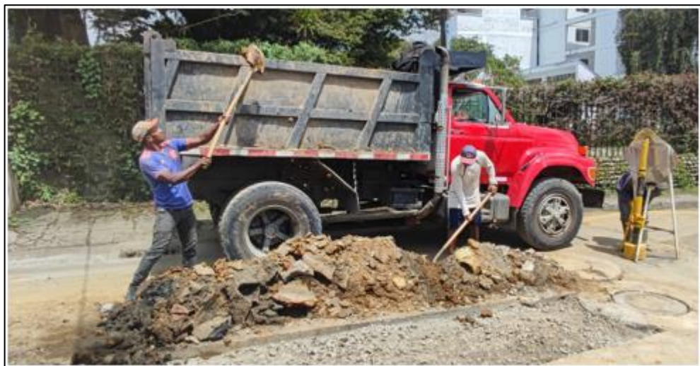
Ilustración 14. Retiro de Material Sobrante y Limpieza
