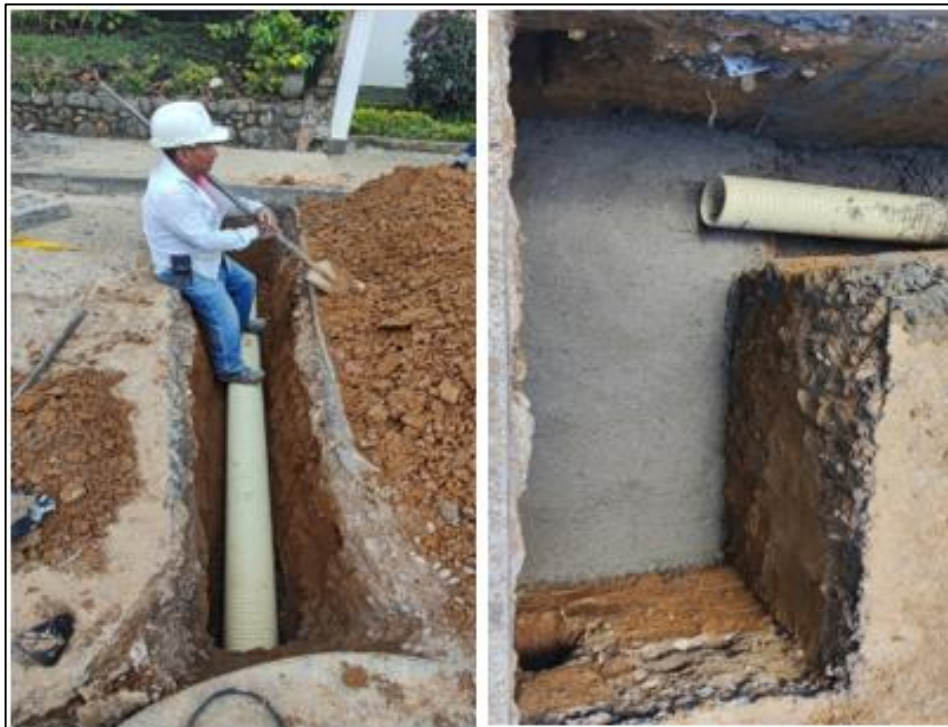
Ilustración 21. Instalación Tubería PVC de 8" - Sumidero
