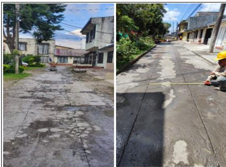
Ilustración 4. Corte de Pavimento
