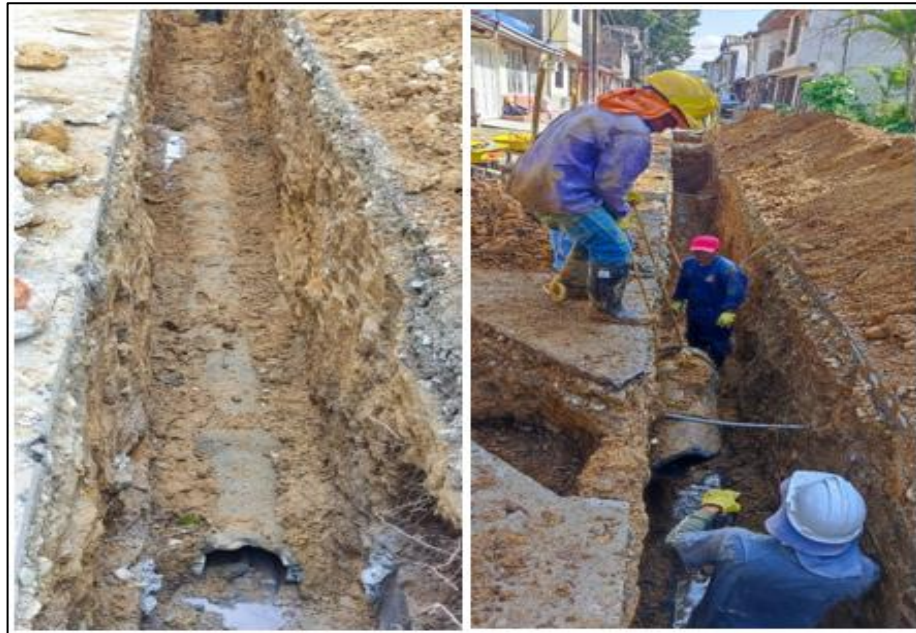
Ilustración 13. Retiro de Tubería Existente
