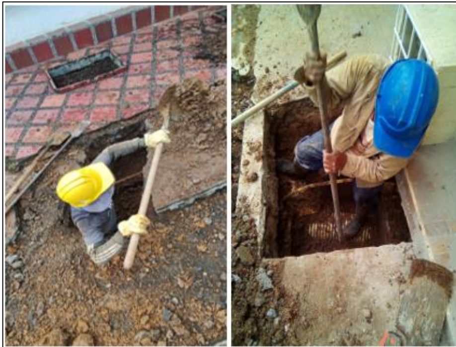
Ilustración 6. Demolición de Andén
