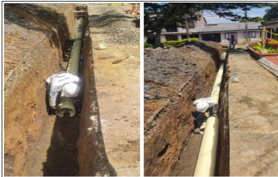
Ilustración 22. Instalación Tubería PVC de 10" - Red Principal
