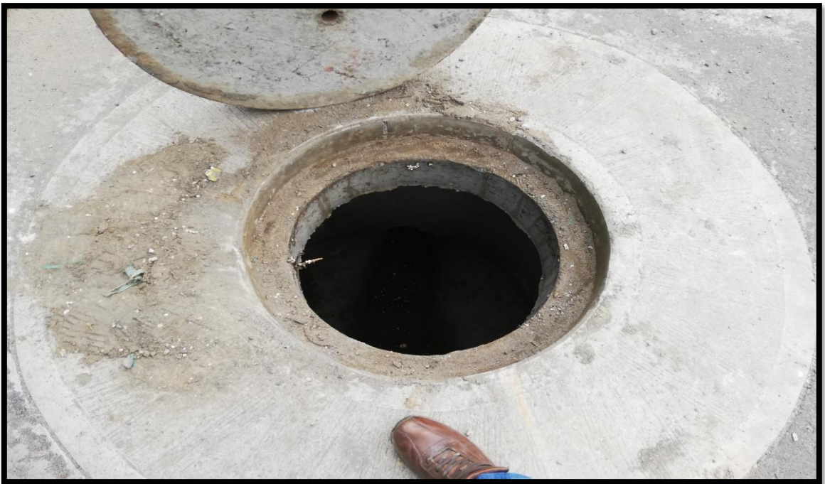
Figura 20. Cámara de inspección. Fuente: Tomada por el pasante.
