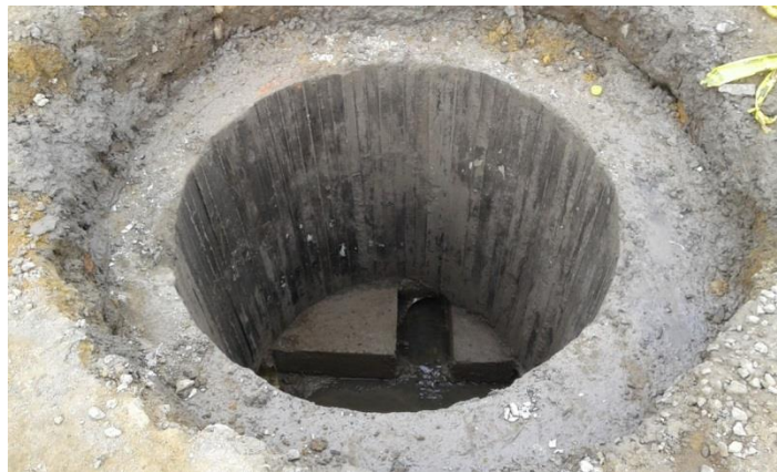
Figura 25. Cámara de inspección nueva. Fuente: Tomada por el pasante.
