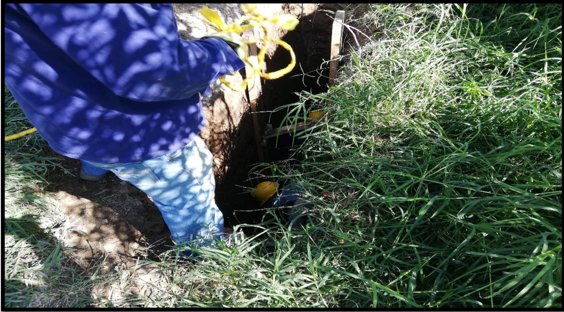
Figura 3. Excavación manual en material conglomerado hasta 2.5m. Fuente: Tomada por el pasante
