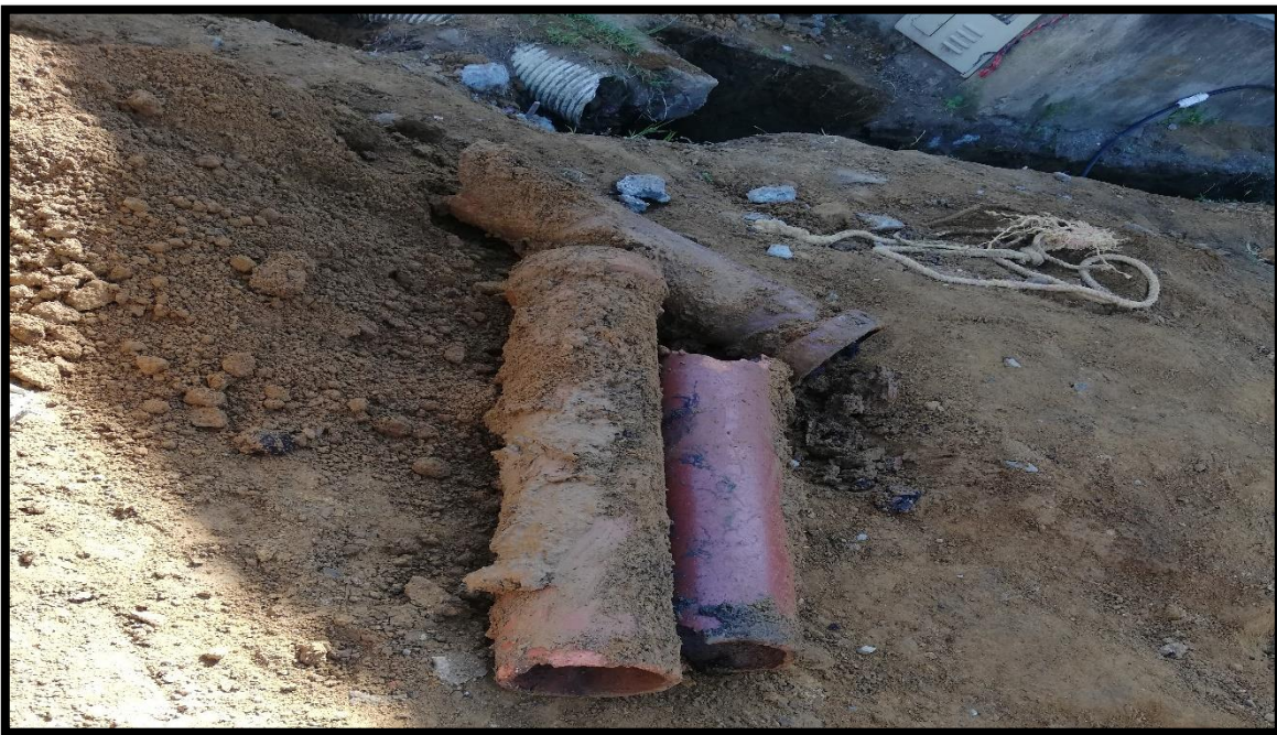
Figura 6. Retiro de tubería existente. Fuente: Tomada por el pasante
