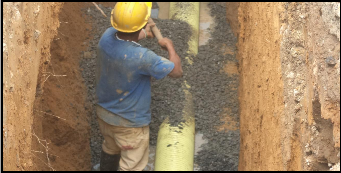
Figura 8. Construcción de filtro. Fuente: Tomada por el pasante.
