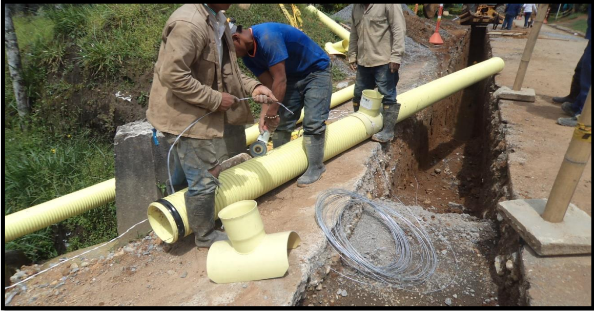
Figura 12. Instalación de tubería. Fuente: Tomada por el pasante.
