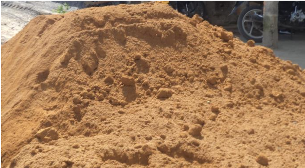
Figura 17. Material en obra para relleno. Fuente: Tomada por el pasante.
