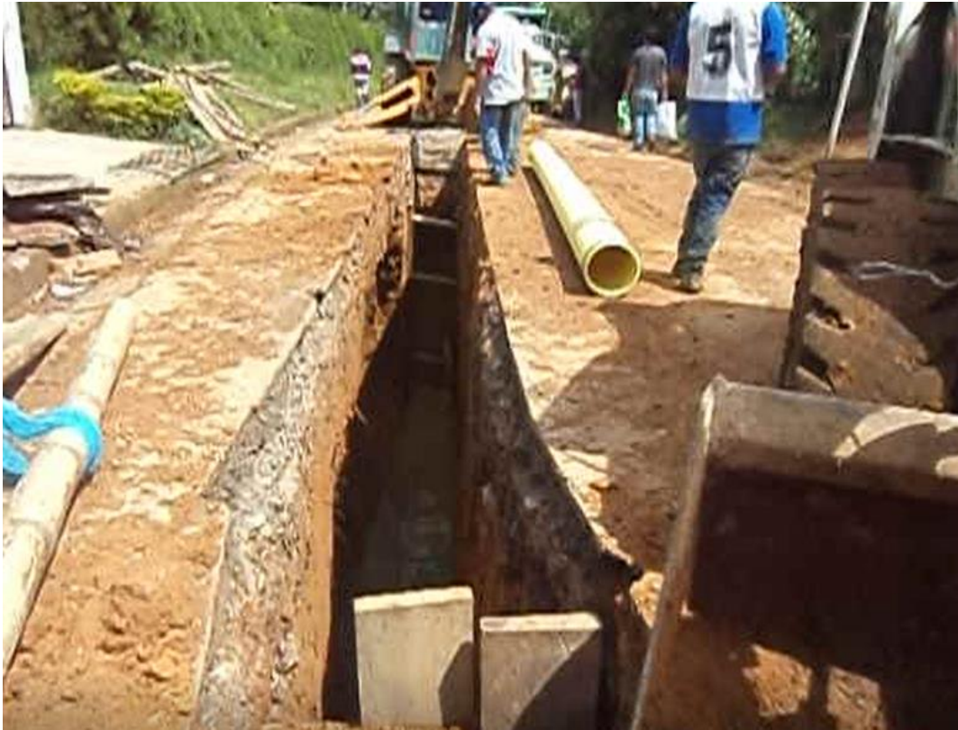
Figura 15. Alineamiento de tubería. Fuente: Tomada por el pasante.
