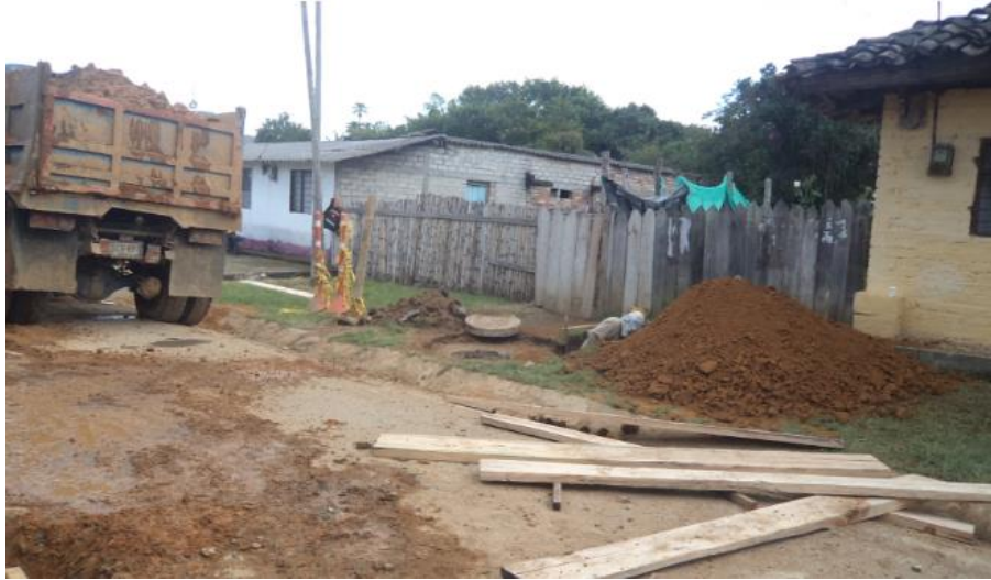
Figura 16. Material en obra para relleno. Fuente: Tomada por el pasante.
