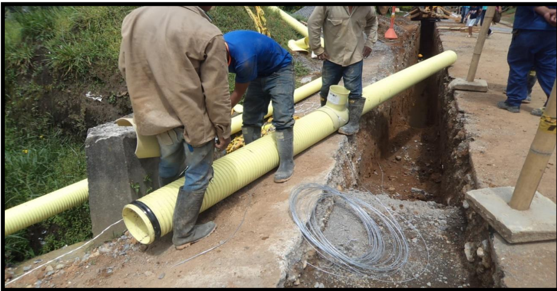
Figura 11. Instalación de silla Yee en sitio. Fuente: Tomada por el pasante
