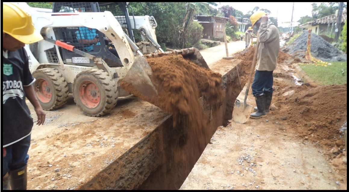
Figura 13. Relleno mecánico para tubería. Fuente: Tomada por el pasante.
