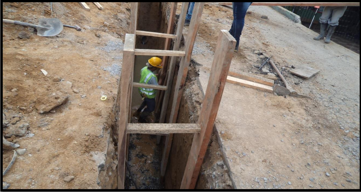
Figura 5. Entibado en madera. Fuente: Tomada por el pasante
