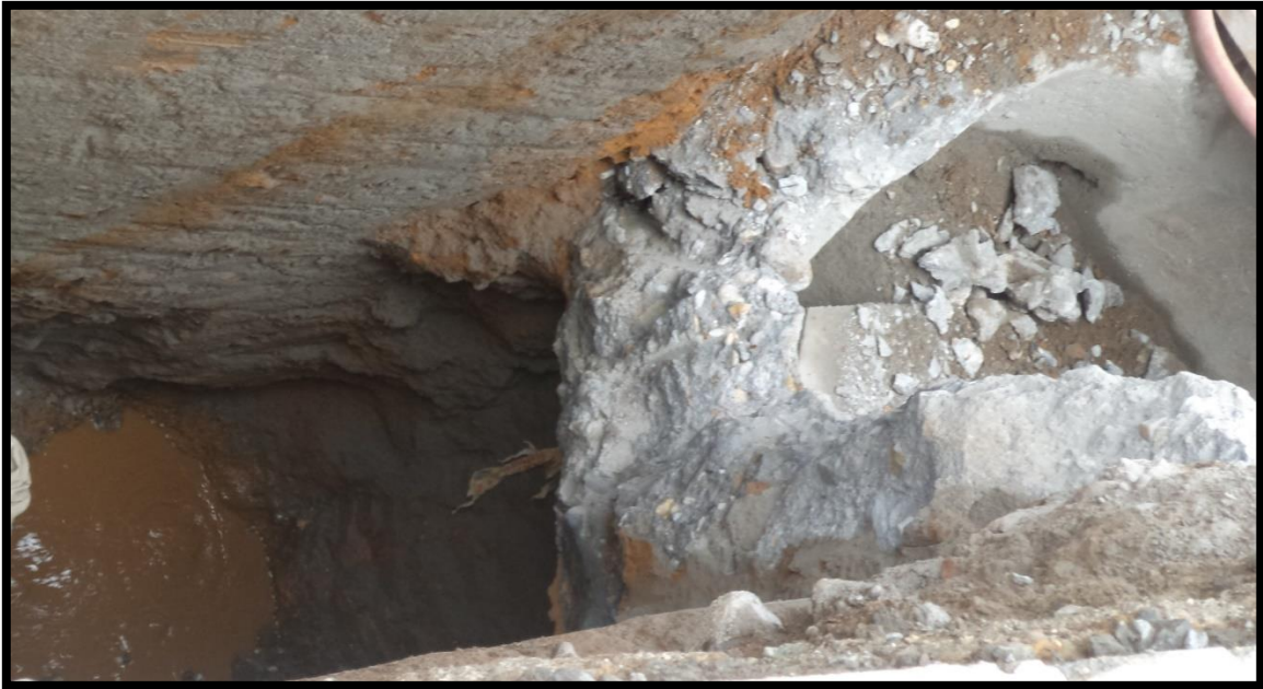
Figura 19. Demolición de cámara de inspección. Fuente: Tomada por el pasante.
