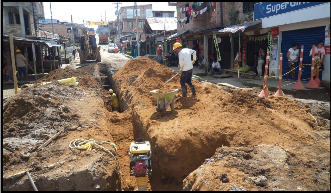
Figura 26. Proceso de compactación. Fuente: Tomada por el pasante.
