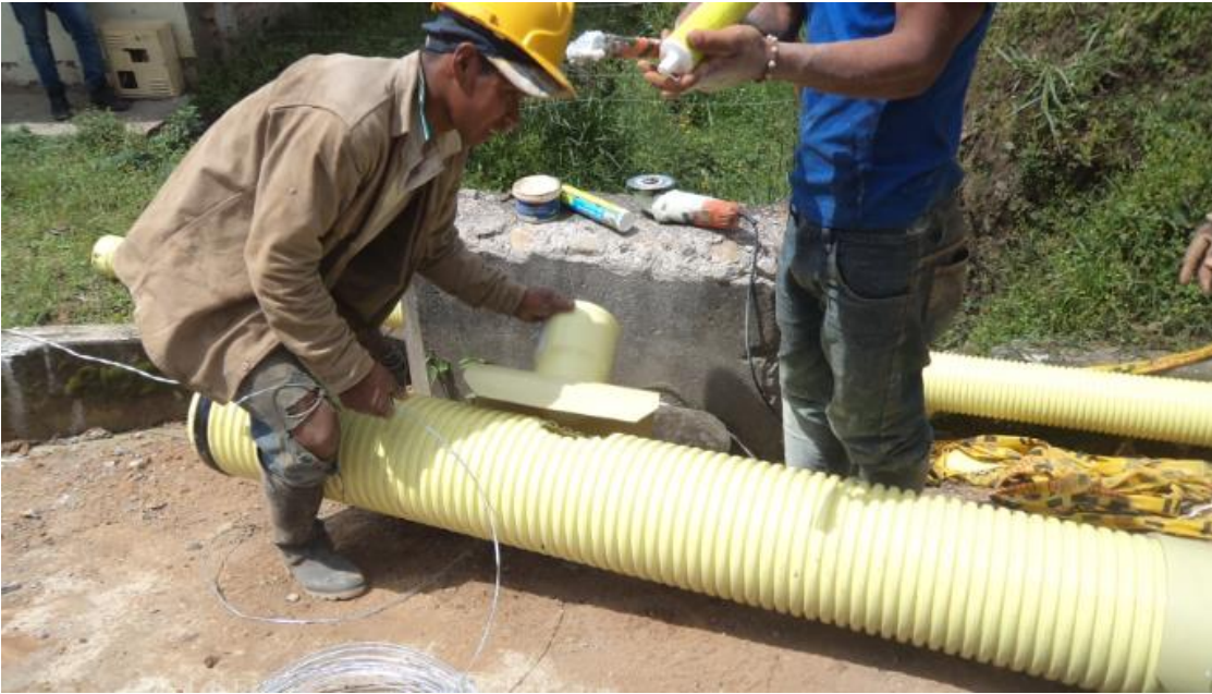
Figura 10. Tubería lista para colocar en sitio. Fuente: Tomada por el pasante
