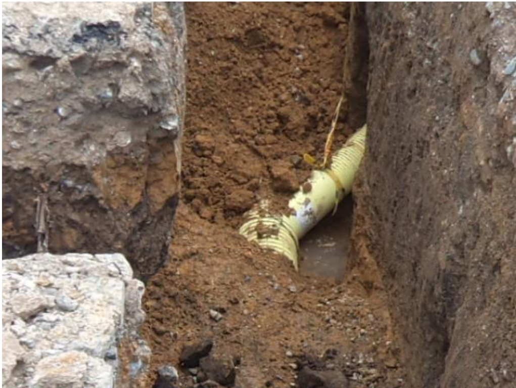
Figura 9. Instalación de silla Yee para tubería. Fuente: Tomada por el pasante
