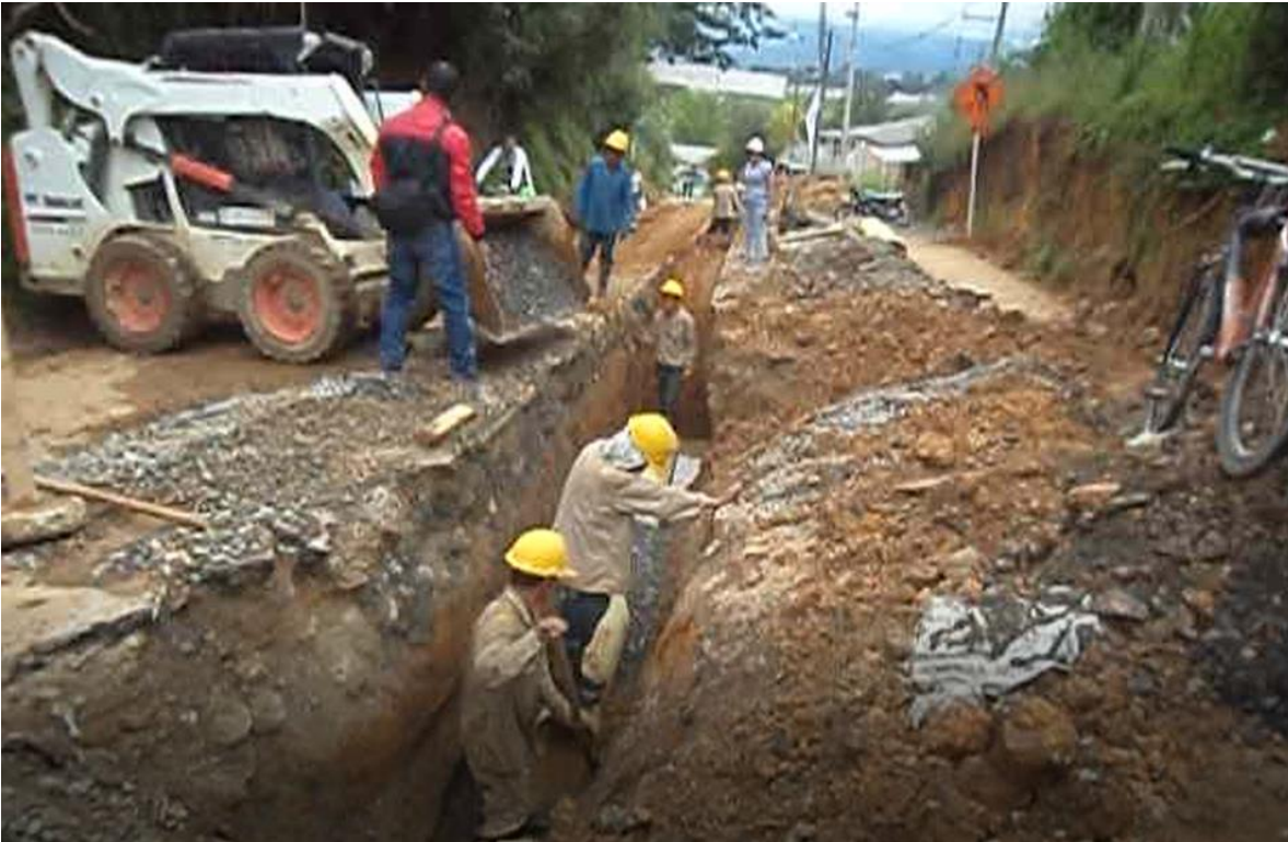
Figura 2. Relleno de material para tubería. Fuente: Tomada por el pasante
