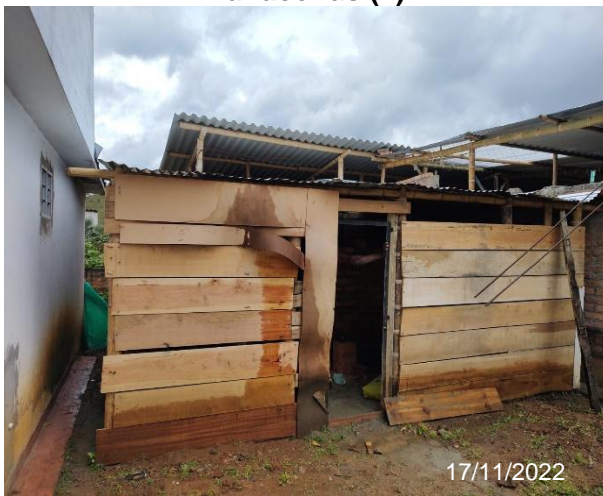
Figura 69. Cerramiento de obra – Yanaconas (2)
