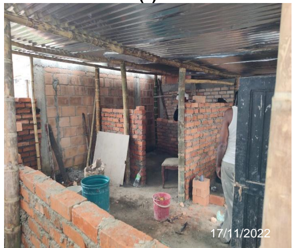
Figura 70. Avance de obra – Yanaconas (2)
