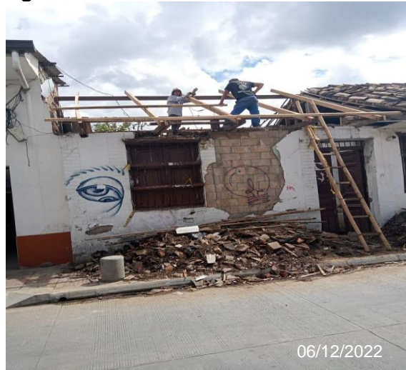
Figura 55. Desmante de cubierta – Centro
