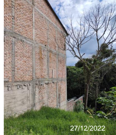
Figura 79. Cerramiento posterior 2- Tablazo
