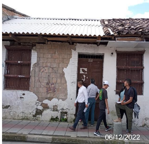
Figura 56, Intervención de cubierta – Centro
