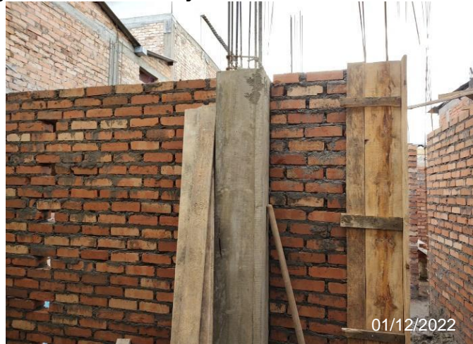
Figura 12. Encofrado y fundición de columnas - Palacé
