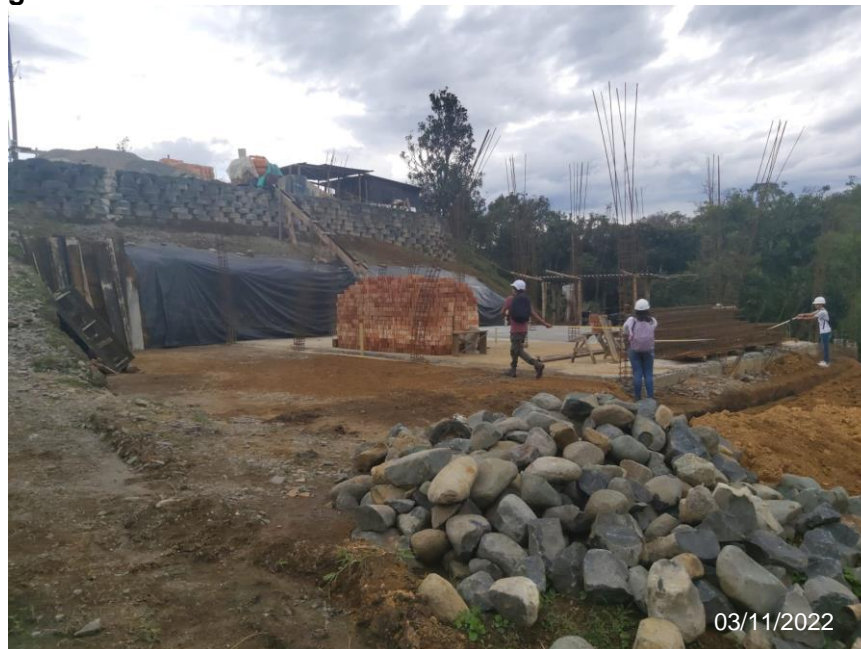
Figura 22. Avance de construcción Subdivisión 3 – San Francisco
