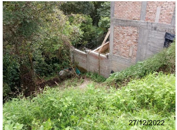
Figura 77. Cerramiento posterior 1- Tablazo
