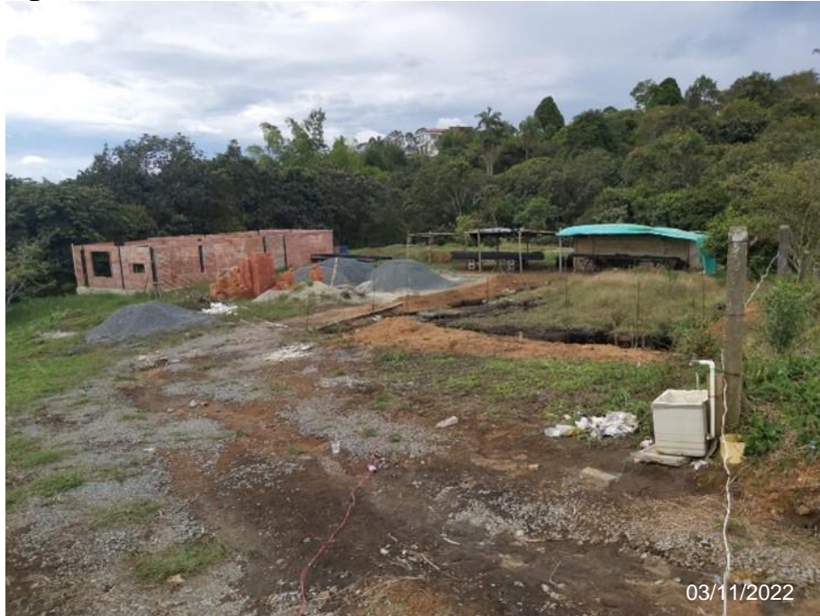
Figura 21. Avance de construcción Subdivisión 2 – San Francisco
