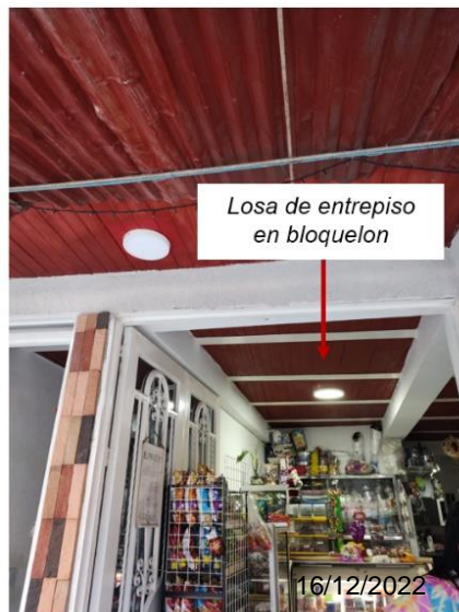
Figura 29. Losa de entresuelo – Yanaconas Figura 30. Detalle de losa de entresuelo – Yanaconas
