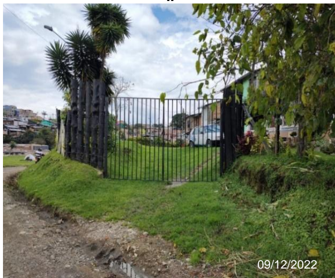
Figura 60. Cerramiento a zona verde – Colombia II
