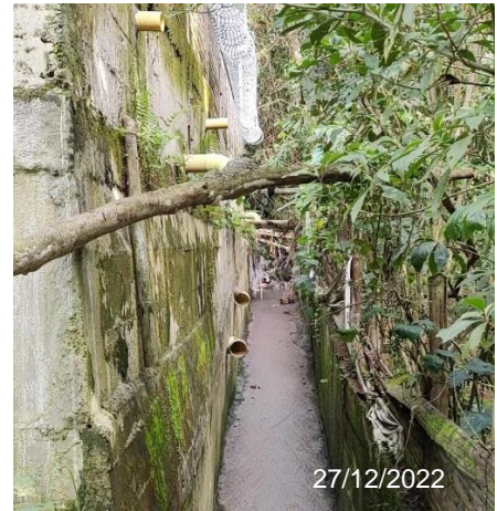
Figura 81. Canal de aguas residuales – Tablazo
