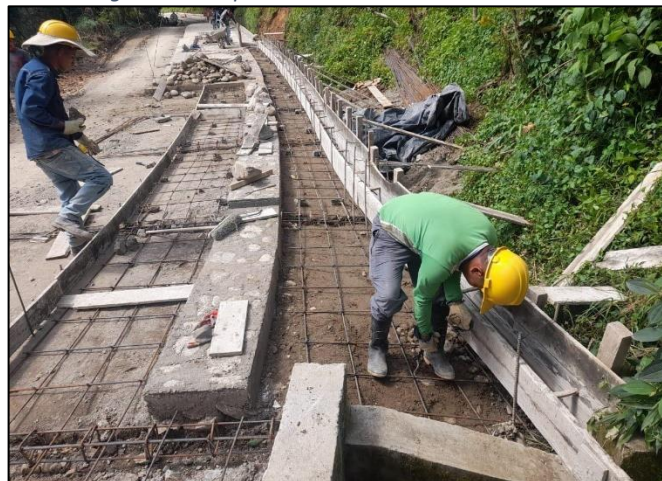
Figura 35 Chequeo de cantidades de acero en obra
