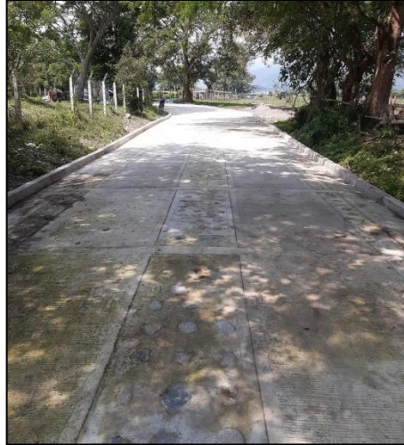
Figura 34 Tramo finalizado de Granadillo
