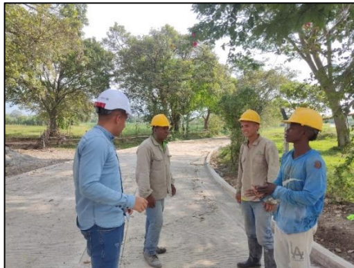
Figura 31 Registro fotográfico de indicaciones en obra
