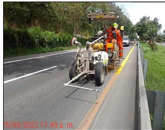
**Ilustración 35.** Repintado de marcas viales – resalto. PR21+200 – Calzada occidental.
