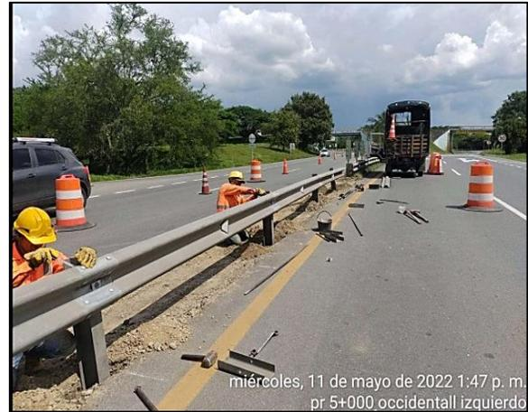
**Ilustración 27.** Reparación de defensas metálicas. PR69+900 calzada occidental
