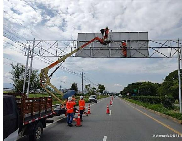
**Ilustración 33.** Cambio de tablero de señal menor. PR38+400 calzada oriental
