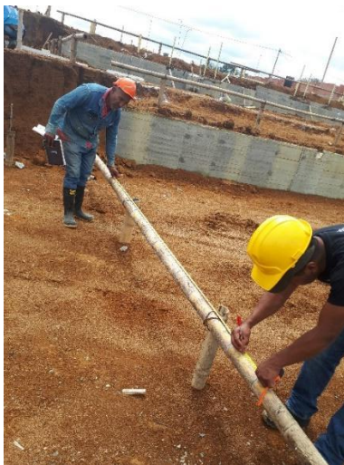
Imagen 2. Marcaje en la Localización y Replanteo
