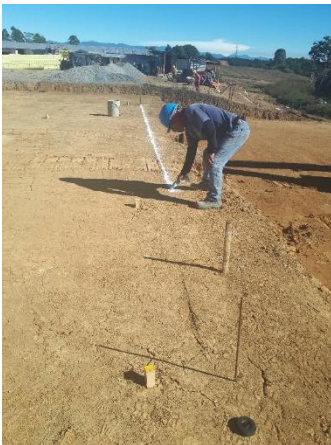
Imagen 39 Delimitación de zonas de excavación por medio de material "CAL"
