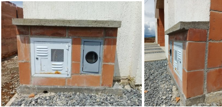
Imagen 45 Construcción de Murete para Instalación de Contadores de Gas y de Agua.
