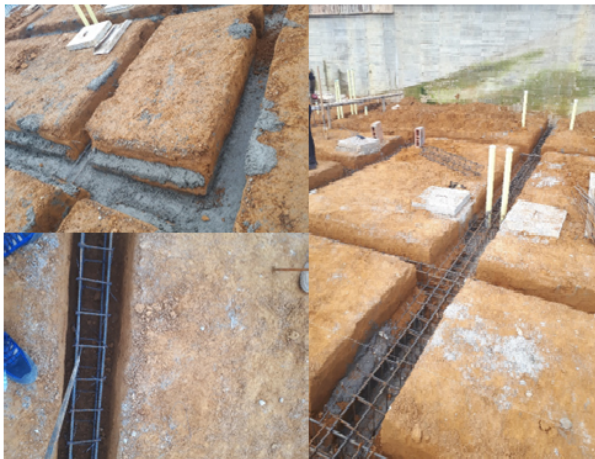
Imagen 10 Solado de limpieza
