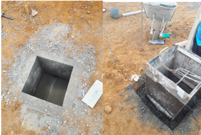
Imagen 7 Terminado de caja de inspección
