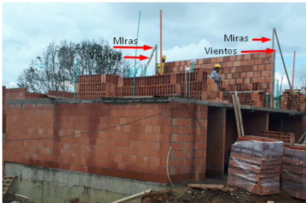
Imagen 31 Elevación del plomo de la verticalidad del muro del primer piso al segundo piso
