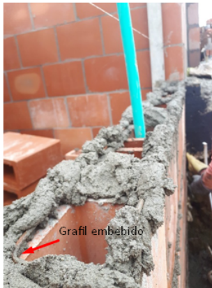
Imagen 21 Grafiles embebidos en pega de mortero
