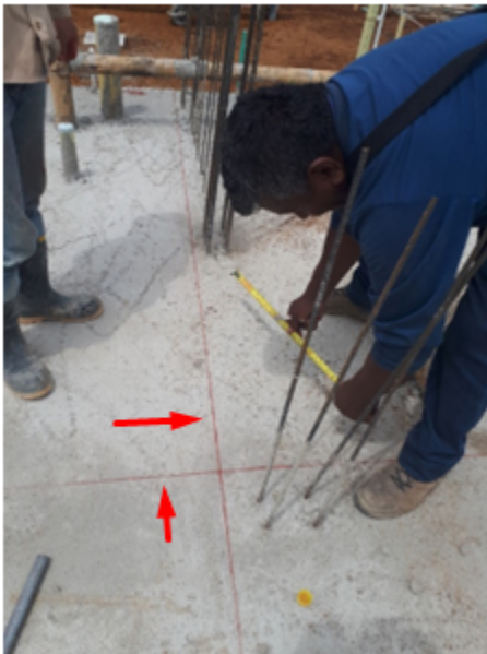
Imagen 19 Marca de Puntos Guías para Cuerdas de Replanteo de Primera Hilada de Ladrillos
