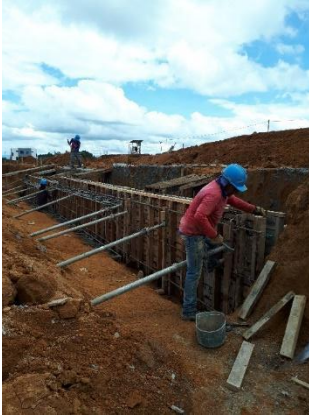
Imagen 42 Instalación de formaleta de madera para fundición de muro de contención
