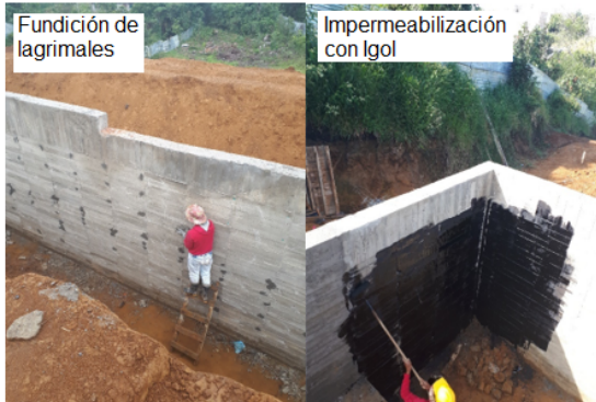
Imagen 43 Fundición de lagrimales e impermeabilización de muros con "IGOL impermeabilizante"
