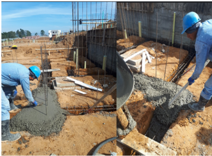
Imagen 15 Actividad de emparejamiento con "Palustre" y Acabado con "Platacho"
