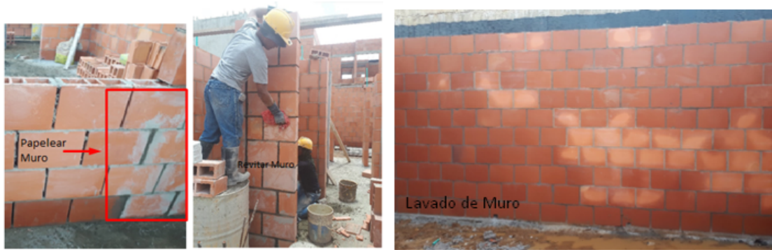
Imagen 22 Limpieza de muros
