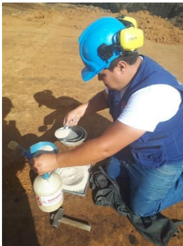
Imagen 36 Prueba de densidad de suelo por GEOFISICA S.A.S
