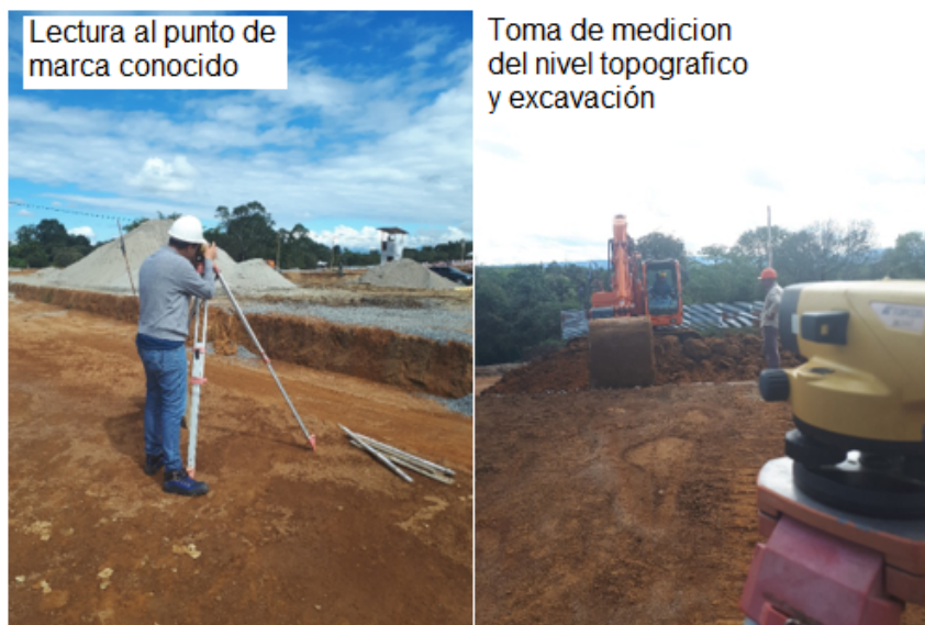
Imagen 44 Nivelación de viviendas realizada con equipo de topografía
