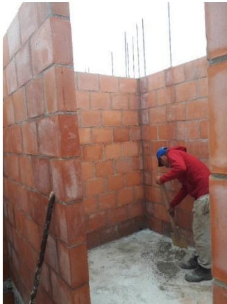
Imagen 25 Limpieza luego de fundición con Paleta
