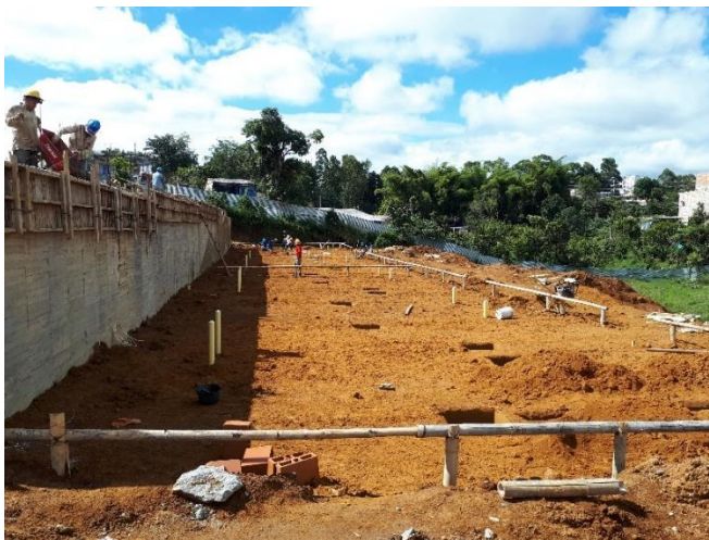
Imagen 1 Puntos de Marca en Localización y replanteo
