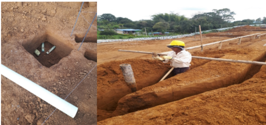
Imagen 3 Excavación a mano de tuberías y caja de inspección
