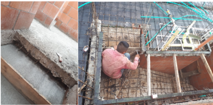
Imagen 30 Fundición monolítica de losa de entrepiso y grada
