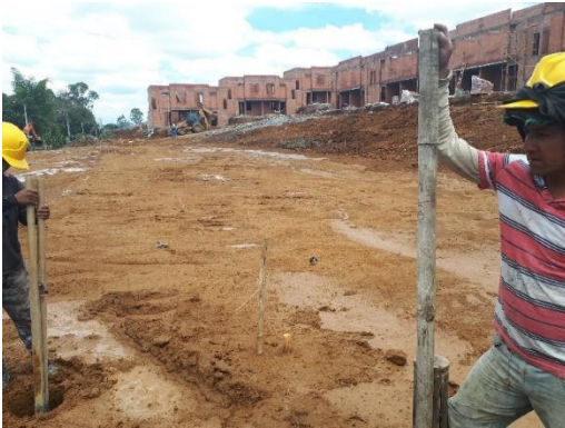
Imagen 38 Utilización de guaduas de forma vertical para referencias de nivel
