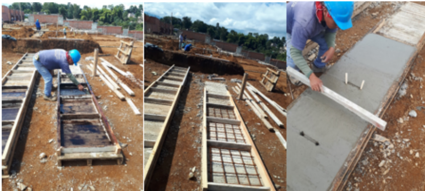
Imagen 6 Proceso constructivo de tapas de cajas de inspección
