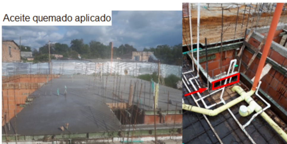
Imagen 28 Aplicación de aceite quemado en formaleta e instalación de formaleta de 12 [cm] para espesor de losa
