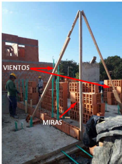
Imagen 20 instalaciones de miras y vientos para la pega de mampostería
