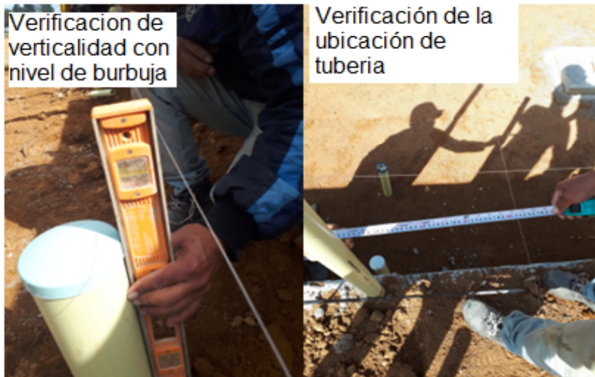
Imagen 4 Verificación de verticalidad con nivel de burbuja y de ubicación por medio de distancias entre ejes
