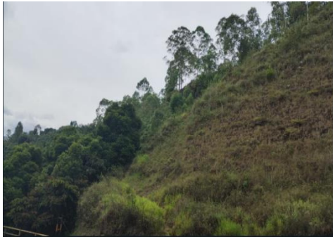
Fotografía tomada por: Grupo de trabajo, 2023
