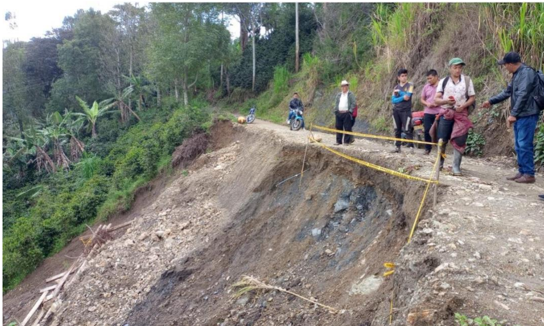
Figura 14 Elementos Expuestos en el corredor vial El Salado - Chapiurco, sector cerones
