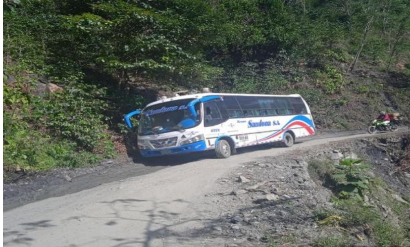
Figura 10 Elementos expuestos en la Vía Terciaria San José – El Tablón de Gómez
