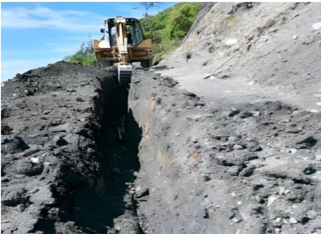
Figura 17 Elementos Expuestos en redes de acueducto, vereda El Diviso
