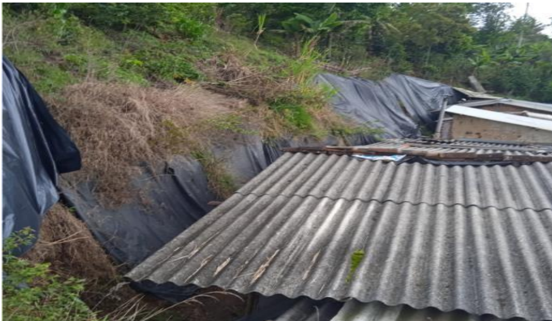
Figura 18 Elementos Expuestos en la Urbanización Los Robles
