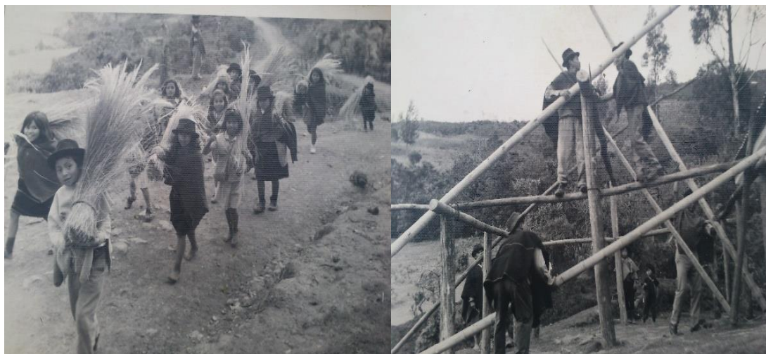
Figura 12. Construcción de Tulpa con materiales de la región.
