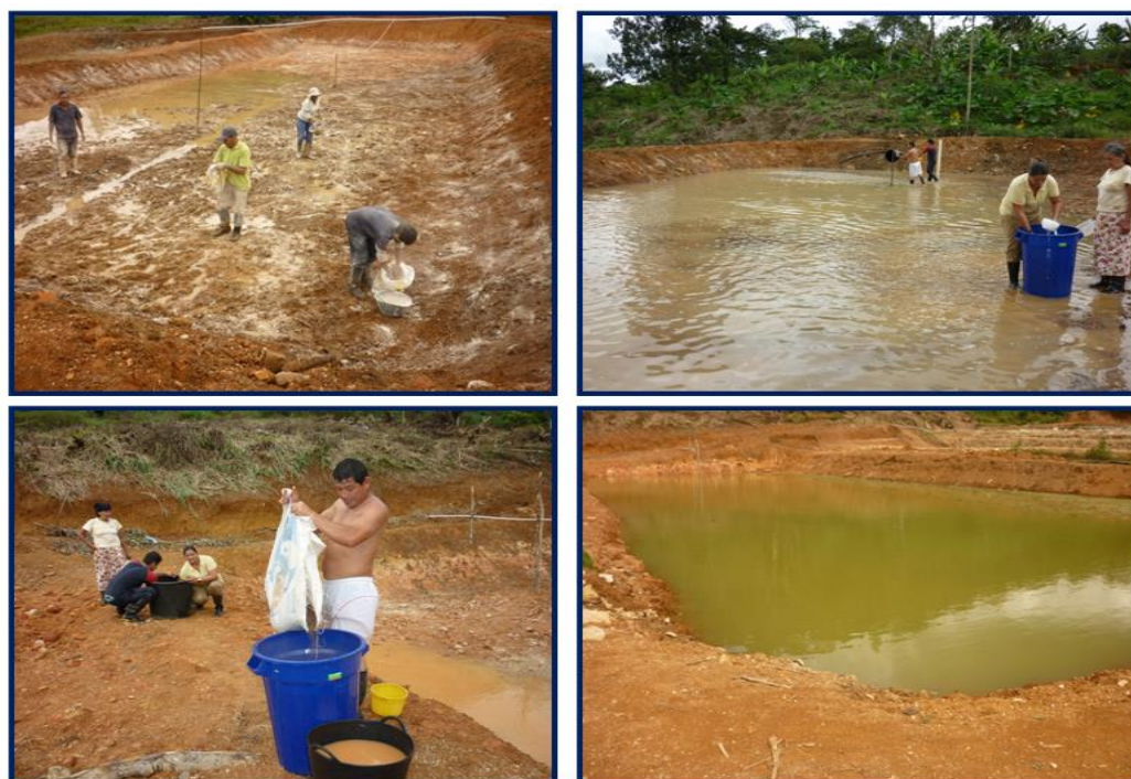
Imagen 29. Adecuación de estanques en San Isidro. Año 2011
