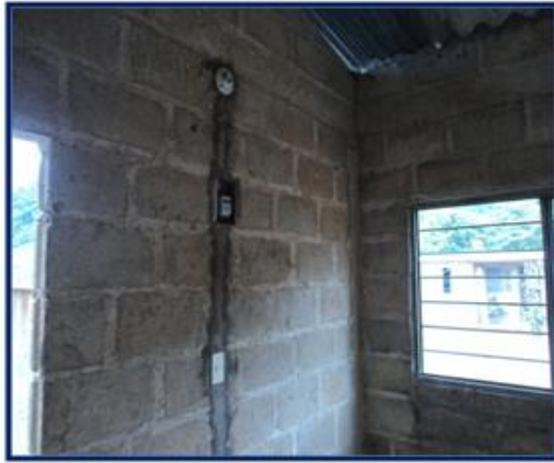
Paredes y ventanas
