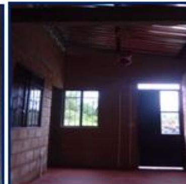
Puertas y ventanas metálicas en vidrio
