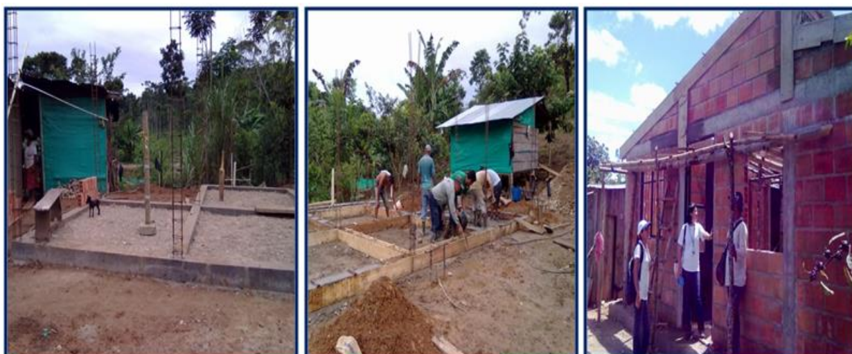
Proceso de construcción de las viviendas
