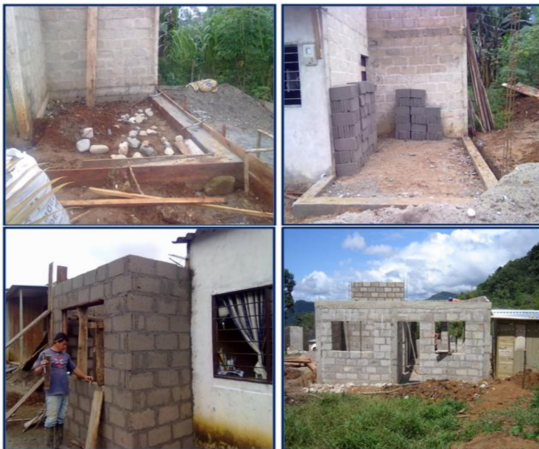
Imagen 12. Mocoa. Construcción de viviendas de interés social en San Isidro
