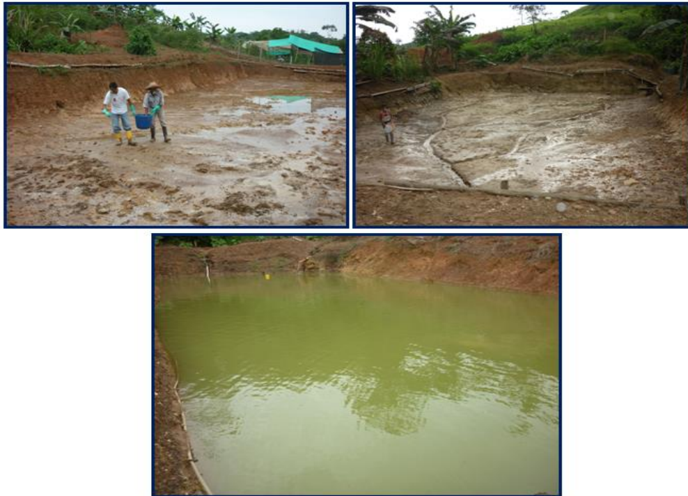
Imagen 31. Adecuación de estanques en Leticia. Año 2011
