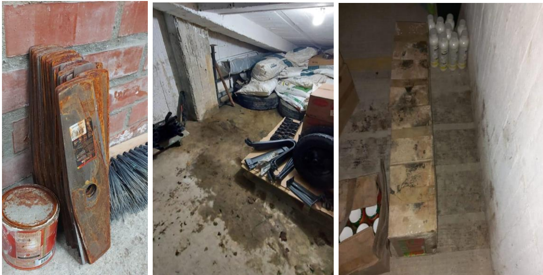
Figura 22. Embalaje y productos afectados por la humedad.
