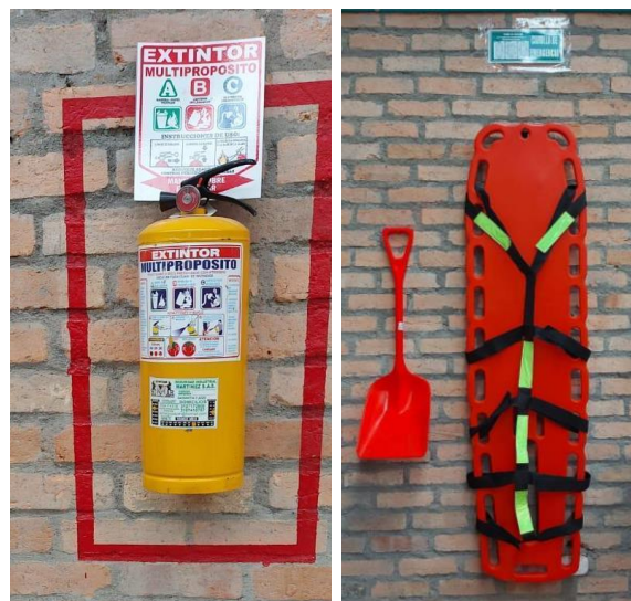
Figura 55. Adecuación de espacio para extintor y camilla de emergencia.
