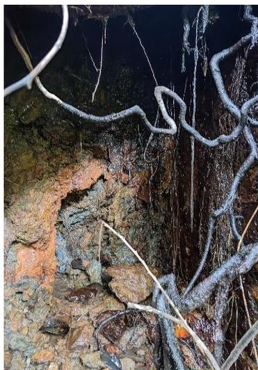
*Infiltración de agua por goteo*
