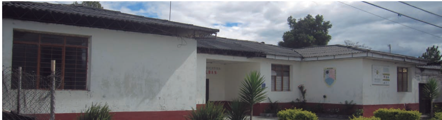
Exterior del colegio.
