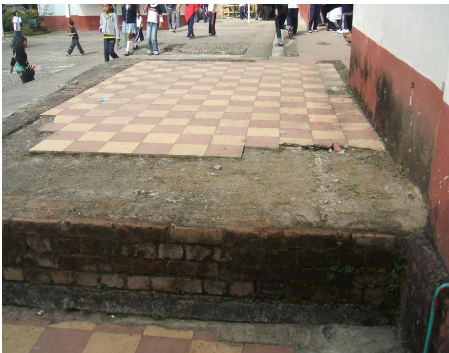
El área de piso de pasillos construidos en concreto que necesita remodelación es de 96 metros cuadrados; Analizando la profundidad y superficie de estos huecos, se requieren 4.8 metros cúbicos de concreto.
