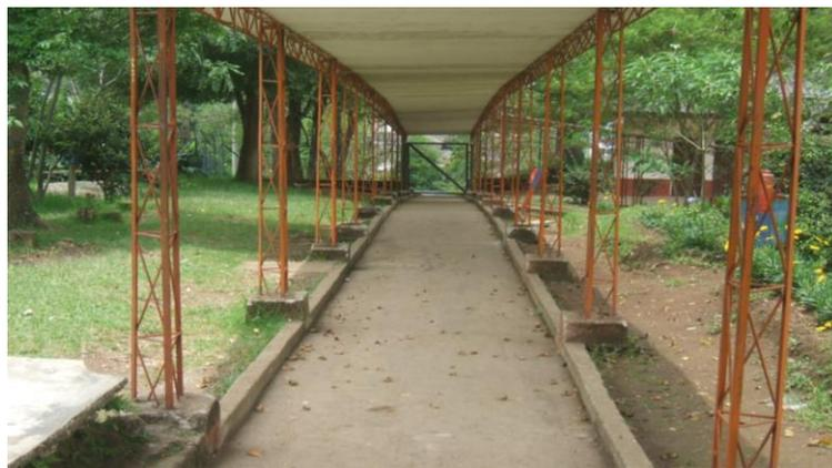
La estructura de soporte es metálica, con columnas de 2.10 metros formada por tres ángulos, amarrados con barras de  $\frac{1}{4}$  -  $\frac{3}{8}$  de pulgada.
