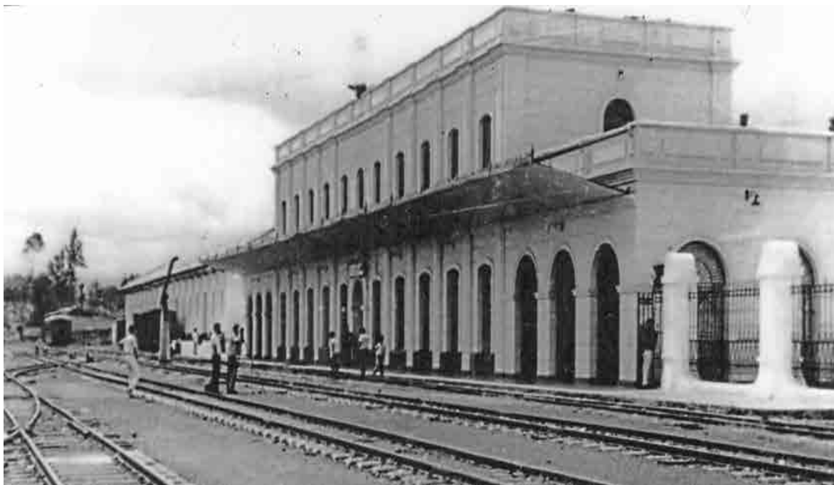
Imagen 3. Estación del ferrocarril en Popayán.
