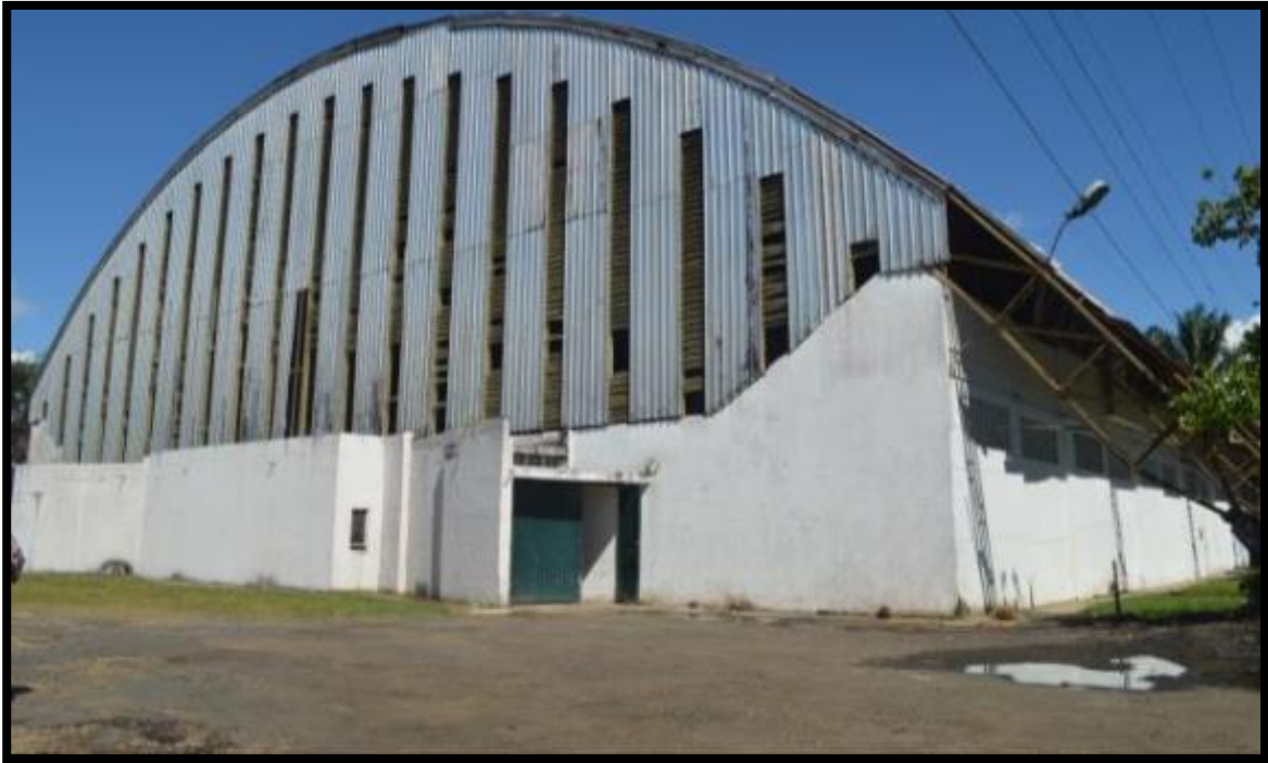
Coliseo Cubierto Juan Viessi
