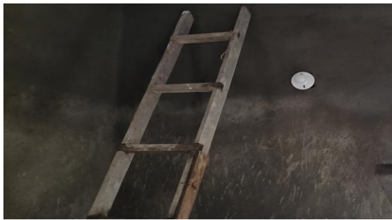
Ilustración 118: salida para iluminación Braimer (cocina).
