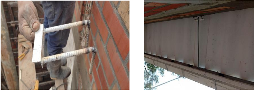
Ilustración 112: tensor varilla de 3/8, Braimer (cocina). Fuente: Propia
