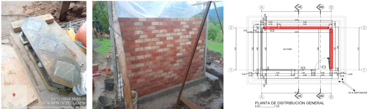
Ilustración 75: avance mampostería y toma de muestra Raúl Gurrute (alcoba) Fuente: Propia
