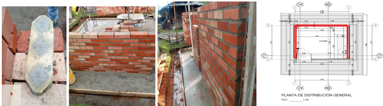
Ilustración 77: avance mampostería y toma de muestra Braimer Chantre (cocina) Fuente: Propia
