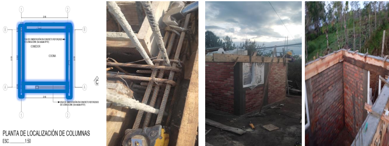
Ilustración 97: encofrado y vaciado de vigas de amarre Víctor molina (cocina). Fuente: Propia
