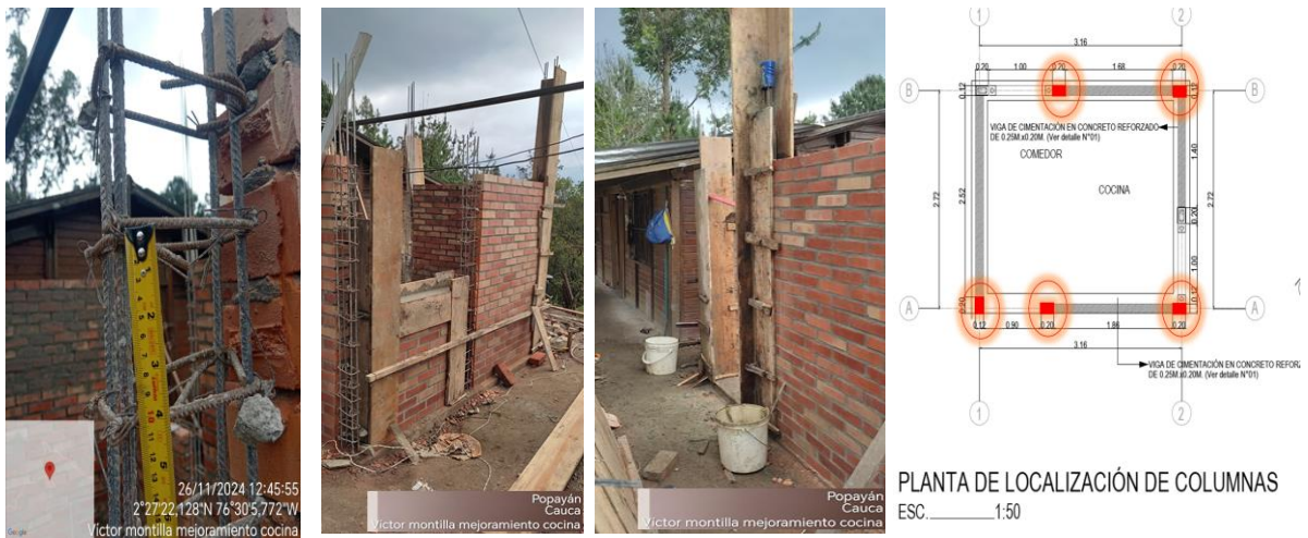
Ilustración 84: avance en figurado y armado de columnas Víctor Molina (cocina) Fuente: Propia
