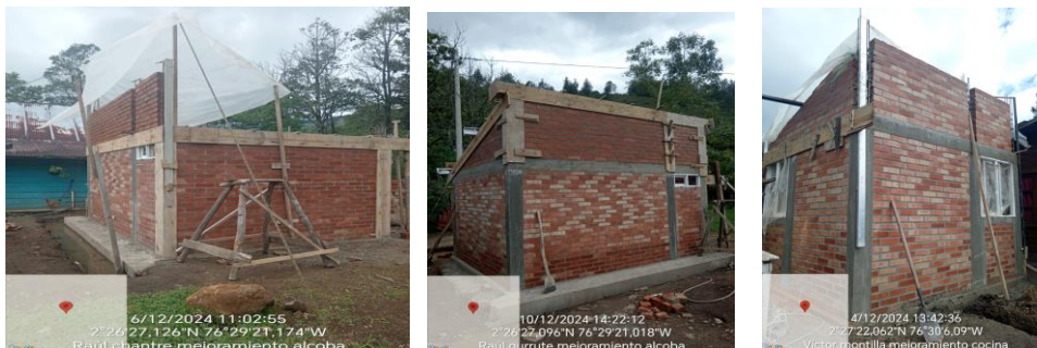
Ilustración 121: avance en muros y cinta de coronación para mejoramientos de Raúl y Víctor.
