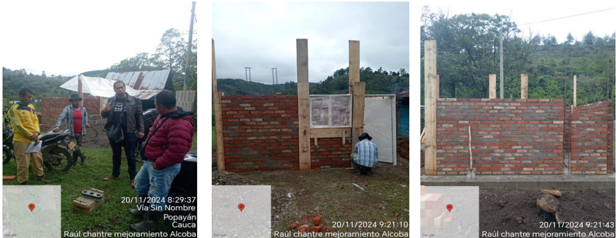
Ilustración 64: mampostería para alcoba con espesor de pega de 2,5 cm (Raúl chantre) Fuente: Propia.
