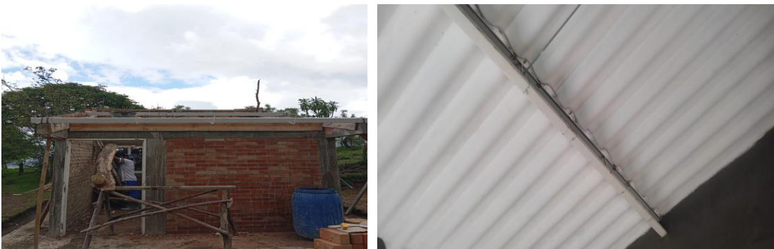
Ilustración 122: perlin metálico, varilla tensora y techo p7 Raúl y Víctor.
