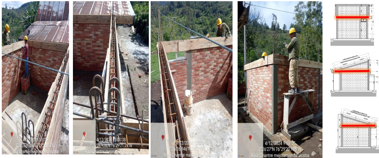
Ilustración 107: elaboración de vigas de amarre Fuente: Propia
