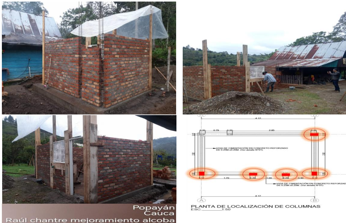
Ilustración 61: armado, encofrado y vaciado de concreto a columnas, Raúl (alcoba). Fuente: Propia
