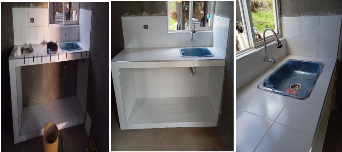
Ilustración 135: Realización de enchapes para cocina. Fuente: Propia
