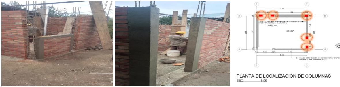
Ilustración 87: registro fotográfico de fundición de columnas faltantes. Fuente: Propia
