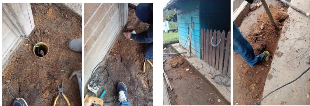
Ilustración 124: instalación de puesta a tierra para tablero eléctrico, Víctor (cocina), Raúl (alcoba).
