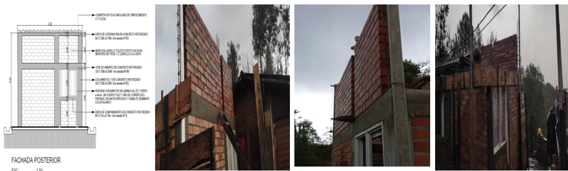
Ilustración 101: elaboración de muro en mampostería Braimer (cocina). Fuente: Propia
