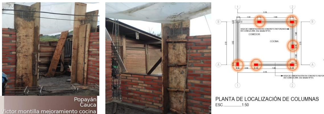
Ilustración 62: armado, encofrado y vaciado de concreto a columnas (cocina). Fuente: Propia
