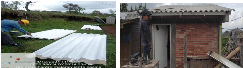
Ilustración 113: posicionamiento teja fibrocemento Braimer (cocina). Fuente: Propia
